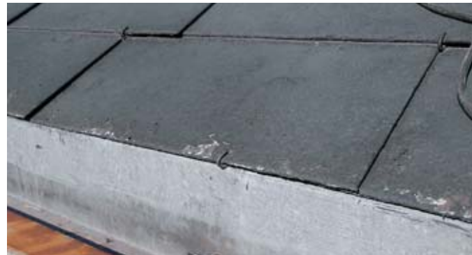
Asbesthaltige Schieferplatten
