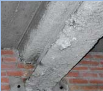
Spritzasbestisolierung
