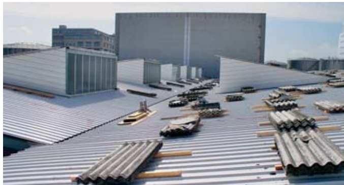
Asbesthaltige Wellplatten
