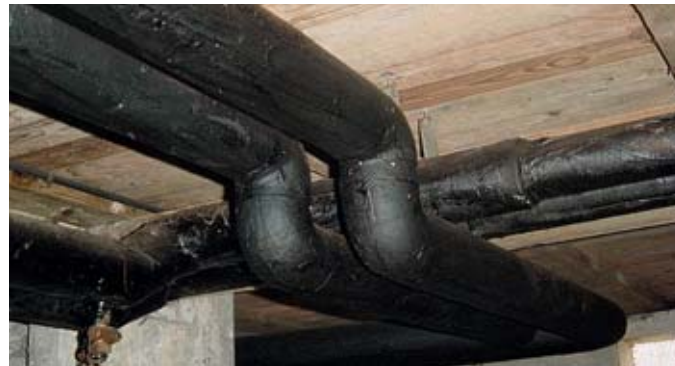
Asbesthaltiger Bitumenanstrich
