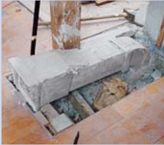
Lüftungskanal aus Asbestzement
