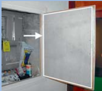
Asbesthaltige Brandschutzplatte
