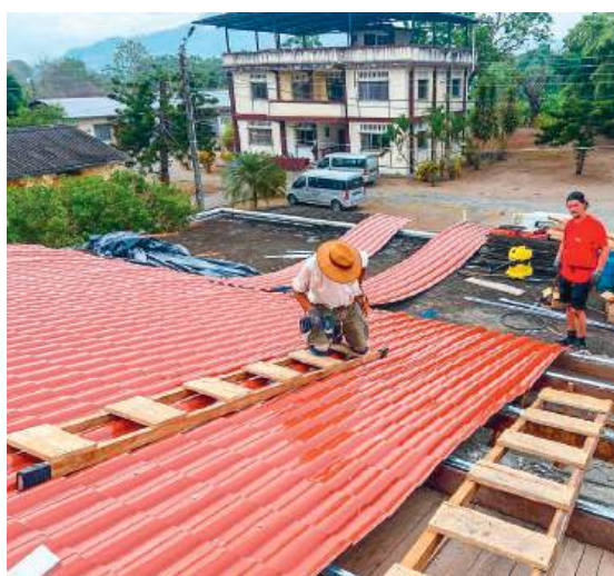
Die alten Eternitplatten sind entfernt und wenig später werden die neue Bleche verlegt
