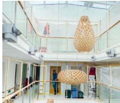
Blick in den Innenhof, 4.OG abgeschottet, 3.OG muss noch verkleidet werden
