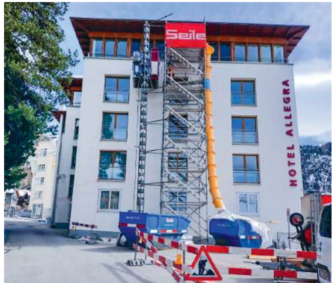
Installation für die Sanierung der Nasszellen im 3. und 4. Stock
