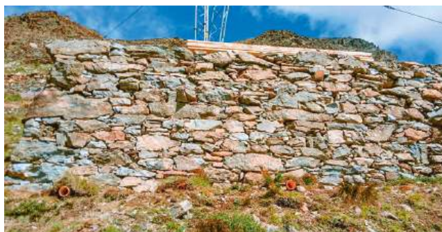
Diese Trockensteinmauer wurde über 8.0m rück- und wieder neu aufgebaut
