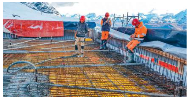
Wartezeiten auf die Fahrmischer mit Beton wurden unterschiedlich genutzt
