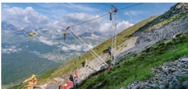
Der Kran hat 8.0m Ausleger und kann 8.0 m nach links und rechts schwenken. Nutzlast 3.0 Tonnen
