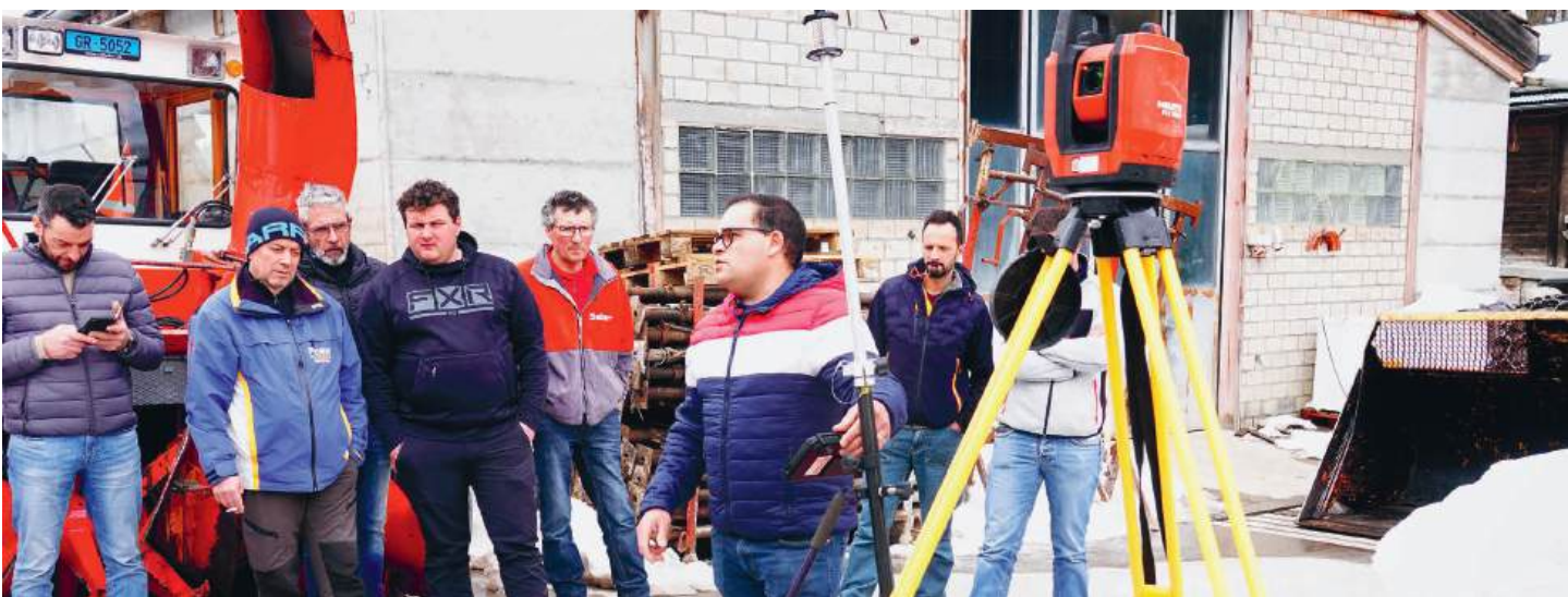
Chança Melo Paulo vermittelt wie das Einmessen und das Abstecken in Zukunft auf den Baustellen aussehen wirdgezeigt
