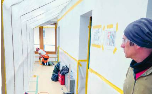
Vorarbeiter Manuel de Castro Cabral hatte jederzeit alles unter Kontrolle
