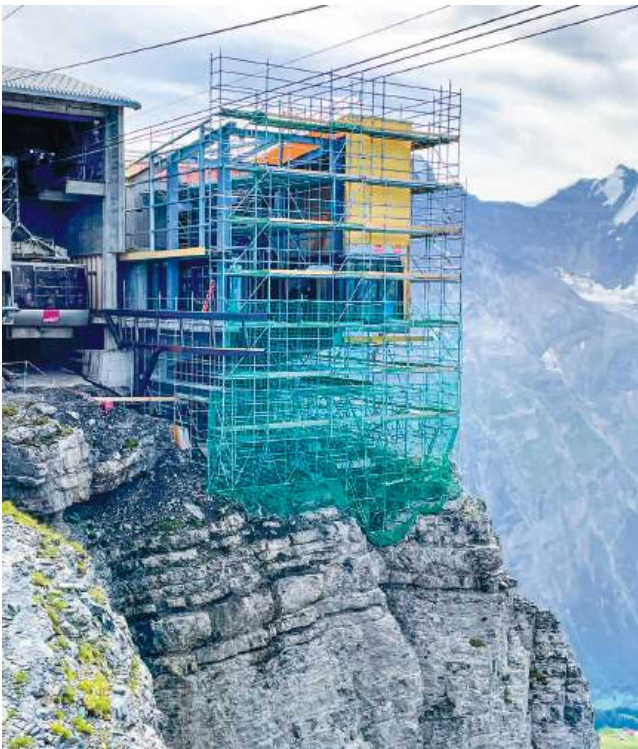
An luftiger Stelle entsteht die neue Talstation Birg. Die alte Bahn war während der Bauzeit 2024 voll in Betrieb
