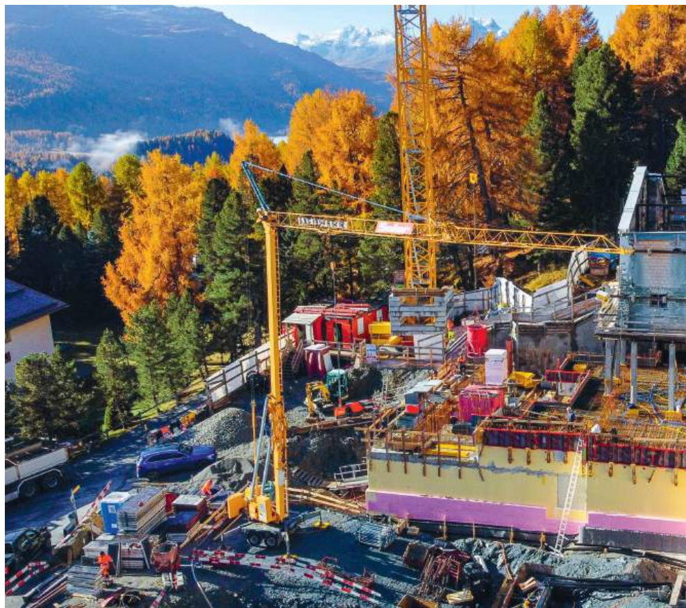
Wir stellten noch einen zweiten, mobilen Kran um die vielen Mitarbeiter bedienen zu können
