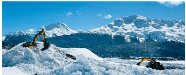
Mitten im Winter wurden die Arbeiten am Stillgewässer wieder aufgenommen
