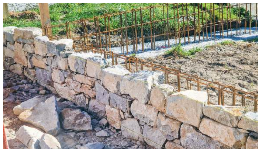
Das Hochwasserschutz Mauerwerk besteht aus beidseitigen Natursteinmauern mit ausbetoniertem Kern
