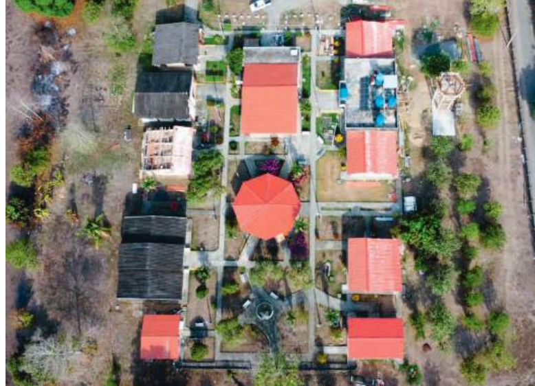
Luftaufnahme kurz vor der Fertigstellung
