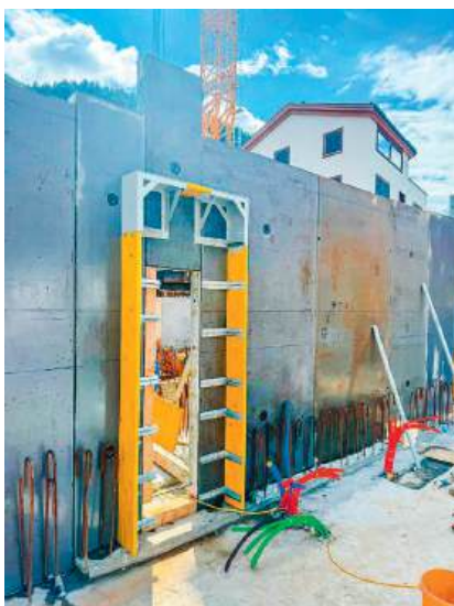
Ein neues System zum Abschalen von Türen und Fenstern wurde getestet
