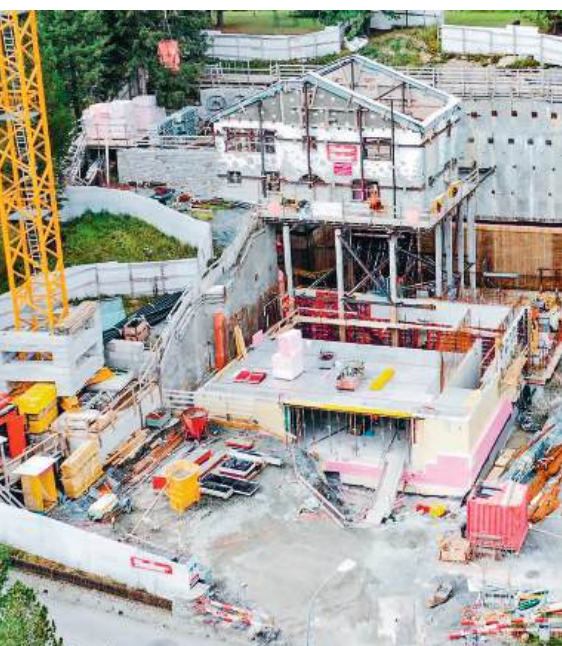
Am bauen des Garagengeschosses
