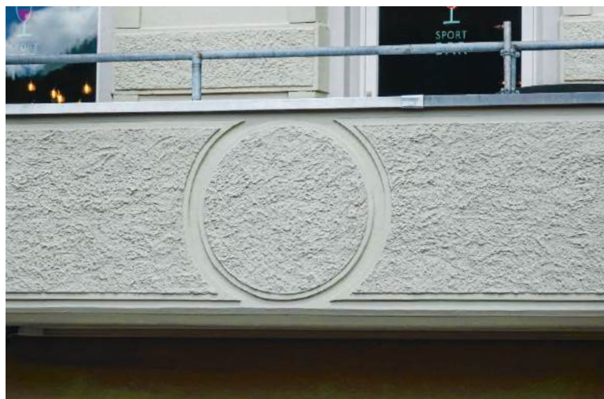
Die fertige gestrichene Brüstung
