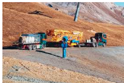
Bei schönstem Herbstwetter wurde Ende Oktober der Kran demontiert
