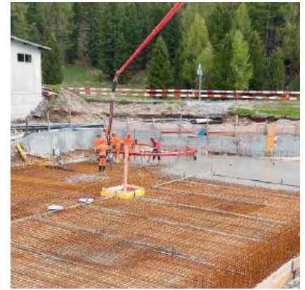
Am Betonieren der Bodenplatte
