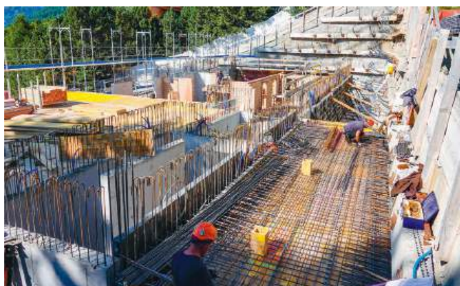
Noch fehlt ein Stockwerk und die Aussicht wird je höher umso grandioser
