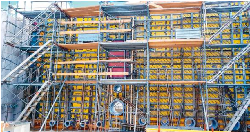
Die vielen Wanddurchdringungen in Form von vorgefertigten Formstücken erschwerten die Arbeiten
