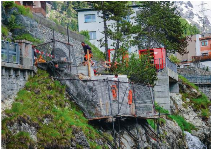
Foundation bereit für die Stahlmontage
