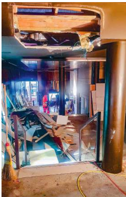
Die Abbrucharbeiten haben begonnen
