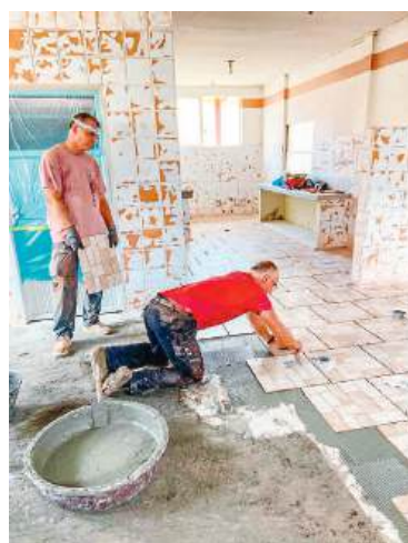
Paolo Cramerer verlegt die neuen Bodenplatten während seine Frau Iwanka im Nachgang ausfugt
