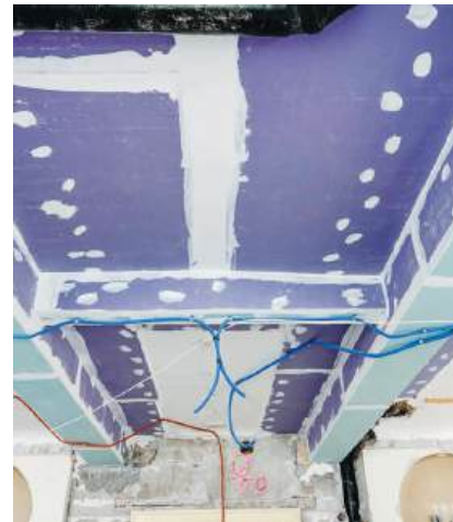
Perfekt verkleidete Stahlträger gemäss Vorschriften der Feuerpolizei.
