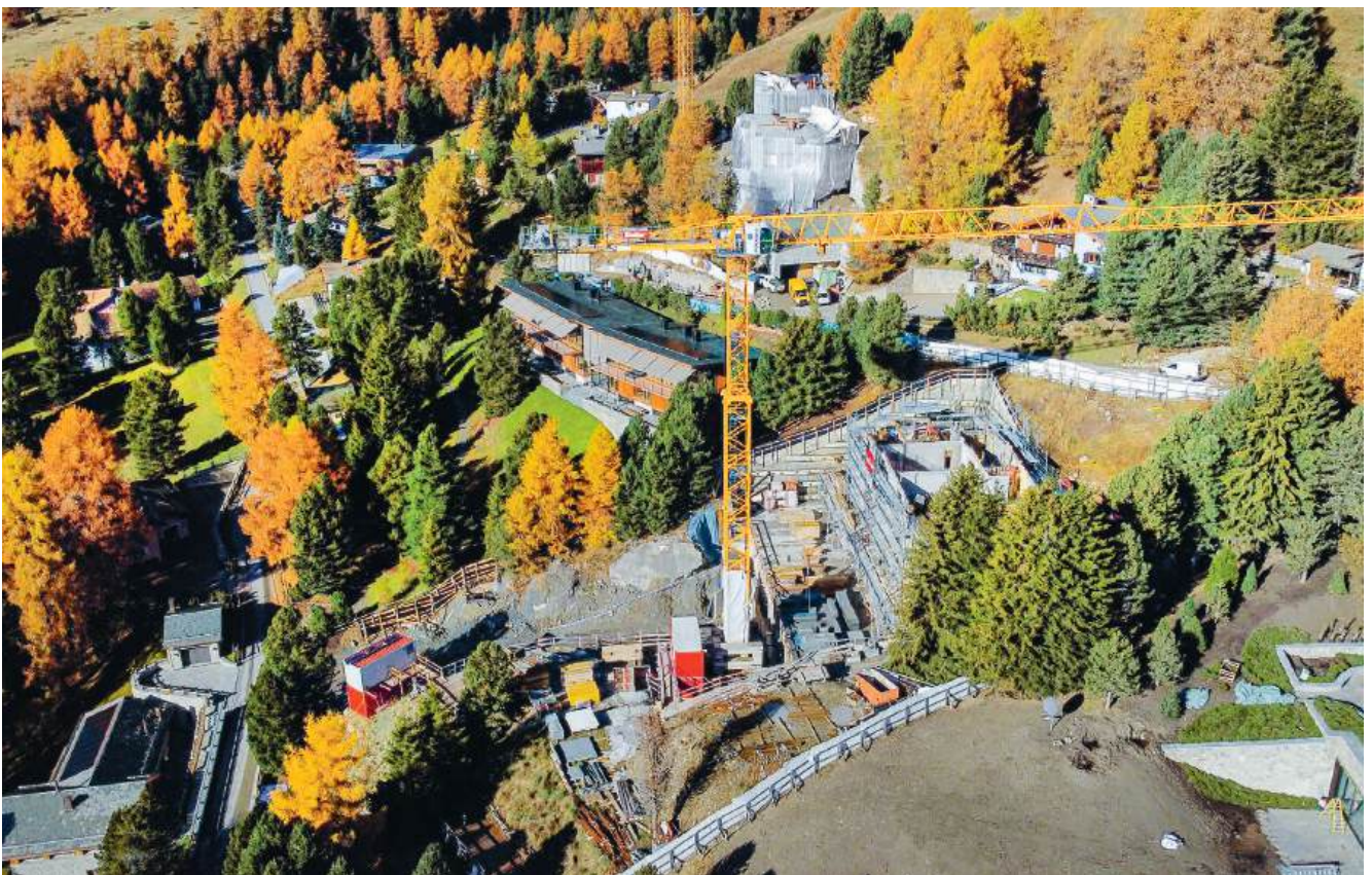
Nach Fertigstellung wird man nur noch die Villa am Hang sehen, hier fehlt noch der Zufahrtstunnel
