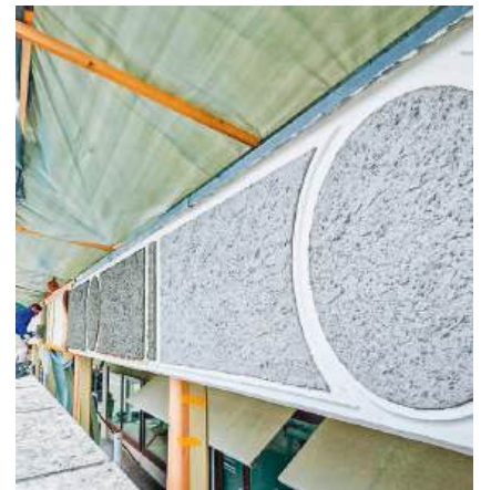
Für den Kellenwurf musste immer wieder alles perfekt abgedeckt werden
