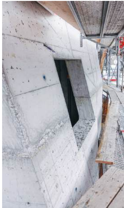
Die Fassade wird später Schräg isoliert.
