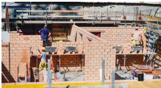
Für einmal haben Akkordmauer das Erstellen der Backsteinmauern übernommen
