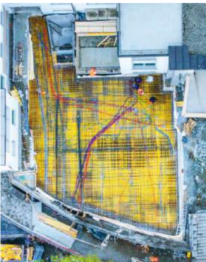
Decke bereit zum Betonieren
