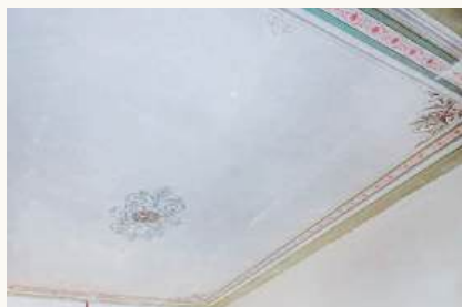
Teils bemalte Decken die bei den Abbrucharbeiten zum Vorschein kamen, wurden ohne Auffrischung so übernommen
