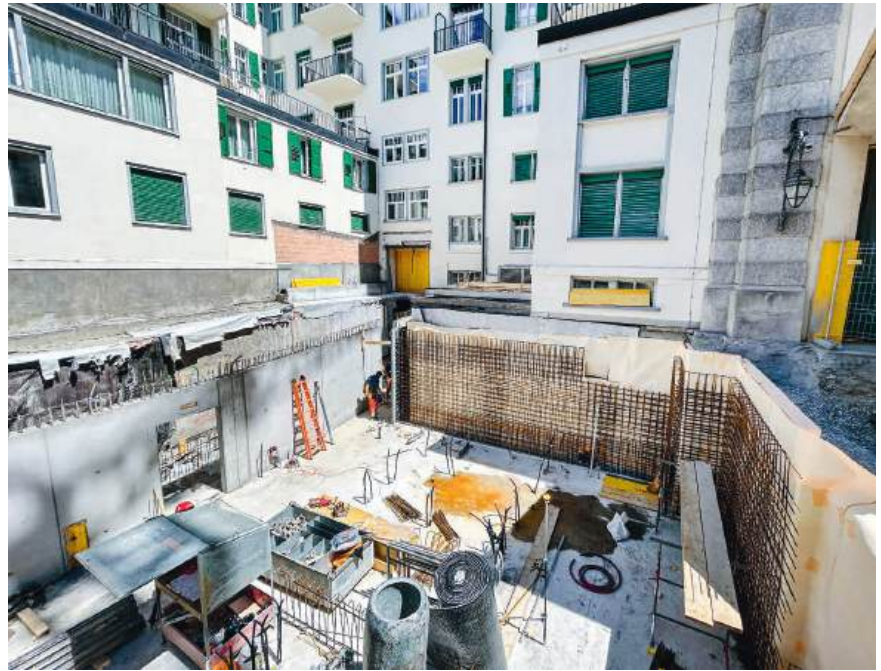
Die gelbe Folie bildet am Schluss eine geschlossene Wanne
