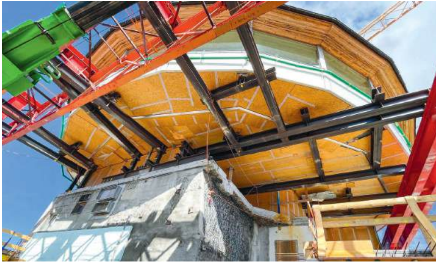
Das Drehrestaurant auf dem Gipfel des Schilthorns wurde mit einer Stahlkonstruktion abgefangen und war den ganzen Sommer in Betrieb
