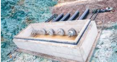
Doch beim Entnahmebauwerk schon eher
