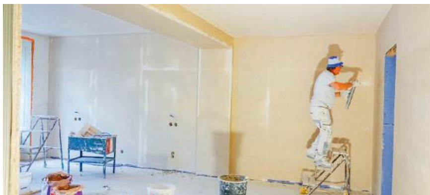
Weitere 6-7 Mann waren für die ganzen Gipsarbeiten zuständig
