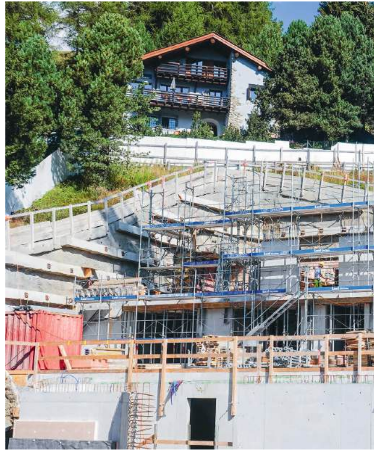
Insgesamt fünf Stockwerke mussten im Sommer erstellt werden
