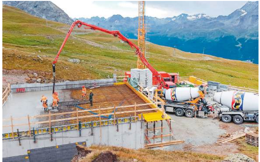
Betont wurde wo möglich mit der Pumpe
