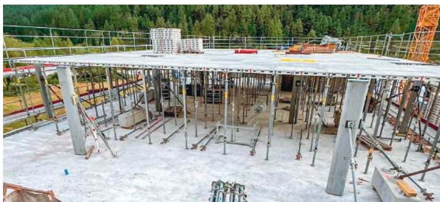
Erd- und Obergeschoss ist ein Skelettbau. Decke kam nur auf den Stützen und den wenigen festen Betonwände wie Lift zu liegen
