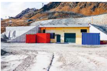
Es fehlen nur noch die Natursteinverkleidungen die im 2025 ausgeführt werden
