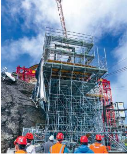
Auf dem Gipfel entsteht neben der alten eine neue Bergstation
