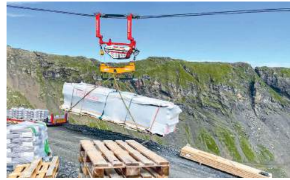
Sämtliches Material und Beton wurde mit einer 8to Seilbahn zum Gipfel geführt
