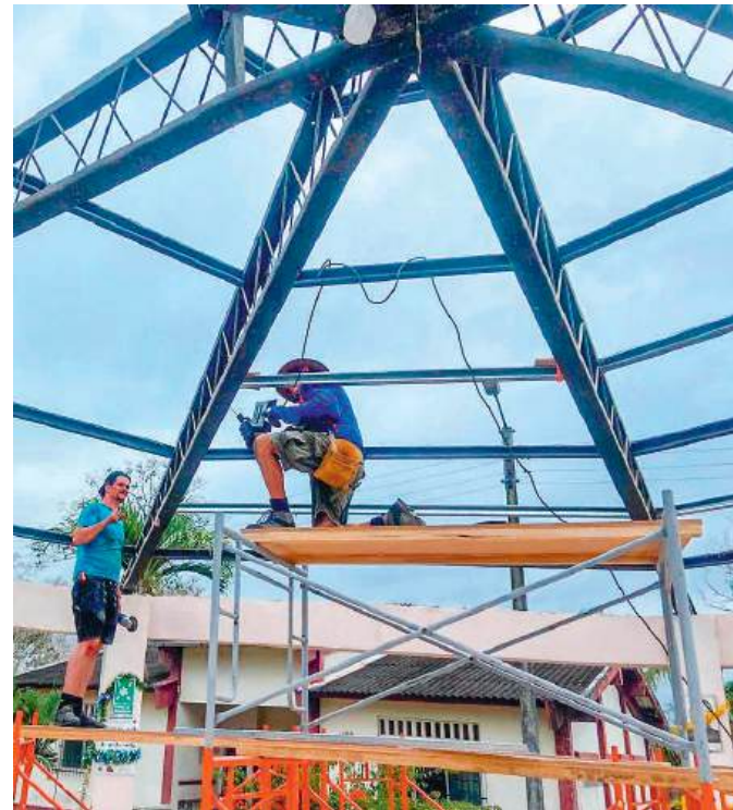
Die Stahlkonstruktion des Pavillons musste verstärkt werden
