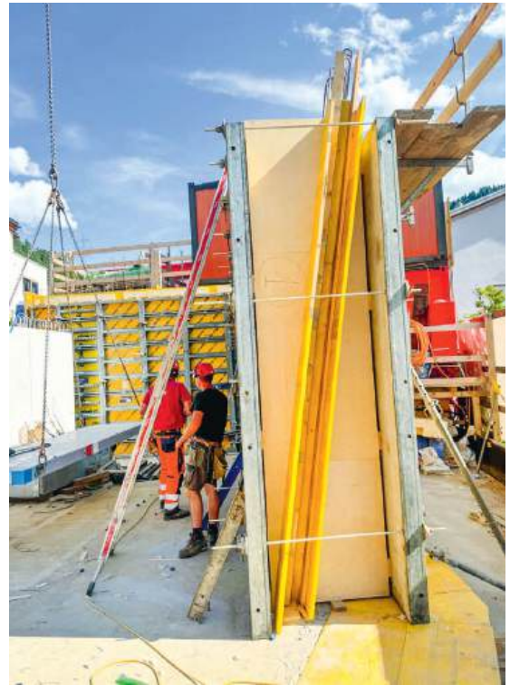
Beidseitige Aufdoppelung, gebunden via Rahmenschalung
