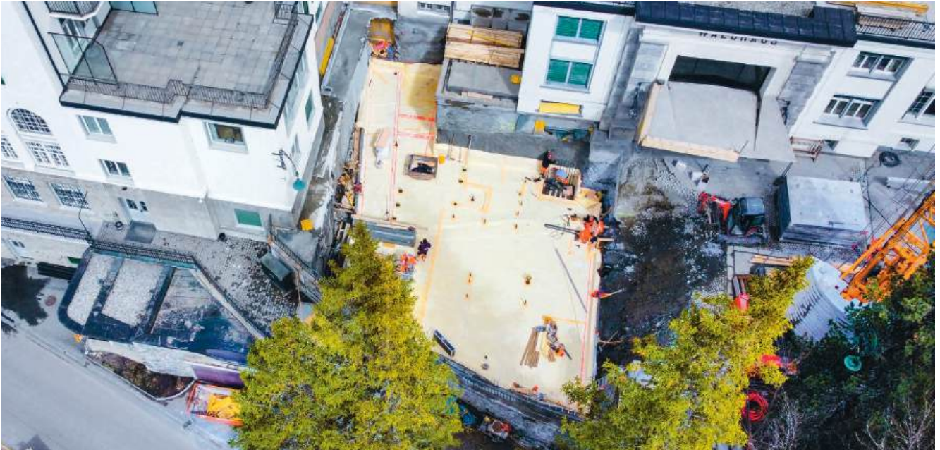
Die Drohnenaufnahme zeigt die Grösse des Anbaus, gelb die wasserdichte Wanne der Firma Sika
