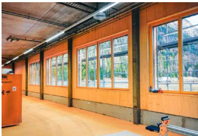
Die grossen Fenster bringen viel Licht in die Schreinerei
