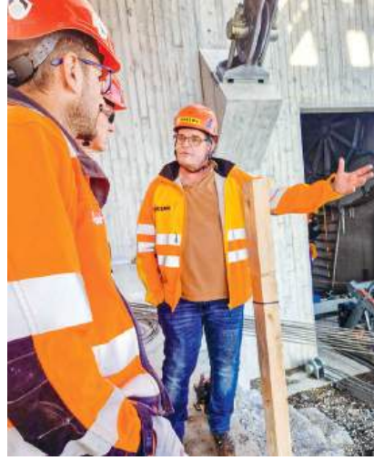
Gerry Fuchs von der Firma Ghelma führte uns über die Baustelle Schilthorn 20XX
