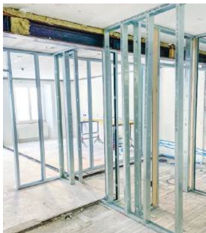
Eine Trockenbauequipe erstellte ca. 5'000m 2 Ständerwände
