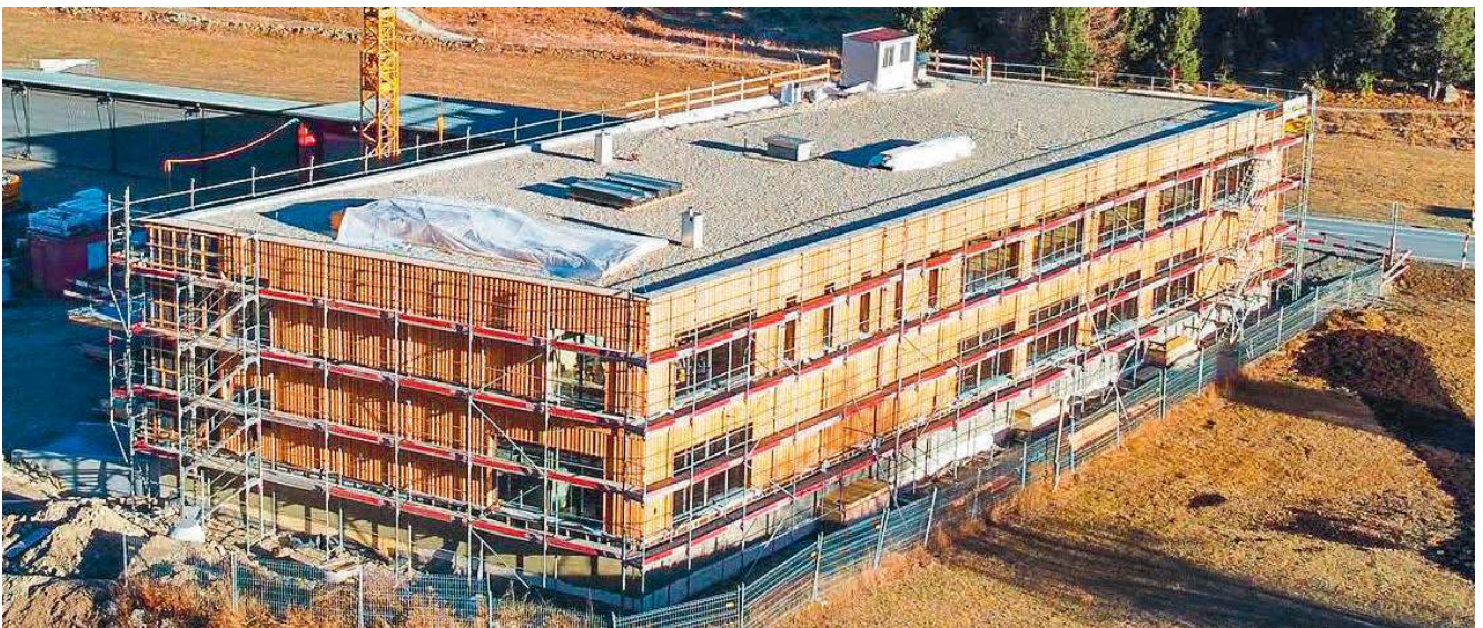
Die Fassade besteht aus verkleideten Holzelementen
