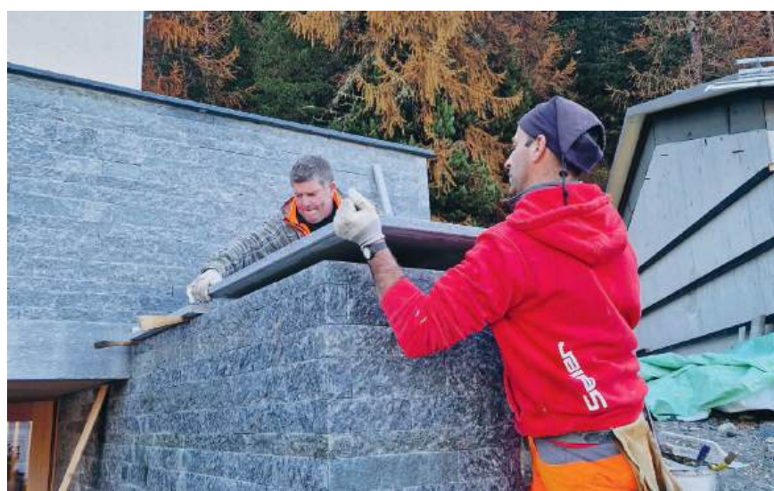
Verlegen der Abdeckplatten
