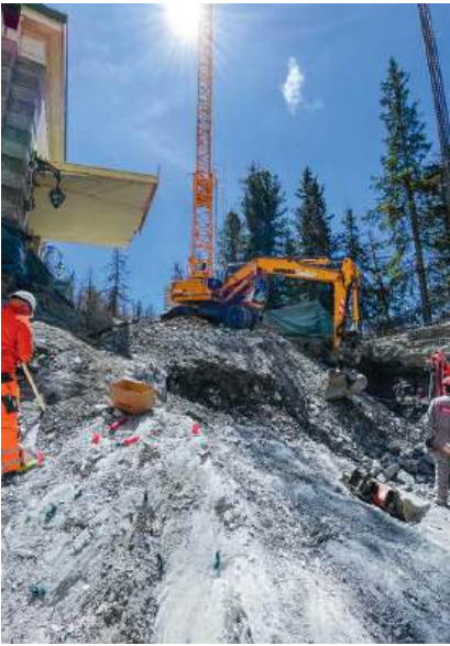
Die Firma Ghelma führte für uns die anspruchsvollen Sprengarbeiten direkt neben dem Hotel aus
