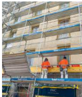
Die ersten zwei Stockwerke wurden neu isoliert und verputzt, der Rest nur gestrichen
