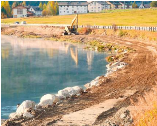
Dammschüttung entlang der Hauptstrasse wo später der Fussweg zu liegen kommt
