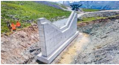
Noch kann man sich nicht vorstellen, wie der Hochwasserentlaster funktionieren soll
