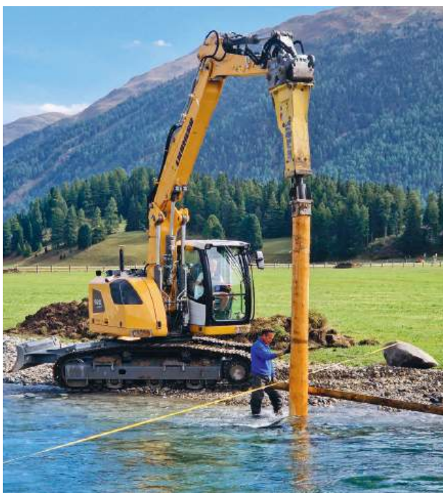
Baumstämme werden für die Langlaufbrücke in den Inn gerammt
