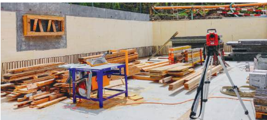
Gut ersichtlich die gelben Folien an den Wänden, die zur Abdichtung gehören (gelbe Wanne)
