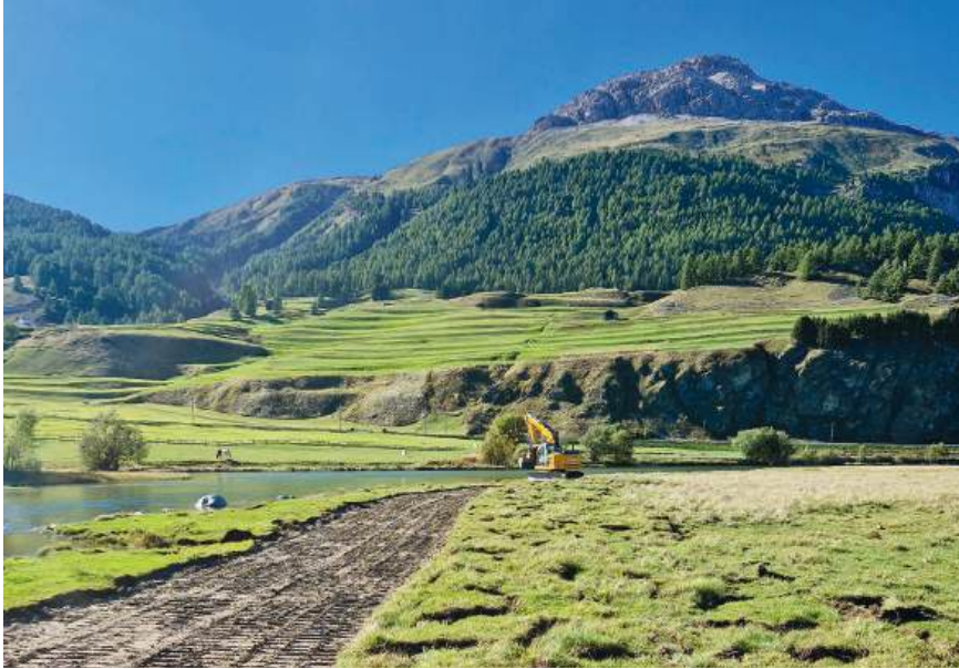
So wie die Rasenziegel perfekt zur Seite gelegt wurden, sind sie wieder platziert worden
