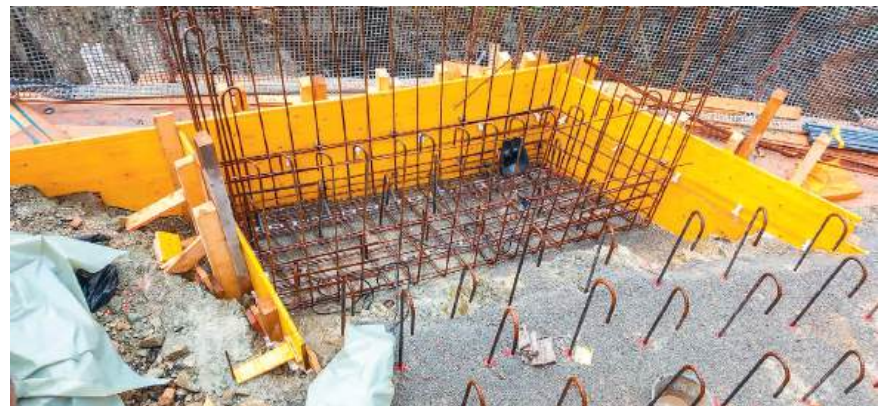
Zusätzlich wurden Anschlusseisen im Felsen verankert
