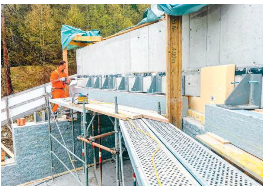
Spezialschuhe um das Gewicht des Sturzes und des später darüber gemauerten Mauerwerkes abzufangen
