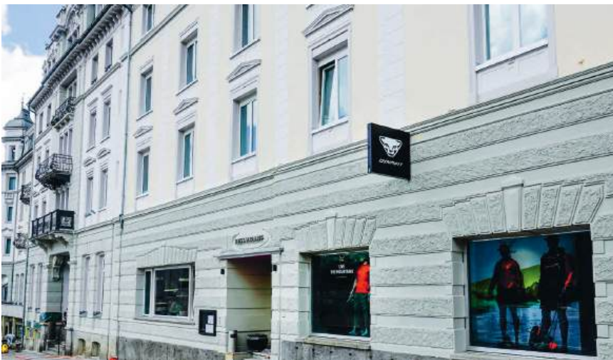
Der Fassadenteil vom Dachwasserfallstrang wurde komplett neu hergestellt
