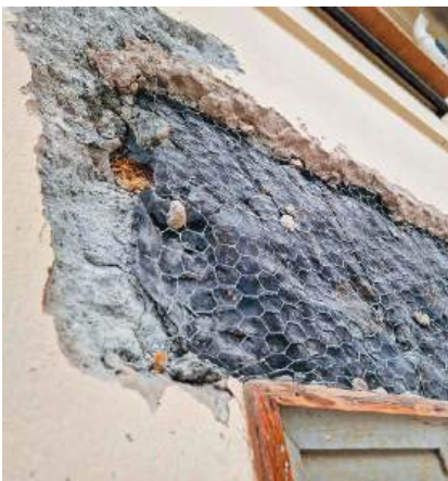
Typischer Aufbau der alten Fassade über dem Fenstersturz
