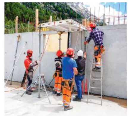
Das erste Element der Rahmenschalung Interfama wird unter Anleitung montiert
