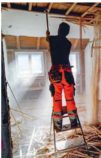
Abbrechen der alten Gipslättildecken
