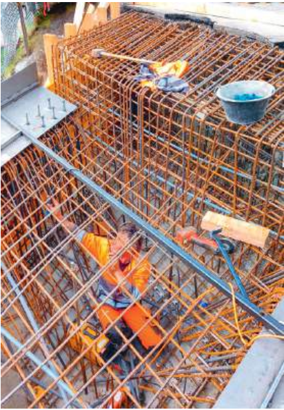
Die Schablonen für die Stahlkonstruktion wurden durch Fabrizio Togni verschweisst
