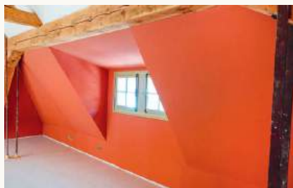
Die oberen Stockwerke sind bereits gestrichen und soweit fertig
