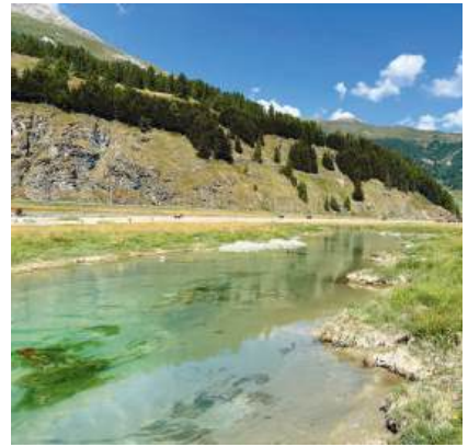
Nach der Herstellung der Ufergestaltung des neuen Flussbetts um die Insel
