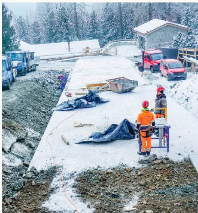
Als letzte Arbeit im 2024 wurde der 44m lange Zufahrtstunnel erstellt, den wir noch vor Weihnachten hinterfüllen
