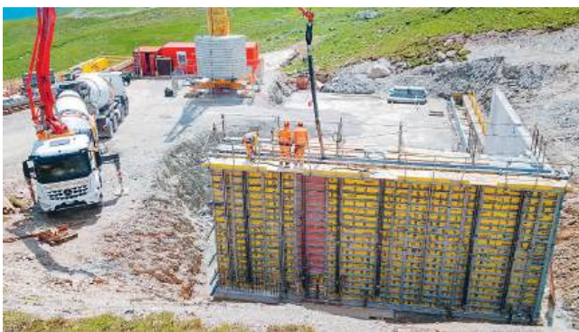
Die ersten 6.15 m hohen Wände der Verteilstation werden betoniert
