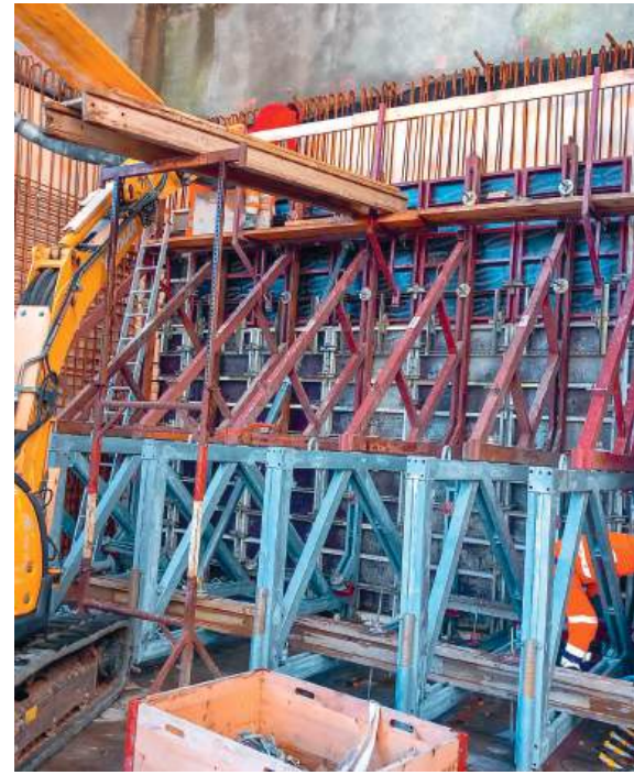
4.5m hohe Wände, einhäutig betoniert, brauchen eine spezielle Abstützung
