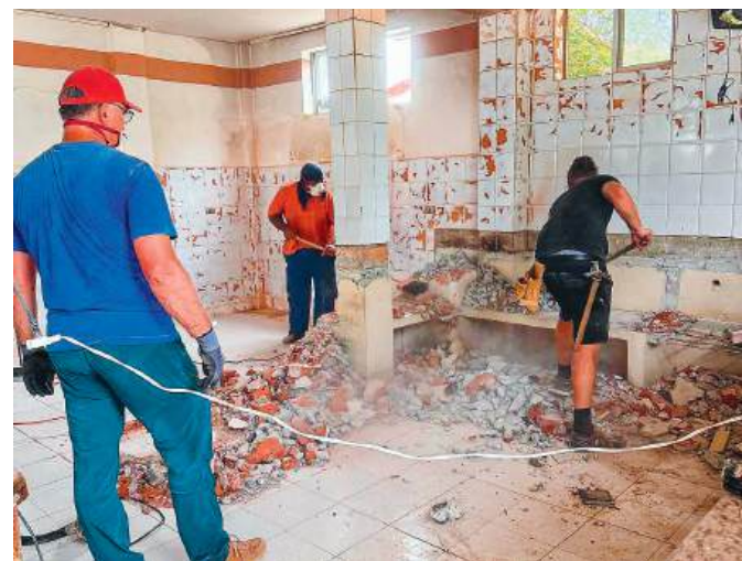
Abbrucharbeiten für den Küchenumbau
