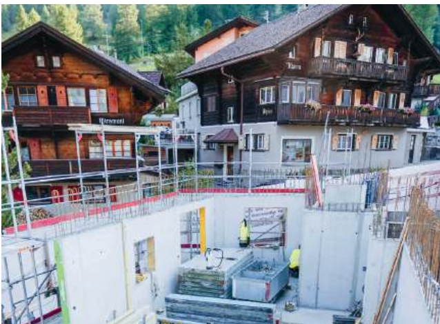
Bergseitig wurden alle Wände vertikal ausgeführt
