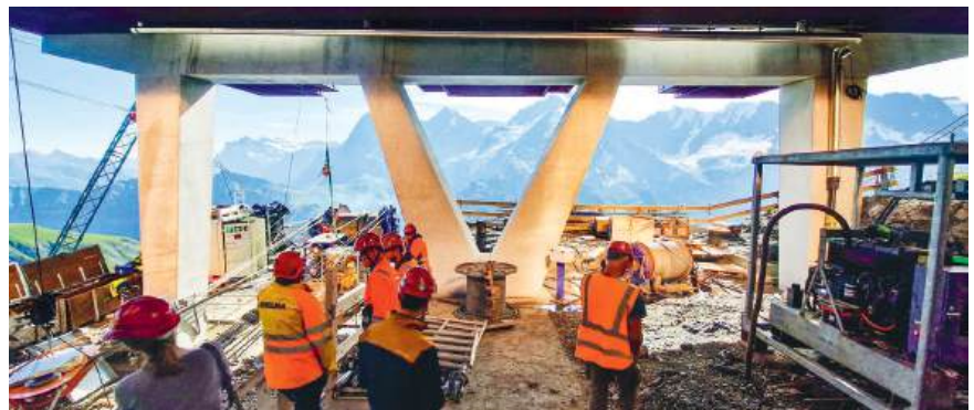
Sehr schöne Betonarbeit bei der neuen Station Birg
