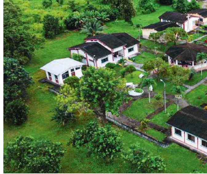
die wunderschön gelegene Alterssiedlung Esposo Bishara vor den Umbauarbeiten
