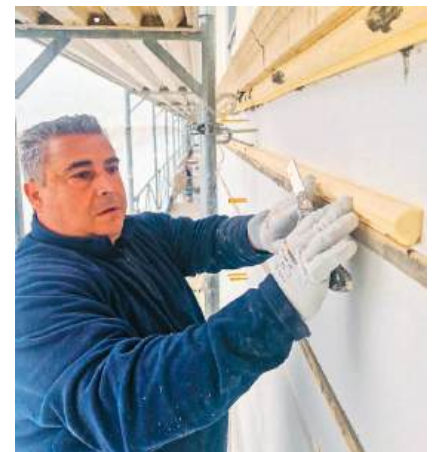
Rocco Raffa ist Meister seines Faches. Die Profile aus XPS Platten hat er alle vor Ort hergestellt.
