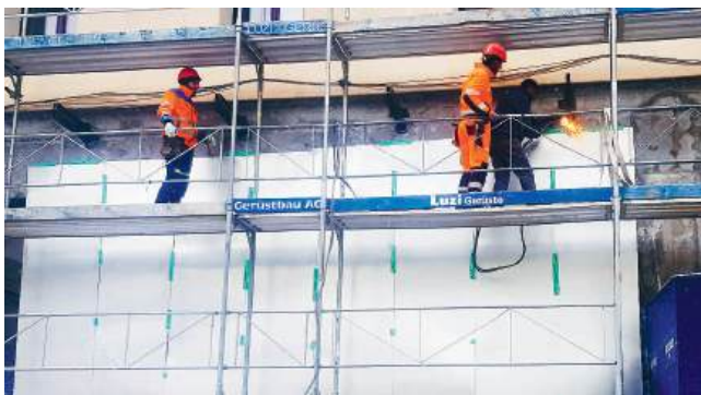
Eine Schutzfolie schützt das Geschäft während den Abbrennarbeiten des Vordaches
