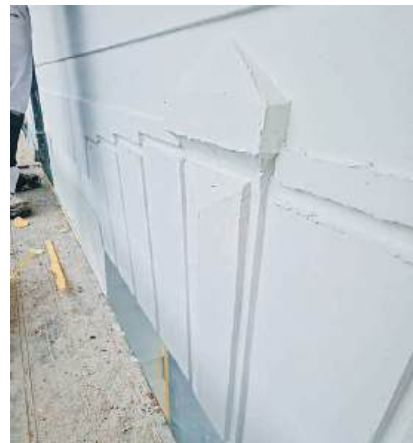
Der Aufbau erfolgte Schritt für Schritt, bzw. Schicht um Schicht
