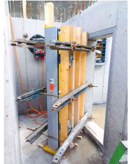
seit langem wieder mal einen Luftschutzraum gebaut
