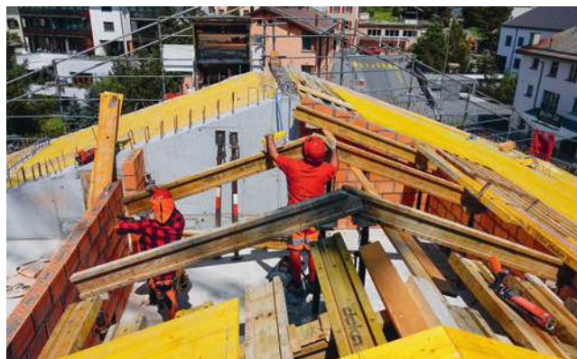
für das Erstellen der Schalung des Betondaches brauchte es Spezialisten aus unseren Reihen
