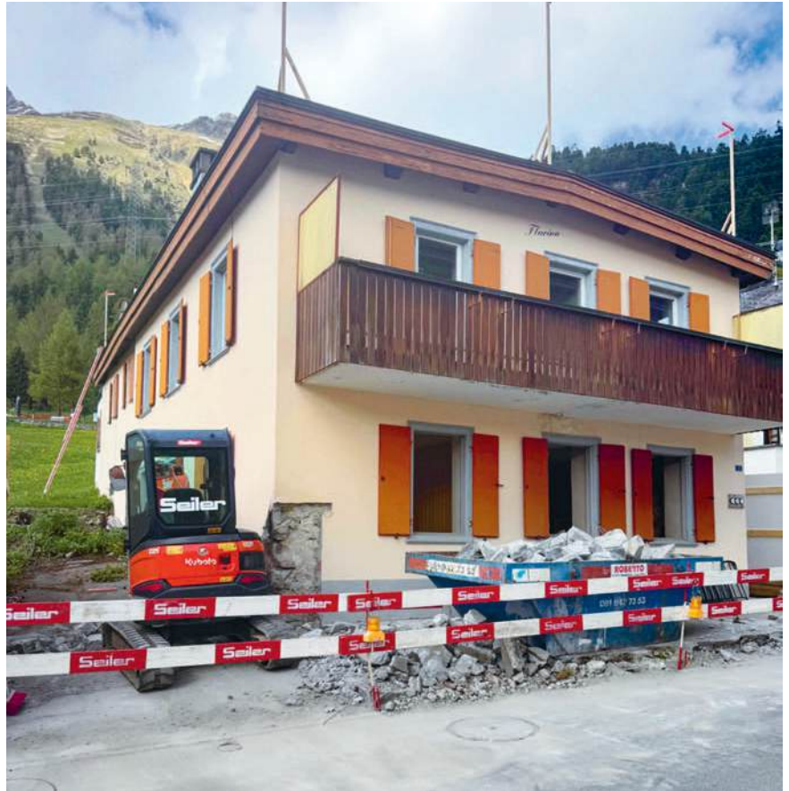
die Chesa Flurina kurz nach Baubeginn
