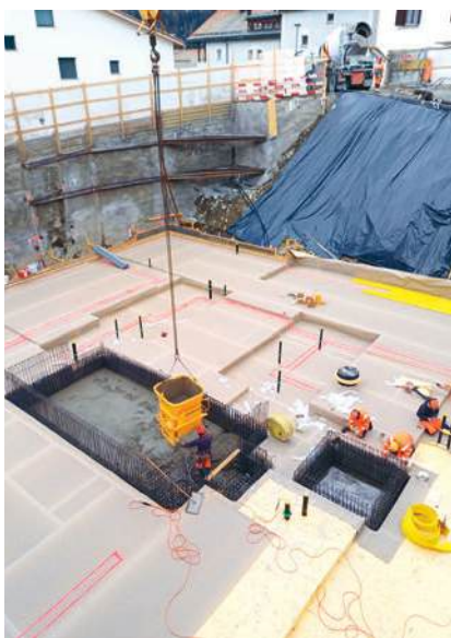
der ganze Bau ist von unten isoliert und mit gelber Wanne der Firma Sika gegen eindringendes Wasser gesichert
