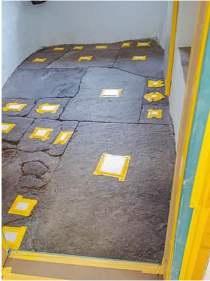
erhaltenswerte Böden wurden exakt aufgenommen, um später wieder originalgetreu zu verlegen
