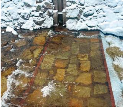
die fertige Blockrampe
