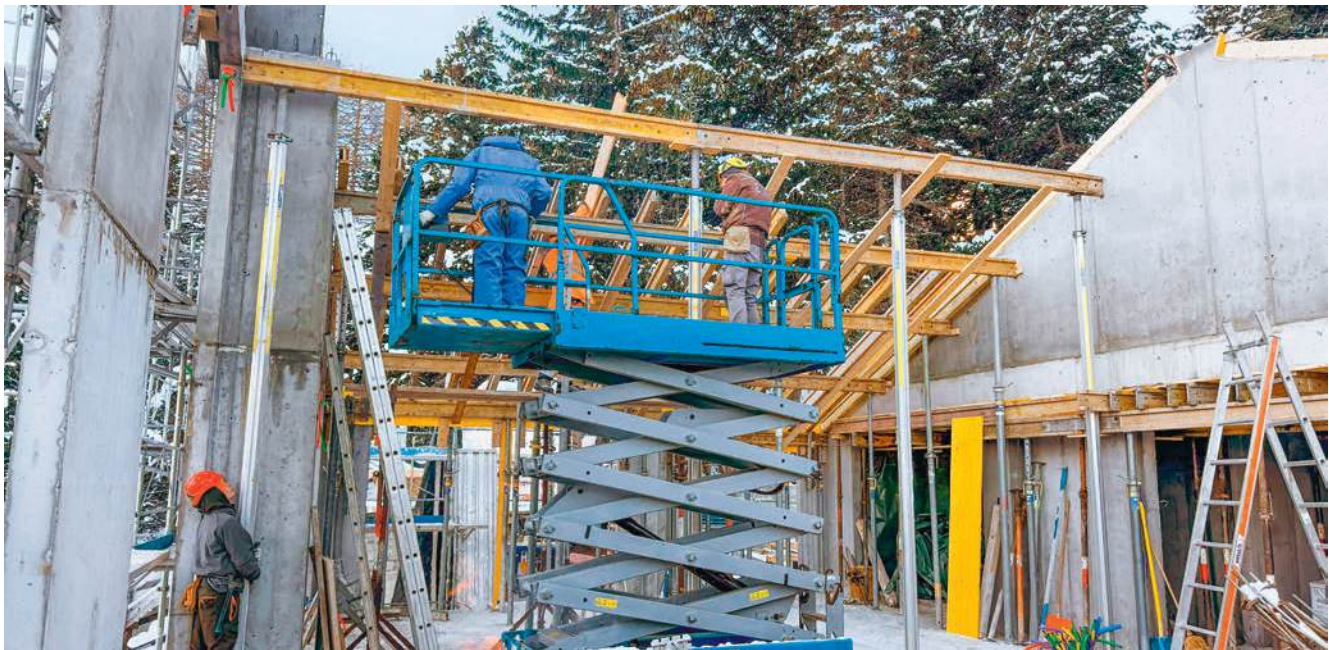
das Dachgeschoss weist eine Raumhöhe von knapp 5.0m auf, was das schalen des Betondaches nicht einfach machte
