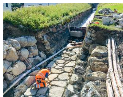
teilweise mussten die seitlichen Wände zusammen mit der Bachsohle neu aufgebaut werden
