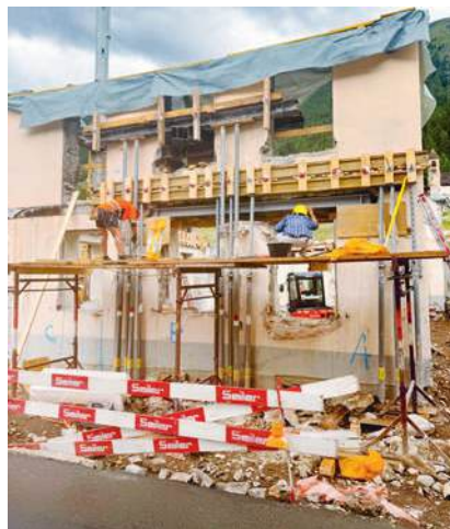
die Öffnungen in der Fassade wurden zum Teil geändert was den Einzug von Stahlträgern nötig machte
