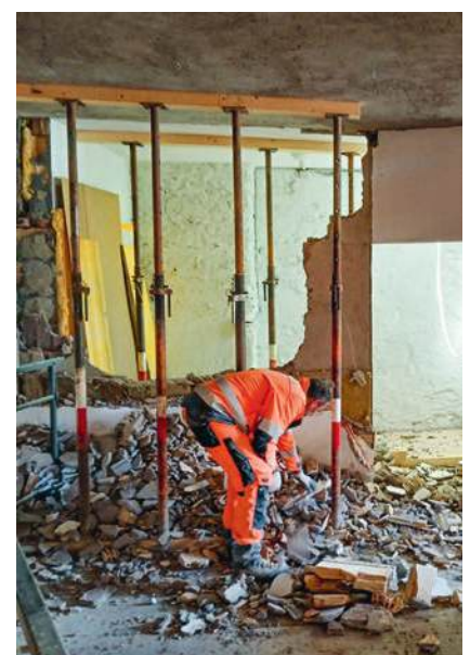
bereits im März 25 konnten wir mit den Abbrucharbeiten beginnen
