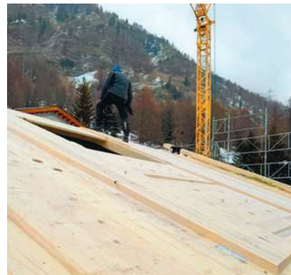
innert zwei Tagen wurde ein Elementdach montiert
