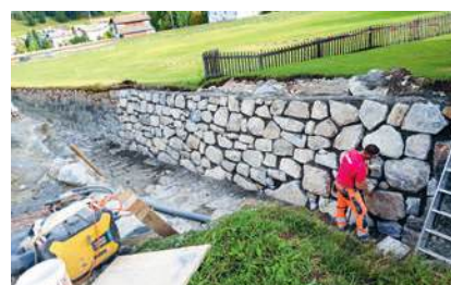
ein frisch sanierter Streckenabschnitt bei welchem noch ausgefugt werden muss
