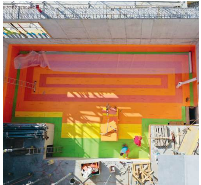
um Lärm- und Schwingungsemissionen zu verhindern wird das Hallenbad auf einer speziellen Isolation gelagert
