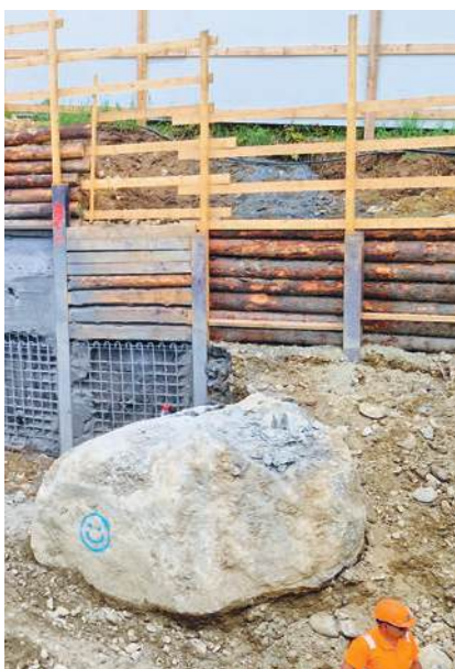
der Findling im Aushub wurde von langer Zeit vom Gletscher abgelagert
