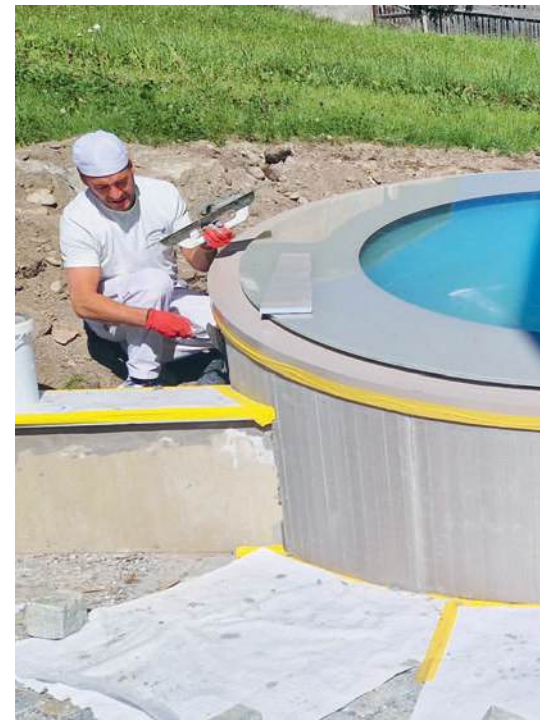
auch die Oblichter mussten innen sowie aussen verputzt werden
