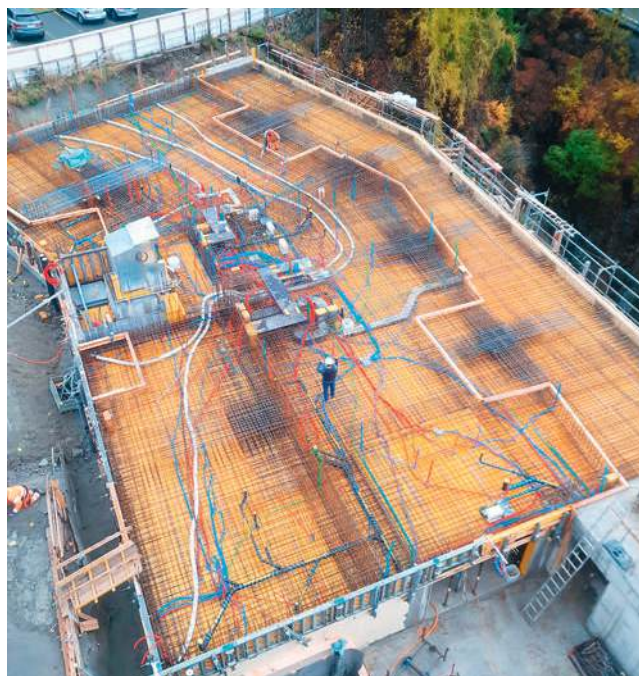
das Dach der Tiefgarage
