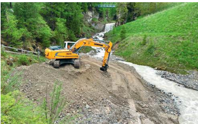
insgesamt wurden 2000 m 3 abgelagertes Material abgeführt
