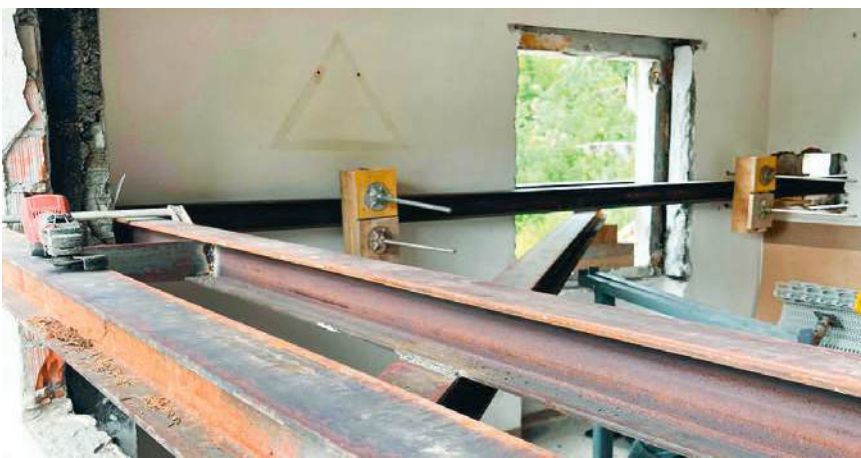
die Sicherungen der Gebäudehülle verlaufen ums Gebäude und zum Teil auch durchs Gebäude
