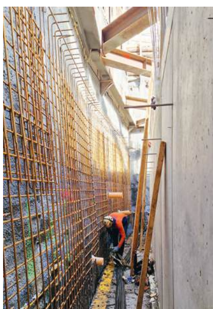
vor der Baugrubenswand kam eine zusätzliche Betonscheibe unter engsten Platzverhältnissen nachträglich betoniert
