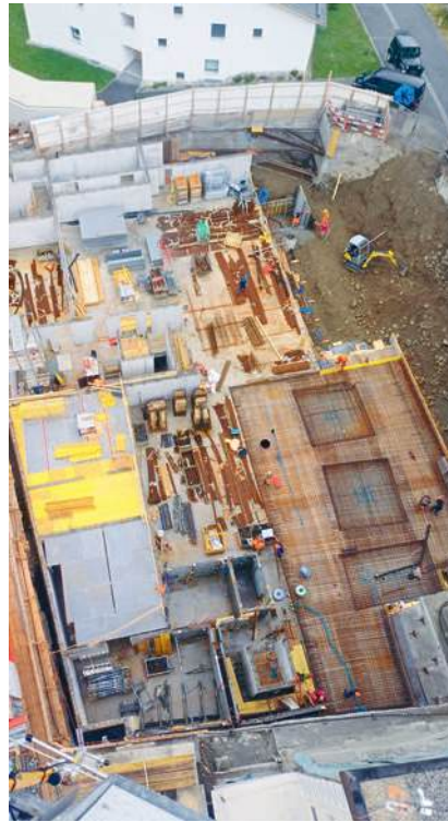
gut ersichtlich, wie etappiert gebaut wurde
