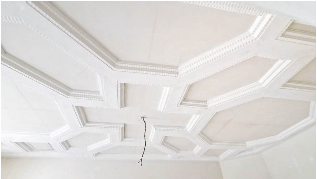
die neu erstellte Stuckaturdecke, das Herzstück unserer Gipserarbeit
