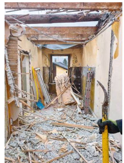
bis auf die Aussenwände wurde alles zurückgebaut
