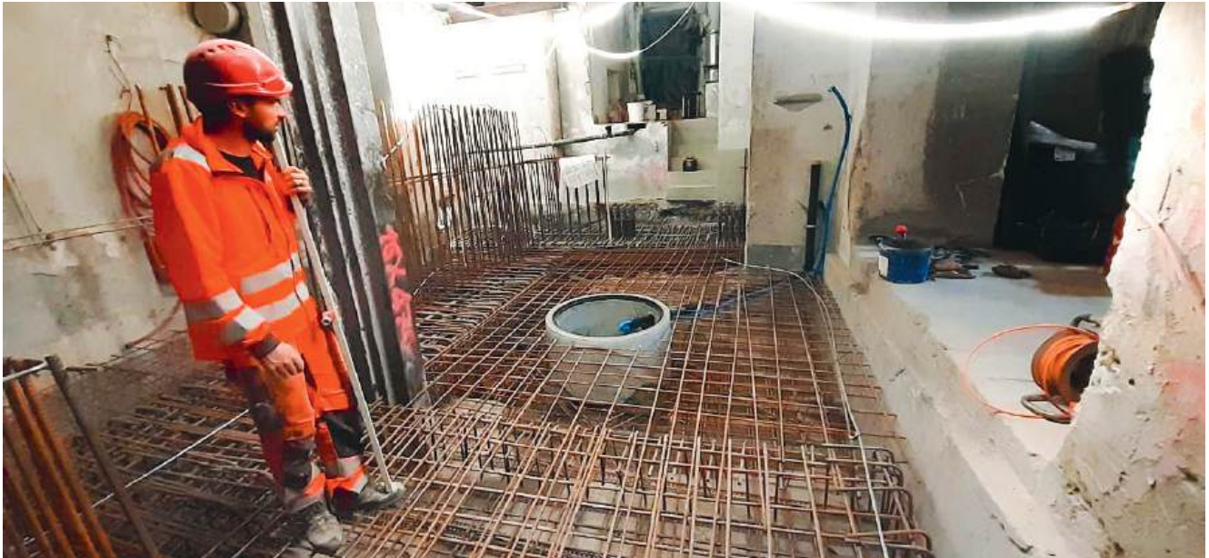
vor dem Betonieren der Bodenplatte
