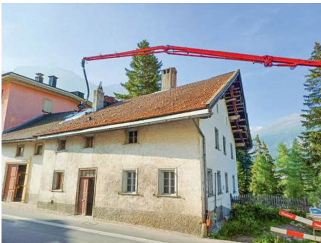
wir betonierten jeweils mit der Pumpe über eine Öffnung im Dach. Der Pumpist auf dem Dach ist angegurtet.
