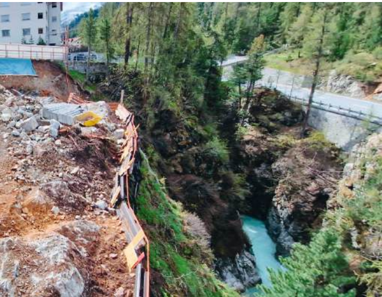
Bohren, Sprengen, Baugrubensicherung und Ankeren, sowie Aushubarbeiten, wurde alles gleichzeitig ausgeführt. Gut ersichtlich wie nahe am Abgrund der Berninaschlucht gebaut wurde
