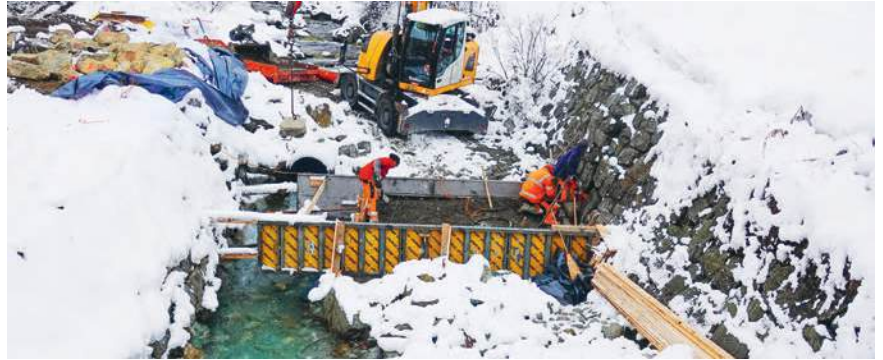
der Grund für das Ausführen im Winter ist die geringe Abflussmenge des Beverins
