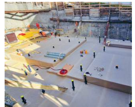
auf die Abdichtung der Firma Sika kann nun die Armierung verlegt werden
