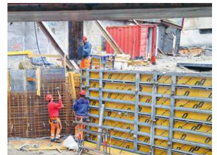
Armieren und Zuschalen der Poolwände
