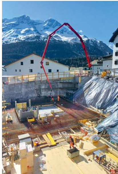
Betonieren erster Teil Bodenplatte noch unter winterlichen Verhältnissen
