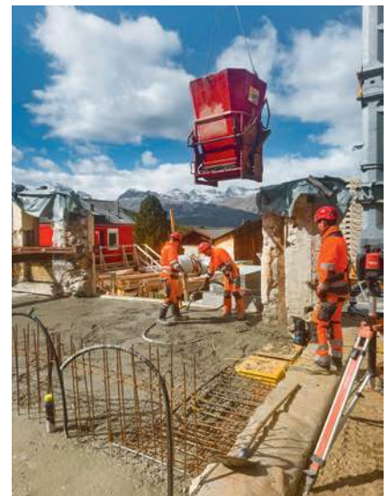
wenn das Wetter passte ist dies ein wunderschöner Bauplatz, betonieren der letzten Decke
