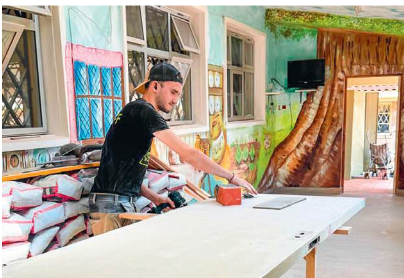
Schreiner Davide Menghini bearbeitet Türen und installierte das Elektrische
