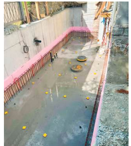
im untersten Anbau befindet sich der Veloraum, die Wände werden einhäuptig gegen die Baugrubensicherung betoniert
