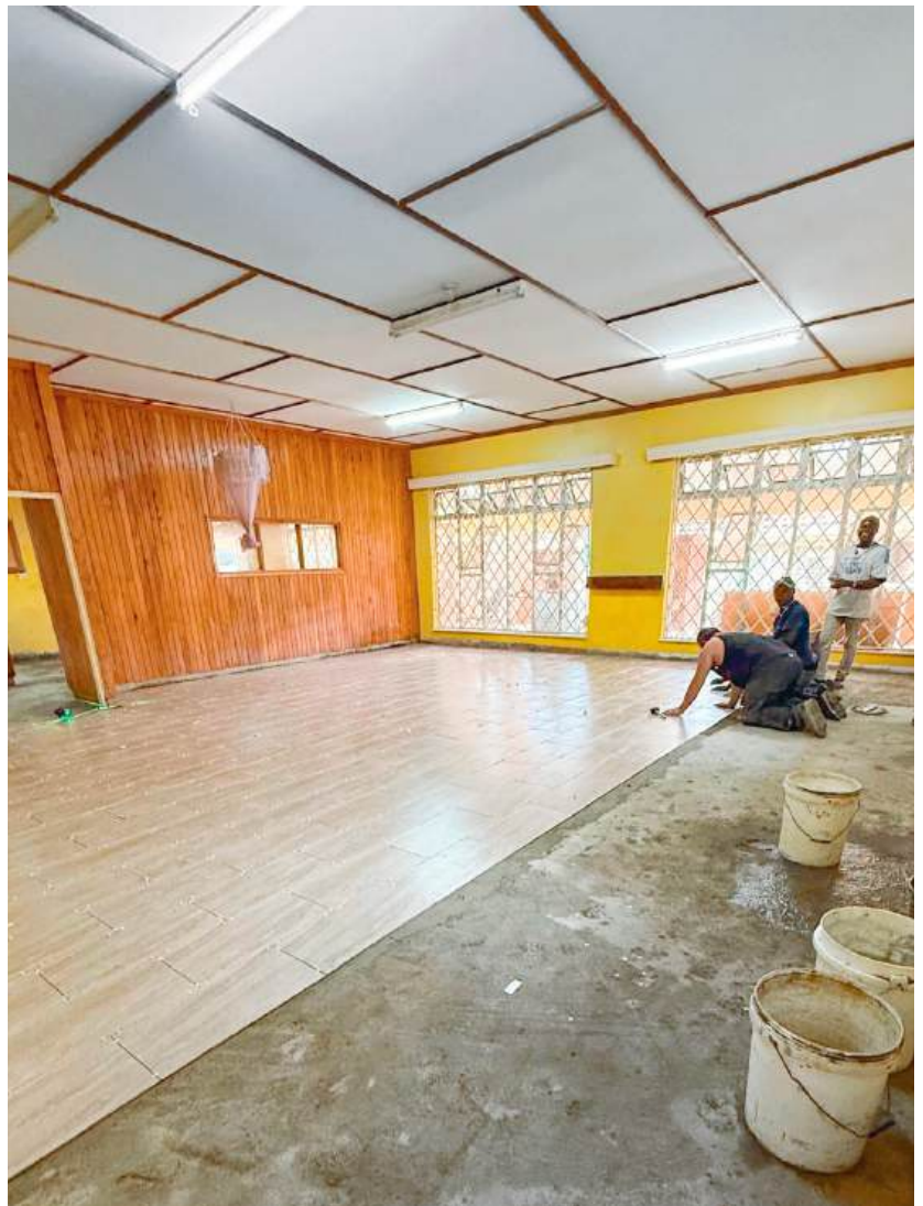
unter Aufsicht von Paolo Crameri wurden die Bodenplatten mit dem Laser verlegt
