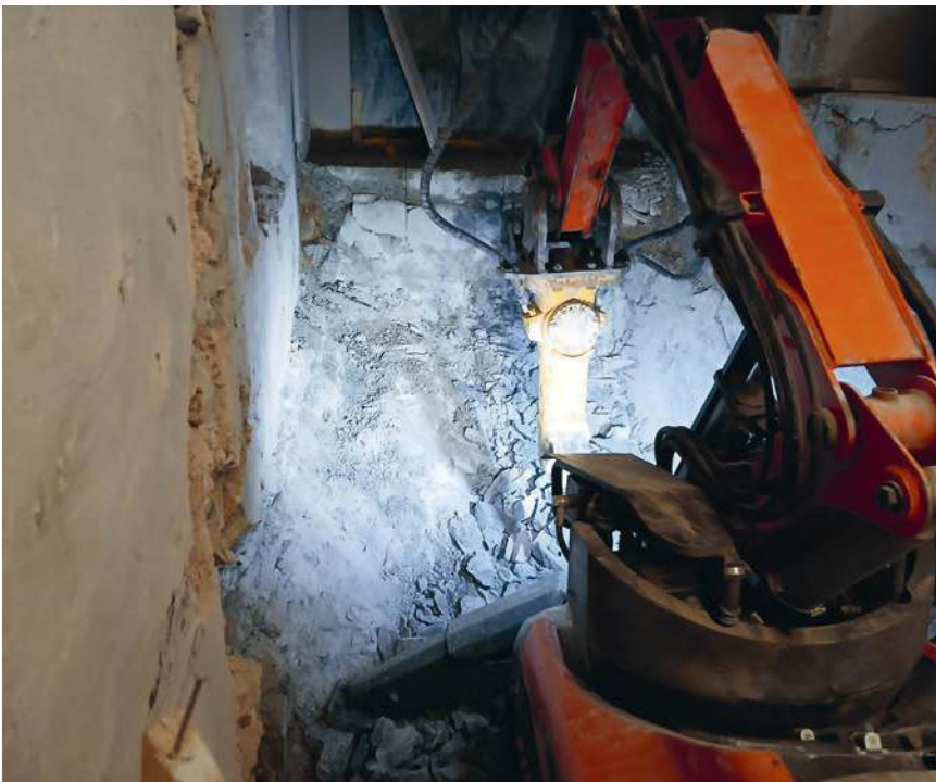
der Abbruchroboter spitzte anschliessend 1.5m in die Tiefe
