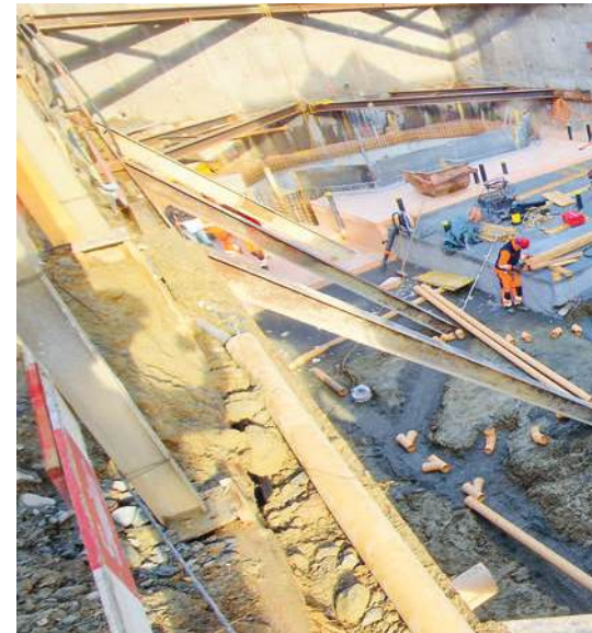
die vielen Leitungen unter der Bodenplatte forderten uns
