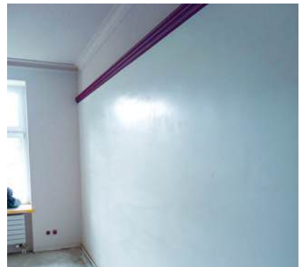
als Basis für die Tapeten erstellen wir überall Glattputz
