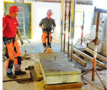
Improvisation war gefragt um die schweren Betonteile nach draussen zu bringen
