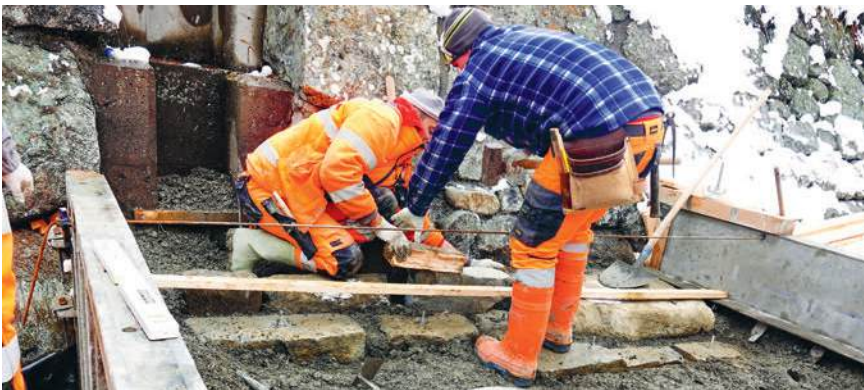
Stein um Stein wurde mit dem Pneubagger und dann von Hand in den frischen Beton gesetzt
