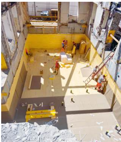
das ganze Untergeschoss wurde isoliert und mit einer gelben Wanne gegen Feuchtigkeit abgedichtet
