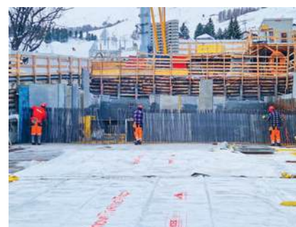
die letzten Wände vor Vollendung des Rohbaus
