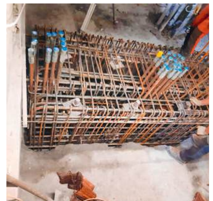
im Riegel ersichtlich die Mikropfähle sowie die gebündelten Gewi Stahlarmierungen
