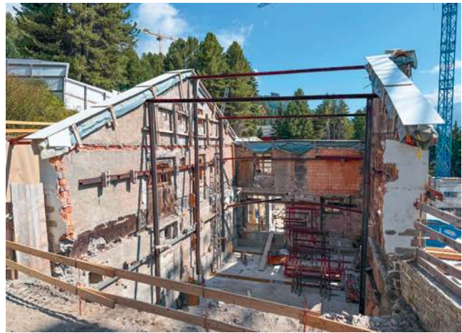
die mit Stahlträgern gestützte und zusammengehaltenen Aus- senwände der Villa, bevor alles abgebrochen werden durfte
