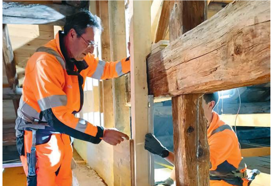
Ermanno Carnini beim Erstellen der Schalung rund um die Dachkonstruktion
