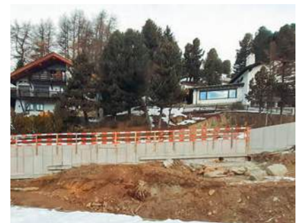
im Auftrag der Gemeinde erstellen wir als Abschluss eine Stützmauer entlang der Via Puzzainas
