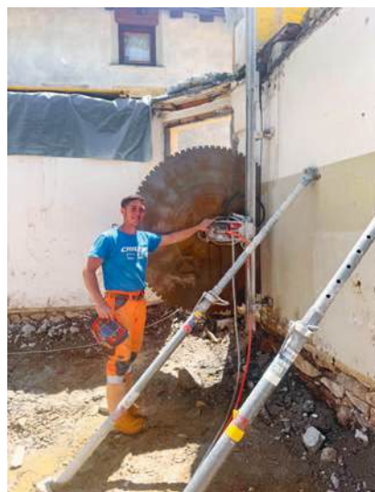
unsere Betonfräse mit Davide Taddei war auf dieser Baustelle im Dauereinsatz
