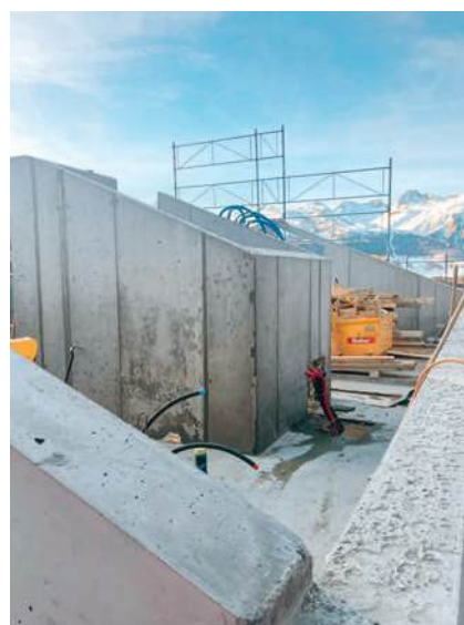
am 15. Dezember waren wir bereit und das Dach konnte montiert werden
