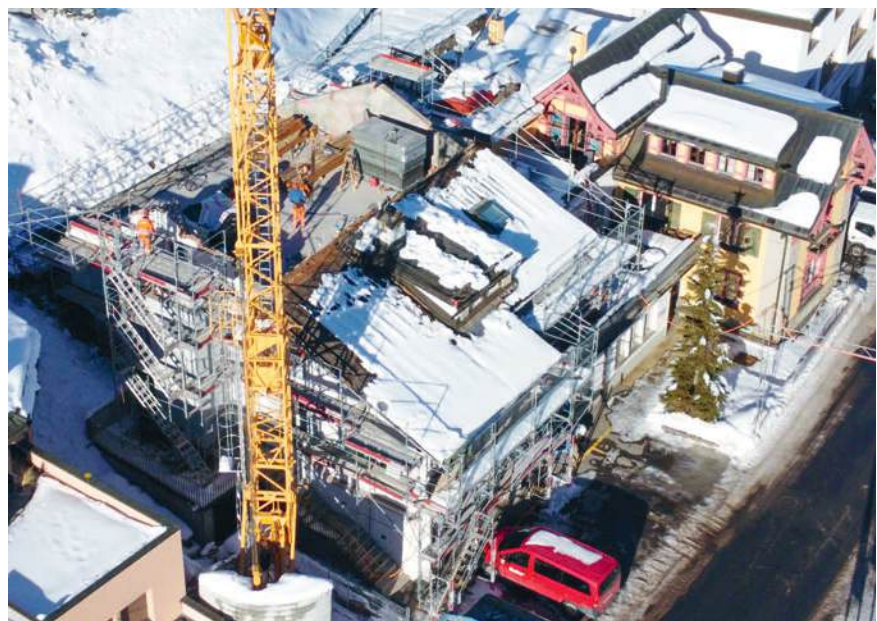
das gab es wohl noch nie in der Geschichte der Firma Seiler, Betonarbeiten und Aufrichten des Daches im Februar
