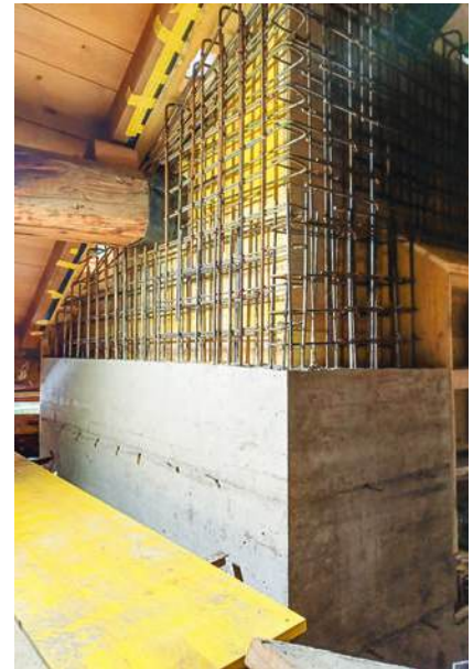
letzte Etappe der durchgehenden Wandscheibe vom Unter- bis ins Dachgeschoss
