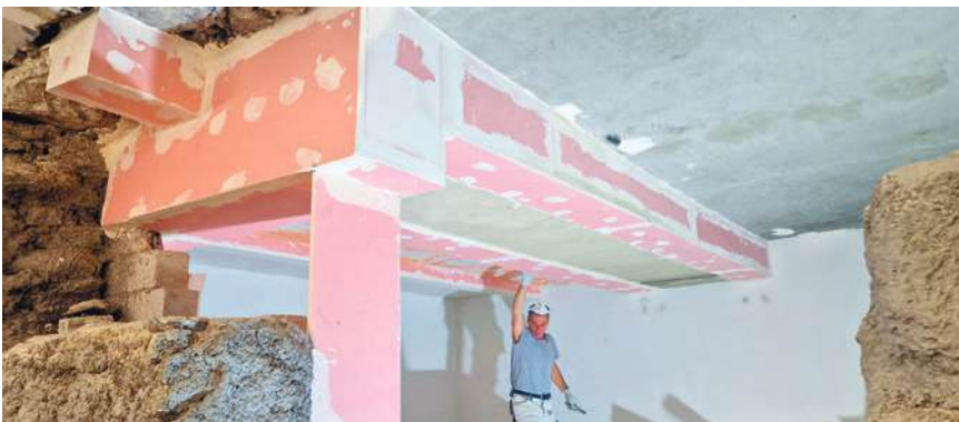
Stahlträger wurden mit feuerfesten Gipsplatten verkleidet
