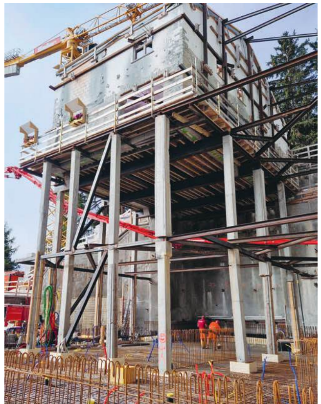
sie erinnern sich an die Villa die auf Stützen abgefangen wurde?
