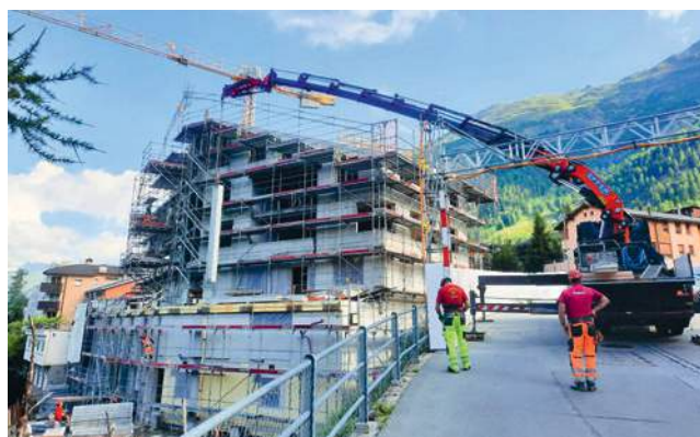
alle vorgefertigten Stützen konnten nicht mit dem Baustellenkran versetzt werden
