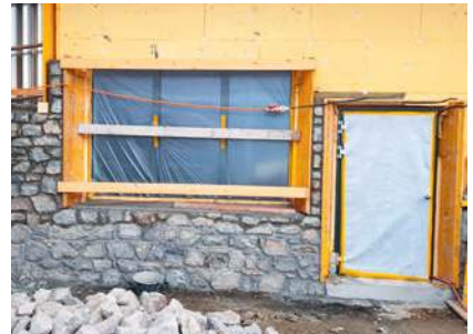
schon im Mai begannen wir mit der Natursteinverkleidung der Pumpstation
