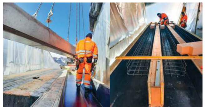
im Winter 2024/2025 erstellten wir direkt auf der Baustelle 16 Sichtbetonpfeiler
