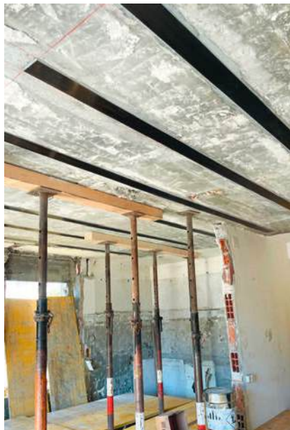
alte Decken wurden mit Klebarmierung verstärkt
