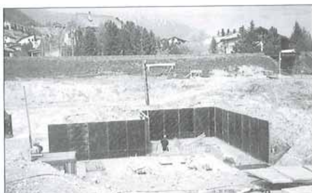
Armatura muri prima tappa
