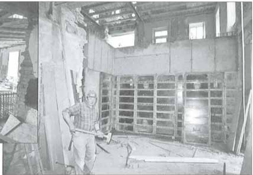
Die Wände wurden alle mit Aluframax geschalt. Alles von Hand, da ja kein Kran zur Verfügung stand.
