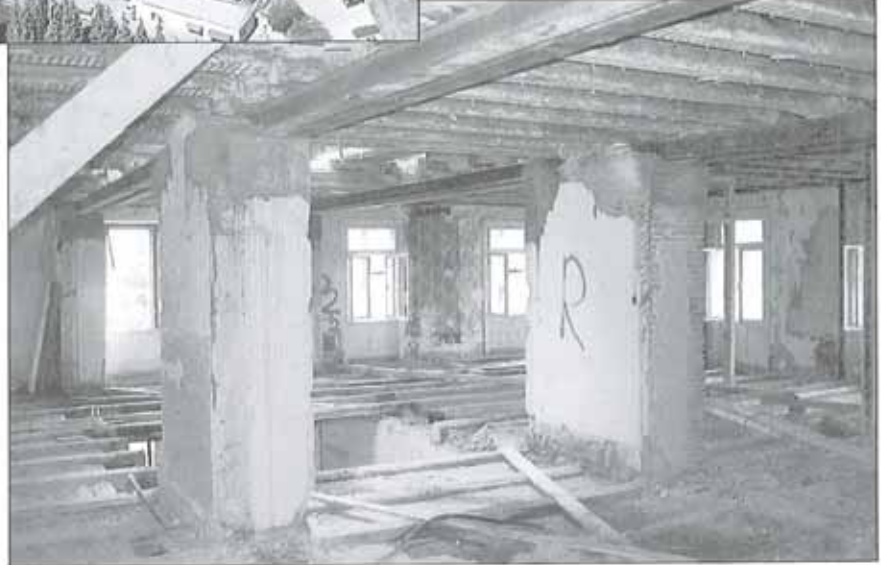
Unterfangung des Hotels auf der Seite der Garage.
