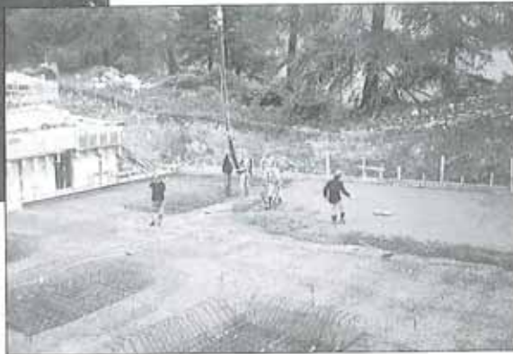
EH. betonieren der Bodenplatte
