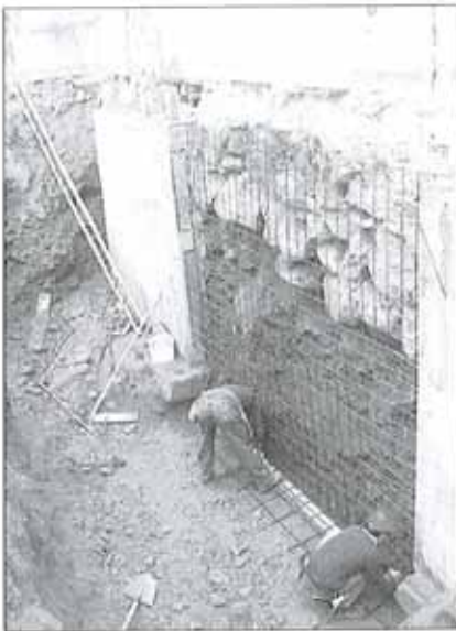
Unterfangung des Hotels auf der Seite der Garage.
