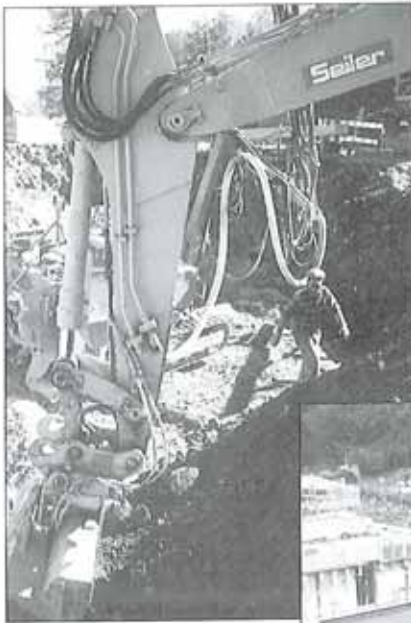
EFH Hess, Hydr. Bohr- und Aushubgerät
