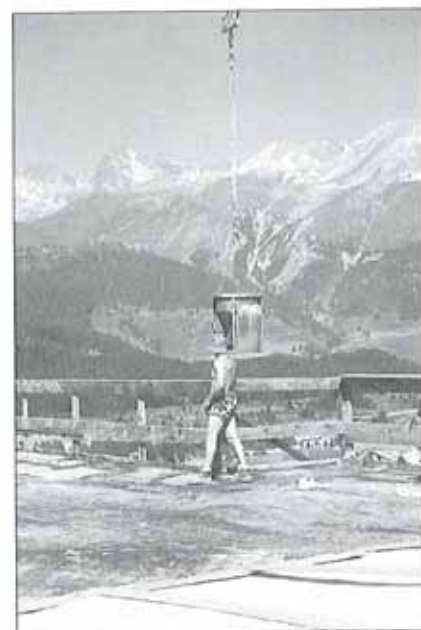
Der Kran bringt neue Calmosteine zum Mauern durch die Dachöffnung.
