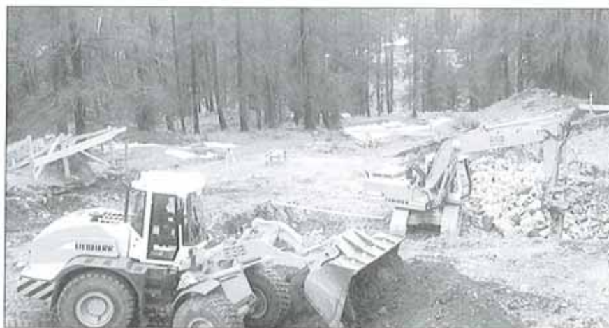
EFH Bodmer, Felsabbau mit hydr. Abbauhammer
