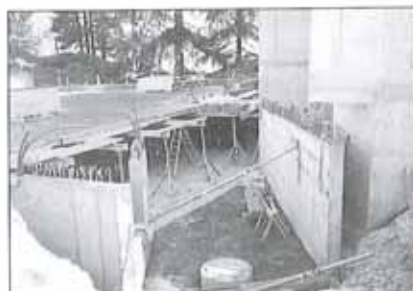
EH. Einfahrt und Deckenschalung
