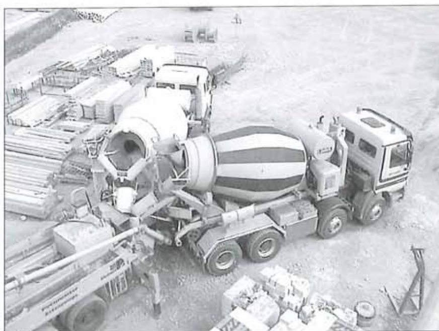
Betonieretappe Tiefgaragendecke mit Betonpumpe
