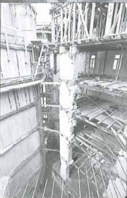
Linker Teil bereits wieder aufgebaut. In der Mitte sieht man die Pfeiler und die alten Decken die zur Aussteifung und zum Stützen der Fassade belassen wurden. Blick über 7 Stockwerke.
