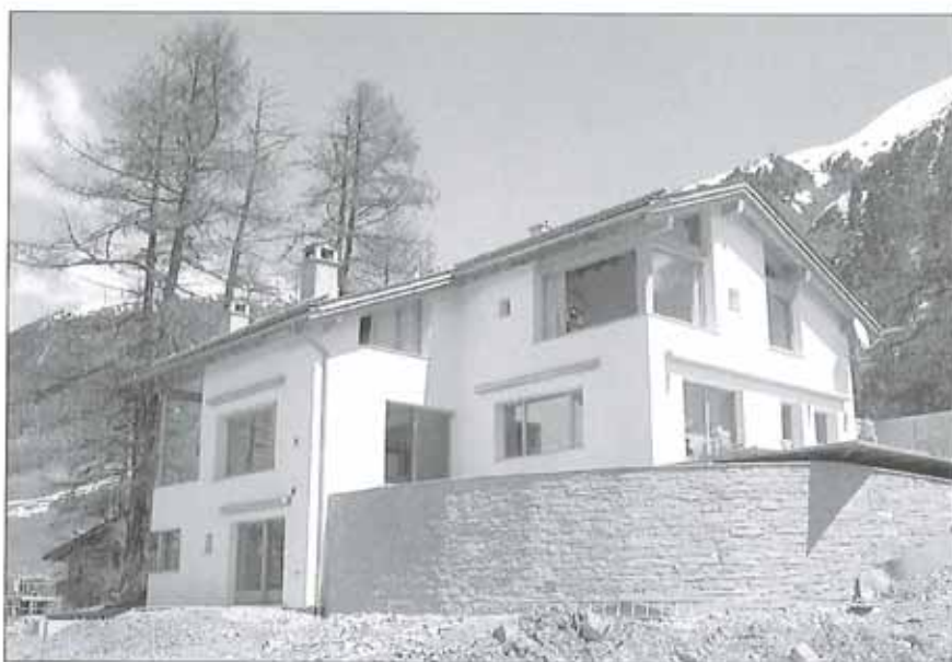
EFH Hess, Mai 2001, Umgebung noch nicht fertig
