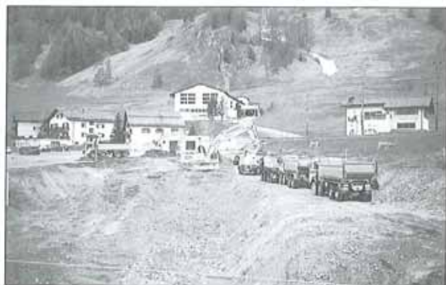
Scavo piano interrato ( ca. con 21 camion)
