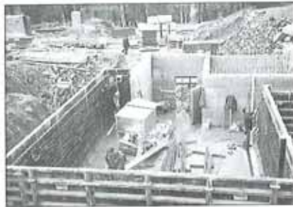
EFH Hess, Wände im UG, 10/99
