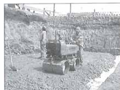
Materialersatz bei schlechtem Baugrund
