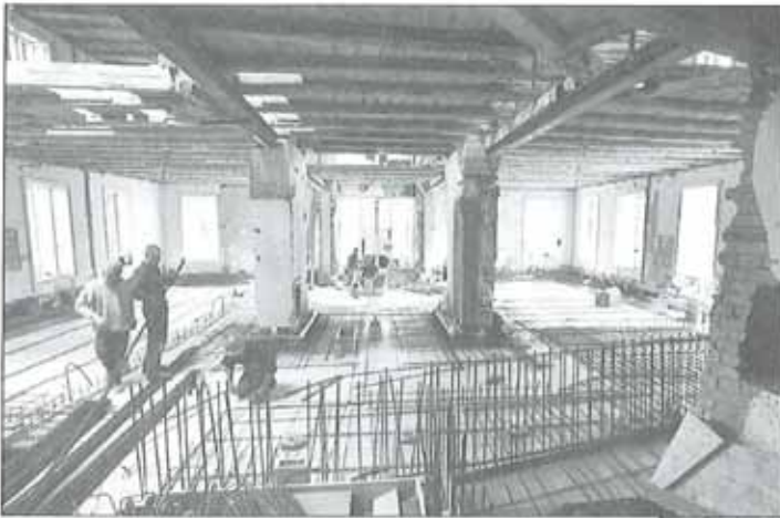
Es wurde immer um die Stützpfeiler betoniert, welche nach dem Einziehen aller Decken abgespitzt wurden.
