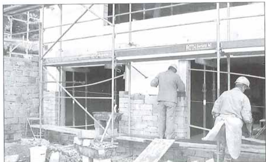
EFH Bodmer, Vormauerung der Fassade mit Natursteinen, «Soglio-Gneis»
