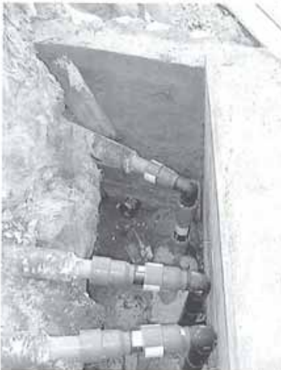
Verkleidung mit Betonmauer, innen
