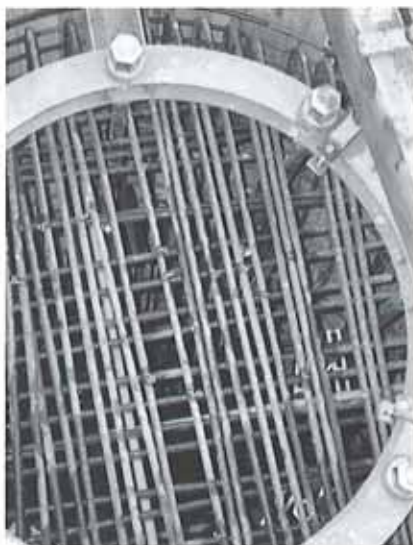
Wo soll da noch der Beton hin?/ Dove può entrare qui ancora il calcestruzzo?
