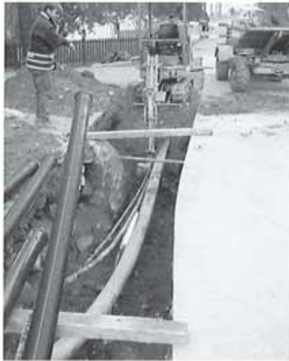
Grabarbeiten neben bestehenden Leitungen
