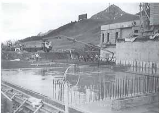
Betonieren der 1050 m 2 grossen Bodenplatte
