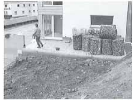
Decke über Werkstatt Pünchera isolieren und schützen
