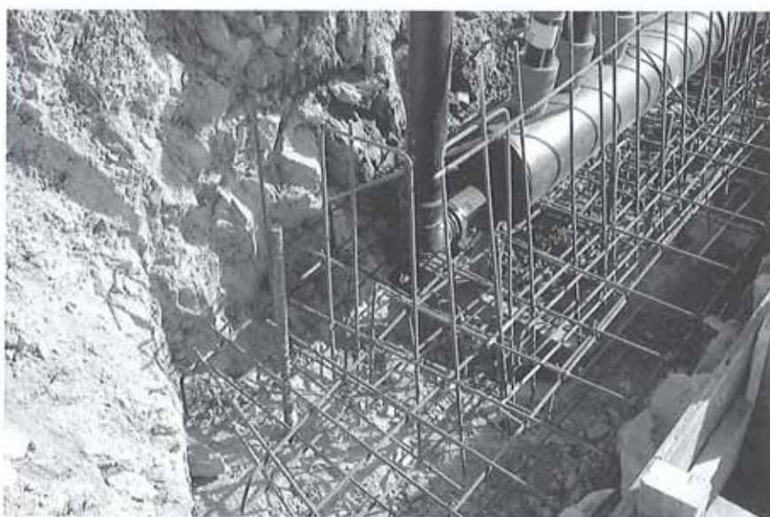
Fassungsstränge vor dem Einbetonieren
