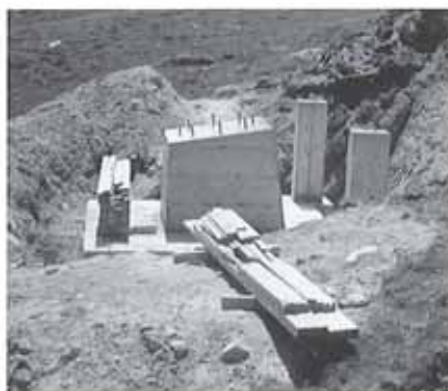
Vor dem Hinterfüllen Mast Nr. 5/ Prima di riempire lo scavo palo 5
