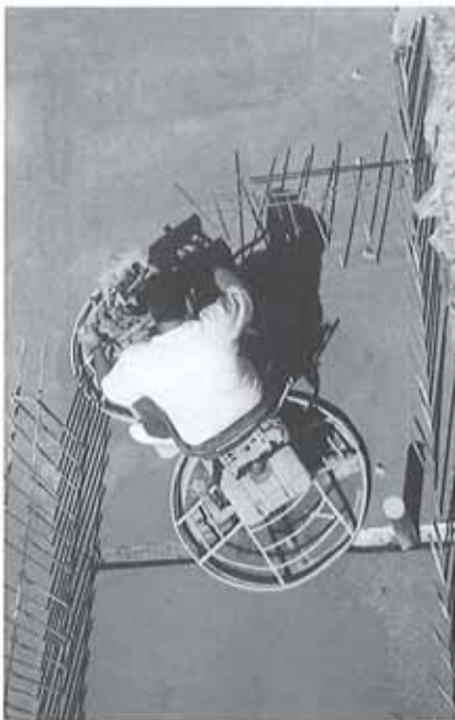
Bodenplatte wurde sofort fertiggestellt nach dem Betonieren (Monobeton)
