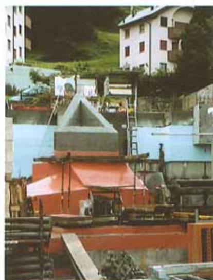
Eindrückliches und teures Oblicht über dem Verbindungsgang zum Haus C
