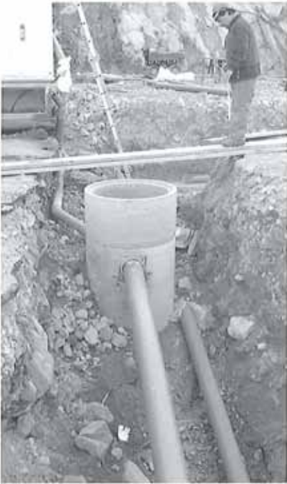
Kontrollschacht begutachtet von Polier Ferruccio Macsenti
