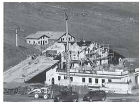
Arbeiten am neuen Dach/ Lavori per il nuovo tetto
