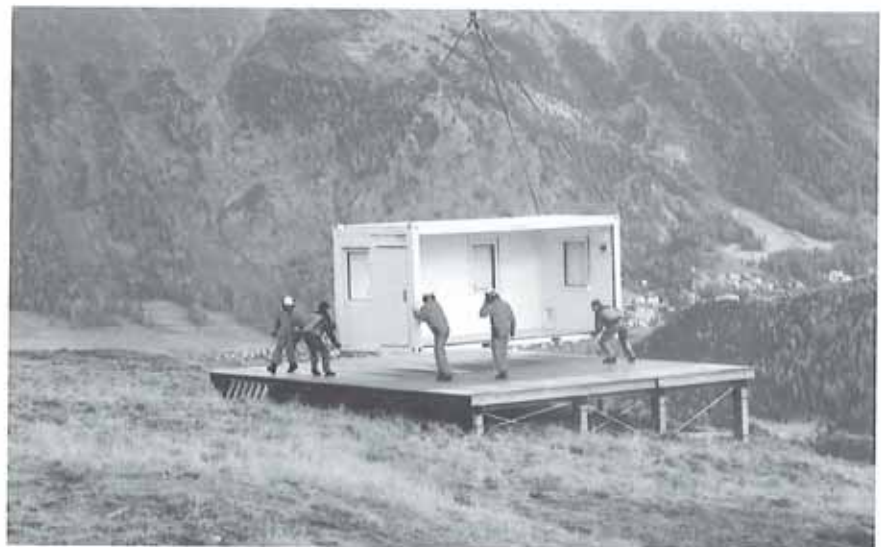
Setzen der Container für die Hubs mit Super-Puma-Helikopter
