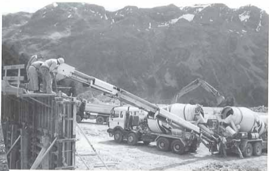
Betonieren mit Förderband ausserhalb des Kranbereiches
