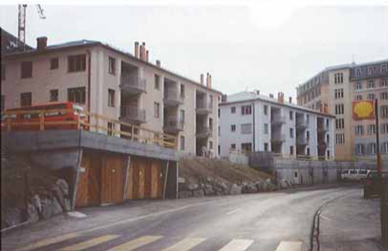
Überbauung Residenz Roseg Häuser A + B (von Via Maistra)
