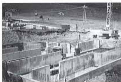
Zwischenwände Reservoir/ Muri di ripartizione nel Reservoir
