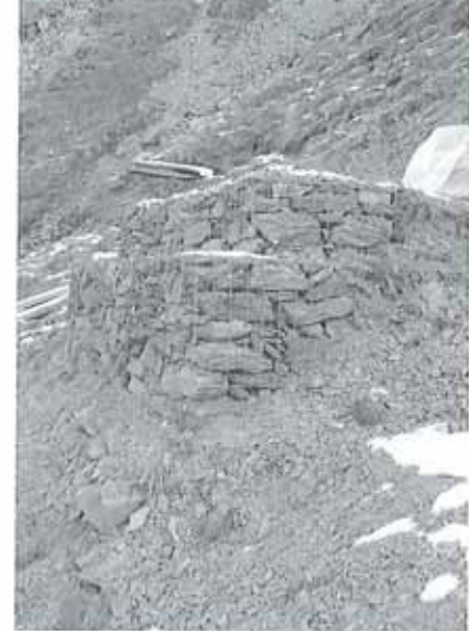
Verkleidung mit Steinkörben, aussen
