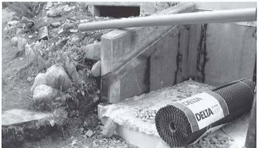
Chesa Cilgia: Sanierungsarbeiten
