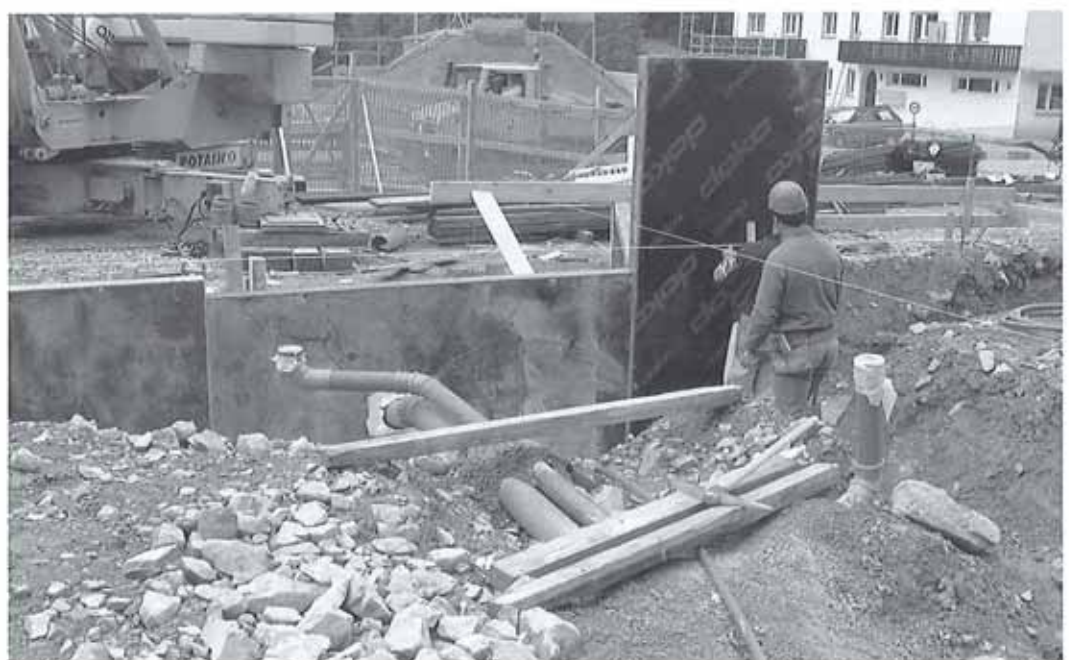
Kanalisation und Schalung Frostriegel
