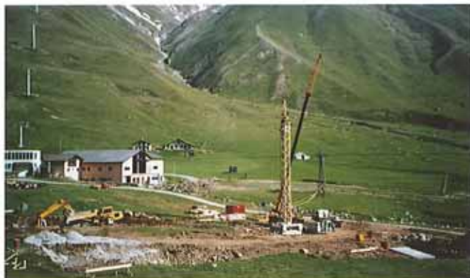
Bauplatz- installation/ Installazione cantiere
