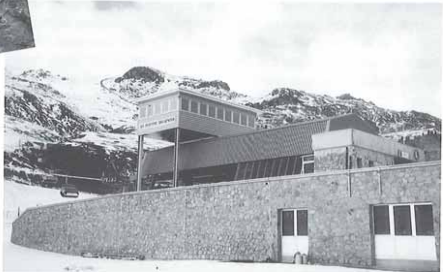
Südansicht mit der Natursteinverkleidung und mit dem Aufbau für die Zeitmessung
