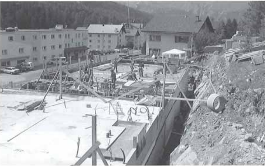
Decke Werkstatt Pünchera betoniert; Perl eingeschalt
