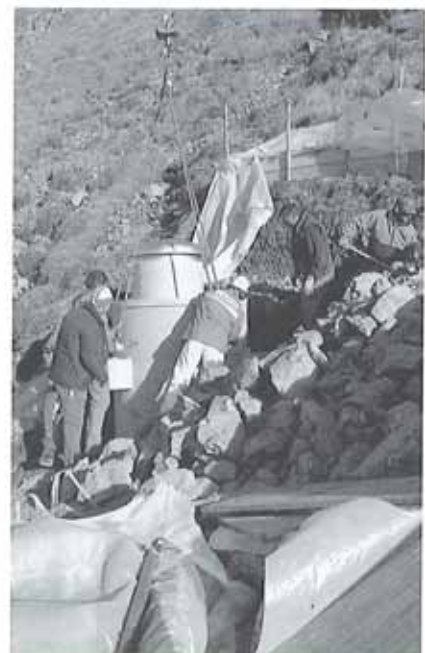
Versetzen des WABE-Schachtes
