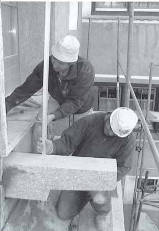
Granitkonsole versetzen für neue Balkonplatte
