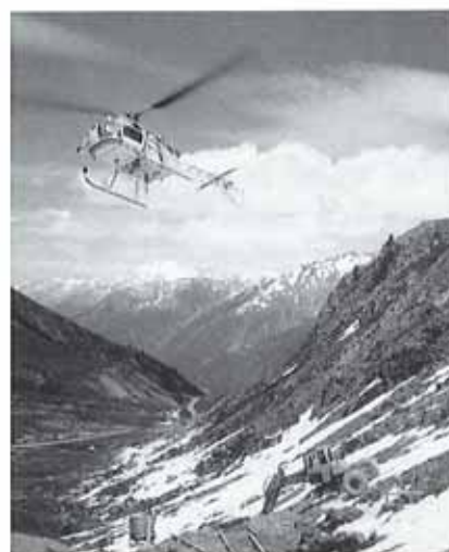
Heli Bernina beim Betonieren/ Heli Bernina al getto piloni
