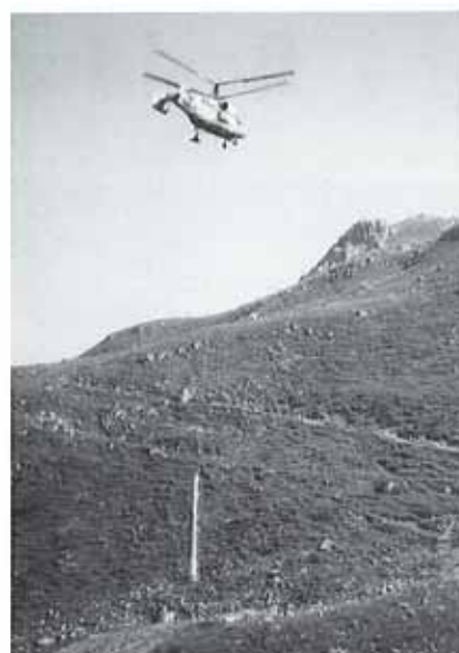
Helikopter «Kamov» beim Stützen setzen/
