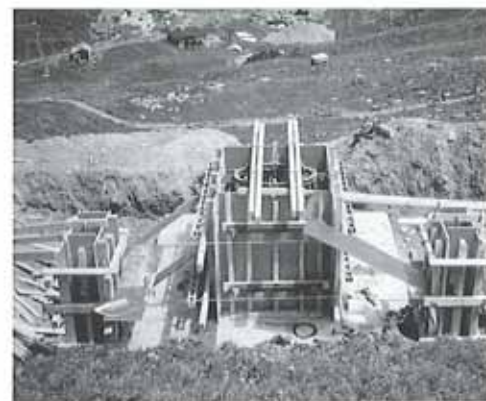
Kopfschalung (Niederhalter)/ Cassero testa pilone
