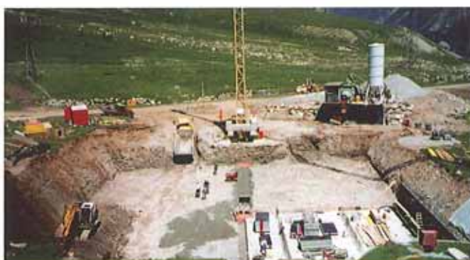
Erste Etappe Bodenplatte/ Prima tappa platea
