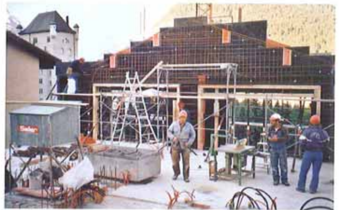
Schalung Firstfront MFH / Cassero frontespitzi
