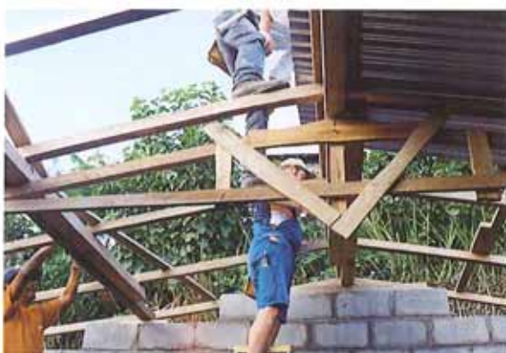
Fachwerkkonstruktion mit Wellblechdach / Costruzione del tetto coperto con lamiera
