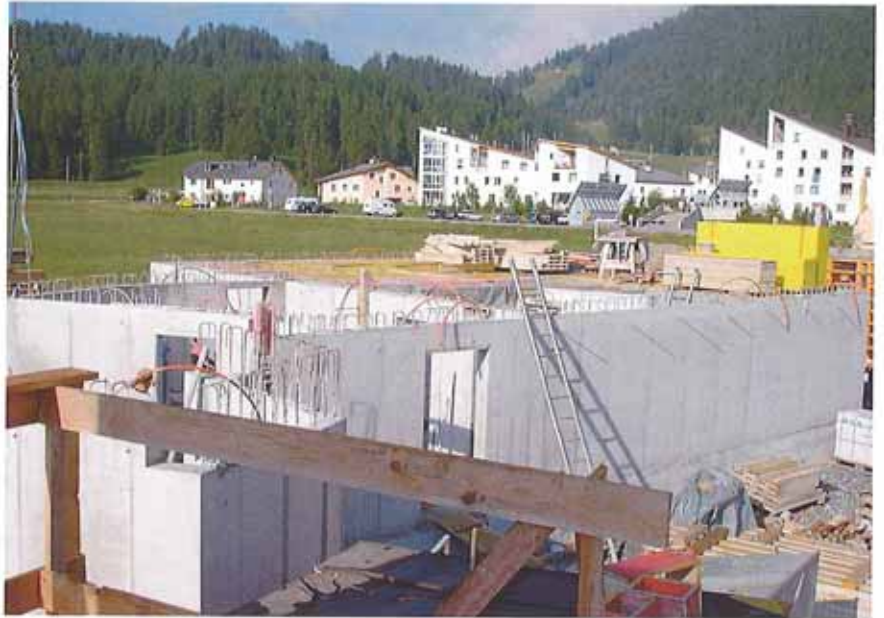
Ansicht des Kellergeschosses
