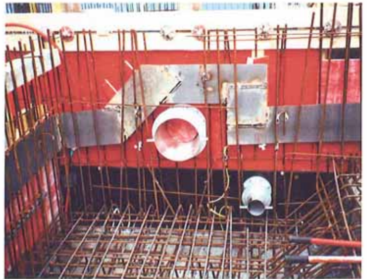
Detail Wassersperre / Dettaglio sbarra acqua
