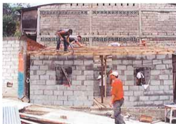
Aufrichten des Daches Montaggio del tetto
