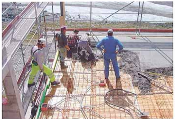
Betonieren des Überbetons der Holzdecke
