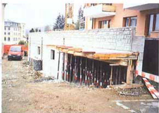
Aussenwände mit Prewi-Matrizen / Muri esterni con Prewo
