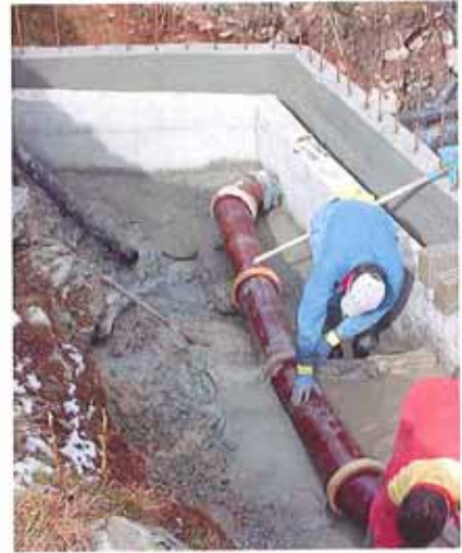
Abdichtung mit Lehm und Lehm-Querriegel in Bearbeitung
