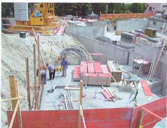
Konventionelle Wandschalung Untergeschoss Mehrfamilienhaus
