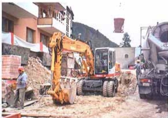
Aushub und Unterfangung / Sottomurazione e scavo
