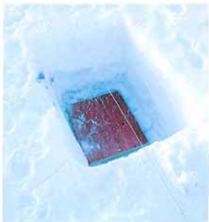
↓ Fundament für Joch, z.T. bis 2 m ab bestehendem Terrain mit Schnee und Wasser aufgefüllt
