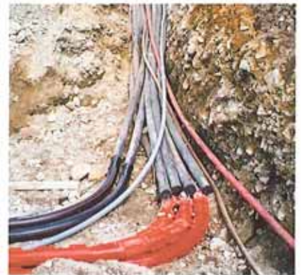
Umlegung Kabelblock / Sistemazione cavi Rätia Energie
