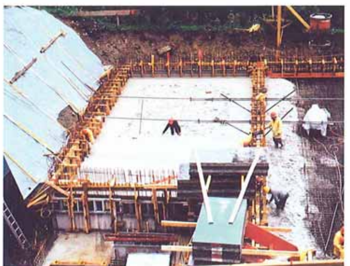
Bodenplatte betonieren / Getto platea
