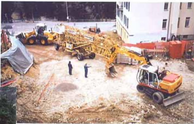
Kranmontage / Montaggio gru
