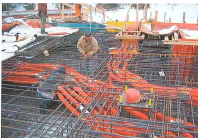
Bodenplattendicke zwischen 0,8 und 1,2 Meter
