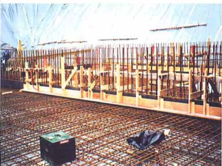
Abschalung mit Hohlkehle
