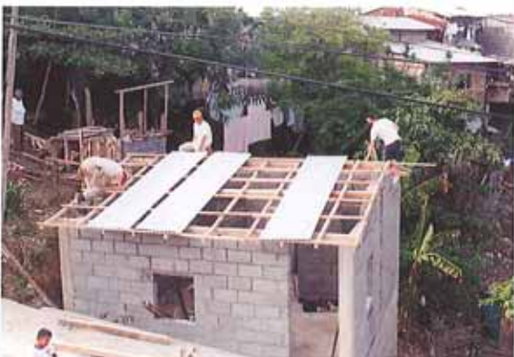
Fachwerkkonstruktion mit Wellblechdach / Costruzione del tetto coperto con lamiera
