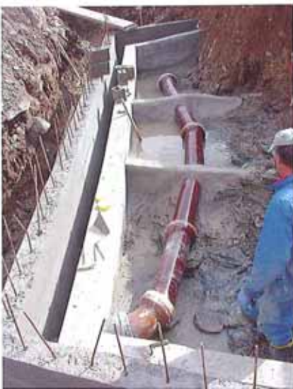
Betonplatte über Lehmschicht
