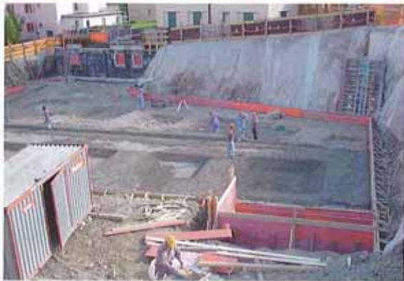
Magerbetonsohle mit Fundamentvertiefungen Tiefgarage
