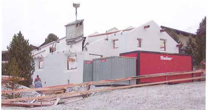
Kurz bevor der Bagger auffuhr. Das ganze Haus wurde geräumt, so dass im eigentlichen Abbruch nur noch Beton und Backsteine durch die Maschine getrennt werden mussten
