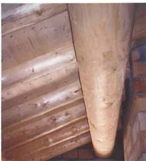
Untersicht des schönen Rundholz-daches
