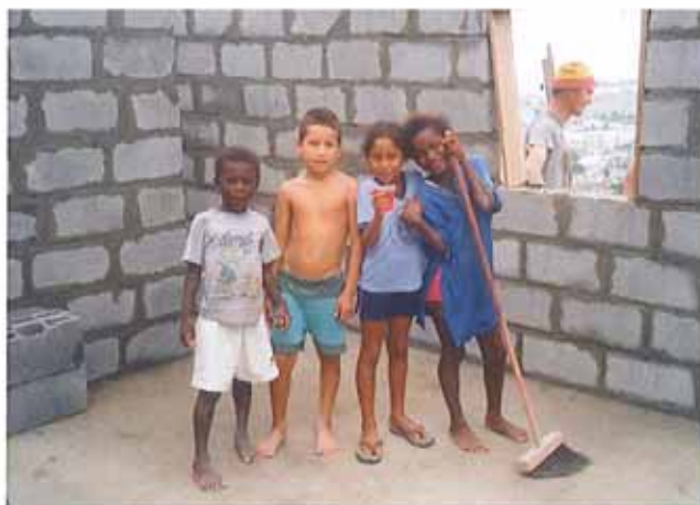
Baureinigung / Pulizia cantiere
