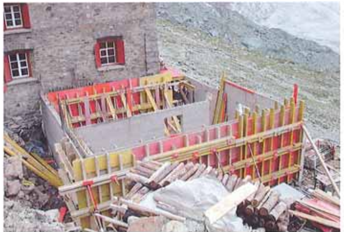
↑ Sichtbeton mit Schaltafelstruktur, ↓ scharfkantig; und das auf 2640 m ü. M., betoniert mit dem Helikopter
