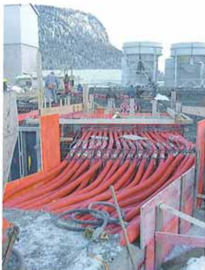
Insgesamt wurden 68 Kabelschutzrohre für die Stromzuleitung und die Steuerkabel verlegt
