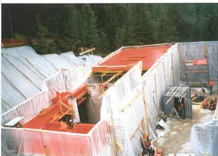
Nachbehandlung Beton / Protezione calcestruzzo
