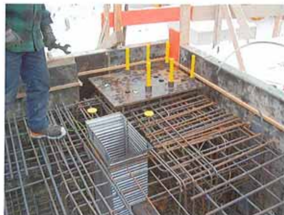
Fussplatte mit maximaler Belastung von 325 Tonnen!
