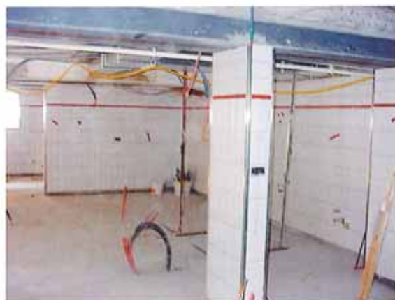
Die Küche vor den Installationen
