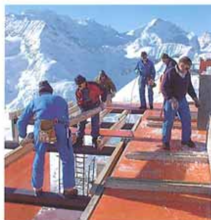
Decke der Schutzgalerie zuschalen
