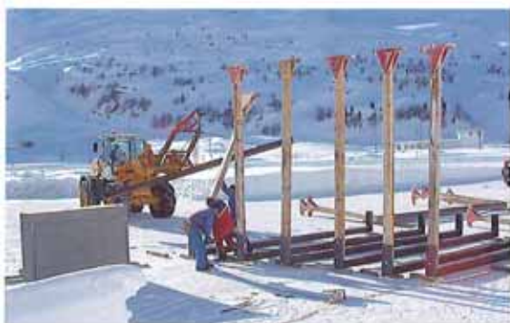
↑ Zusammenbau der Joche auf dem Lagalb-Parkplatz
