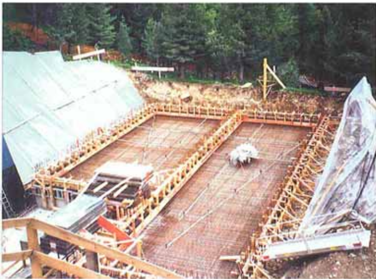
Armierung Bodenplatte / Posa ferro platea
