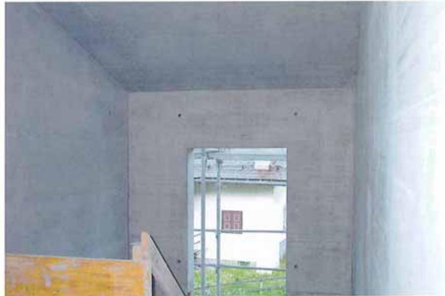
Treppenhaus in Sichtbeton, mit Schalltafelstruktur
