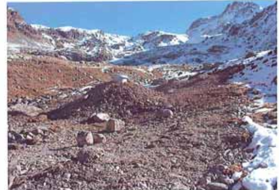
Fertig eingedeckte Quellfassung mit anschliessendem WABE-Schacht
