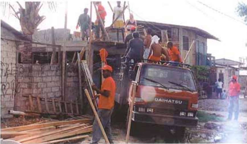
Materialtransport und -ablad / Trasporto e scarico del materiale
