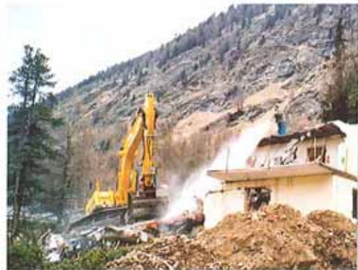
Abbruch Chesa Gloria / Demolizione casa Gloria
