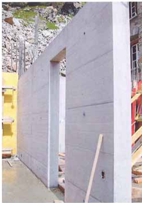
↑ Sichtbeton mit Schaltafelstruktur, ↓ scharfkantig; und das auf 2640 m ü. M., betoniert mit dem Helikopter
