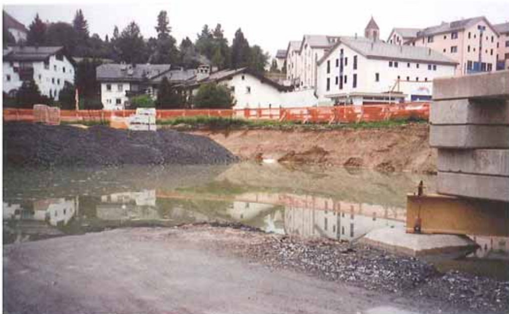
Überbauung Pros d'Islas mit Seeanstoss, aber nur wenn die Grundwasserabsenkung versagte
