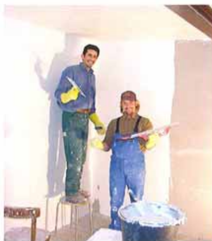
Ein Maschinist und ein Kranführer beim Feinabrieb (Bruno Manzo und Antonio Cometti)
