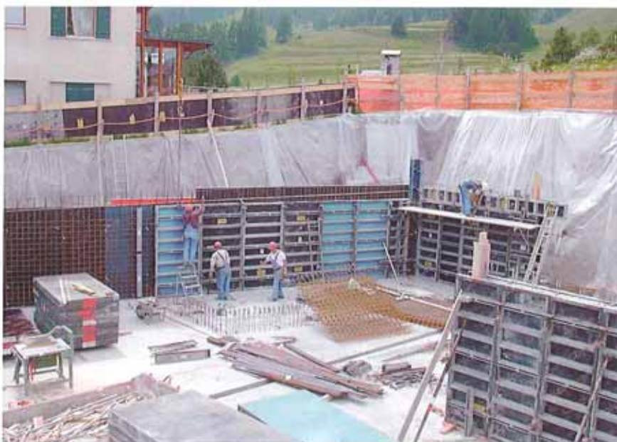
Grossflächenschalung Wände Tiefgarage
