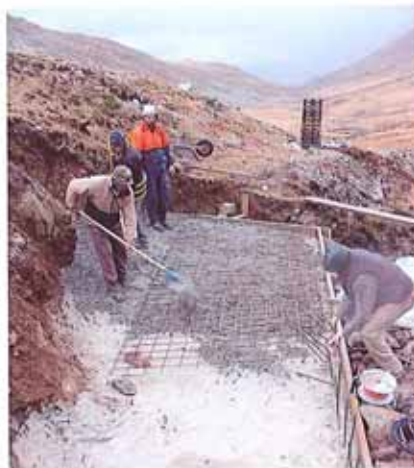
Betonplatte über Lehmschicht
