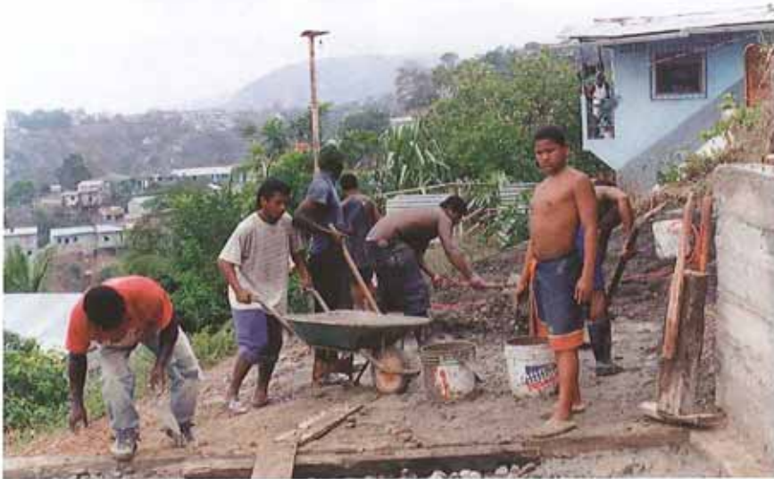
Die acht Familienangehörigen beim gemeinsamen Bau einer Bodenplatte Gli otto membri della famiglia nella costruzione di una platea
