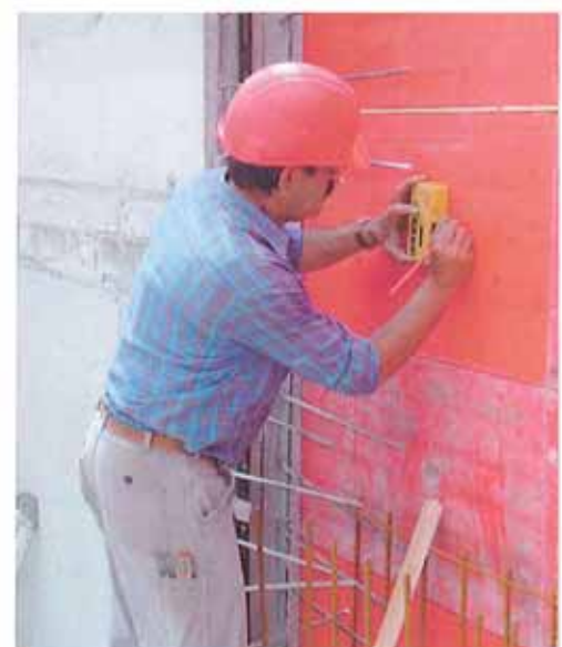
Polier Armin Lazzarini beim Meterriß erstellen
