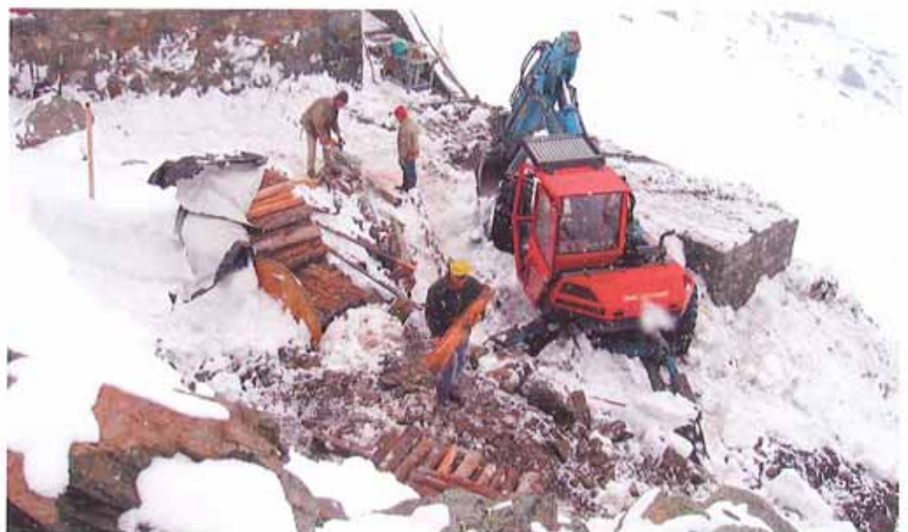
Die Aushubarbeiten beginnen
