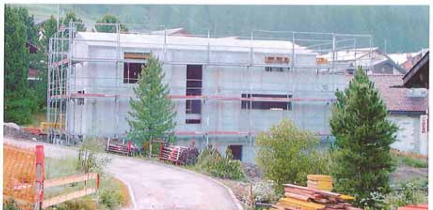
Fertiges Rohbau-Gebäude mit Betondach
