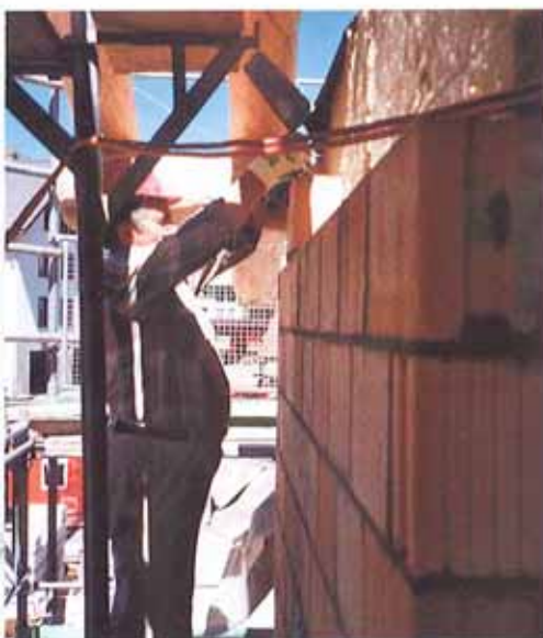
Tomaso Curti beim Erstellen des Fassadenmauerwerkes. Gut ersichtlich, wieso das Gerüst einen 30 cm Fassadenabstand braucht
