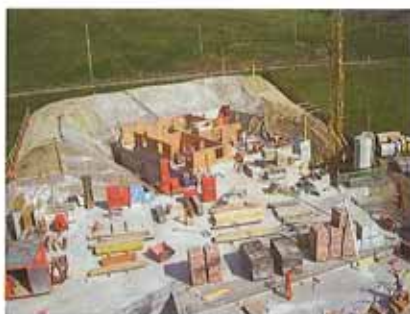
Wände EG Haus D, E / pareti pianoterra casa D, E
