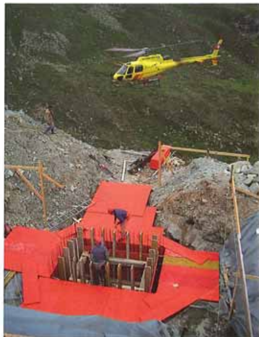
Boden und Wände betonieren mit Heli, Entleerungsschacht 2. UG
