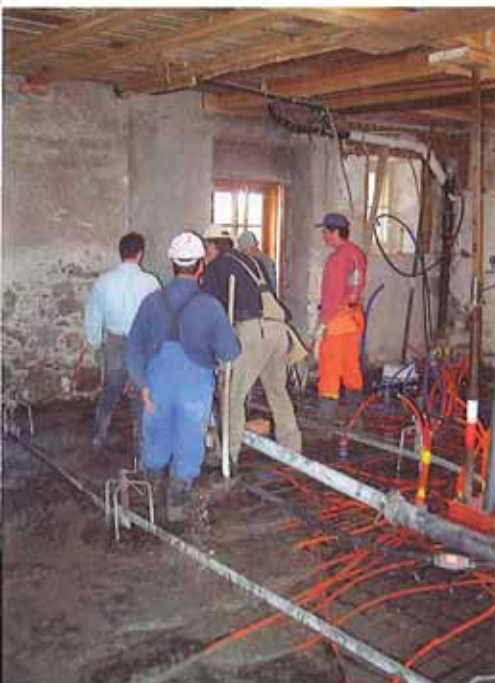
Decke über UG. Betonieren, innen
