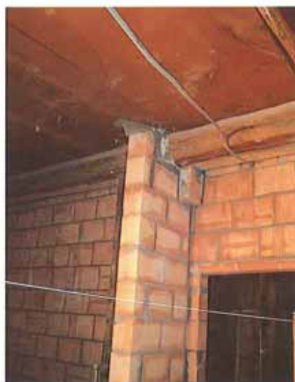
Zwischenwände im EG
