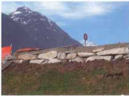
Zwischen den beiden Brücken wurde die Fahrbahn mittels Blocksteinen verbreitert
