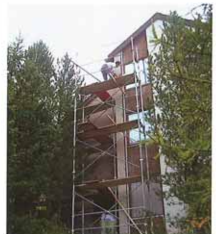
Antonio Martinho beim Verputzen einer Fassade
