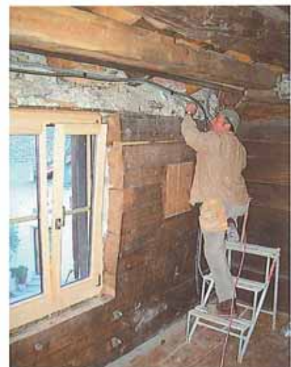
Wände im DG, vor Verkleidung
