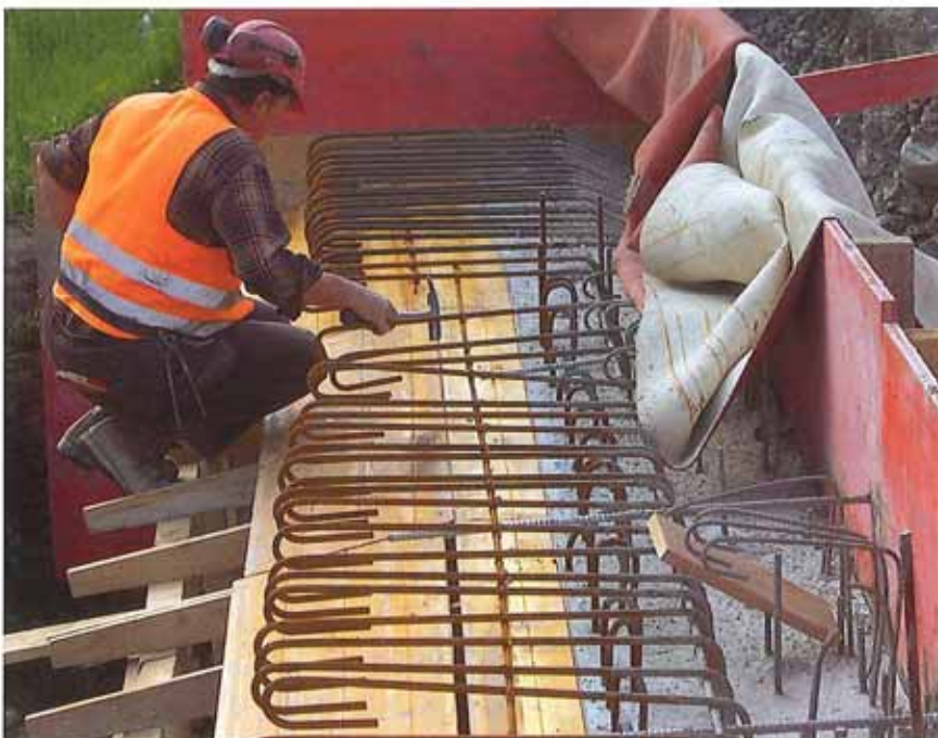
Verbreiterung bei den Flügelmauern. Die alten Flügelmauern wurden zuerst vorbetoniert
