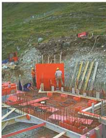
Decke über 1. UG, vor dem Betonieren
