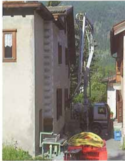
Decke über UG. Betonieren, von aussen
