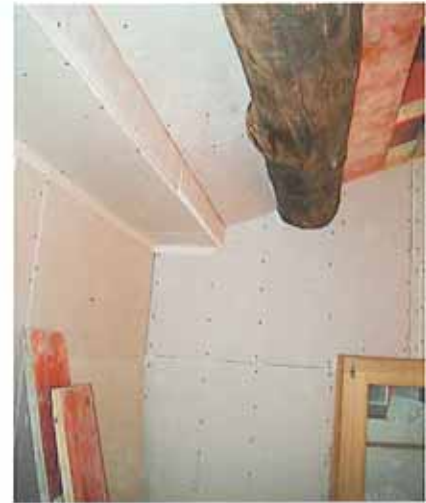
Wände im DG, nach Verkleidung mit Rigipsplatten
