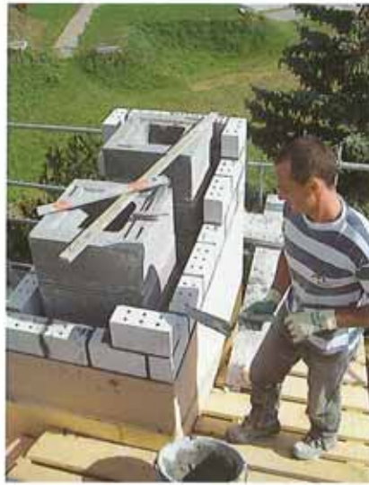
Kaminsanierung: Marcello Della Bella
