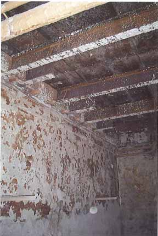
Decke über UG. Eisenträger mit Lärchenbohlen
