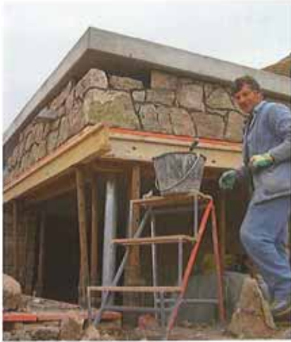
Davide beim Aufmauern des Sturzes
