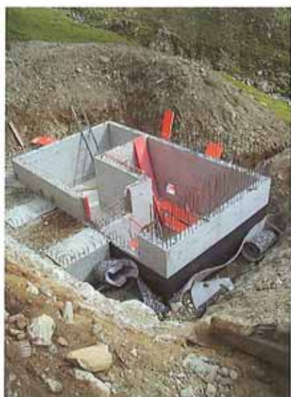
Wände im UG, ausgeschalt
