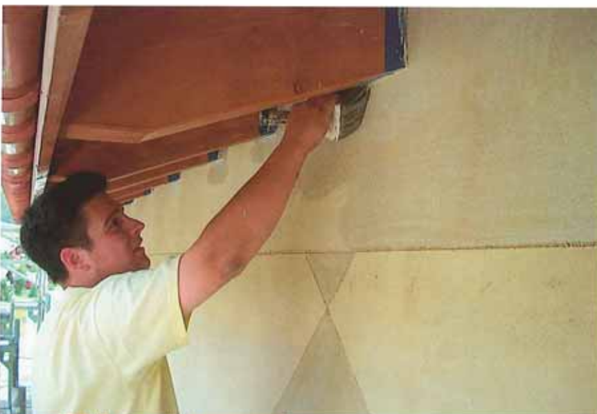
5. Sumpfkalk wird aufgetragen
