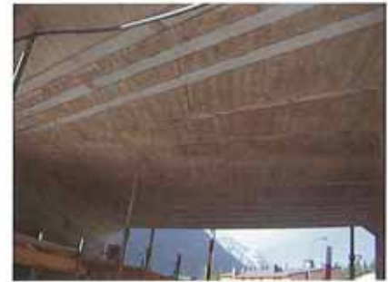
Die Brücke Cuntschett wurde von unten mittels geklebten Stahllamellen verstärkt
