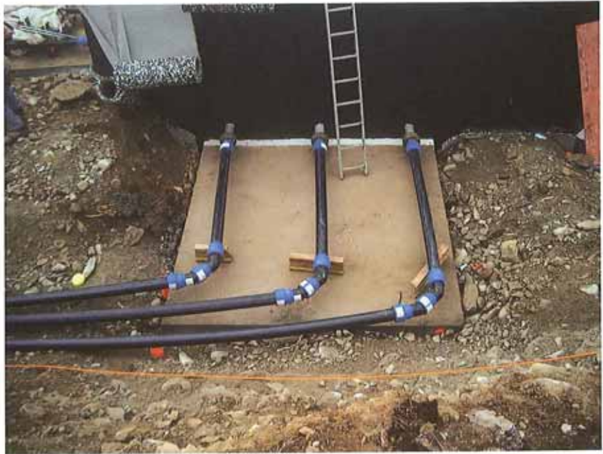
Schlepp-Platte mit Zuleitungsrohren
