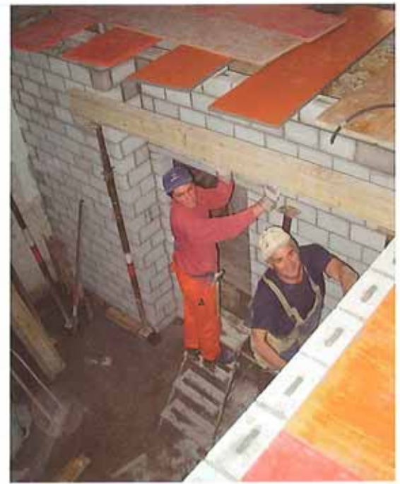
Marino und Matteo bei Schalarbeiten, Decke über UG
