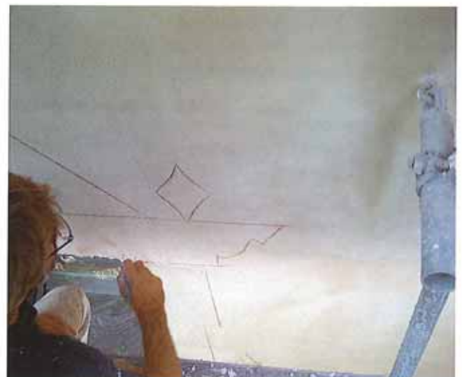
3. Herausheben eines Fensters
