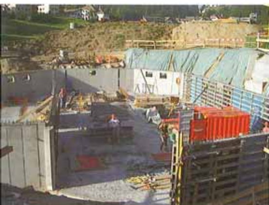
Wände Garage UG / muri autorimessa
