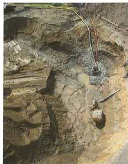
Aushub, man beachte die Lehmschichten / scavo strati di argilla
