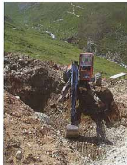
Aushub mit Schreitbagger, Antonio Cattaneo
