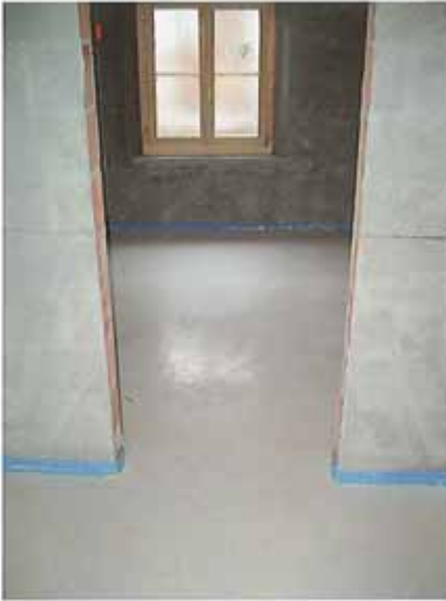
Böden mit Fliessestrich (Top Floor)
