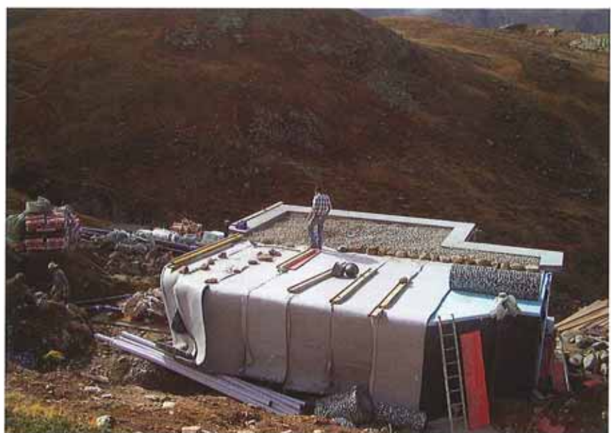
Sammelschacht vor dem Hinterfüllen
