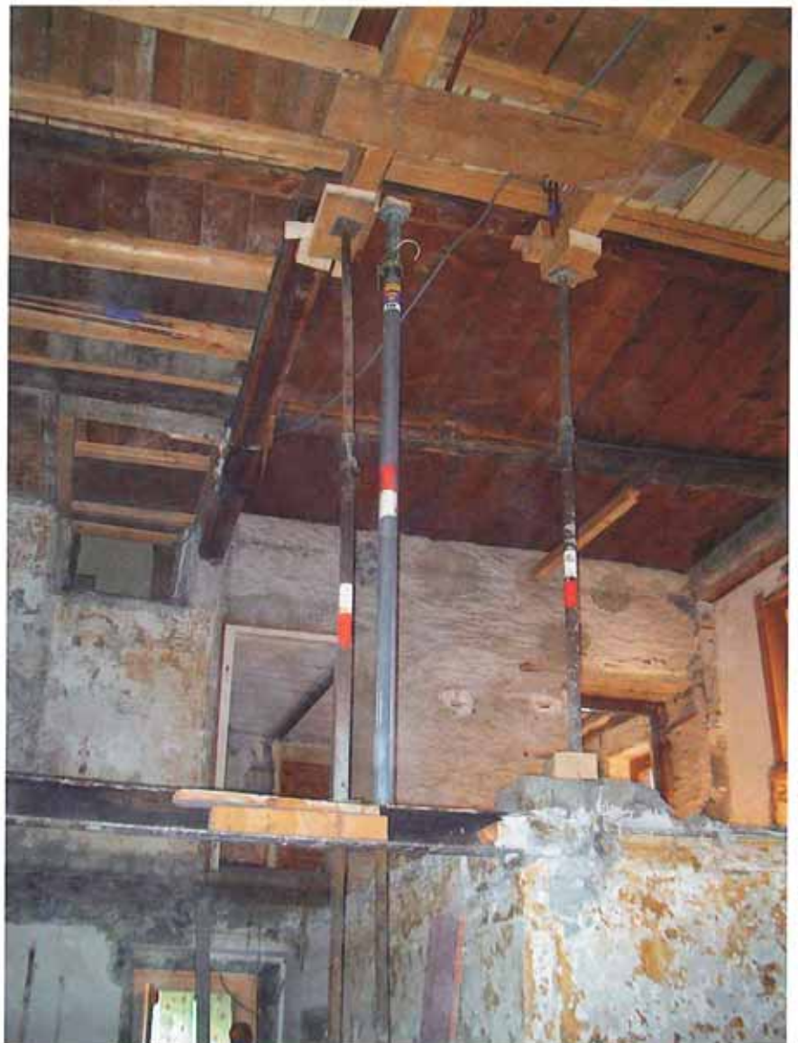
Abgespriesste Decke über EG. (Bereits entfernt, Decke über UG)
