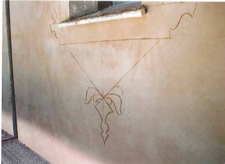
4. Fertig eingeritzter Grobrahmen
