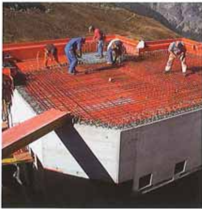
Decke über EG, vor dem Betonieren
