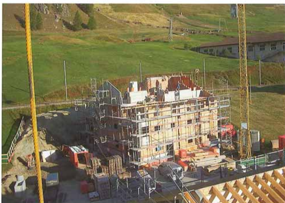
Bereit zum Aufrichten Haus D / pronto per mettere il tetto casa D
