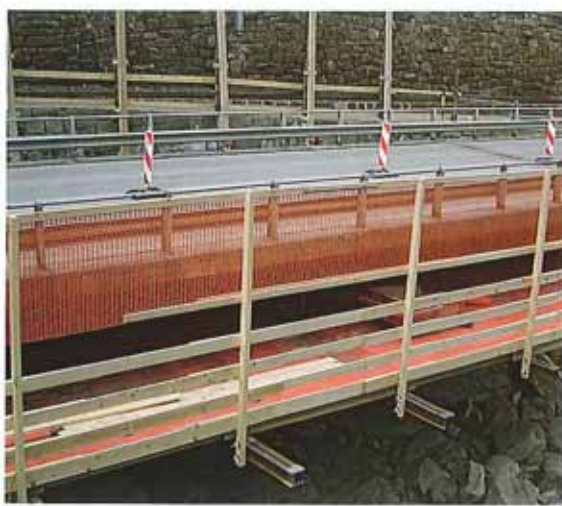
Fertiges Lehrgerüst und gleichzeitiges Schutzgerüst
