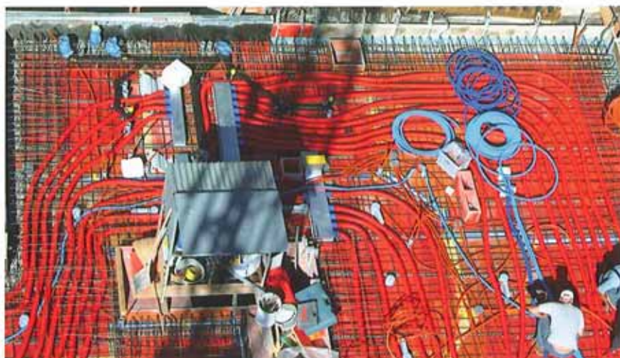
Lüftung, Sanitär, Elektrisch! Wo bleibt da noch Platz für Beton? Ventilazione, sanitario, elettrico, dove rimane il posto per il calcestruzzo?
