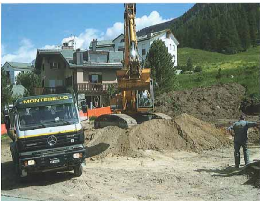
Der Aushub umfasste zirka 600\text{ m}^3 Scavo volume di 600\text{ m}^3
