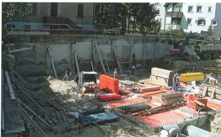
Schalung Decke 2. UG Cassero soletta secondo interrato
