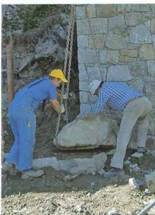
Beginn Blockwurf-Mauerwerk
