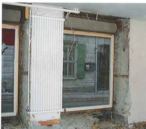
Bauherrin Sarah Cavegn legt selber Hand an
