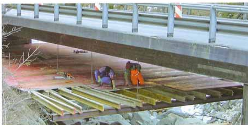
Erstellen des 600 m 2 grossen Lehrgerüsts unter der Brücke
