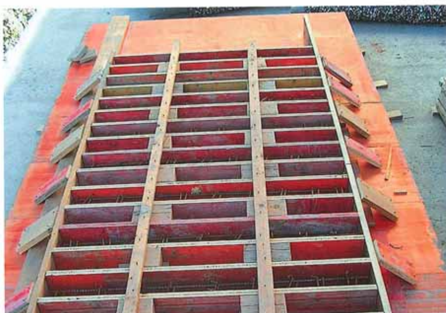
Schalung für die Betonpfeiler
