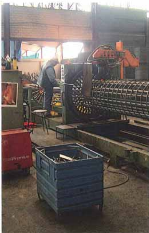
Zusammenschweissen von Armierungseisen für Pfahlfundationen
