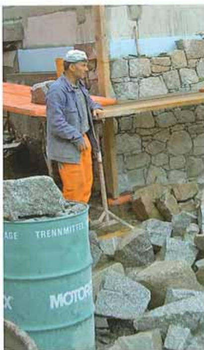
Beginn mit der Natursteinverkleidung
