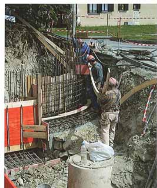
Frostriegel und Stützmauer geschalt
