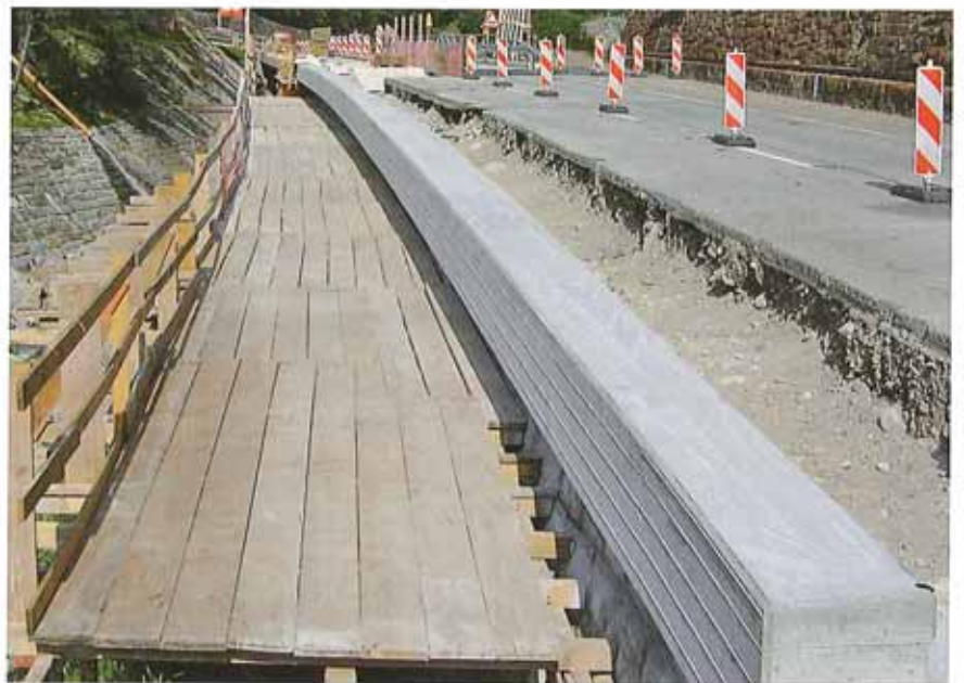
50 m 3 Stützmauer talseitig mit Kordon
