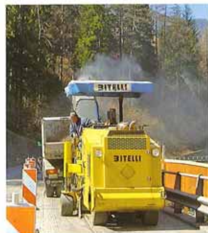
Abtrag des Belags mittels Belagsfräse
