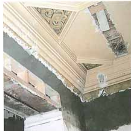
Decke abgefangen durch Versetzen zweier Stahlträger
