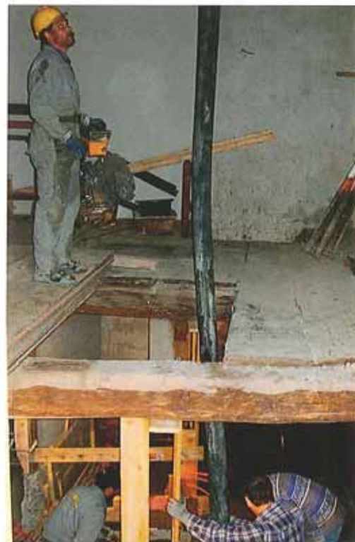
Betonierarbeiten im Untergeschoss mittels Betonpumpe durch die Eingangstüre
