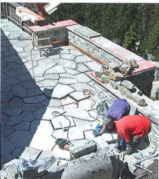
Gartensitzplatz mit Soglio-Quarzitplatten «wild» verlegen
