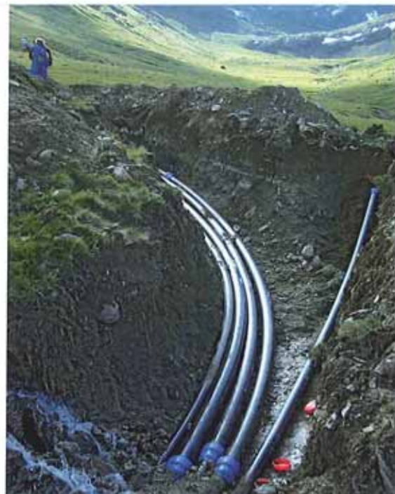
Abzweigung zu den Quellfassungen C bis F
