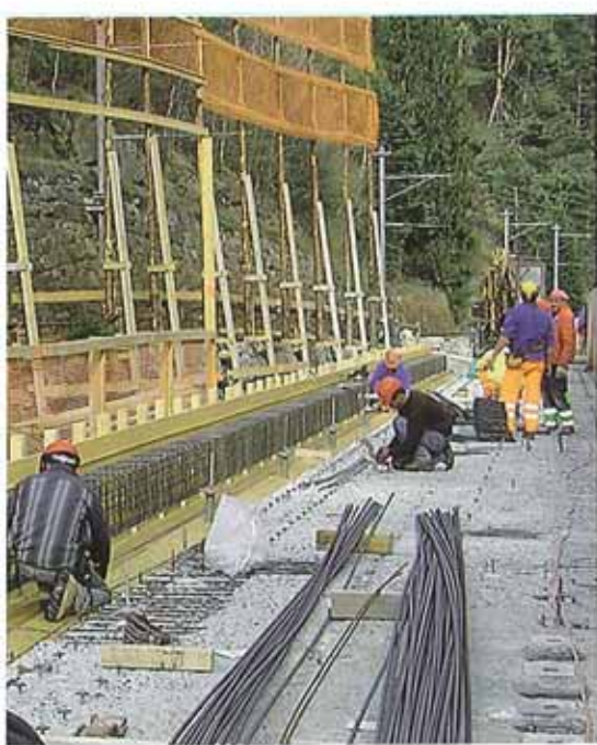
Armieren des Kordons. Gut ersichtlich auch das Schutzgerüst RhB im Hintergrund
