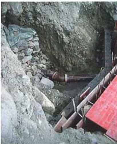
Querriegel betoniert und 2. geschalt
