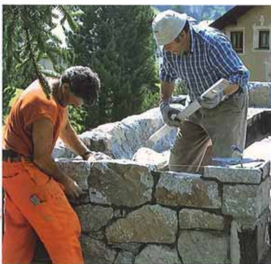
Davide und Tomaso beim Mauern der Brüstung
