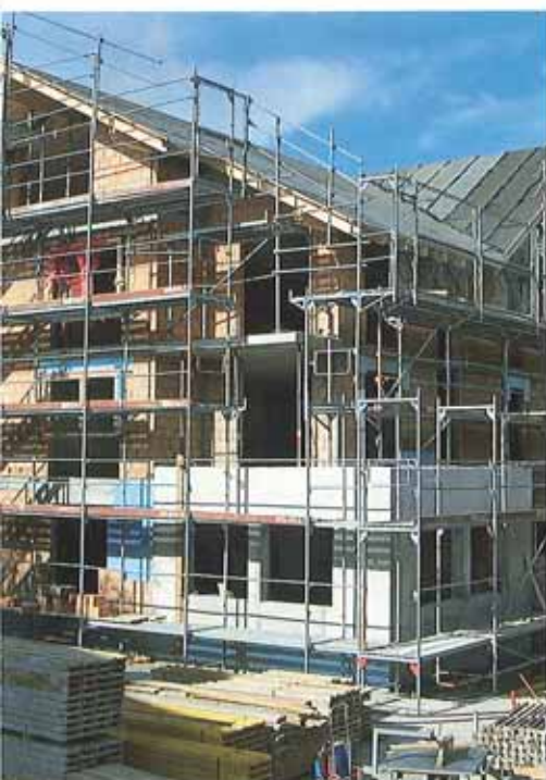
Aufrichten des Daches Posa tetto
