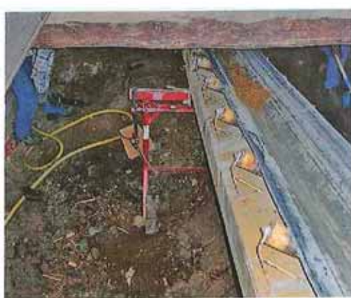
Aushubmaterial aus dem Kellergeschoss wurde mittels Förderband ins Freie transportiert
