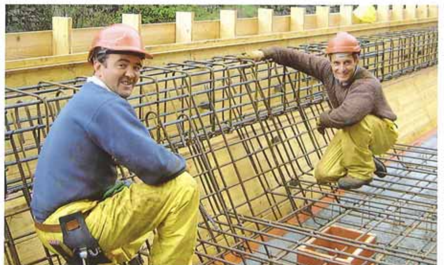
Unter der Leitung von Craperi Saul (rechts) wurde die anspruchsvolle Armierung verlegt
