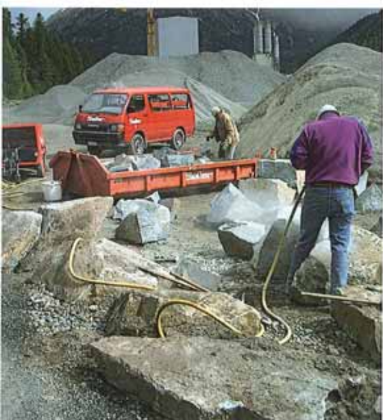
Vorbereitung: grosse Natursteine werden auf dem Julierpass bereits gespalten
