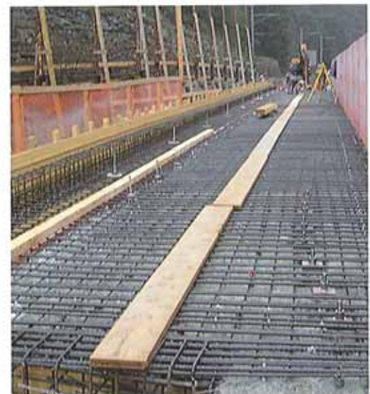
Bereit zum Betonieren des Überbetons
