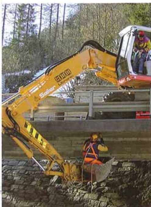
Mittels Pneubagger wurden die Verankerungen für das Lehrgerüst gesetzt, natürlich mit Seilsicherung
