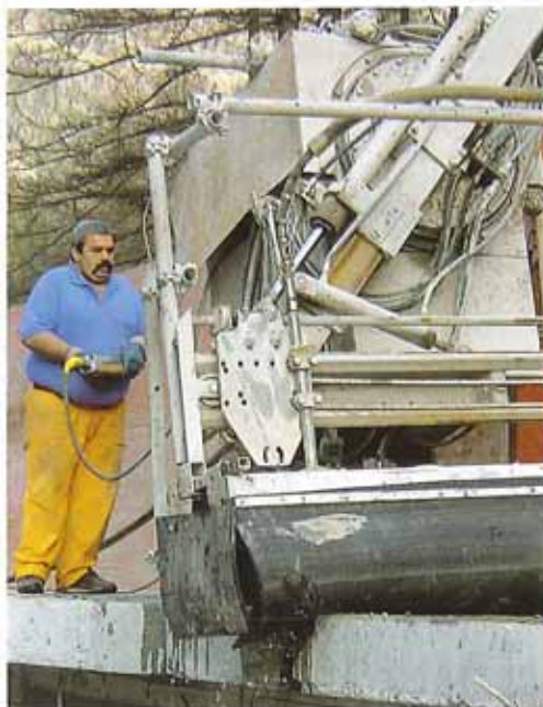
Abtrag des schlechten Betons mittels Wasserhochdruck durch die Firma Reprojekt
