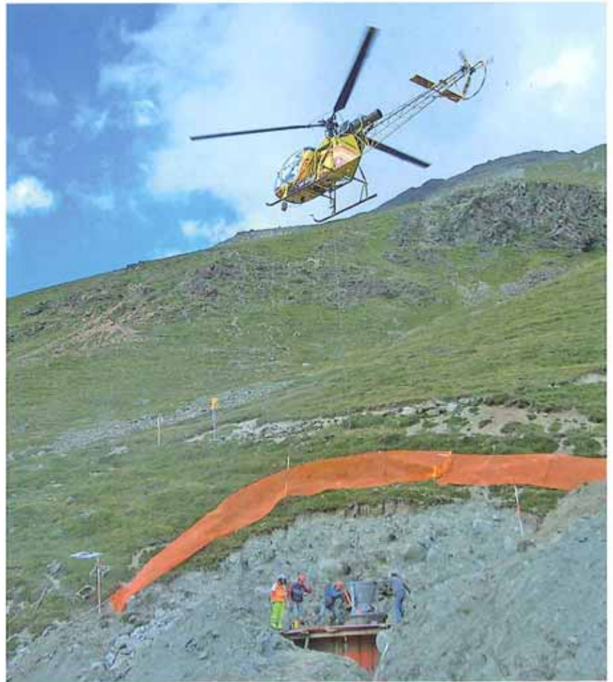
2. Querriegel mit Heli-Bernina betoniert
