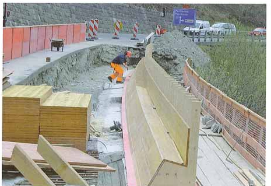
Schalung der Stützmauer und des Kordons vor der effektiven Brücke
