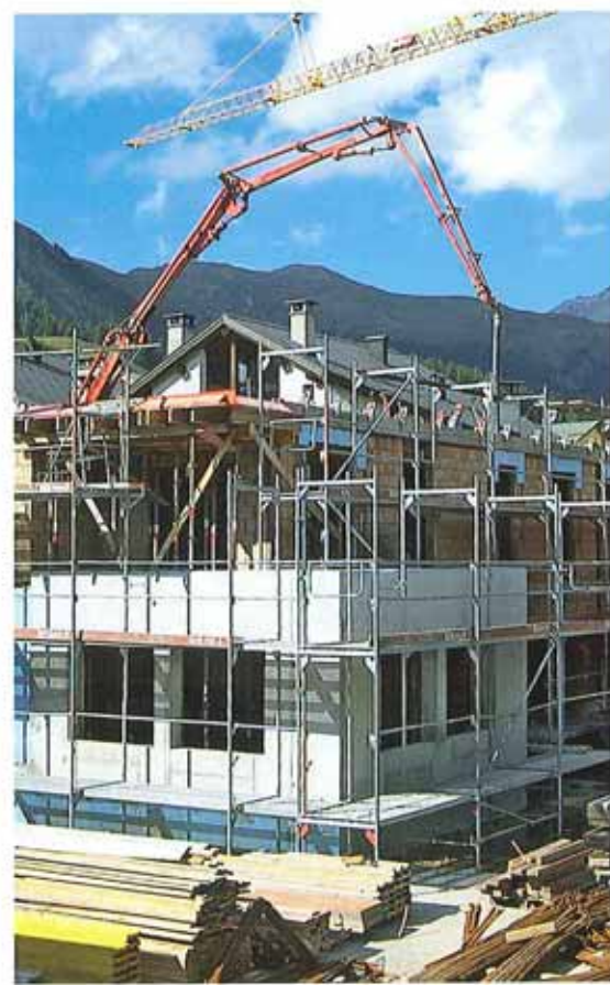
Betonieren Decke 1.0G Getto soletta primo piano
