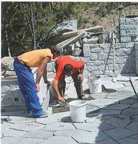
Gebrüder Martinhos beim Ausfugen
