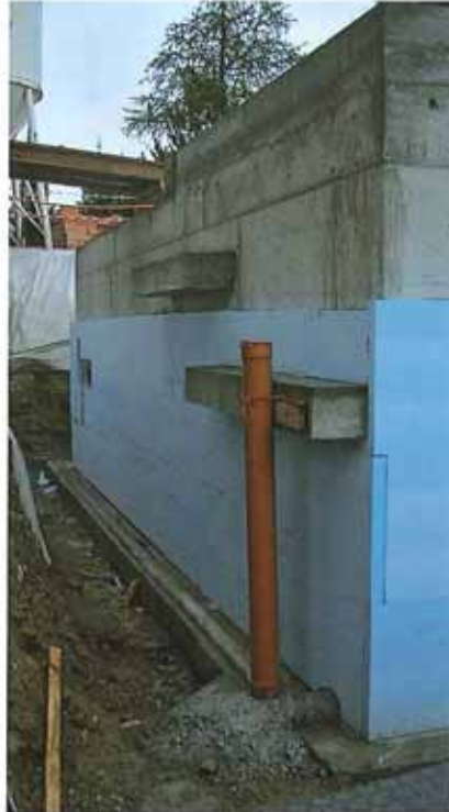
Betonkonsolen: Auflager für Natursteinverkleidung
