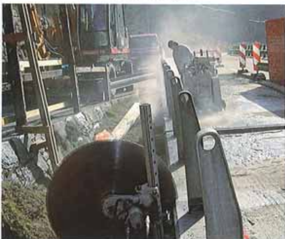
Abtrennen des Kordons durch eine italienische Spezialfirma
