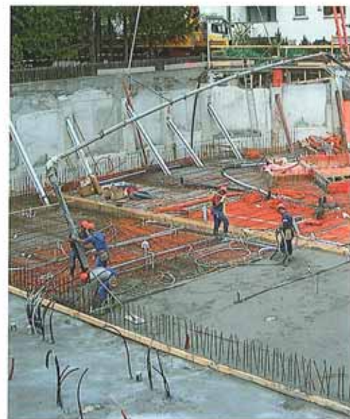
Betonieren in 2 Etappen. Bodenplatte 1. UG und Decke 2. UG. Getto in 2 tappe. Platea primo sottterraneo e soletta secondo sottterraneo
