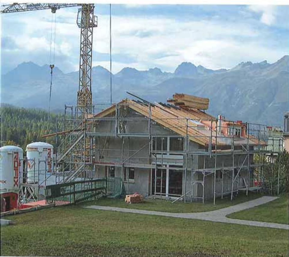
Rohbau vollendet, Dach aufgerichtet, Costruzione grezza, tetto montato
