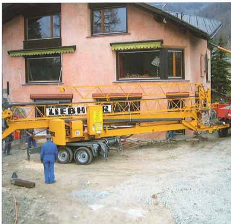
Erstmontage des Liebherr 13 HM bei der Chesa Paparella in Pontresina
