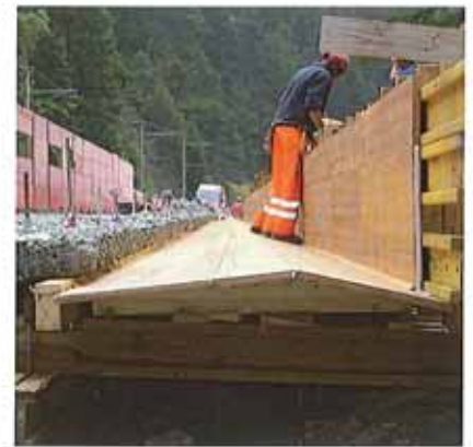
Schalung Verbreiterung und Kordon, vor dem Armieren
