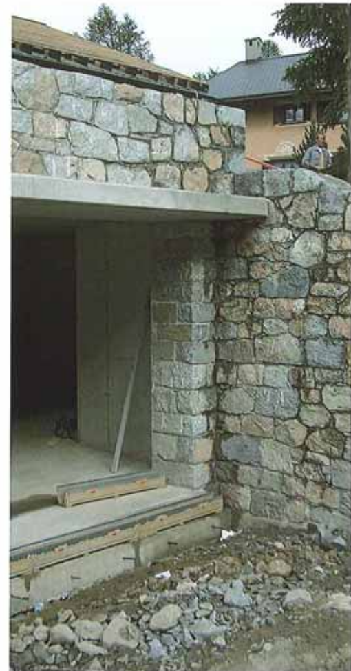
Doppelgarage: fertiges Natursteinmauerwerk
