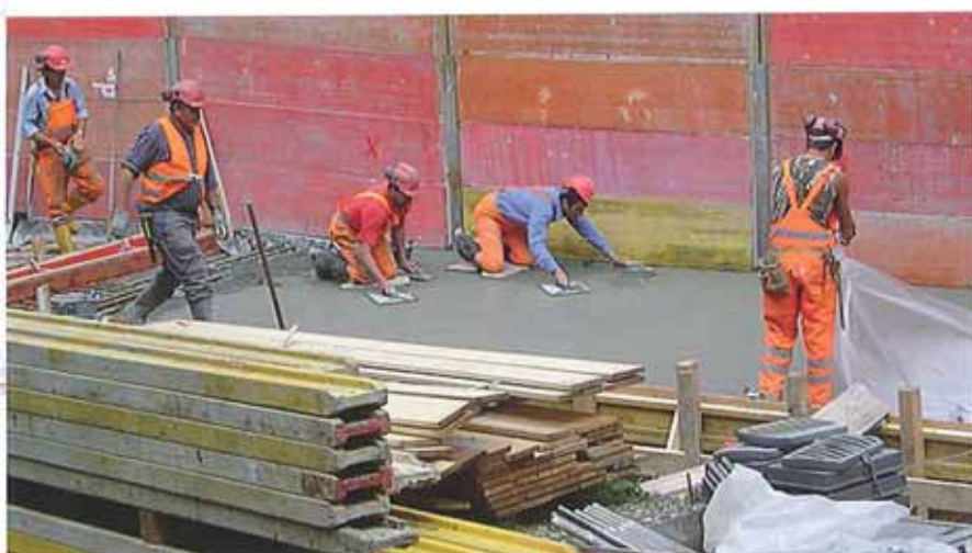
Erstellen des Fahrbahnbetons. Genauigkeit musste im Bereich von +/- 1 cm liegen
