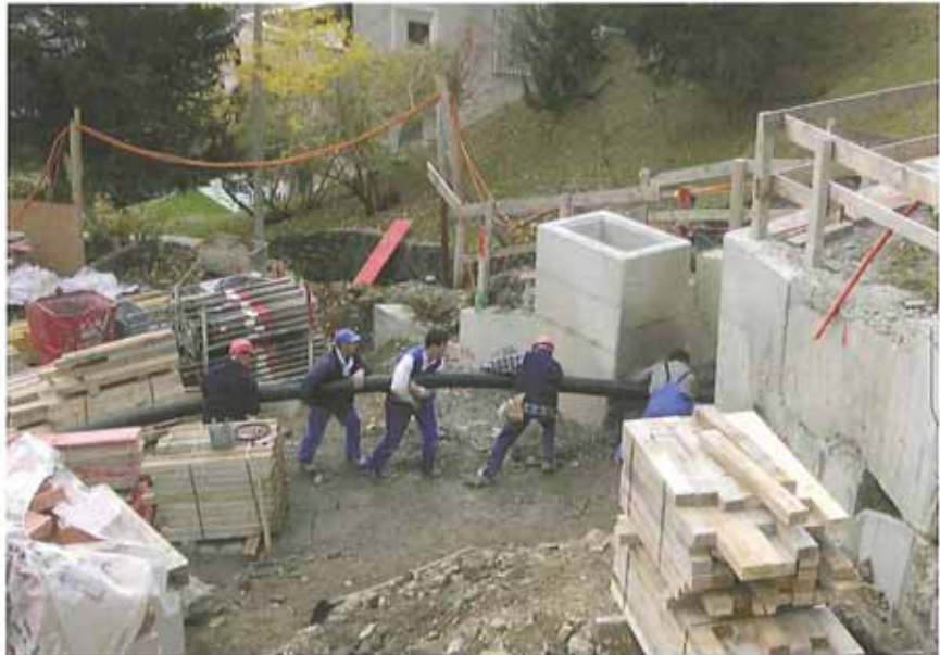
Einziehen der isolierten, flexiblen Wasserleitung in das gerammte Stahlrohr
