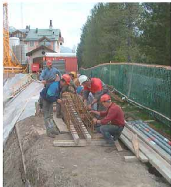
Sage und schreibe 6 Eisenleger sind am Binden eines Pfeilers mit vielleicht 50kg Armierung
