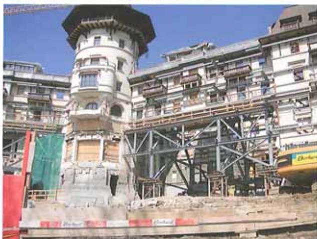
Mit Stahlträgern wird alles zusammengehalten
