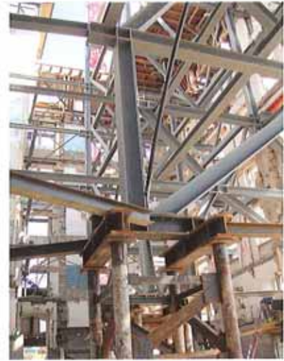
Mikropfähle, auf welchen die ganzen Fassaden abgestützt sind
