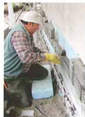
Tomaso Curti verkleidet den Sockelbereich mit Soglio-Quarzitsteinen
