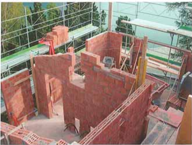
Dachgeschoss, bereit zum Aufrichten
