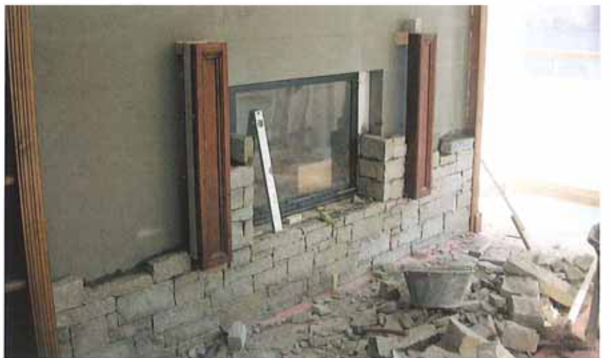
Verkleiden eines Cheminees mit Natursteinen. Speziell war nur, dass die restliche Wohnung bezugsbereit war
