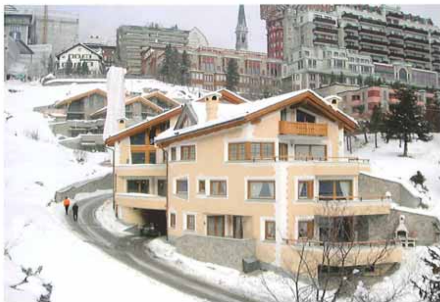
Winteransicht der zum Teil bezogenen Überbauung.
