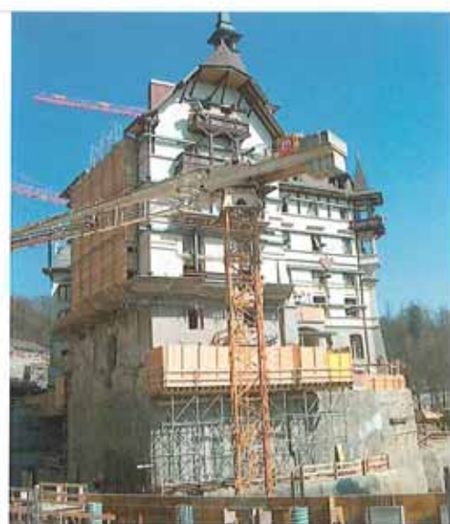
Hotel Dolder zum Teil auf Mikropfählen, zum Teil unterfangen
