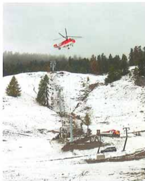
Montage der Masten mittels Kamov der Heli Swiss
