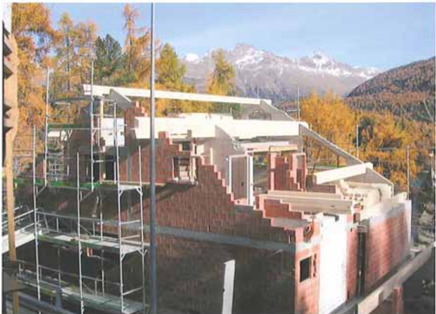
Bei Kaiserwetter wurde schliesslich das Dach montiert
