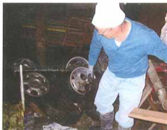
"Chaos total" in den überfluteten Kellern
