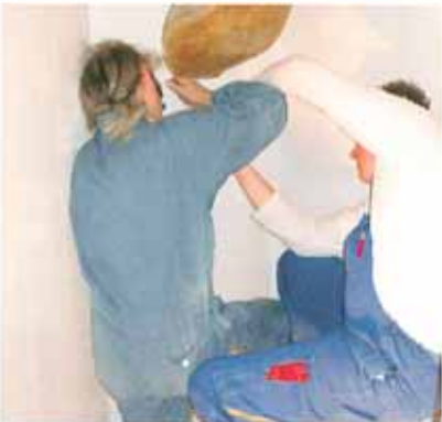
Pandocchi, eines der Originale auf der Baustelle. (Elektriker der Firma „der Elektriker“)
