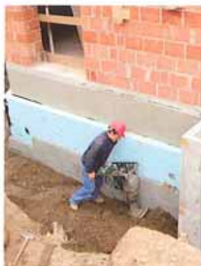
Hinterfüllen des Anbaus
