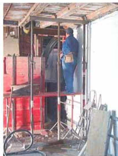
Abfangen der Holzbalkendecke
