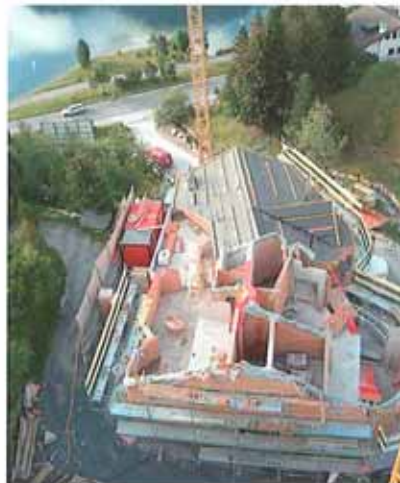
Haus 1 während dem Aufrichten
