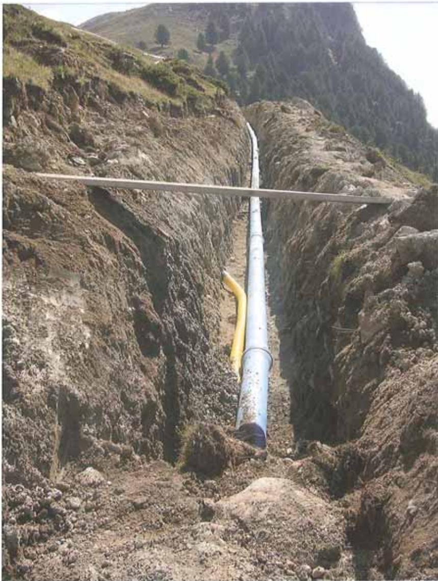
Graben mit den verlegten Leitungen
