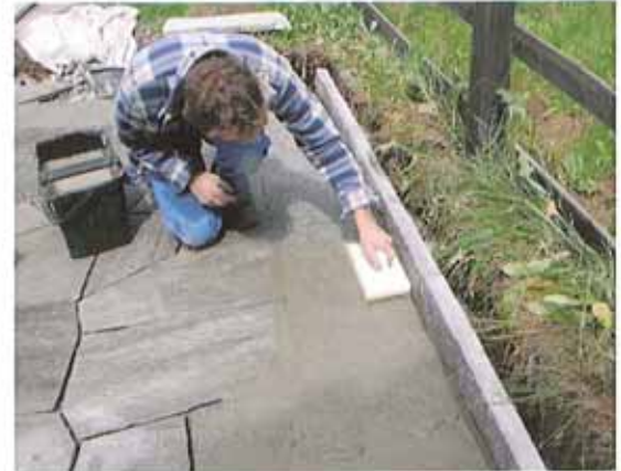
Ausfugen mit Spezialmörtel
