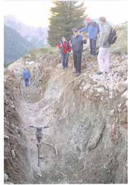
An der wöchentlichen Bausitzung wird unser Graben begutachtet. Hier eine Felspassage. Insgesamt lagen 400m im Fels.
