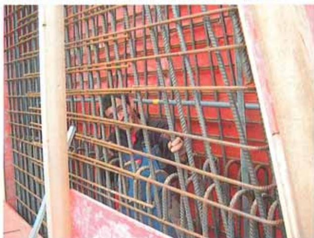
Carlos Oliveira in der Armierung des Stehers der Talstation
