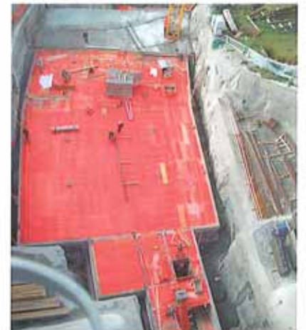
Decke über Garagengeschoß vom Kran aus gesehen
