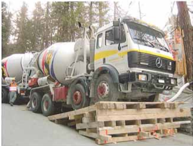
Diese spezielle Rampe entwickelte Ferruccio Mascanti für Betonierarbeiten. Sie wurde jeweils auf die Strasse gestellt, so konnte die Betonpumpe horizontal gestellt werden
