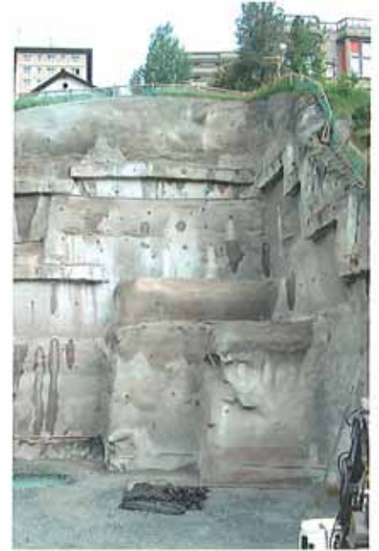
Imposante Baugrubensicherung des hinteren Hauses
