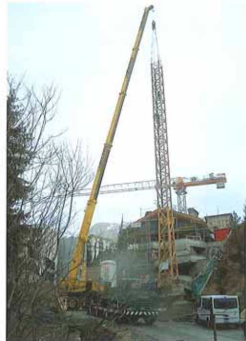
Demontage des Krans im April 2005 nach 20 Jahren ununterbrochenem Einsatz. Im Hintergrund der Kran MDT 120, den wir als Ersatz für den City E 10 gekauft haben
