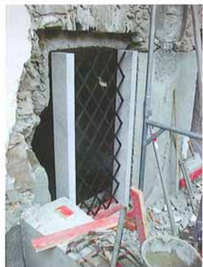
Versetzen der Gewölbe aus Naturstein
