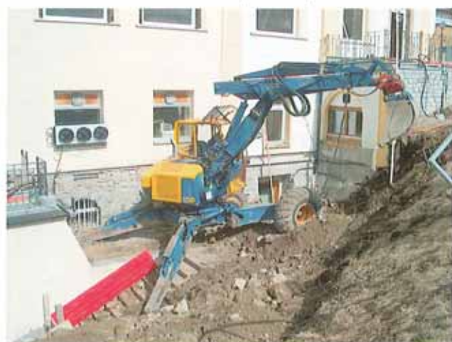
Aushubarbeit für die Terrassenvergrößerung
