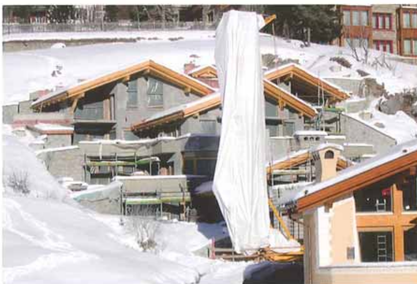
Der hintere Teil der Überbauung mit zusammengelegtem und eingepacktem Kran. In St. Moritz müssen ja alle Kräne im Winter abgebaut werden
