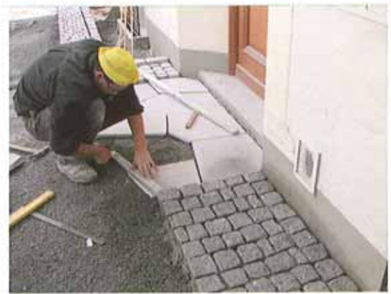
Roberto Salvetti beim Verlegen der ersten Platten
