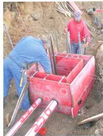
Polier Marino Caspani und Bauarbeiter Norberto da Cuhna beim Schalen eines Zugschachtes
