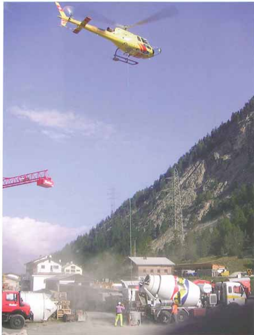
Betontransport mit der Heli Bernina ab Werkhof Seiler
