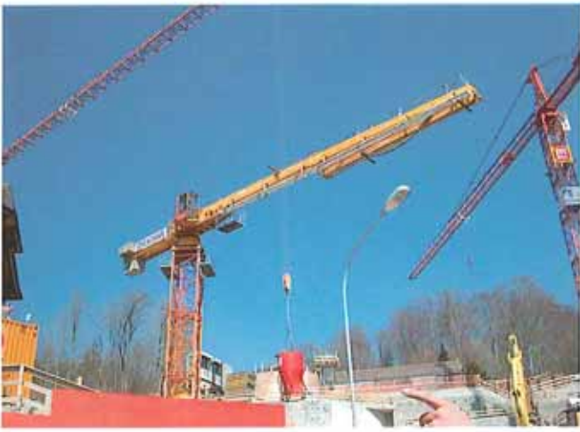
Betonpumpenkran mit 45m1 Ausladung
