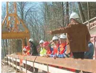
Bauherrenvertreter Urs Simeon vom Büro Fanzun erklärt die Baustelle
