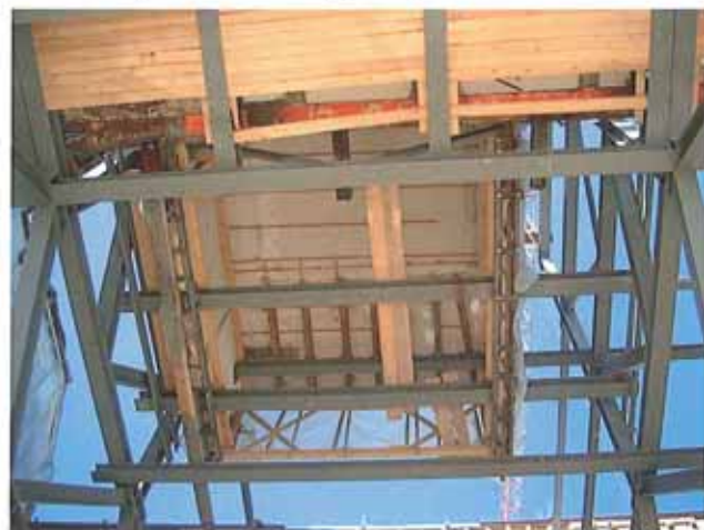
Aufnahme von unten: eines der sechs Zimmer, welches völlig in der Luft hängt und mit Stahlträgern abgefangen ist
