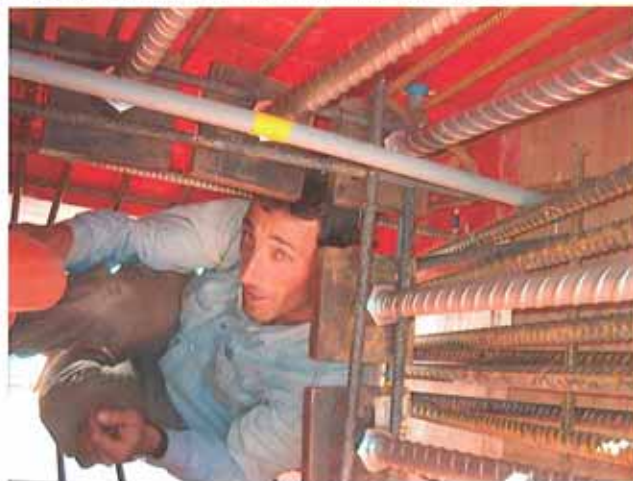
Polier Dario Giudici beim Montieren der Schablone
