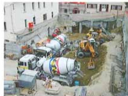
Engste Platzverhältnisse. Die Fahrmascher liefern den Gunit
