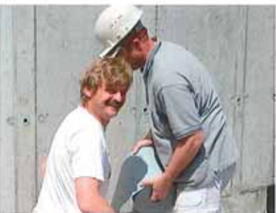
Sämtliche Abdichtungen erstellte Marcel Winkler, auch er ein „spezieller Vogel“
