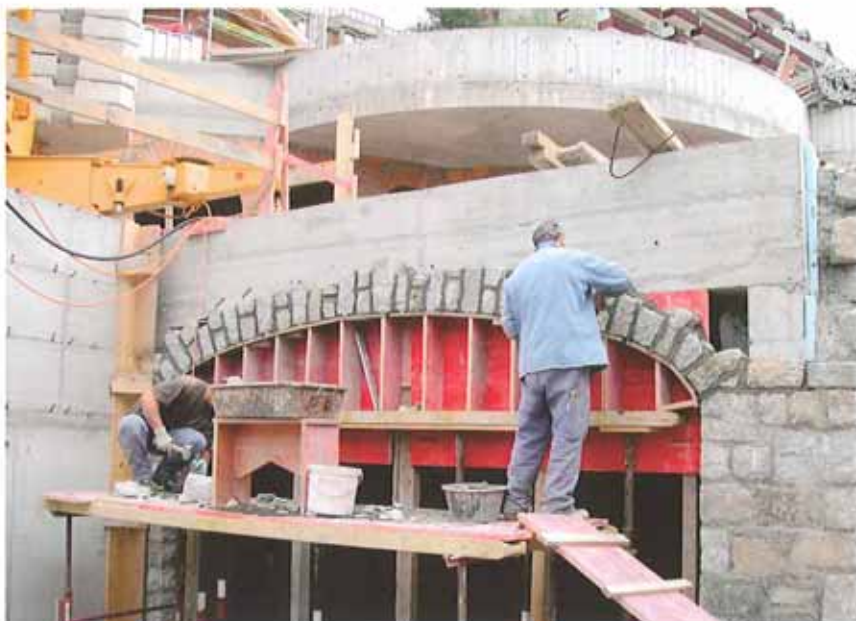
Davide Angelini erstellt die geschwungene Garageneinfahrt. Eines der optischen Herzstücke dieser Überbauung
