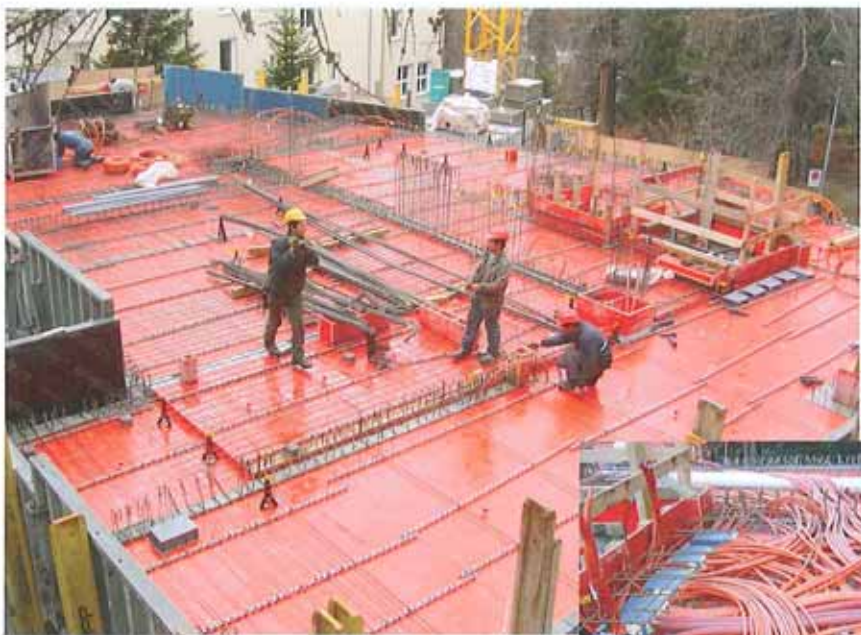
Decke über Erdgeschoss. Jetzt fehlt nur noch der Beton
