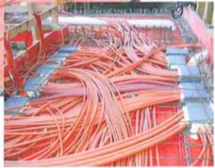
Decke über Erdgeschoss. Jetzt fehlt nur noch der Beton
