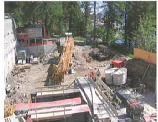
Der Kran musste nach 2 Monaten umgestellt werden
