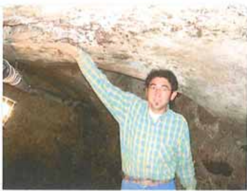
In diesem Keller stand das Wasser bis zur Decke. Vorarbeiter Manuel Paiva, der die Arbeiten leitete, zeigt den Stand des Hochwassers an
