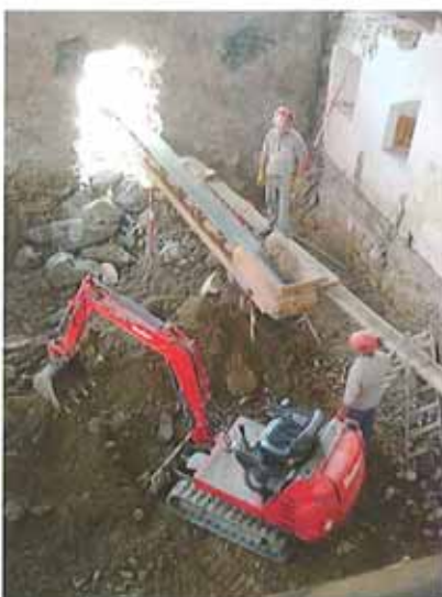
Absenken des Gebäudebodens (ca. 1.5 m)
