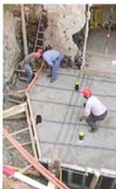
Beim Isolieren der Bodenplatte
