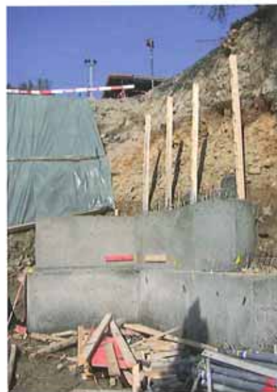
Fertige Baugrubensicherung
