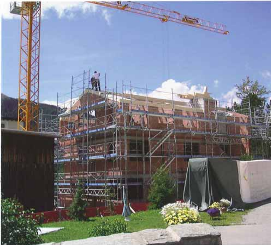
Aufrichten des Daches
