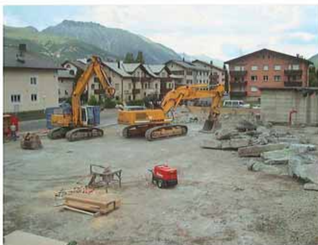
Abbruch der Bodenplatte und gleichzeitiges Herauslesen der Isolation
