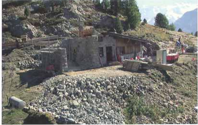
Gebäude bereit zum Aufrichten des Daches
