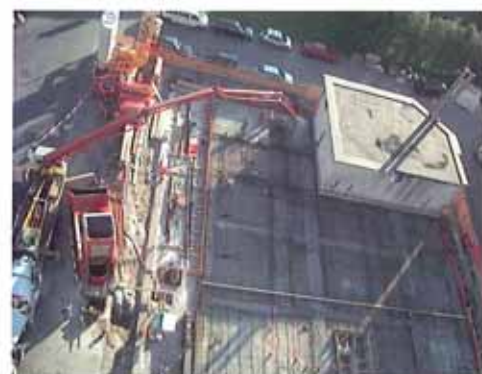
Betonieren der Bodenplatte aus der Sicht des Kranführers
