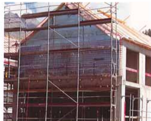
Die einhäuptige Sicht-Fassade verlangte einiges an Können
