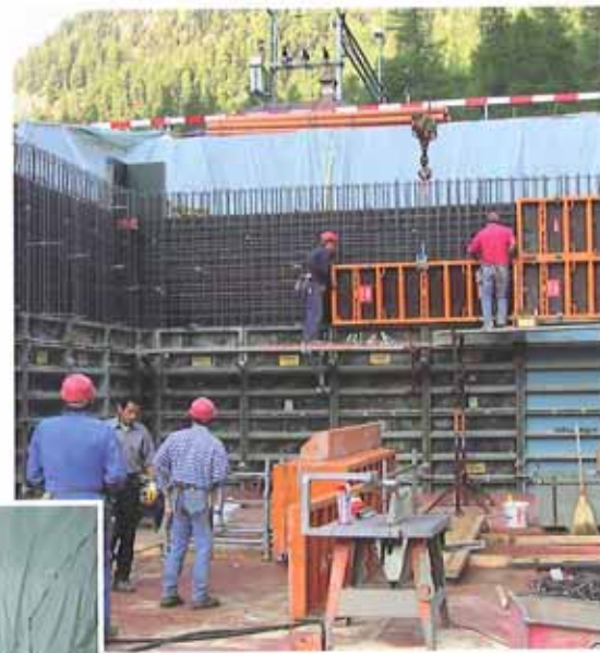
Wände 1. Etappe geschalt
