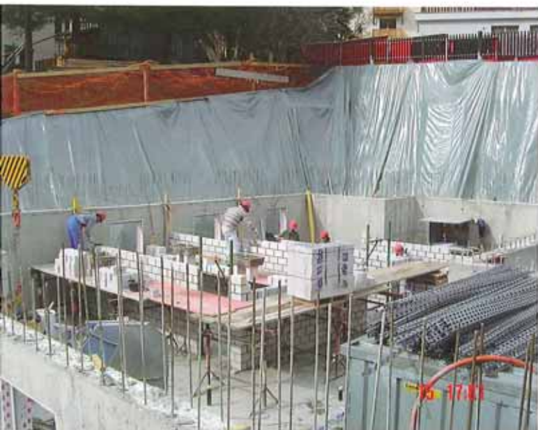
Erstellen der Kalksandsteinmauern im Untergeschoss
