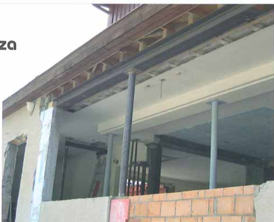
Die neue grosszügige Fassadenöffnung im Empfangsbereich
