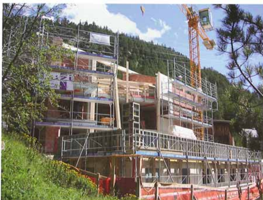
Erstellen der Kalksandsteinmauern im Untergeschoss
