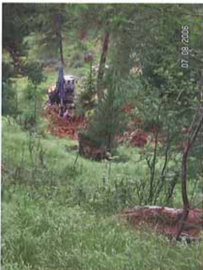
Grabarbeiten in unwegsamem Gelände
