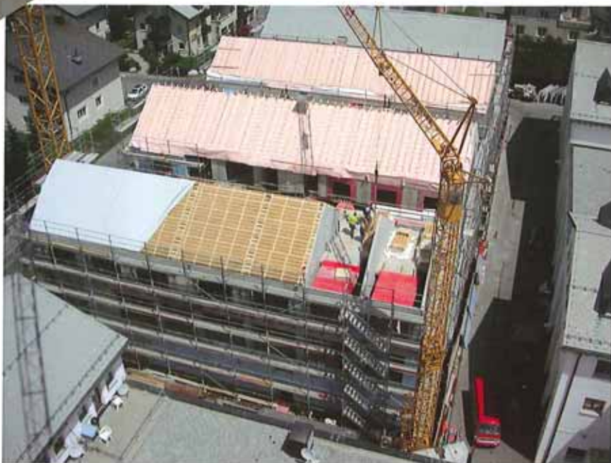
Es fehlen noch 4 Dachelemente bis zur kompletten Dachaufrihtung
