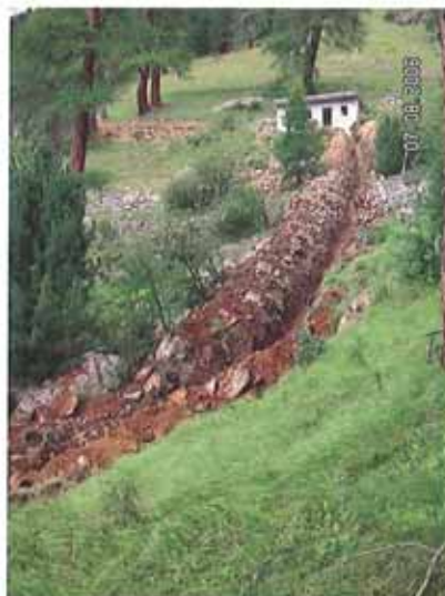
Grabarbeiten für Stromzuleitung
