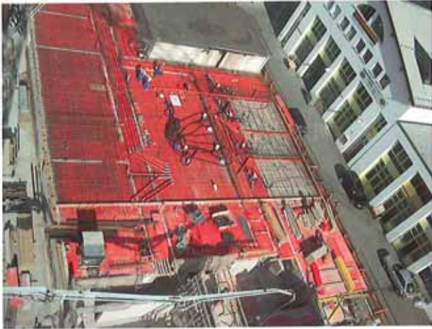
Decke über Erdgeschoss. Sämtliche Betonierarbeiten wurden mit der Betonpumpe ausgeführt
