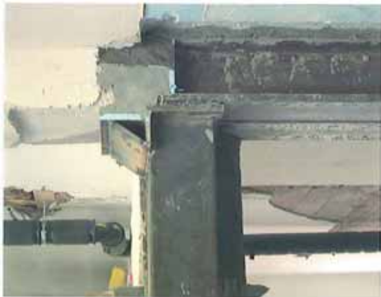
Abfangen von Lasten mittels Stahlträgern
