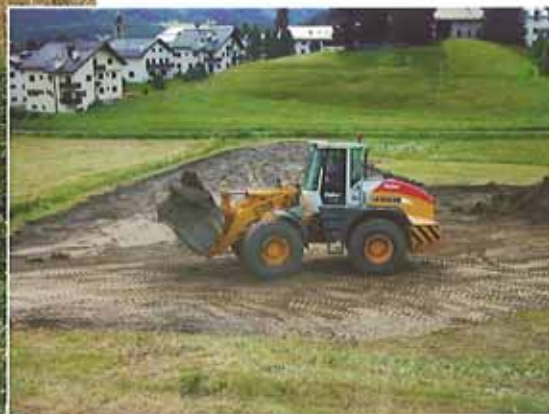
Das grosse, gelbe Ungetüm der Firma Seiler, welches den Humus wegschiebt
