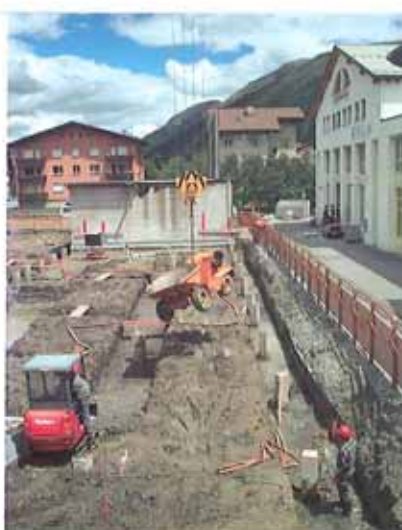
Die freigelegten Pfähle wurden mit Riegel untereinander verbunden
