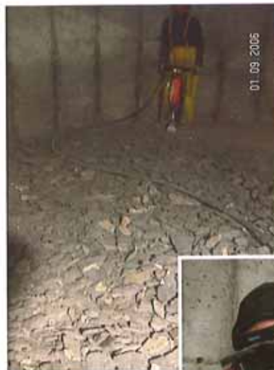
Zementüberzug am Reservoirboden weggespitzt
