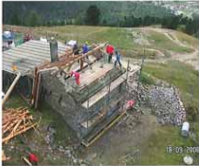
Abbrucharbeiten am alten Gebäude
