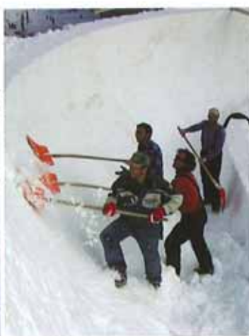
Anhand der oberen Absteckung wird die Kurve ausgekratzt
