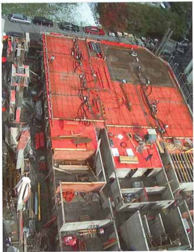
Decke über 1. Obergeschoss. Betonieren in Etappen
