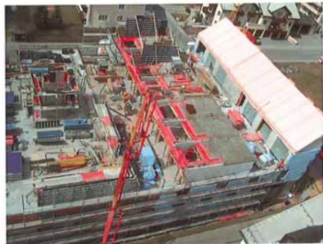
Gut zu sehen die Arbeitsschritte. Beim Trakt 1 ist das Dach bereits aufgerichtet, im Trakt 2 beginnt man die Giebelwände zu schalen, im Trakt 3 ist man noch einen Stock tiefer an den Aussenwänden
