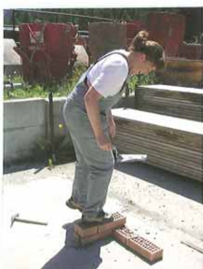
Corina Grass erstellte Lagerfugen von 2 mm
