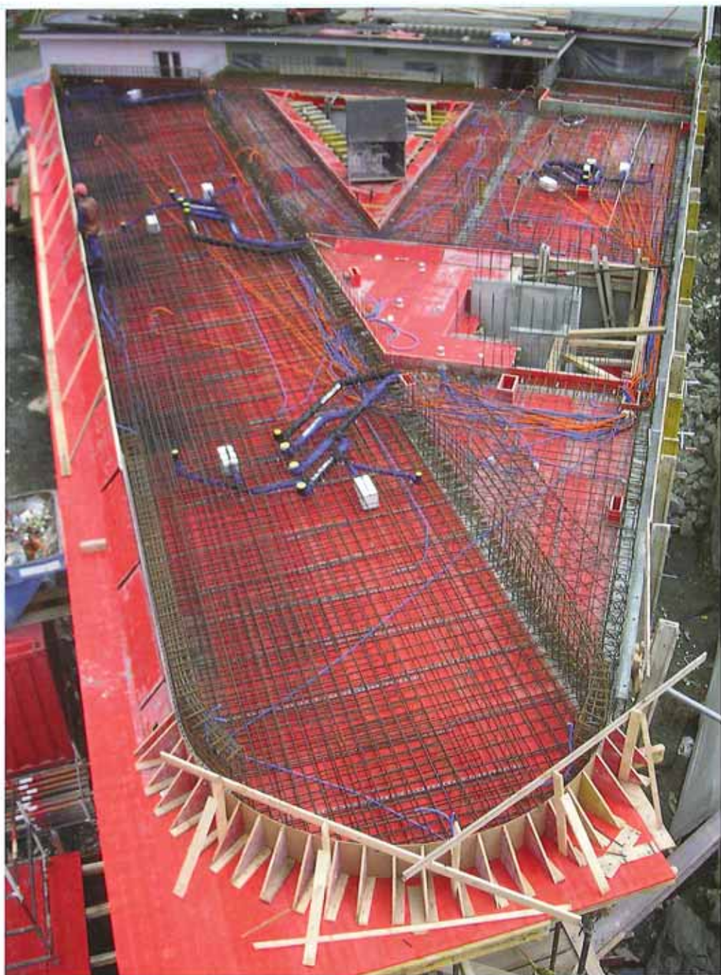
Kurz vor dem Betonieren der Decke über dem Sockelgeschoss
