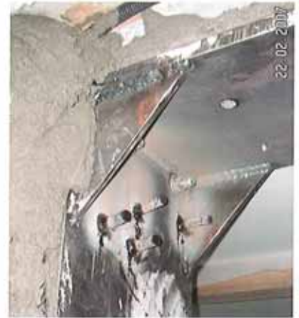
Neu eingezogener Stahlträger
