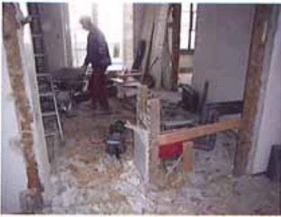
Zuerst wurden im Innern Teile der Wände herausgebrochen
