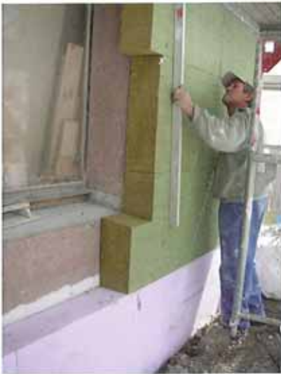
Aussenisolation im Spritzbereich, Jackodur KF 300 und MW-Dämmplatten Flumroc Firestop
