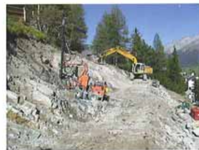
Aushub, Fels bohren und sprengen
