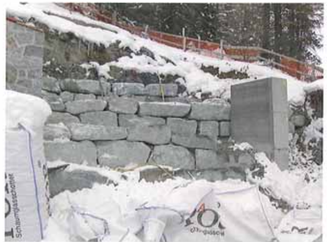
Hinterfüllungsarbeiten Blockwürfe
