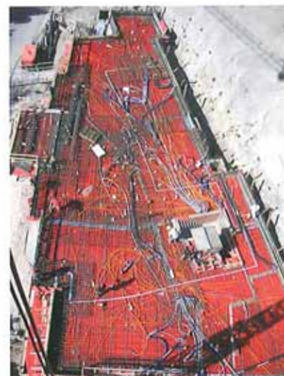
Deckenschalung über Erdgeschoss
