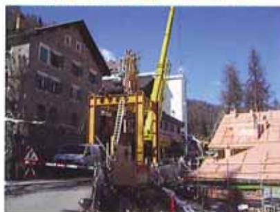
Komplizierte Kranmontage auf Portal
