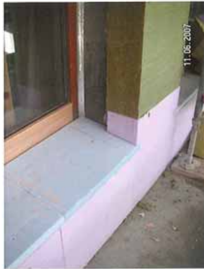
Brüstung fertig isoliert
