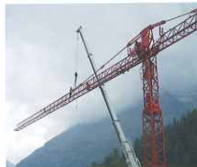
Der Ausleger wird am König befestigt, Luftiger Arbeitsplatz für den Kranmonteur
