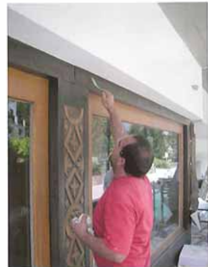
Finnish-Arbeiten (Fertigputz)
