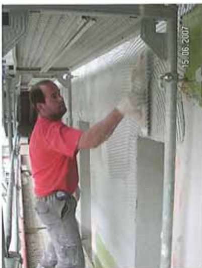
Kunststoffgewebe aufziehen
