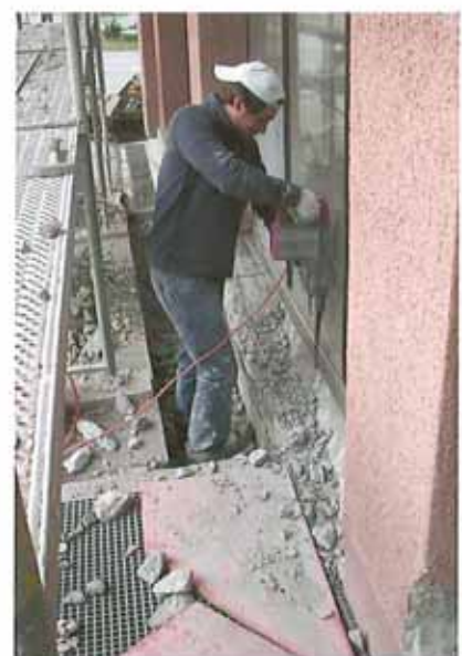
Beton-Fensterbänke wegspitzen
