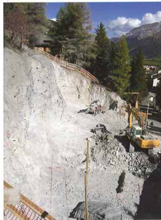
Aushub, Felsausbruch aufladen und abführen
