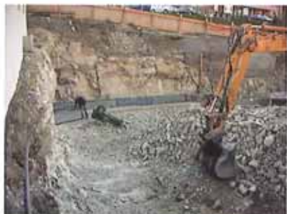
Nach mehreren Sprengungen ist die definitive Tiefe erreicht
