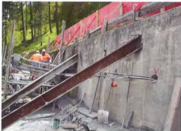
die bestehende Stützmauer musste abgespriesst werden
