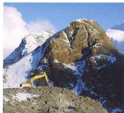
Unser Liebherr beim Abtragen des Vorpfels des Piz Trouvats...
