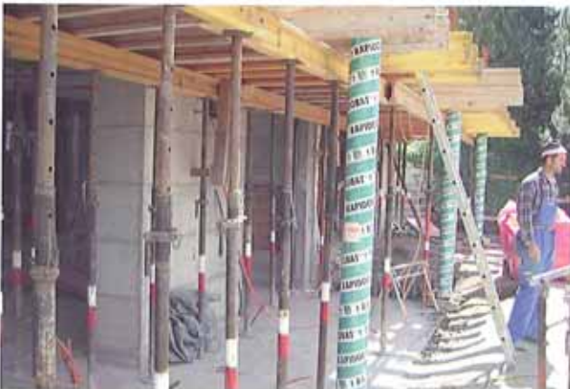
Aufbau der neuen Balkonplatten
