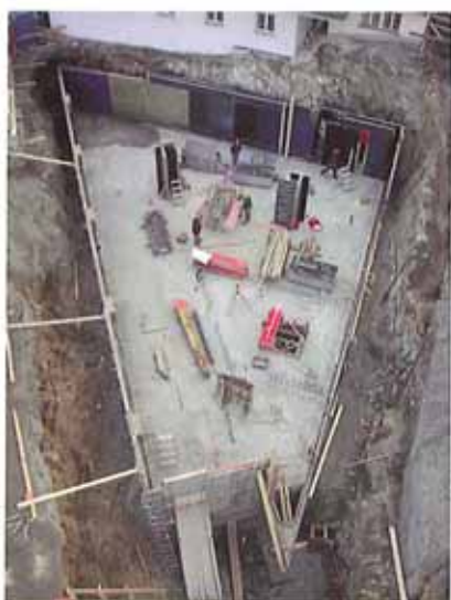
Erstellen der Aussenwände im Untergeschoss
