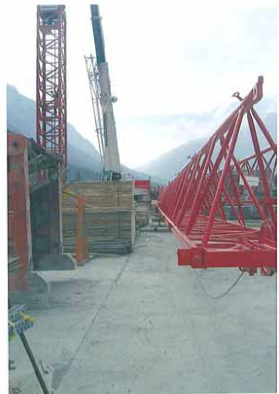
50 Meter Ausleger kurz vor der Montage
