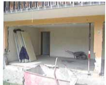
Ausbrucharbeiten im Erdgeschoss
