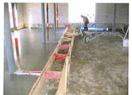
Bodenplatte aus selbstverdichtendem Stahlfaserbeton
