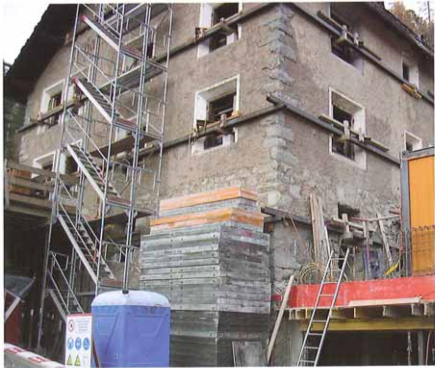
Aussteifungen Fassaden bestehendes Gebäude
