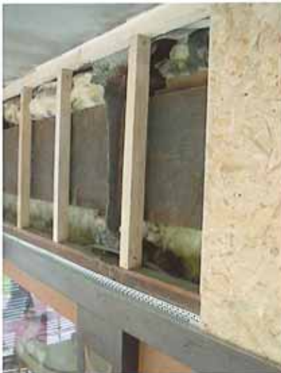
Stahlträger verkleiden
