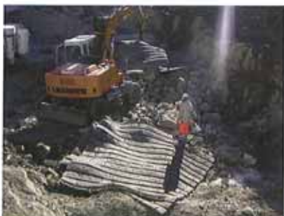
Der Aushub musste neben dem bestehenden Hotel herausgesprengt werden
