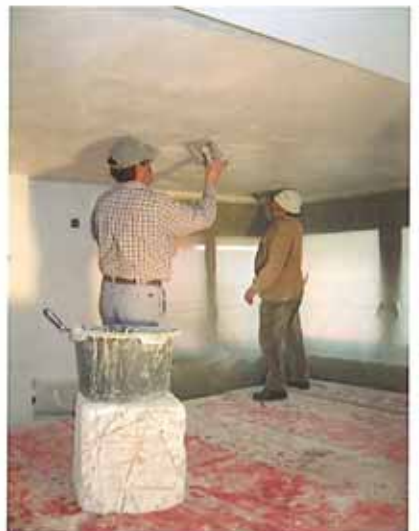
Man staune!! Polier Armin Lazzarini und Tomaso Curti beim Glattstrich
