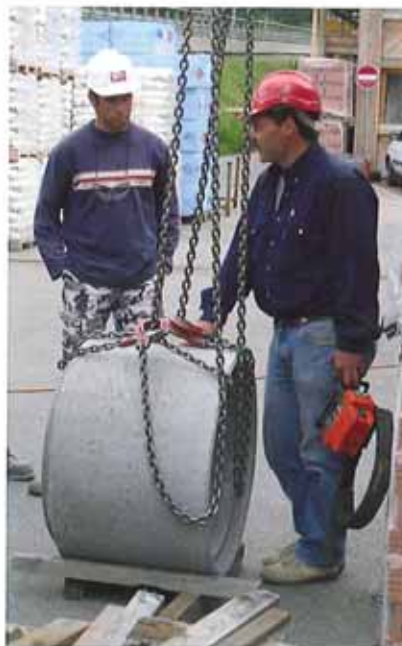
Unser Polier Ferruccio Macsenti vermittelt an seinem Posten die Kenntnisse über das Anschlagen von Lasten an den Kran
