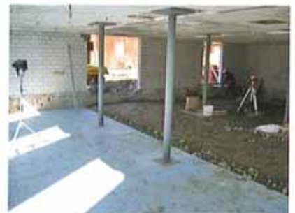
Aufbau der neuen Bodenplatte Dämmung auf Sandbett
