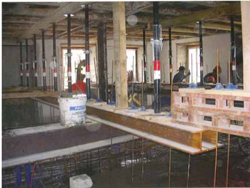
Betonierarbeiten Decke Chesa Veglia
