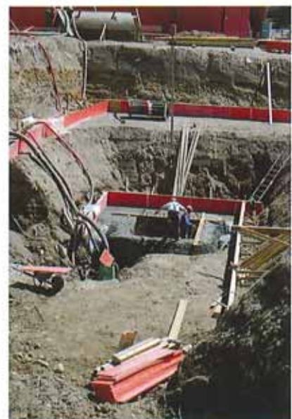
Liftunterfahrt des Hauses E
