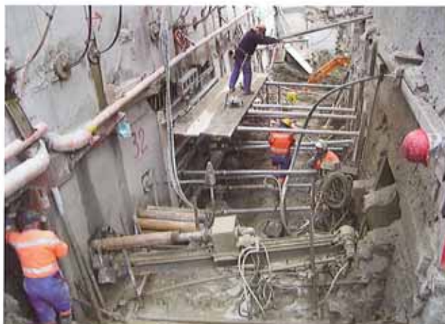
Baugrubensicherung Ankerwand
