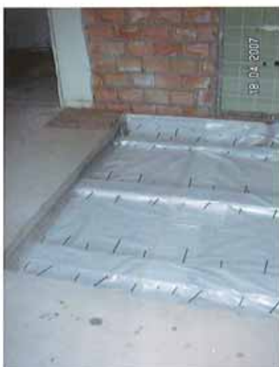
Bodenvorbereitung für Unterlagsboden
