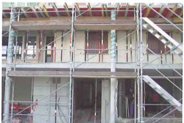
Der Rohbau steht
