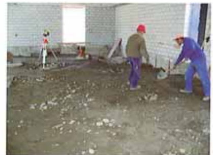
Planum unter der Dämmung bei der Bodenplatte
