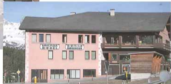
Ostfassade vor der Sanierung
