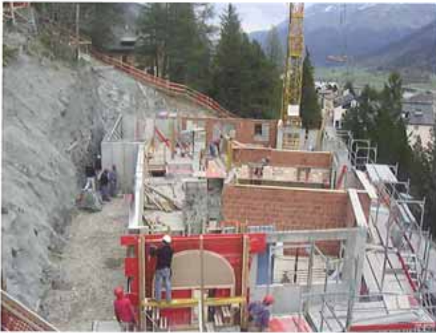
Mauerwerk im 1. Obergeschoss
