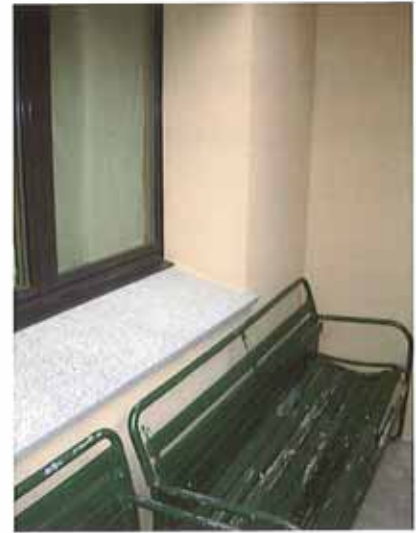
Fertig verputzt mit Fensterbank
