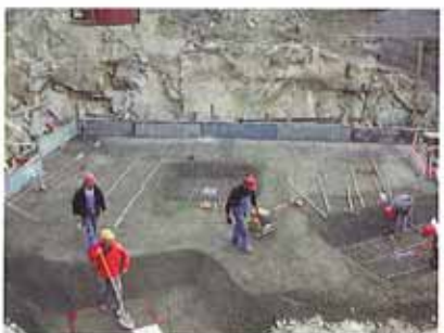
Einbringen von Magerbeton und Füllbeton
