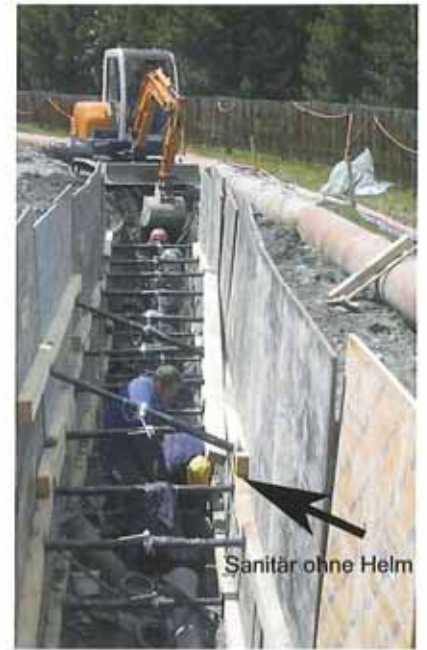
Erstellen der Ringleitung unter erschwerten Bedingungen
