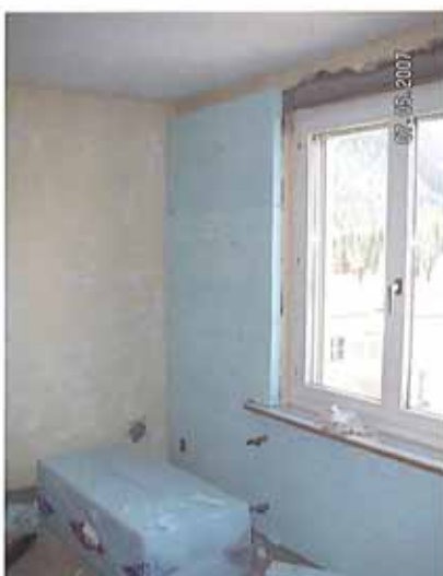
Aussenwände isoliert
