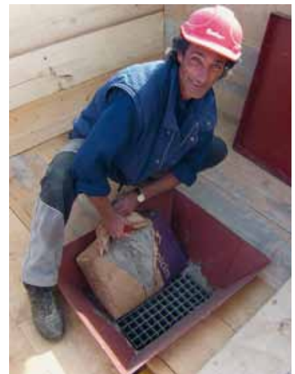
In diesen Schlitz wurden insgesamt 22'368 Säcke Zement eingefüllt. Im Bild der Chefpolier Dario Giudici beim Probe-Einfüllen.
