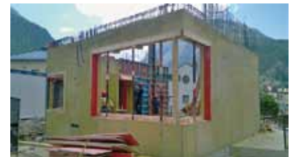
Der Kassaraum frisch ausgeschalt. Ausführung mit eingefärbtem Beton
