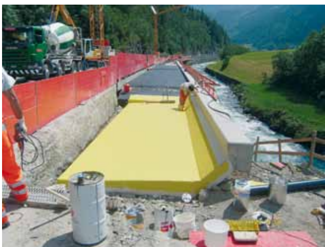
Nach uns kam die Firma Sika AG, sie dichtete den Beton mit Folie ab.
