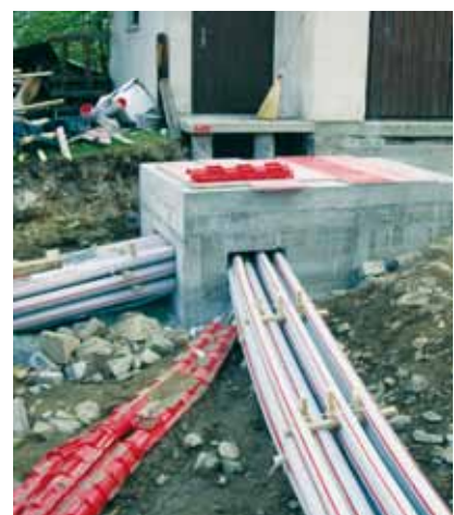
Zuoberst wurden noch die Strom- und Telefonleitungen verlegt
