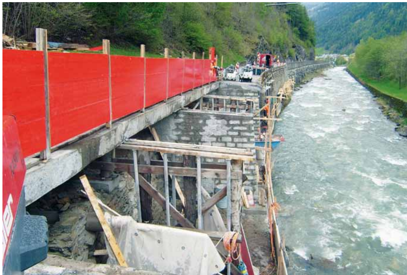
Situation nach dem Abheben der Betonplatten
