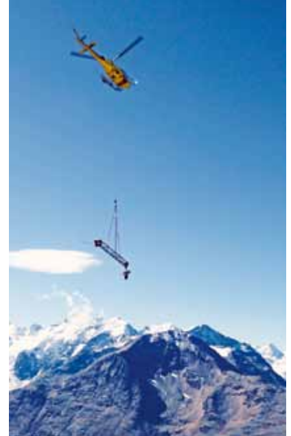
Mit der Heli Bernina wurde jeweils der Baustellenkran von Lawinerverbauung zu Lawinerverbauung umgesetzt
