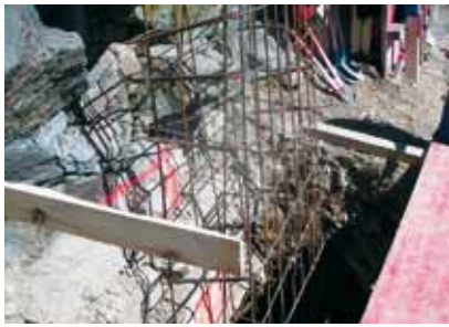
Wo es nicht anders ging, wurde zur Verstärkung vorbetoniert
