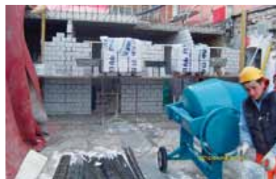
Es wurde nicht nur Beton verbaut
