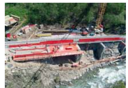
Zwischen den Brückenauflagern wurde die neue Brücke geschalt
