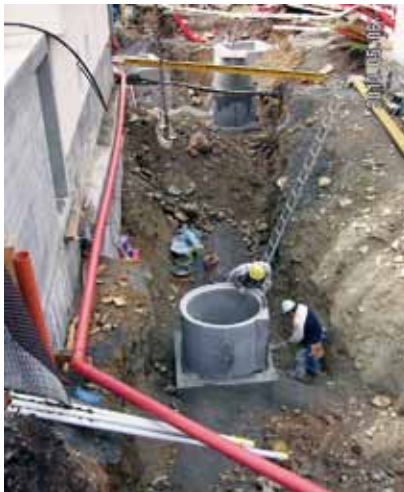
Unglaublich was alles an Leitungen im Boden versenkt wurde
