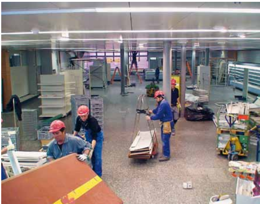
Decken und Wandverkleidungen wurden entfernt
