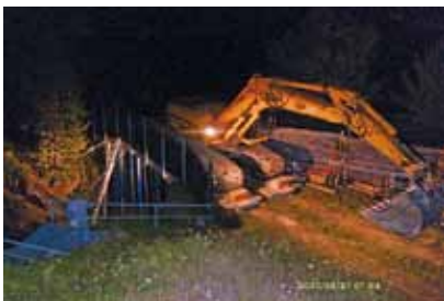
Mit Spezialstützen wurde die Schlittelbrücke abgestützt, so dass der 25 t Bagger die Brücke queren konnte
