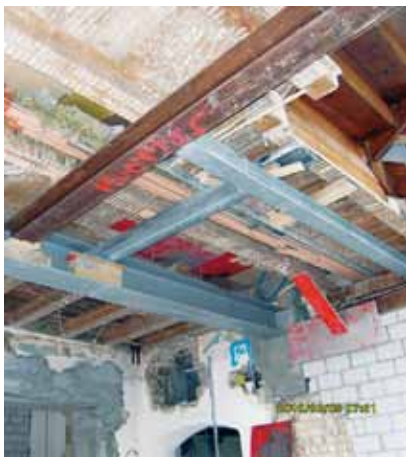
Mit Stahlträgern wurde die Holzkonstruktion abgefangen
