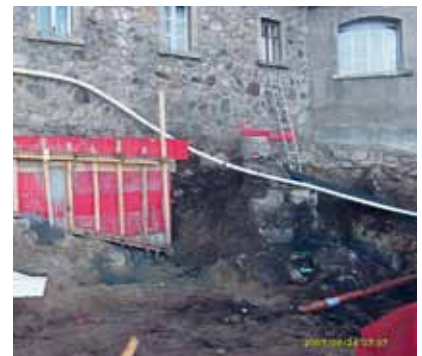
Das bestehende Hotel wurde zum Teil unterfangen
