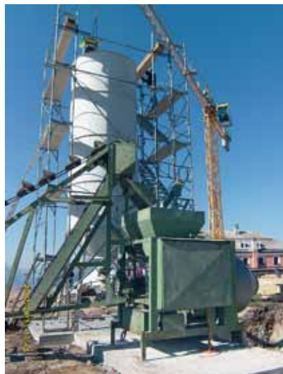
Unsere Betonanlage, bevor wir sie Frostbeständig einpackten
