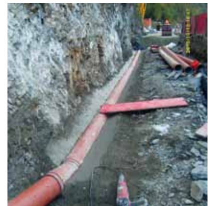
Nachdem die talseitige Fahrbahn wieder hergestellt war, wiederholten sich die Arbeiten bergseitig, hier wurde auch noch eine Sickerleitung eingelegt.
