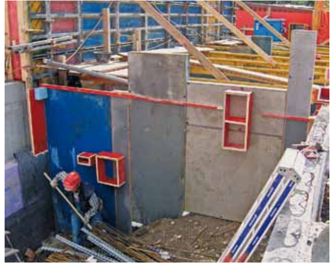
Streifenfundamente unter der Bodenplatte
