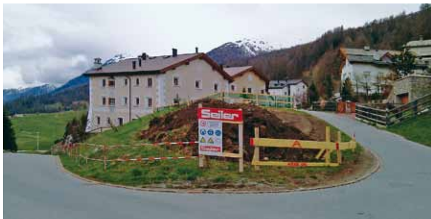
Eine Baustelle entsteht
