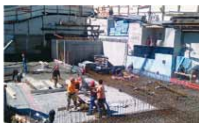
Endlich konnte das Eisen für die Bodenplatte verlegt werden
