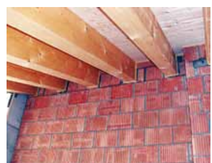
Innenwände fertig aufgemauert
