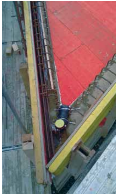
Mehrheitlich kamen nur neue Framaxelemente zum Einsatz
