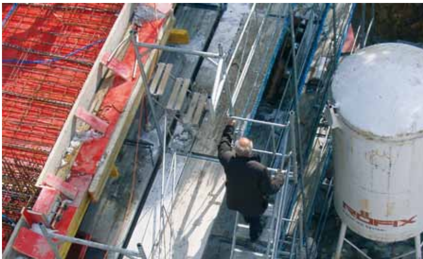
Nuot Saratz verfolgte sehr oft die Bauarbeiten
