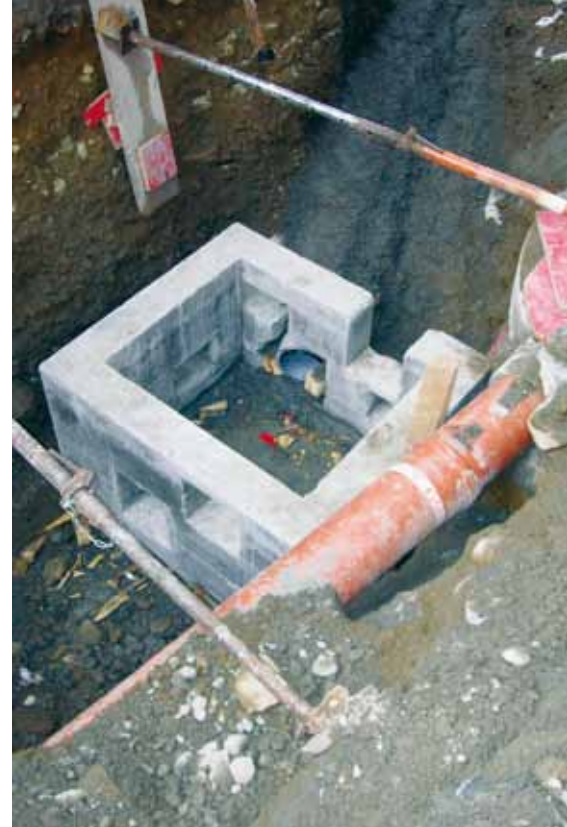
Verschiedene Ortsbetonschächte wurden erstellt
