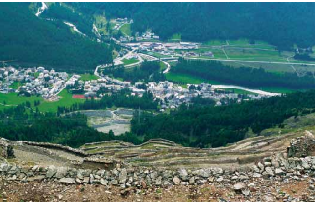
Gut ersichtlich, warum es ob Pontresina Lawinerverbauungen benötigt, in der Mitte der vor kurzem erstellte Auffangdamm
