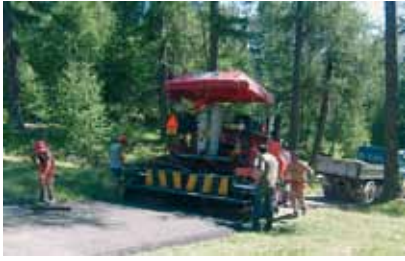
Mit einer Einbaumaschine wurde Belagsrecycling auf dem Weg zum Umschlagplatz eingebaut
