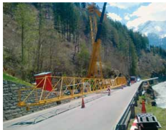
Als erstes stellten wir 2 Kräne, ein Selbstaufsteller mit 35m Ausleger und ein Oberdreher mit 50m Ausleger
