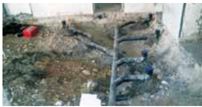
Neue Leitungen wurden verlegt
