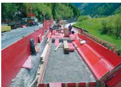
Auskragung mit Kordon geschalt, aber noch nicht armiert
