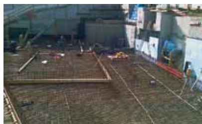
Kurz vor dem Betonieren
