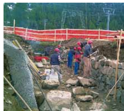
Der bestehende Clüxcanal wurde zum Teil abgebrochen und mit einer neuen Linienführung wieder erstellt
