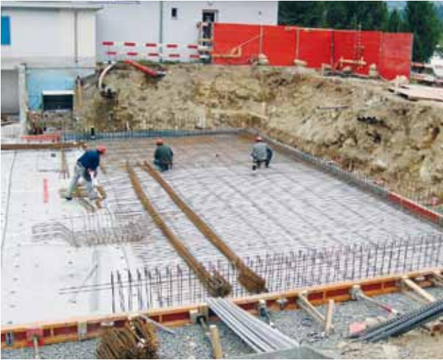
Bewehrung Bodenplatte
