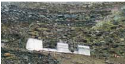
Fertige Abstützung, der bis zum Teil 4 Meter hohen Bruchsteinmauern
