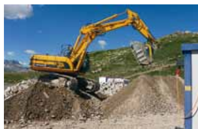
Der Abbruch wurde mit dem "Brecher" vor Ort aufbereitet
