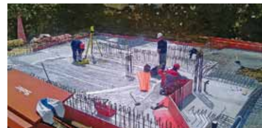
Nachbehandlung der frisch betonierten Bodenplatte
