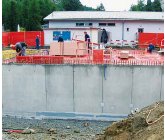
Deckenschalung über Untergeschoss
