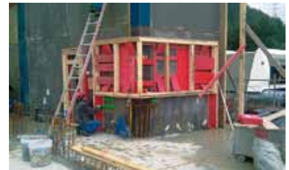
Die Fensterausparung musste speziell stark ausgesteift werden
