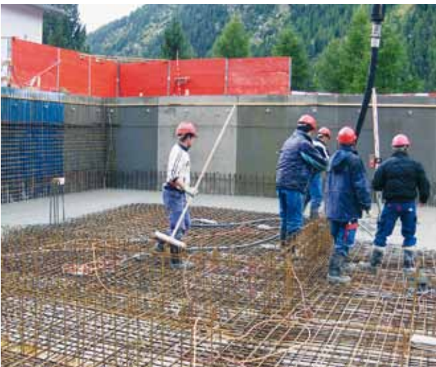
Betonieren der Bodenplatte
