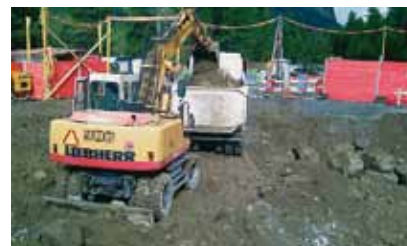
Baugrubenaushub
