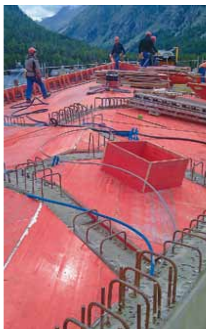
Deckenschalung im Gefälle
