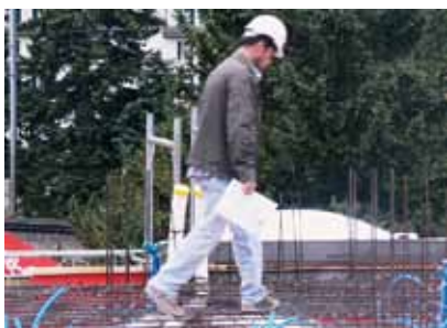
Bauleiter Mario Meng bei seiner täglichen Kontrolle
