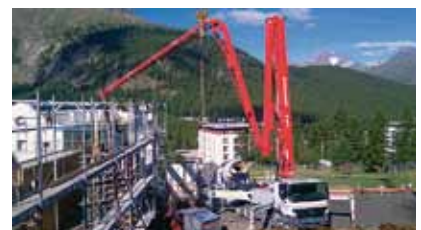
Der eingefärbte Beton wurde als selbstverdichtender Beton angeliefert und eingebracht
