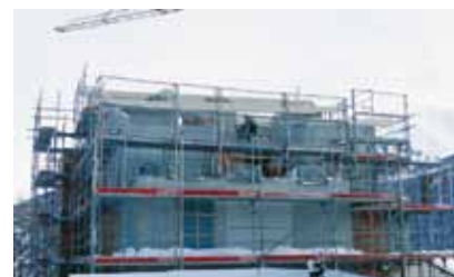
Am 30. November 2010 konnte man das Dach aufrichten
