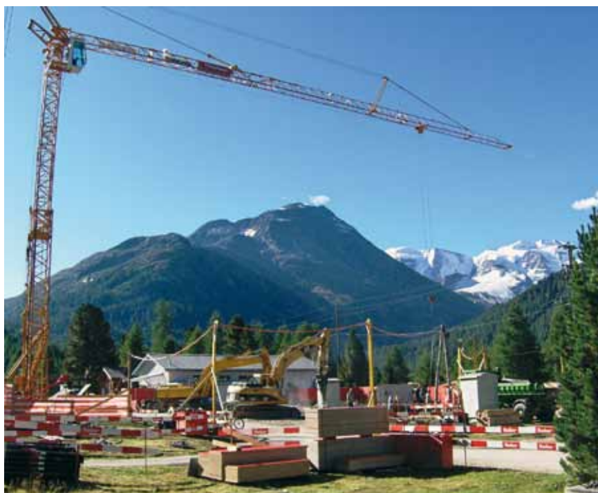
Rückbau altes Gebäude
