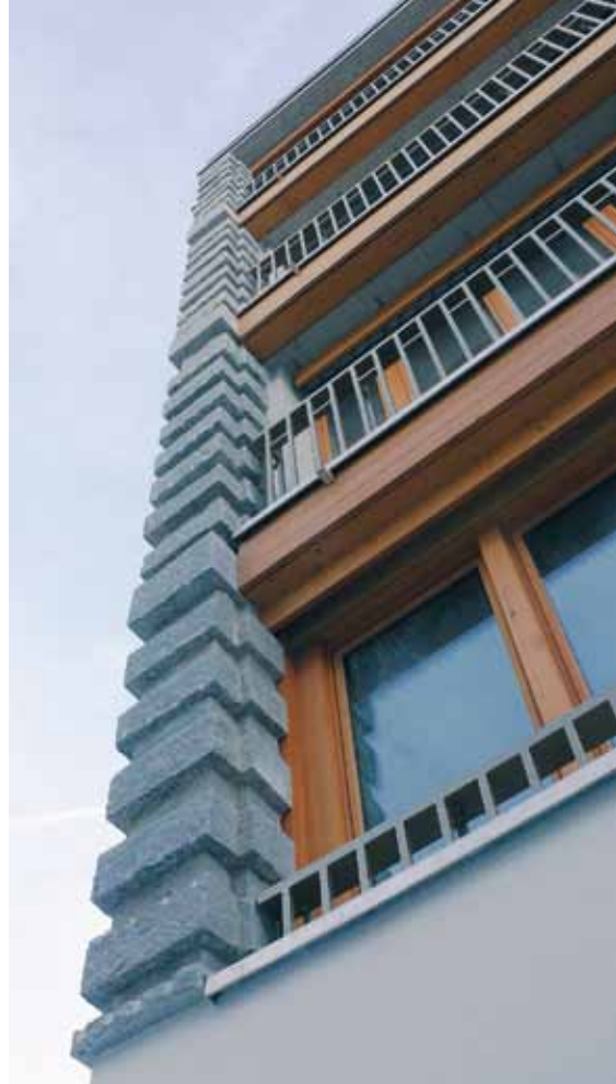
Eckpfeiler über 4 Stockwerke, knapp 12 m hoch
