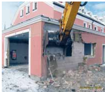
Der Abbruch kann beginnen
