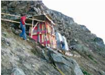
Bereit zum betonieren
