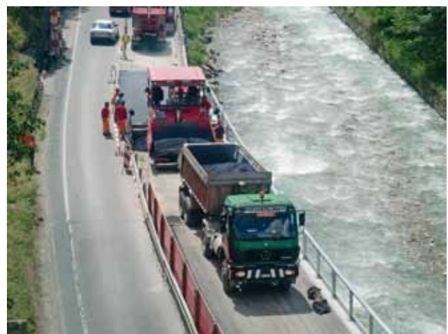
Nach dem Abdichten und einkoffern kam die Firma Schlub AG, sie erstellte mit dem Belag die neue Fahrbahn.
