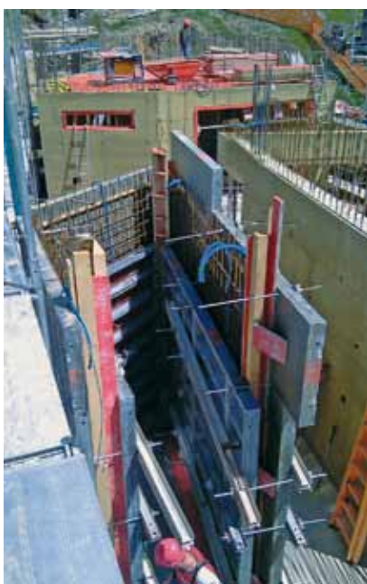
Alles wurde in Beton hergestellt das meiste in Sichtbeton.
