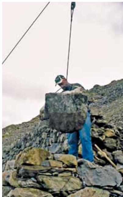
Stein für Stein wurde wieder neu gesetzt
