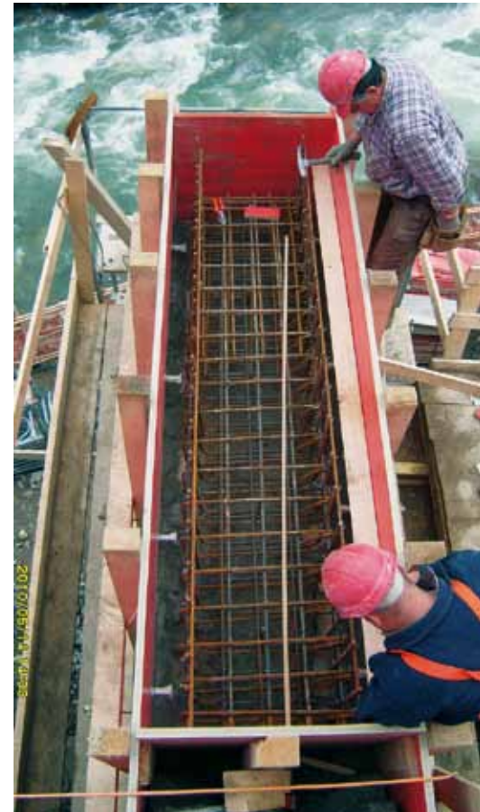
Auf den freigelegten Brückenauflagern mussten neue Köpfe erstellt werden
