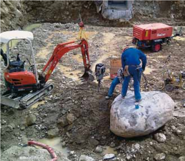
Zerkleinern von Findlingen mit hydraulischem Spaltkeil
