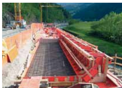
Nun bereit zum Betonieren
