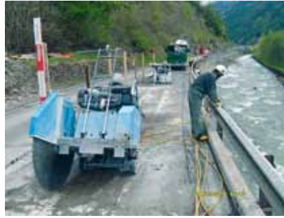
Mit einer Betonfräse wurden Streifen von 1.0 m Breite und 9.0m Länge geschnitten
