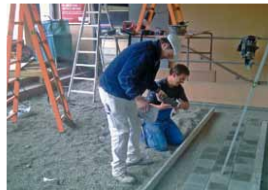
Marco Pozzi und Claudio Lanfranchi verlegen die neuen Eingangsplatten
