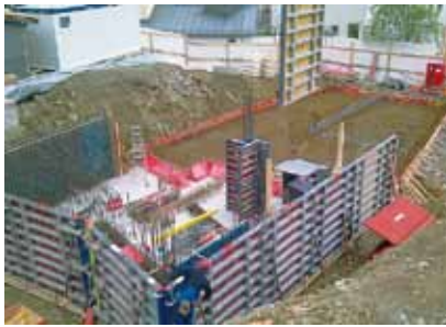
Das Untergeschoss entsteht
