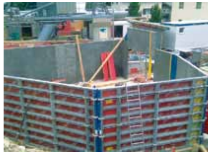
Mehrheitlich kamen nur neue Framaxelemente zum Einsatz
