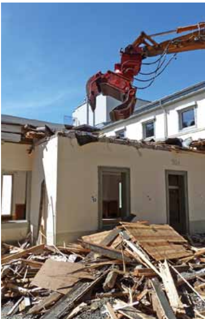
Abbruch des alten Personalhauses
