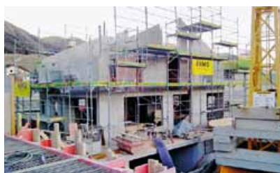
Bereit zum Aufrichten des Daches
