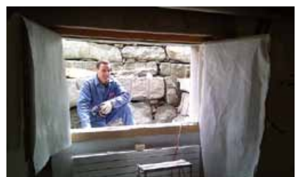
Zuputzen neue Fenster im Untergeschoss durch Renzo Costini
