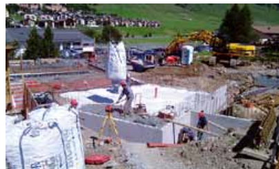
Unter den Bodenplatten wurde Misapor eingebaut
