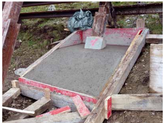
Ein freigelegter Mikropfahl vor dem Schalen und Betonieren. Gut ersichtlich sind die kleinen Fundationen die früher erstellt wurden.
