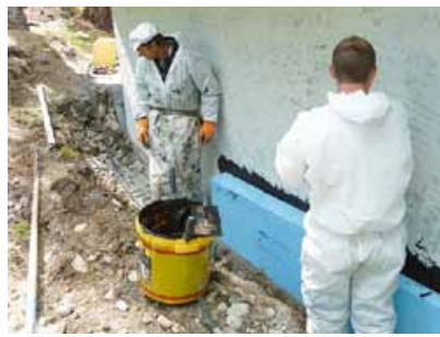
Im Sockelbereich wird eine Perimeterisolation aufgezogen
