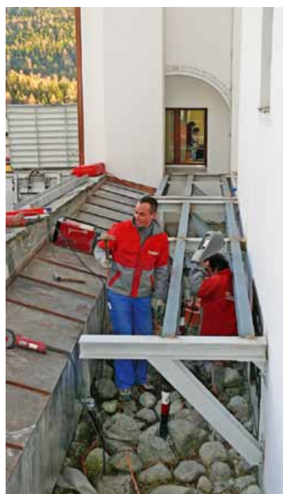
Drei Tage vor Eröffnung erstellten wir beim Notausgang noch eine Passarelle
