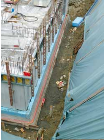
Perimeterisolierung und Sickerleitung
