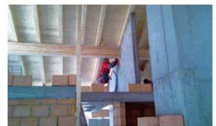
Innen Ausmauerungsarbeiten
