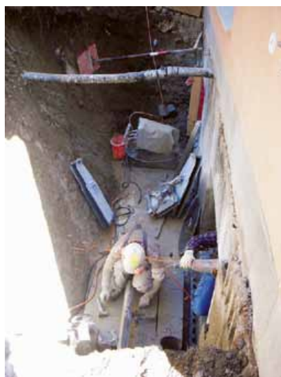
Im Untergeschoss werden neue Fenster ausgefräst
