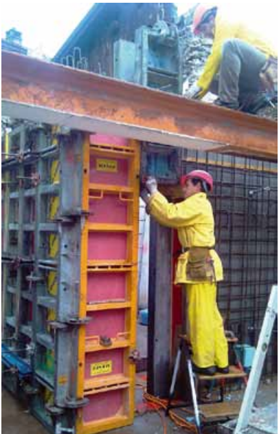
Innenwände in Beton
