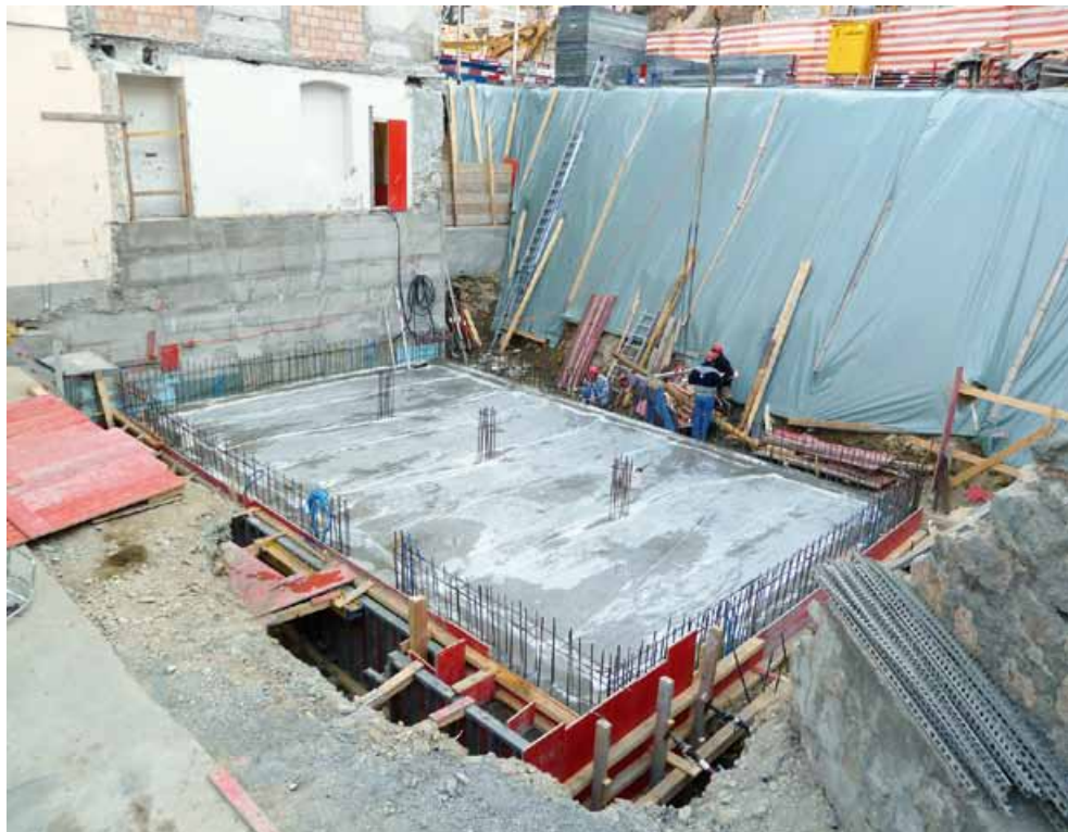
Bodenplatte betoniert
