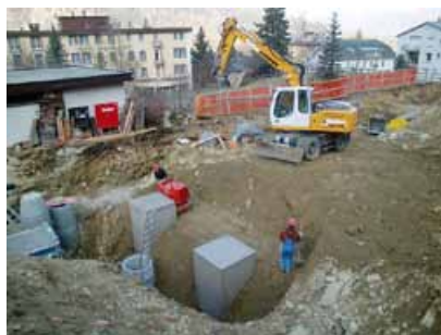
Die Kranfundation kam seitlich der Kanalisation zu liegen
