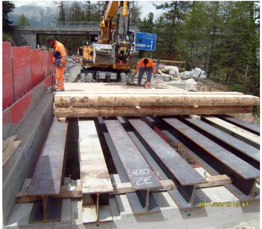
Wir erstellten Auflager und mittels Stahlträger und Holzrollen eine provisorische Notbrücke.
