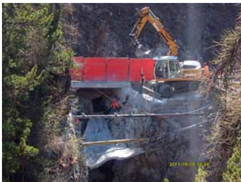
Nun wurde die Arbeitsbühne eingebaut und so lässt es sich doch entspannter arbeiten, als wie Dario Giudici hier am Seil.
