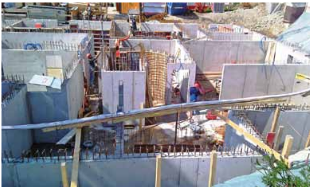
Wände im Untergeschoss
