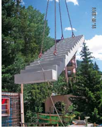
Die Treppen und der Dachabschluss wurden im Elementbau angeliefert
