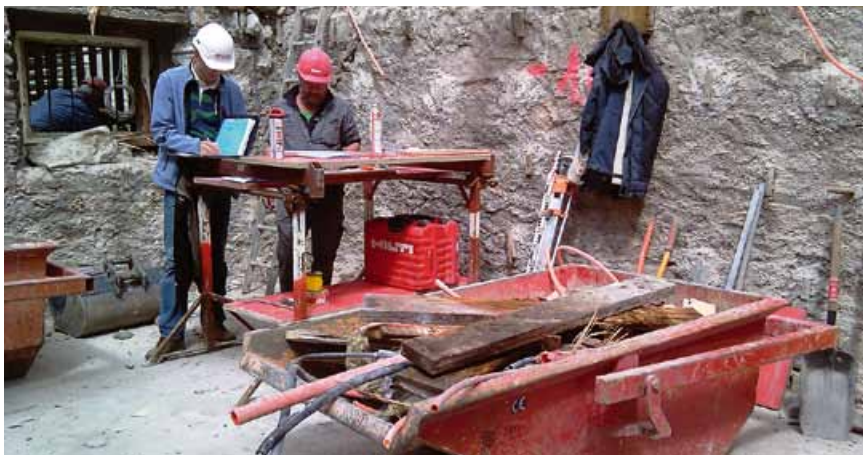
Besprechung Bauablauf, Capo Luciano del Curto und Bauingenieur Markus Berweger
