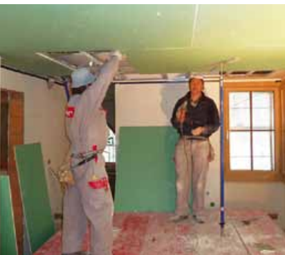
Marco Pozzi, der die Gipserarbeiten leitete, beim erstellen von heruntergehängten Decken
