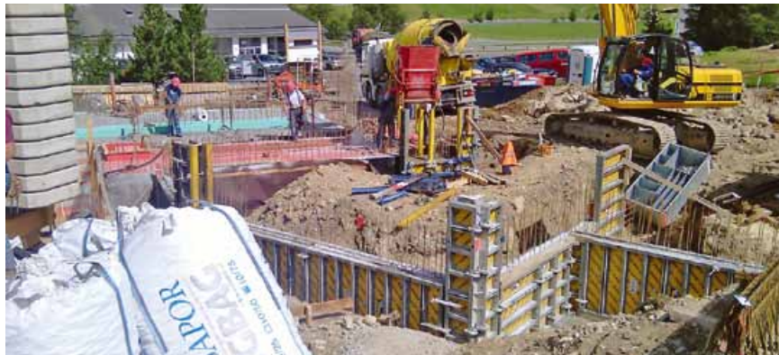
Die Einmessarbeiten erwiesen sich in der Anfangsphase alles andere als einfach
