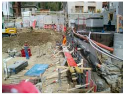
Überall waren Leitungen im Weg und mussten umgeleitet werden
