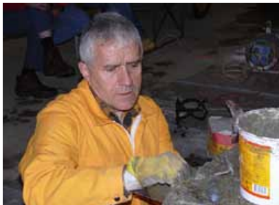
Eins zu eins wird eine abgebrochene Kante reprofiliert
