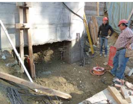
Unterfangen des bestehenden Gebäudes
