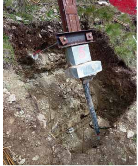
Ein freigelegter Mikropfahl vor dem Schalen und Betonieren. Gut ersichtlich sind die kleinen Fundationen die früher erstellt wurden.
