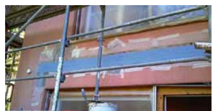
Rissanterung Fassaden
