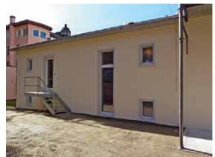
Ansicht des neuen Personalhauses von hinten
