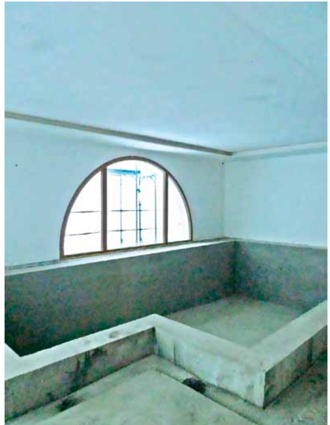
Das Hallenbad steht für die Abdichtung bereit
