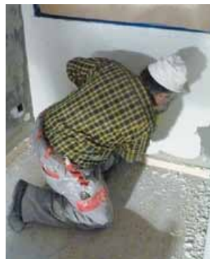
Tomaso Curti bei Verputzarbeiten
