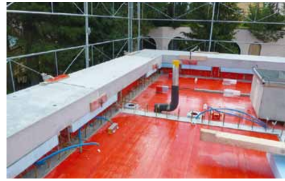
Die Treppen und der Dachabschluss wurden im Elementbau angeliefert
