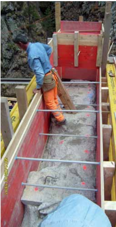
Wir erstellten Auflager und mittels Stahlträger und Holzrollen eine provisorische Notbrücke.
