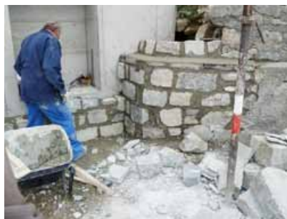
Die alte bestehende Bruchsteinmauer wurde ergänzt
