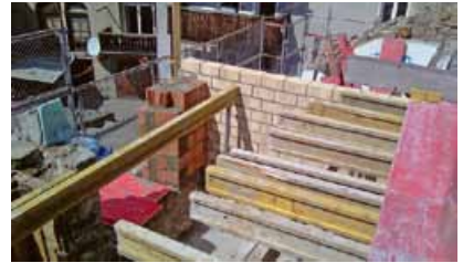
Deckenschalung Dachgeschoss
