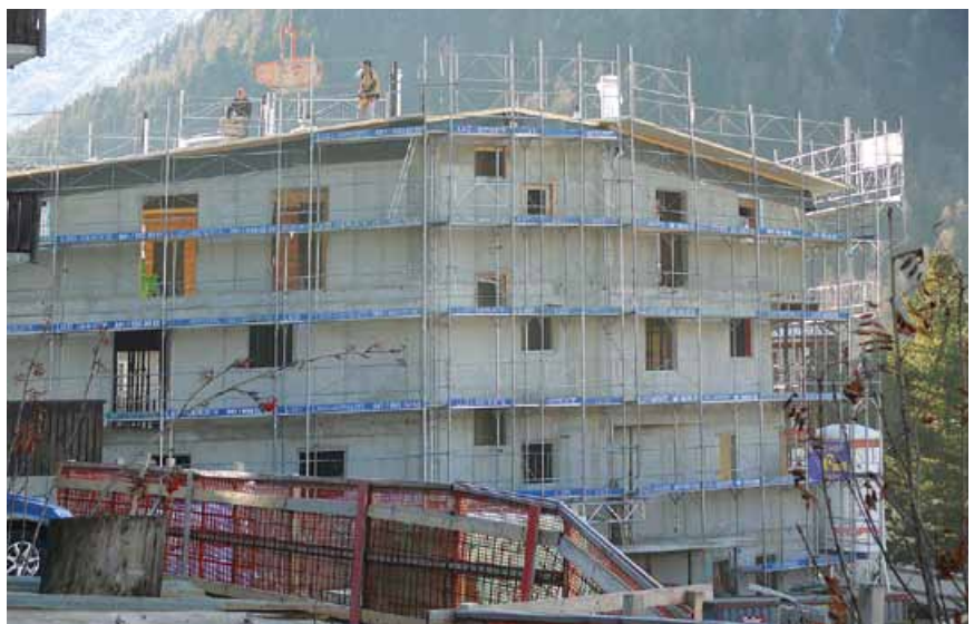
Am 7. November wurde das Dach aufgerichtet
