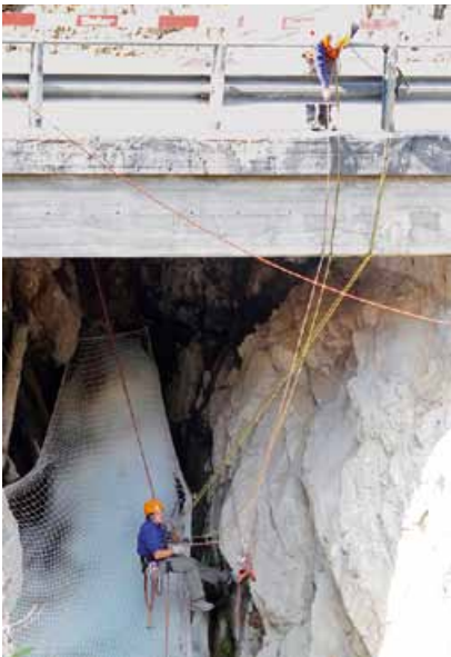
Thomas und Erwin Furrer hängen unter der Brücke ein Sicherheitsnetz auf.
