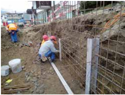
Die Ausfachung der Stahlträger der Baugrubensicherung konnte beginnen
