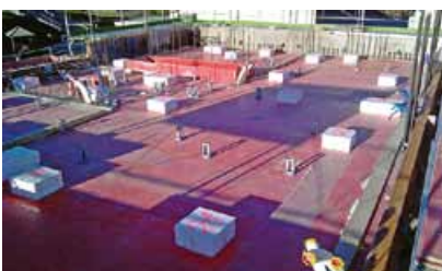
Decke 1. Teil Untergeschoss
