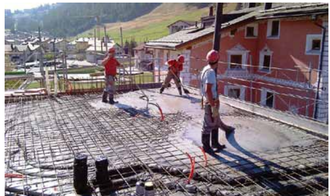
Decke betonieren mit selbstverdichtendem Beton
