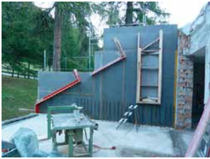
Neue Giebelwände entstehen
