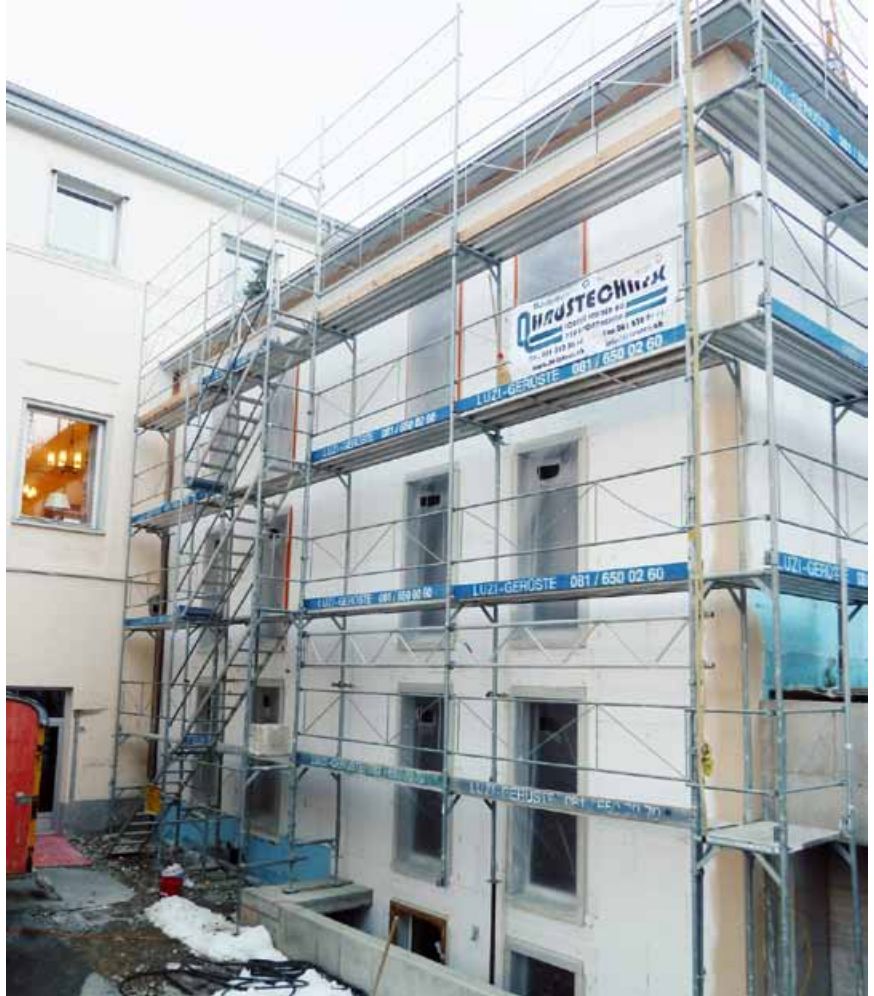
Die Aussenisolierung und die Verputzarbeiten wurden ebenfalls von uns ausgeführt
