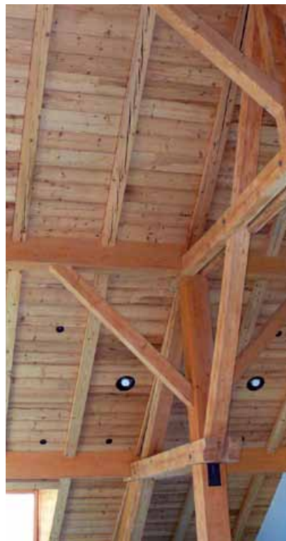
Dachstock alles in Altholz
