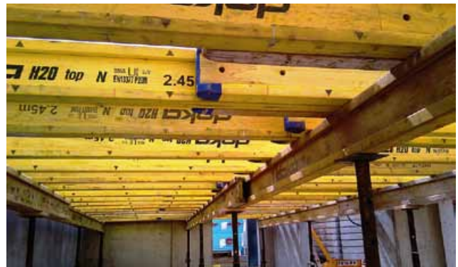
Deckenschalung Erdgeschoss
