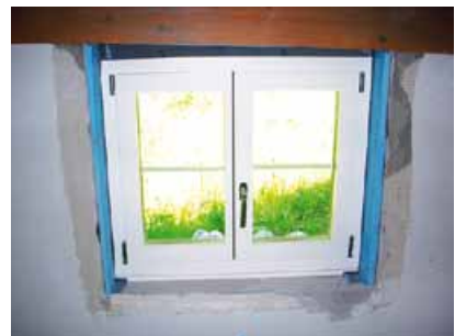
Anpassungen der Leibungen bei den neuen Fenstern
