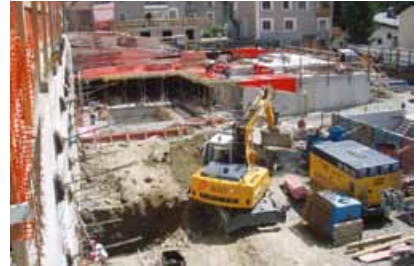
Nebst dem MFH Etter wurde nebenan auch das MFH Seglias vorangetrieben
