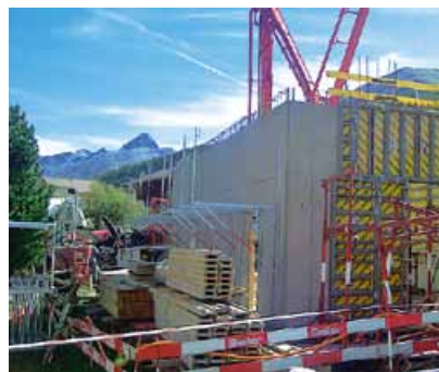
Wandhöhen bis fünf Meter in Sichtbeton
