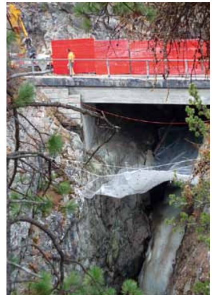
Bereit zum Abbrechen der Brücke. Einen Meter über dem Netz wurde anschließend eine Arbeitsbühne eingebaut.
