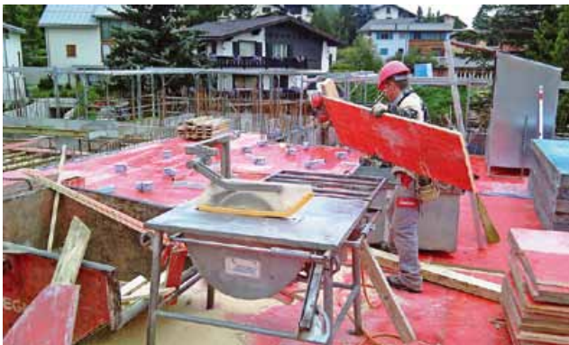
Decke im Obergeschoss
