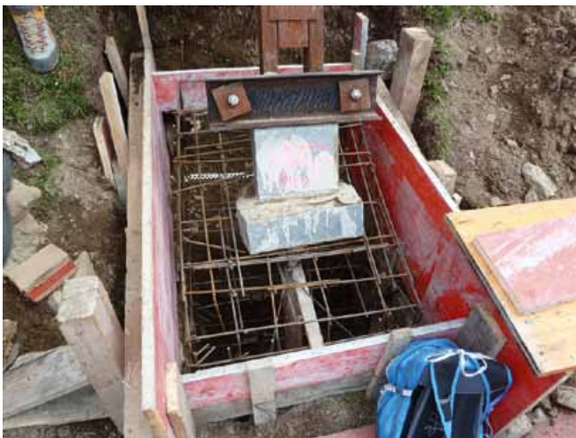
Ein Neues, viel grösseres Fundament/Unterfangung, vor und nach dem Betonieren
