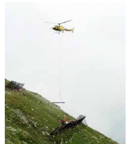
Materialtransporte zur Baustelle mit der Heli-Bernina
