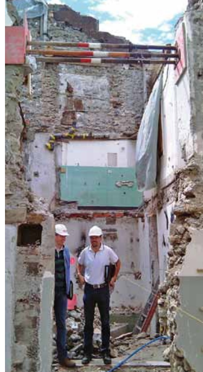
Baurundgang: Bauleitung René Oswald und Ingenieur Markus Berweger
