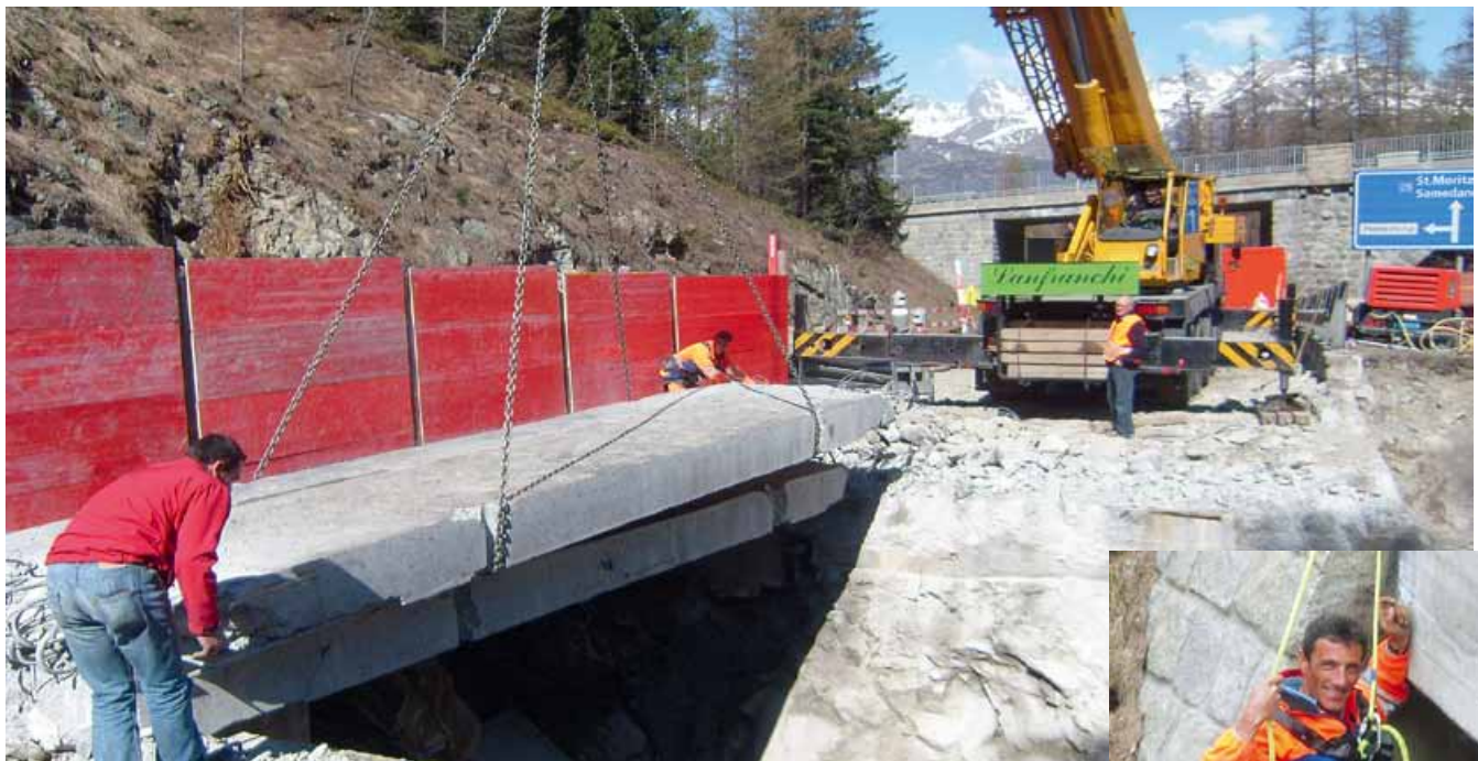
Die Brücke wurde in Stücke geschnitten und vom Autokran weggehoben.
