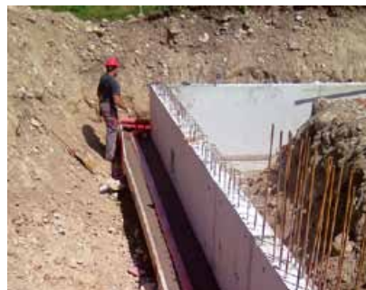
Frostriegel mit Sickerleitung
