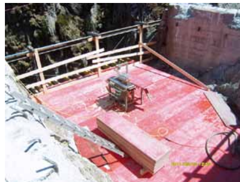
Nun wurde die Arbeitsbühne eingebaut und so lässt es sich doch entspannter arbeiten, als wie Dario Giudici hier am Seil.
