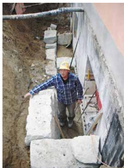
Capo Renzo Iacomella, Aufbau Lichtschacht mit Blocksteinen
