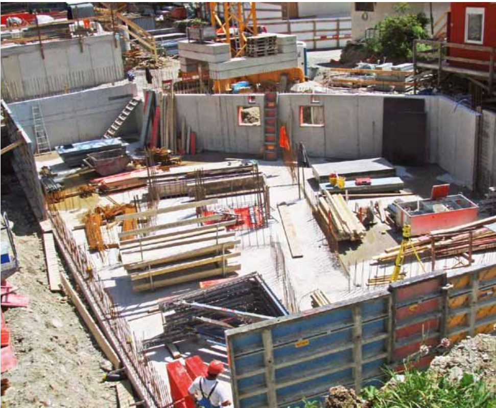
Bodenplatte mit Aussenwänden des Untergeschosses
