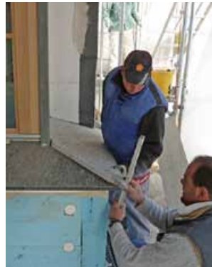
Fensterbänke werden versetzt
