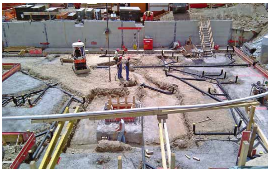
Einbau Haustechnik unter Bodenplatte
