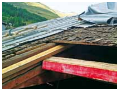
Über Dachöffnungen wird Material ins alte Engadinerhaus befördert. Das Dach bestand ursprünglich aus Schindeln, später wurde ein Blechdach darüber verlegt. Nun entsteht ein isoliertes Blechdach, bei dem die ursprünglichen Dachbalken sichtbar bleiben.
