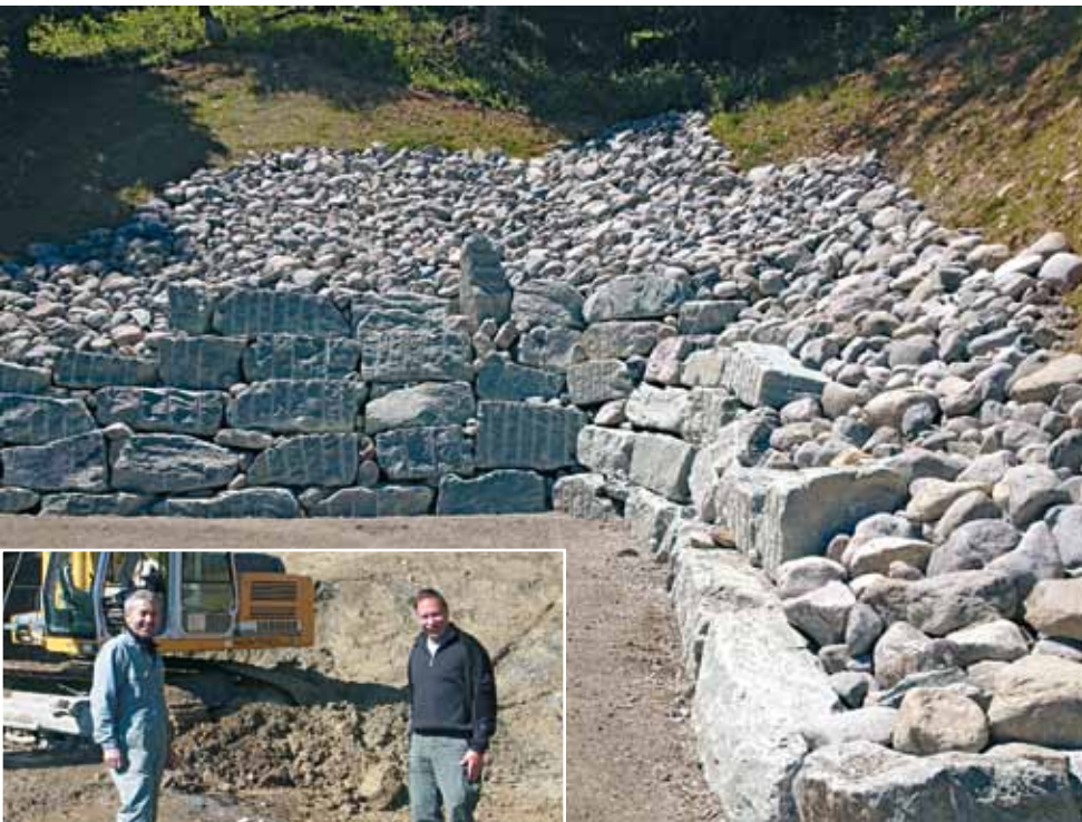
Neuer Wendeplatz mit Hangentwässerung und Stabilisierung
