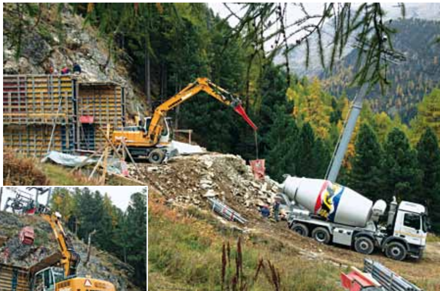
Sämtliche Betonarbeit konnte direkt mit dem Pneubagger ab Fahrmischer vorgenommen werden
