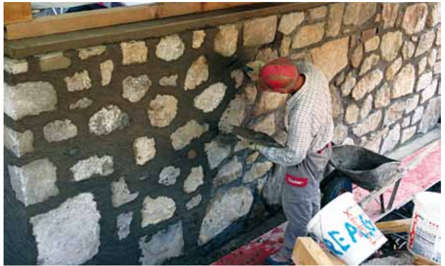
Nino Lorenzoni, Fertigarbeiten am Bruchsteinmauerwerk
