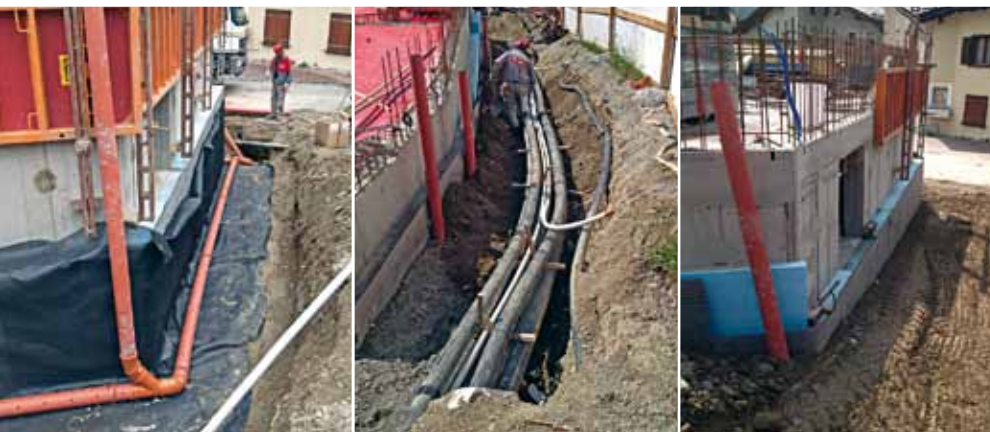
Sauberes Arbeiten in Etappen. Vorbereitung Sickerleitung, hinterfüllt und Kabelblock verlegt, alles hinterfüllt und verdichtet.
