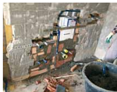
Einmauern der neuen Sanitärinstallationen
