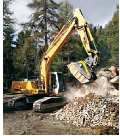
Felsabbau in der Kurve und Materialaufbereitung zum Wiedereinbau
