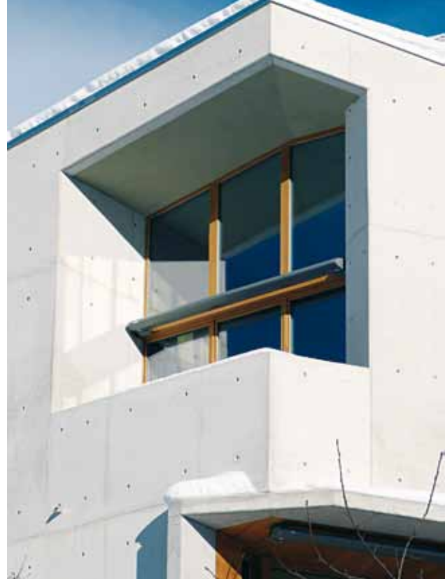
Dieser Sichtbeton lässt keine Wünsche übrig
