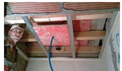
Schliessen der alten Öffnung unter Dach durch Manuel Cabral
