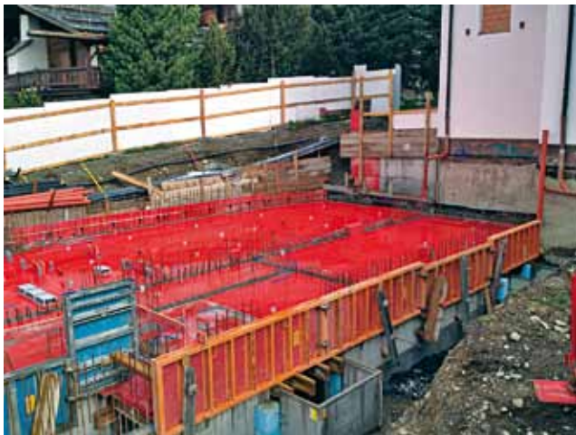
Decke über UG: Bereit zum Betonieren
