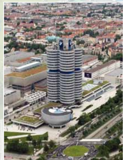
Das BMW Gebäude vom Fernsehturm aus gesehen
