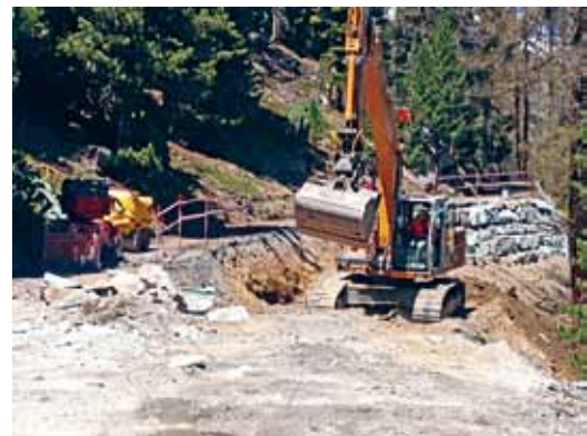
Erstellen des Blockwurfs
