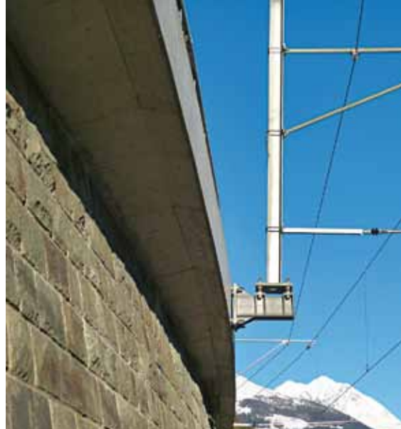
In den Kordon integrierter RhB Strommast
