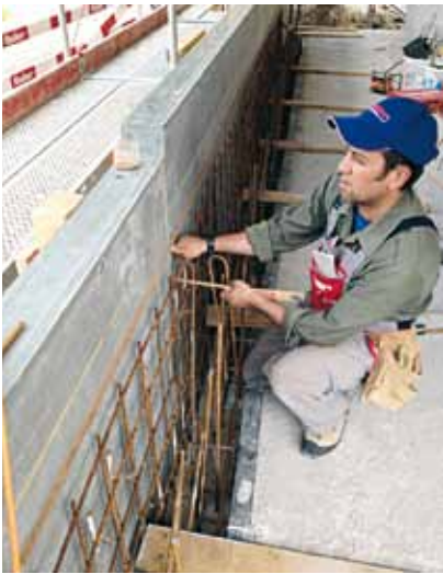
Capo Gianluca Del Vecchio bei Schalungsarbeiten an der Brüstung
