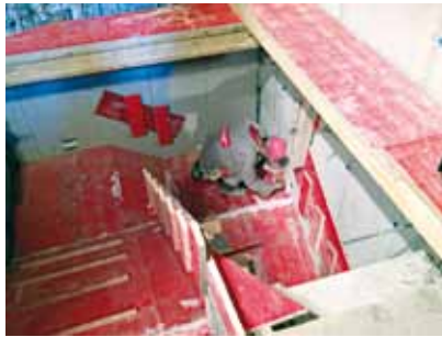
Auch ein neues Treppenhaus wird hochgezogen.
