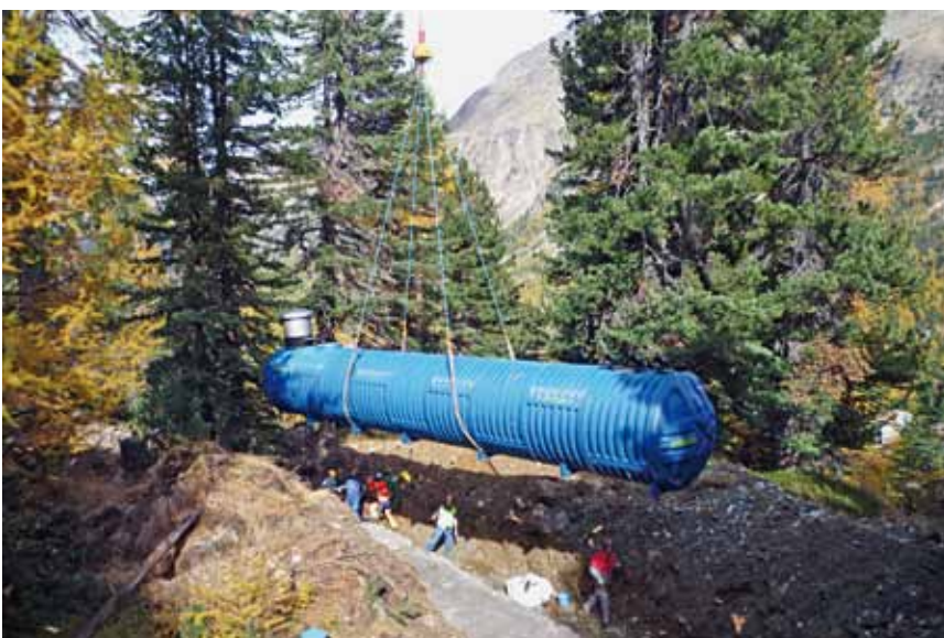
Das Reservoir wird am Berg oben gesetzt
