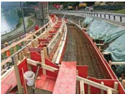
Die erste Etappe ist bereit zum Betonieren
