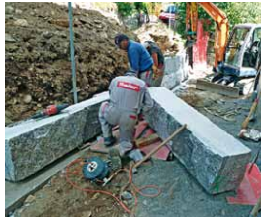
Die alte Stützmauer wurde neu durch Quadersteine aus dem Tessin ersetzt
