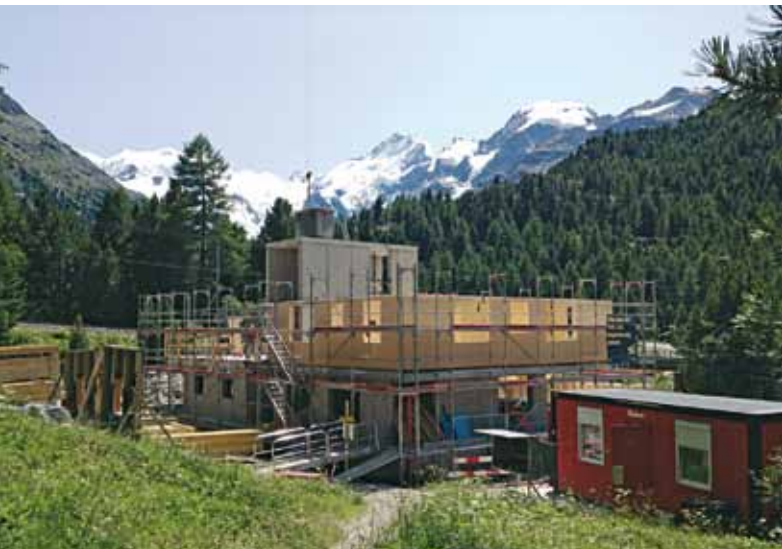
Aufbauen der Elementkonstruktion
