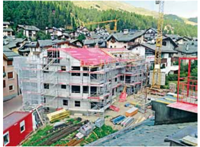
Ein Mehrfamilienhaus, das in der Aussenhülle komplett aus Beton besteht, sogar das Dach wurde betoniert.
