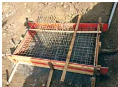
Die Bodenplatte eines Mastfundamentes
