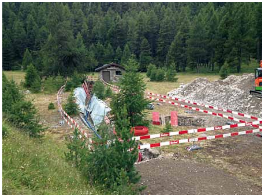
Anschluss Leitung bis zum Pumpenhaus
