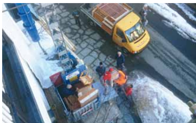
Der Möbelabtransport funktionierte über den Aussenlift
