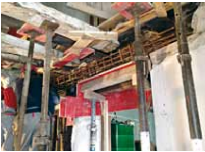
Die alte Balkendecke und die neu eingezogenen Stahlträger erhalten ein neues Auflager das zugleich Türsturz ist. Der Ingenieur, der Schaler und der Eisenleger wurden stark gefordert.
