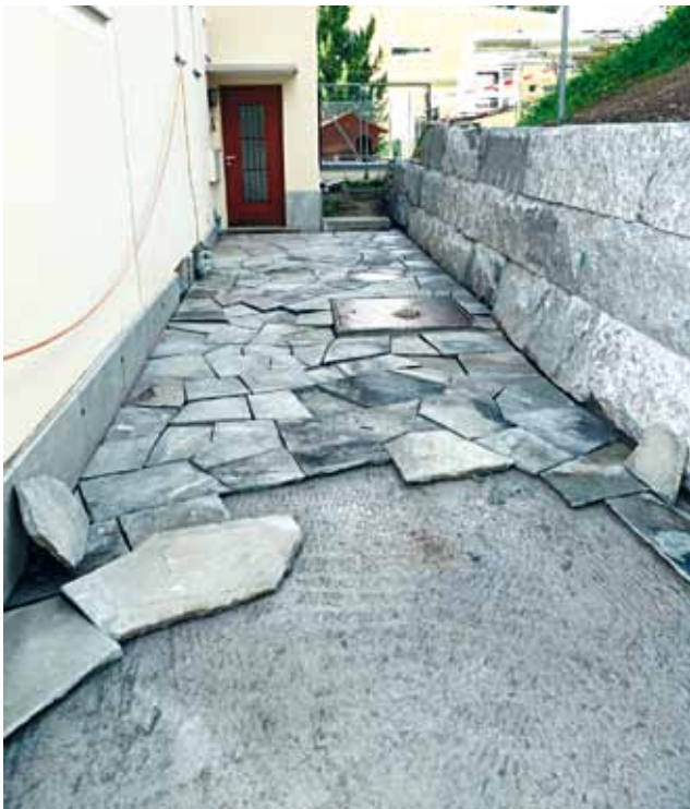
Zum Hauseingang werden neu die Bevola Platten verlegt
