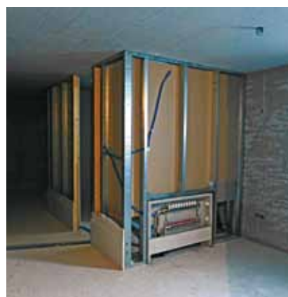
Sämtliche Innenwände wurden im Gipskartonsystem erstellt
