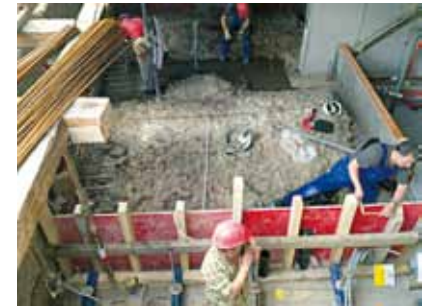
Alte Gewölbe werden freigelegt und überbetoniert.
