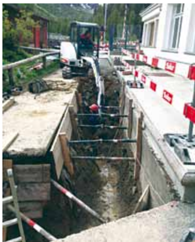
Grabenaushub zum Teil im Fels
