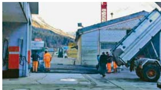
Die Firma Schlub teert die neue Einfahrt
