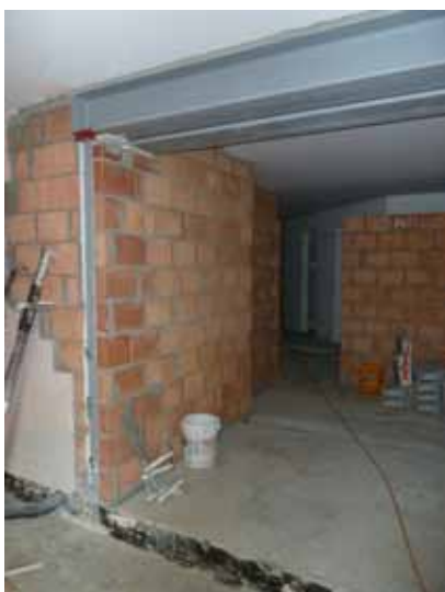
Diverse Stahlträger wurden eingebaut und an der Fassade Änderungen vorgenommen.
