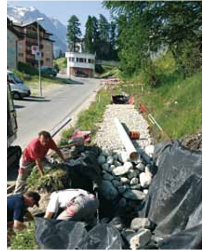
Flies und Sickerpackung einbauen
