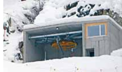
Die lawinensichere Bergstation mit geheiztem und modernen Aufenthaltsraum für den Skiliftangestellten
