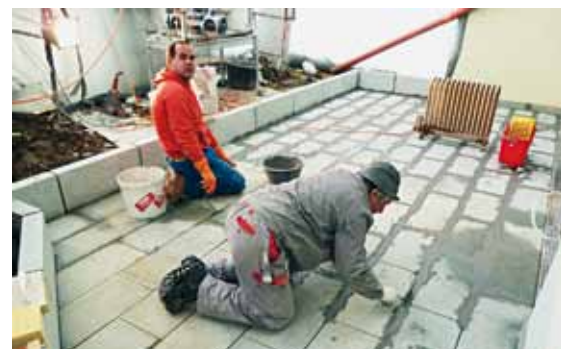
Auf dem Gartensitzplatz wurden durch Antonio Martinho und Tomaso Curti neue Platten velegt.
