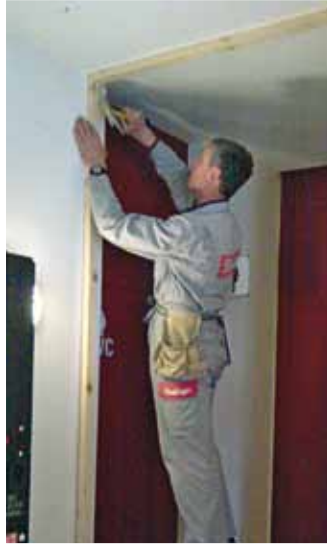
Sisto Besseghini verschliesst die Durchgänge staubdicht
