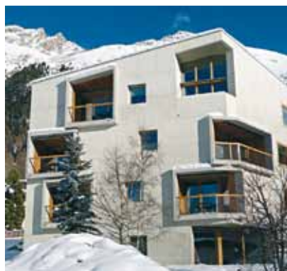
Südansicht der Sichtbetonfassade
