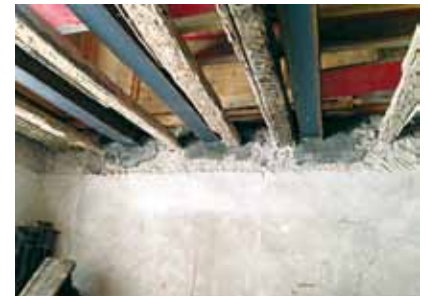
Neu eingezogene Stahlträger neben den mehrere hundert Jahre alten Holzbalken die weiterhin sichtbar bleiben.
