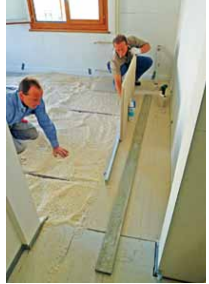
Im Innern wurden die Böden neu mit Brio Elementplatten ausgeführt
