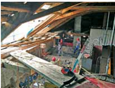
Über Dachöffnungen wird Material ins alte Engadinerhaus befördert. Das Dach bestand ursprünglich aus Schindeln, später wurde ein Blechdach darüber verlegt. Nun entsteht ein isoliertes Blechdach, bei dem die ursprünglichen Dachbalken sichtbar bleiben.
