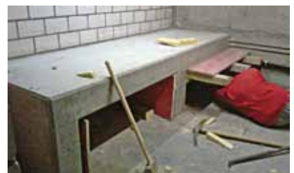
Ausschalen Waschmaschinen Sockeltisch
