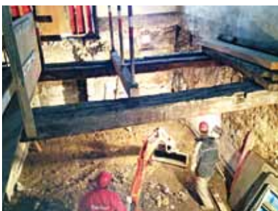
Unterfangungsarbeiten im Untergeschoss
