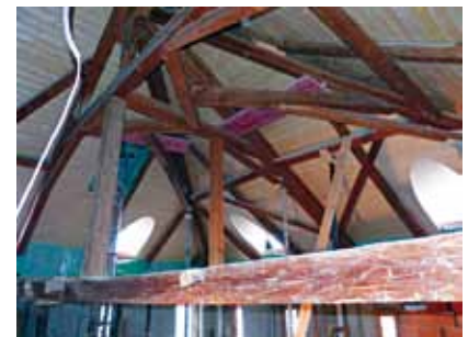
Neuer und zugleich alter Dachstock. Die helle Täferung wird mit Gipsplatten verkleidet.
