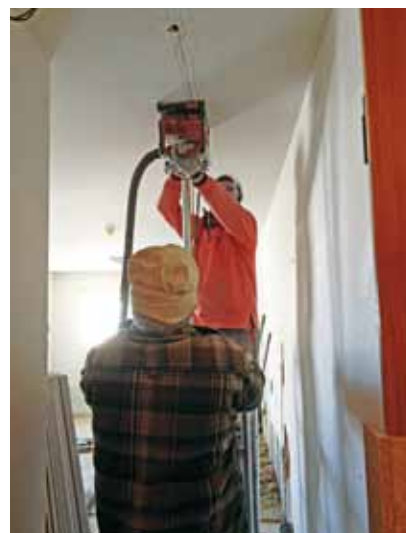
Diverse neue Leitungen wurden in Decke und Boden eingefräst
