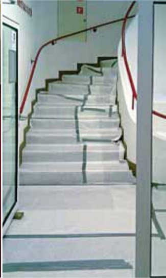
Das Treppenhaus ist abgedeckt
