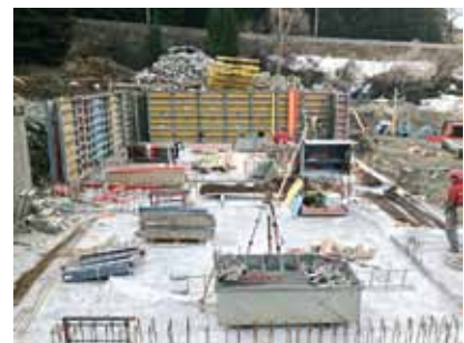
Untergeschoss; erstellen der Aussenwände
