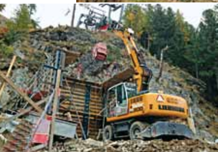
Sämtliche Betonarbeit konnte direkt mit dem Pneubagger ab Fahrmischer vorgenommen werden
