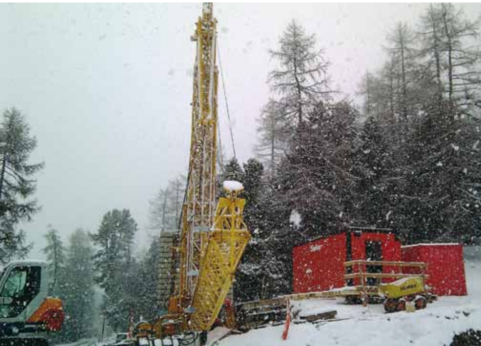
Installation Baukran bei winterlichen Verhältnissen
