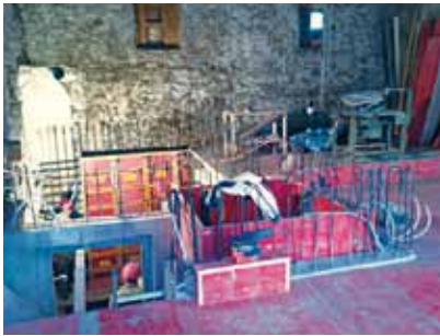
Von unten nach oben werden neue Wände und Decken eingebaut.
