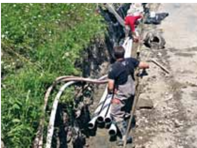
Mehrere Rohrböcke verlegen
