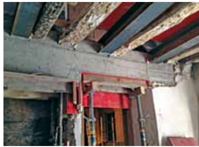
Die alte Balkendecke und die neu eingezogenen Stahlträger erhalten ein neues Auflager das zugleich Türsturz ist. Der Ingenieur, der Schaler und der Eisenleger wurden stark gefordert.
