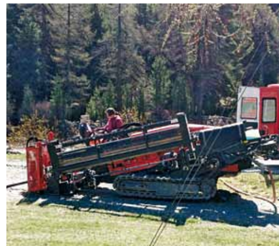
Leitungsdurchstossung unter RhB-Linie
