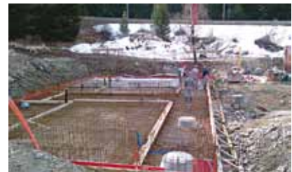
Betonieren der Bodenplatte
