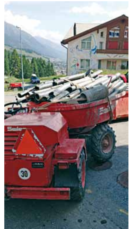
Rückbau von alten Leitungen
