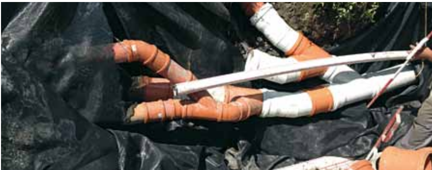
Drainagen Hangentwässerung kanalisieren
