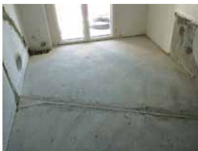
Diverse neue Leitungen wurden in Decke und Boden eingefräst
