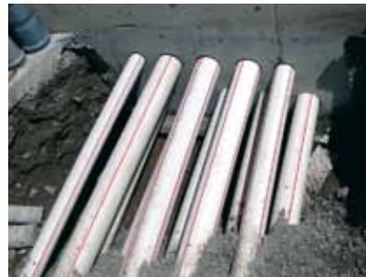
Rohrböckeführung ins Gebäude
