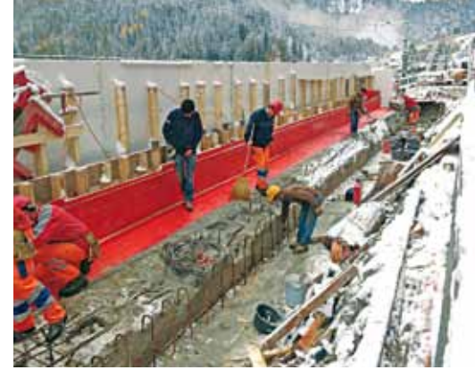
Die 80 Meter, die wegen fehlendem Schutzgerüst nicht ausnahmslos am Tag gebaut werden konnten. Die weissen Schutzplatten sind nur ein geringer Schutz. Schalarbeiten konnten nur in der Nacht, wenn die Fahrleitung ausgeschaltet war, erledigt werden.
