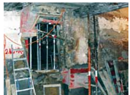
Komplizierte Schal- und Abstützarbeiten
