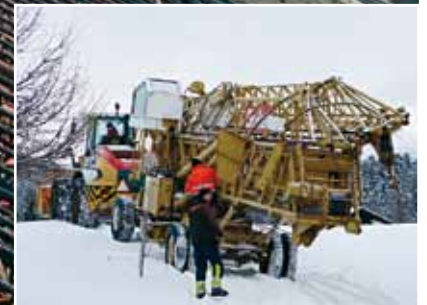
Unkomplizierte Krandemontage. Der Kran wird kurzerhand über die Wiese gezogen.
