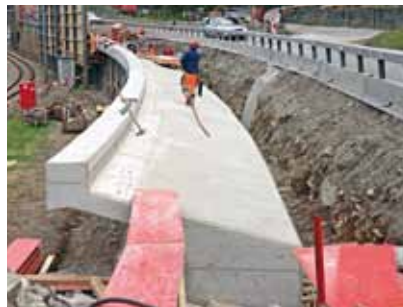
Hier später ausgeschalt und bereit zum Abdichten.
