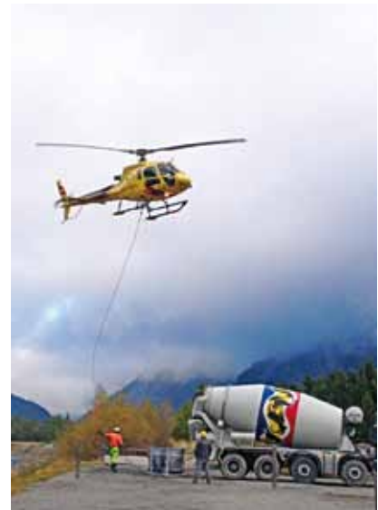
Im steilen Gelände wurde der Beton mit dem Heli eingebracht
