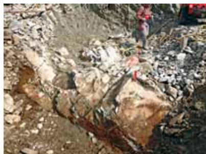
Bei der Bergstation musste viel Fels gesprengt werden
