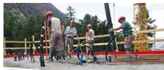
Einbringen des Deckenbetons
