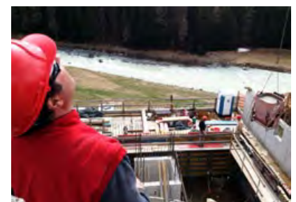
Betonieren der Wände aus der Sicht des Kranführers Angelo Fernandes Carvalho
