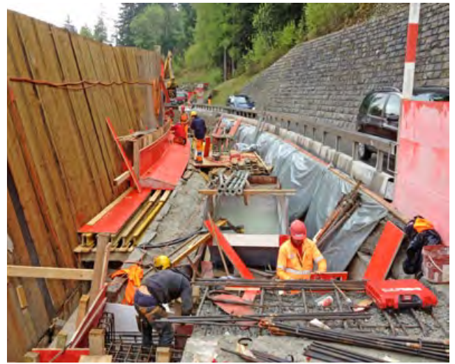
Zusätzlich zur Brücke wurden noch 280m Strassenkordon erstellt. Gut ersichtlich sind die engen Platzverhältnisse.
