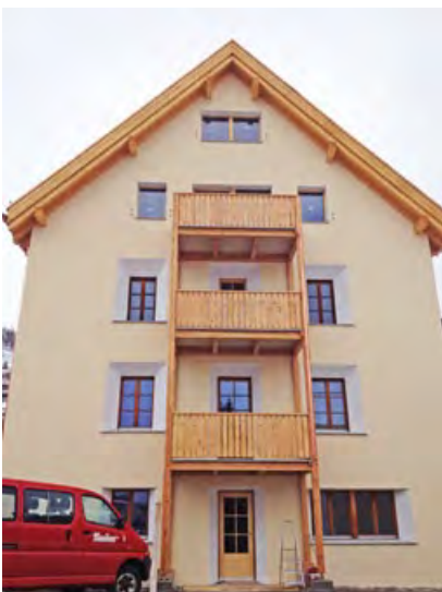
Fertige Chesa Denoth, nach Abschluss der Fassadensanierung
