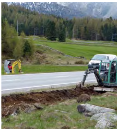
Die beiden Kleinbagger im direkten Vergleich. Das gleichzeitige Arbeiten links und rechts der Strasse förderte die Leistung.
