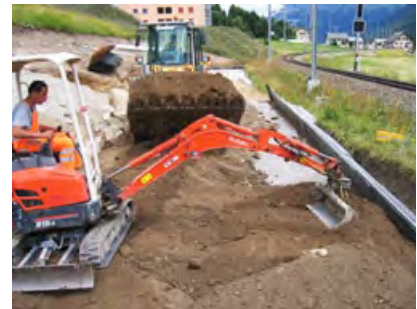
Schichtweise wird das Material eingebracht und verdichtet
