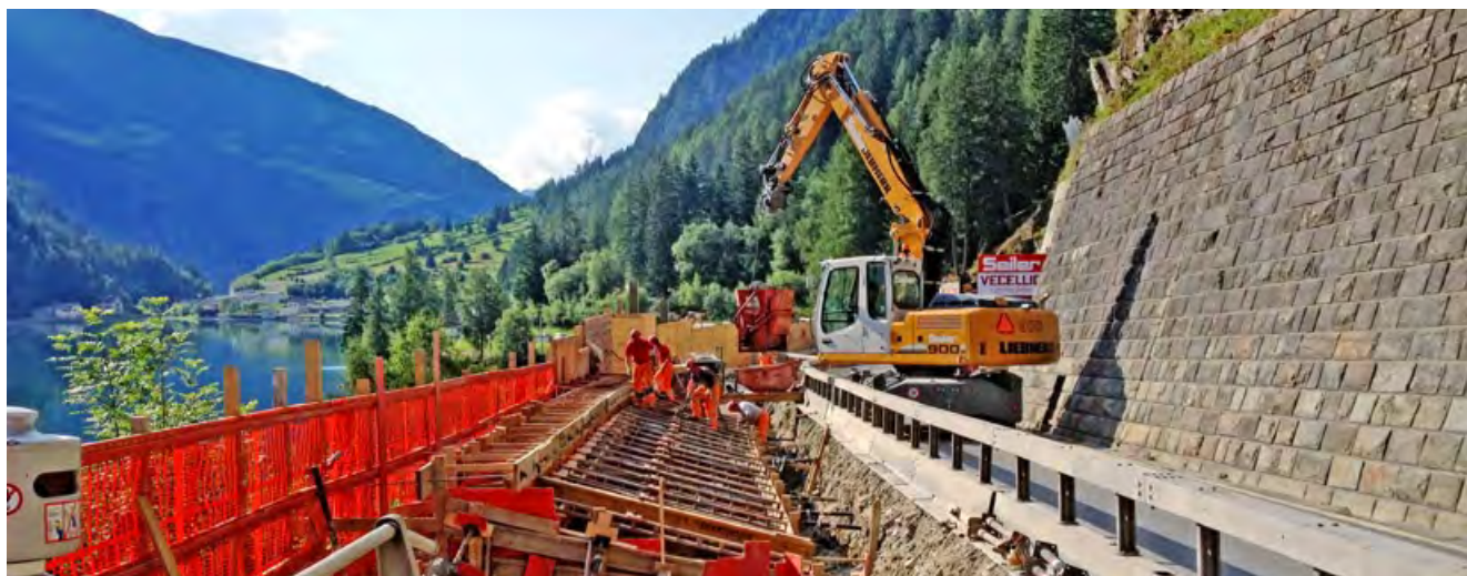
Betonieren mittels Pneubagger
