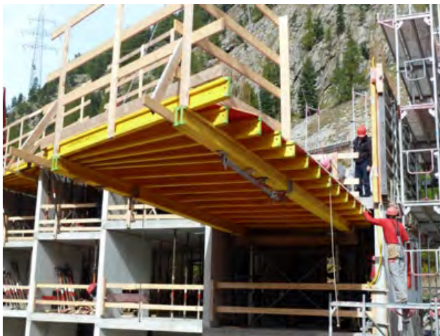
Die Schaltische werden mit dem Geländer ausgebaut...
