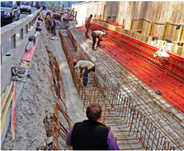
Die Armierung wird verlegt
