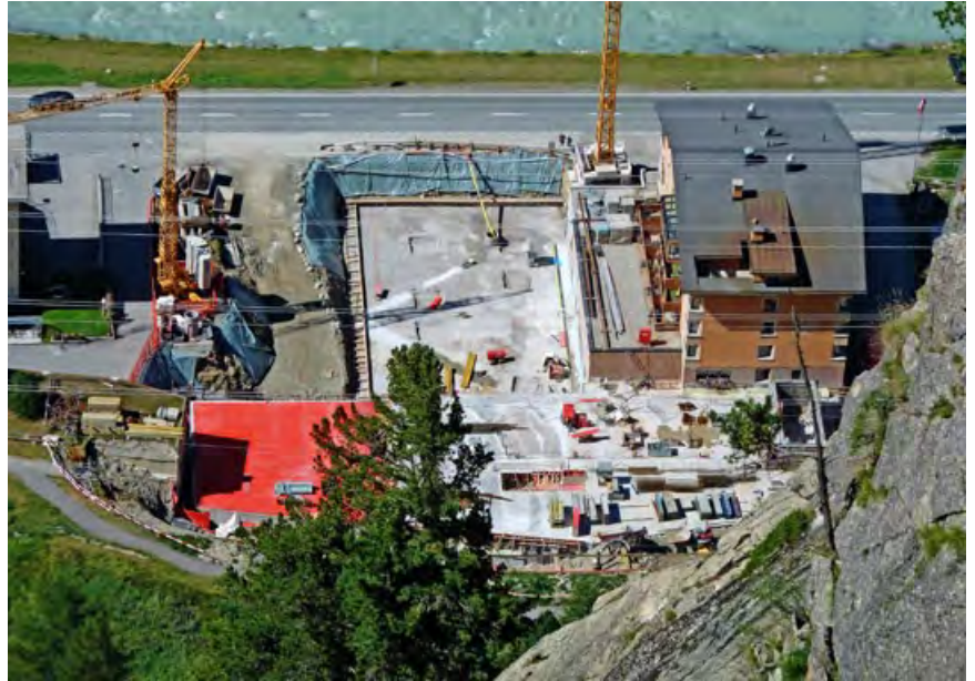
Sicht vom Klettersteig auf die Baustelle
