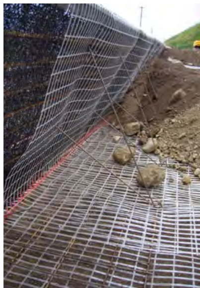
Das Sytec Terra Mur Produkt, welches eine Böschungsneigung von 70 Grad zulässt
