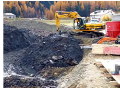
Antonio Cattaneo lädt mit seinem Raupenbagger das schlechte Material auf
