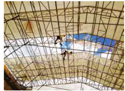
Kranöffnung im Notdach, welche in der Nacht jeweils geschlossen wurde
