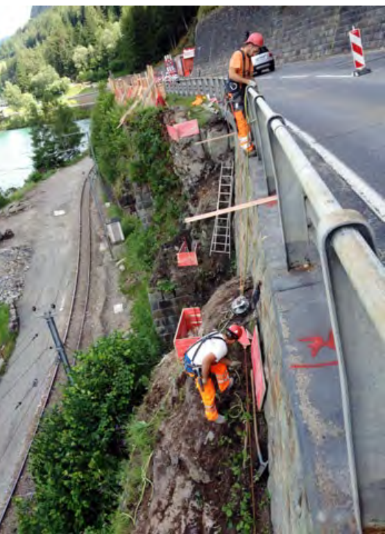
Das Stellen der Schutzgerüstpfeiler verlangte uns einiges ab
