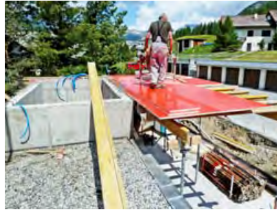
Schalen des Vordaches mit neuen Schaltafeln
