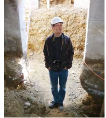
Bauherr und Architekt Heinz Inhelder hatte jederzeit alles unter Kontrolle
