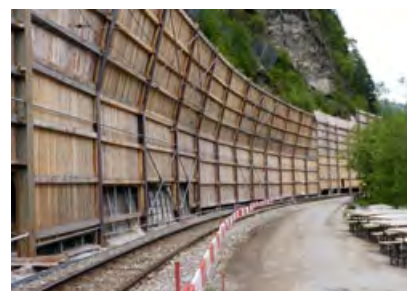
Zum Schutz der RhB Linie wurde ein Schutzgerüst auf die ganze Länge erstellt
