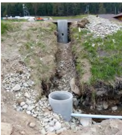
Für jedes Signal galt es, ein Fundament mit einem Betonrohr zu erstellen, zudem setzten wir alle 300m bei jedem Mast, ein Kabeleinzugschacht
