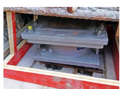
Die neuen Brückenlager werden eingebaut
