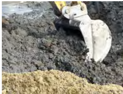
Bis zur unteren Kiesschicht mussten 3m Torf abgebaut werden
