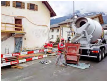
Betonieren der Kellerdecke direkt ab Fahrmischer
