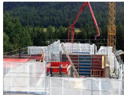
Betonieren der Wände mittels Betonpumpe
