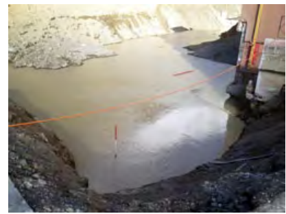
Der Baugrubenaushub war nicht immer lustig, das Grundwasser drückte
