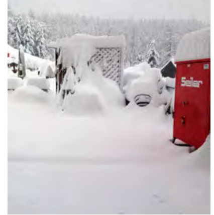
Ein Tag nach Baustelleröffnung kam der grosse Schnee!
