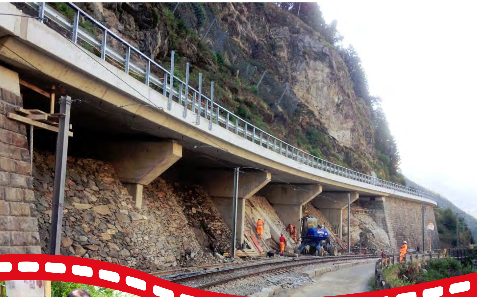
Fertige Brückenuntersicht. Letzte Instandstellungsarbeiten an den Bruchsteinmauern.
