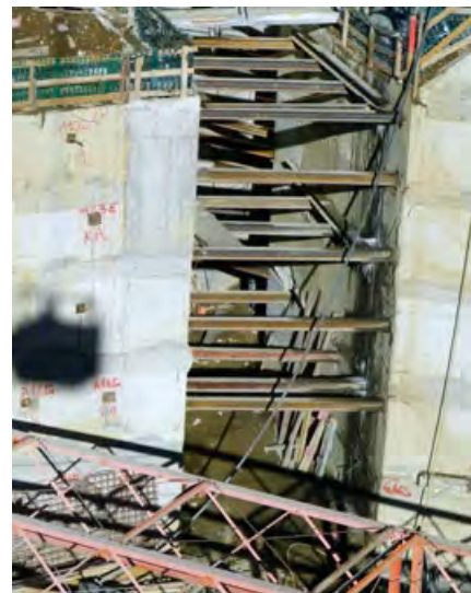
Im Verbindungskorridor zum Sporthotel wurde nicht geankert, sondern alles mit Stahlträgern ausgefacht.
