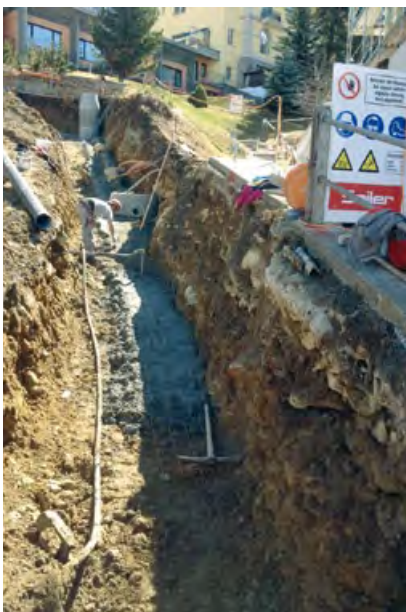
Die Leitungen mussten umgelegt werden
