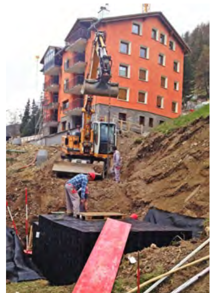
Für das Meteorwasser wurde ein separater Sickerschacht gebaut
