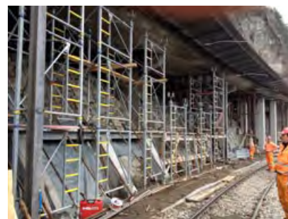
Unter der Brücke wurde ein Leegerüst eingebaut
