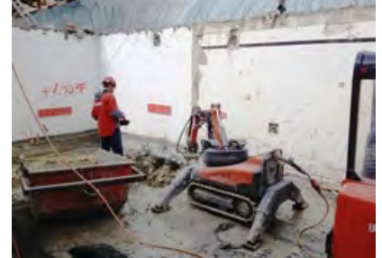
Ausbruch und Aushub für die Liftunterfahrt
