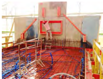
Schalungsarbeiten Decke Dachgeschoss und Giebelwände
