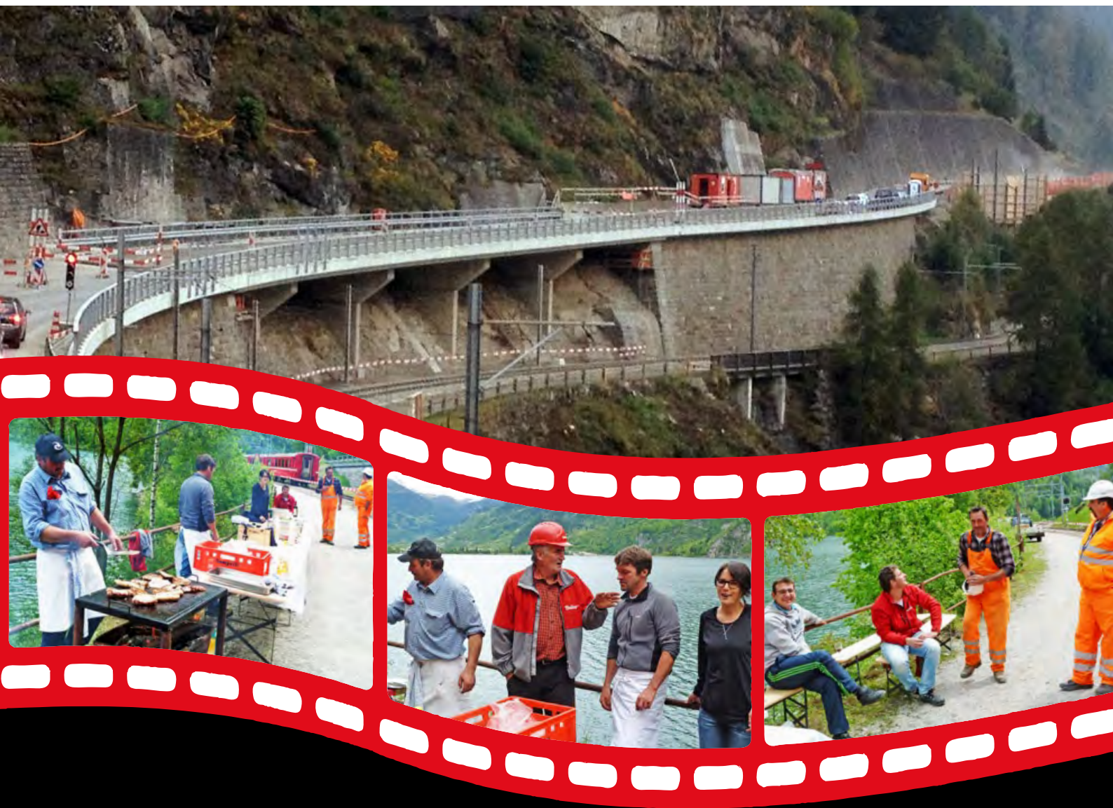
Hier bekommt man einen Eindruck von der Dimension. Talseits betrug die Gesamtlänge 320m!
