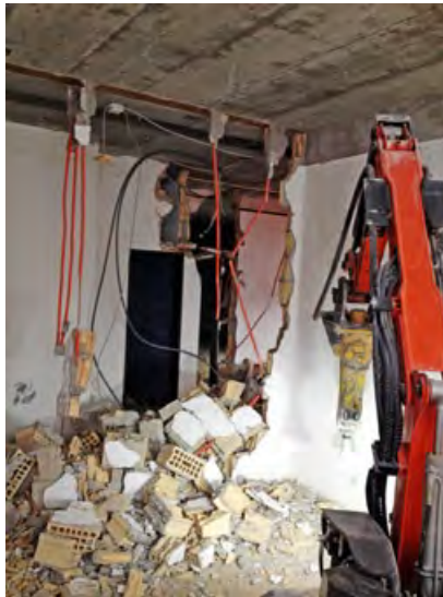
Bei den Abbrucharbeiten wurde so viel wie möglich mit dem Abbruchroboter gearbeitet . . .
