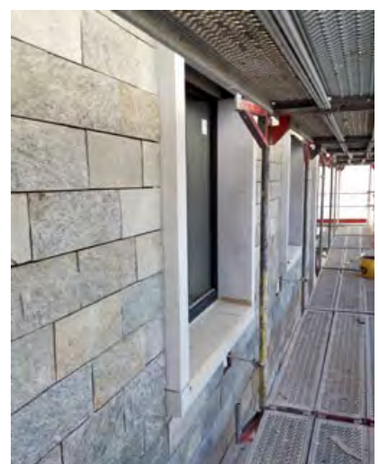
Die Fenster wurden mit Faserbetongewände umrahmt. Die Platten stammen aus dem Val Malenco. Interessant wird sein, wie sich unsere Fassadensystem Lösung im Vergleich zu den Nachbarhäusern bewähren wird.
