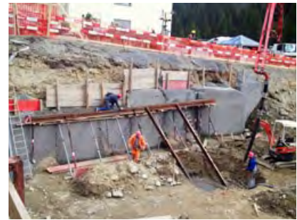
Baugrubensicherung gegen Chesa Gianda
