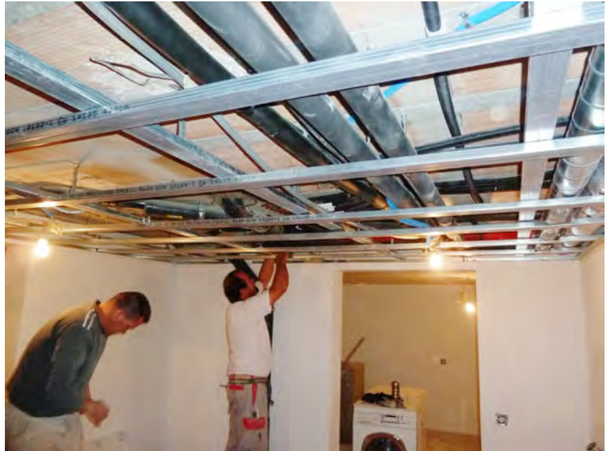
Zeitgleich wurden auch im Innenbereich sämtliche Gipsarbeiten erledigt
