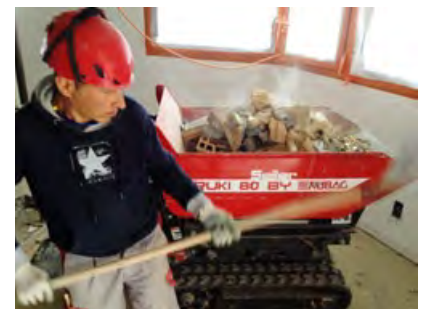
. . . der zugleich auch den Bauschutt mittels Motorkarette ins Freie brachte
