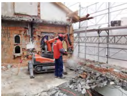
Rückbau von oben nach unten mittels Abbruchroboter
