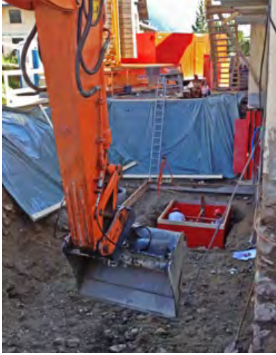
Aushub Treppenhaus und Weinkeller
