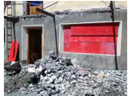
Rückbau Balkonplatten
