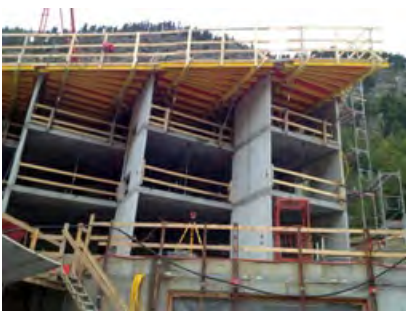
2 Tage später, am 12. Oktober sah es dann so aus, und es fehlte noch ein Geschoss.
