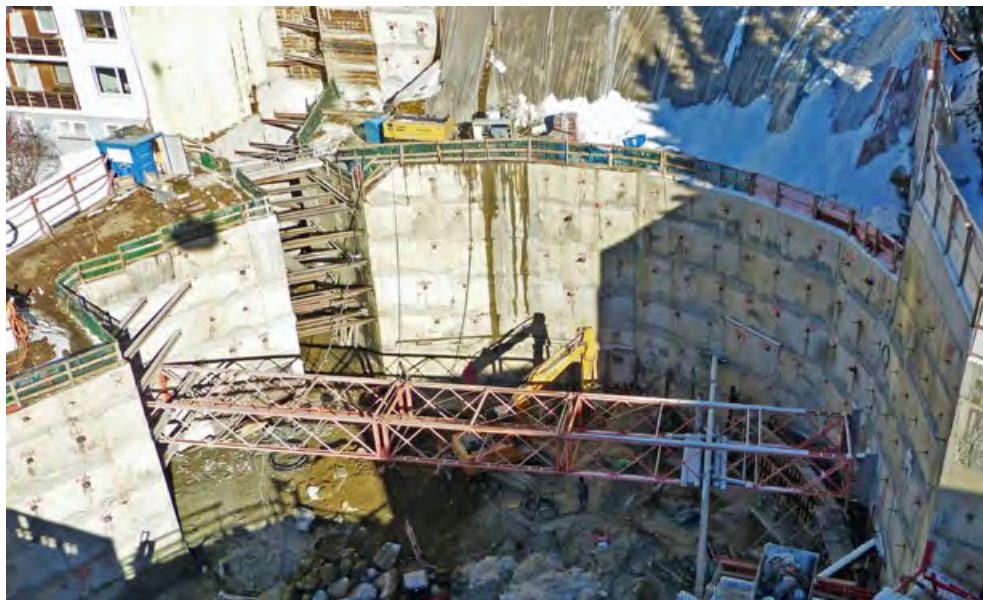
Ungeubliche Dimensionen: der rote Fachwerkträger ist 32m lang und der Raupenbagger darunter 24 Tonnen schwer.
