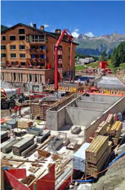
Endlich konnte man richtig zügig arbeiten
