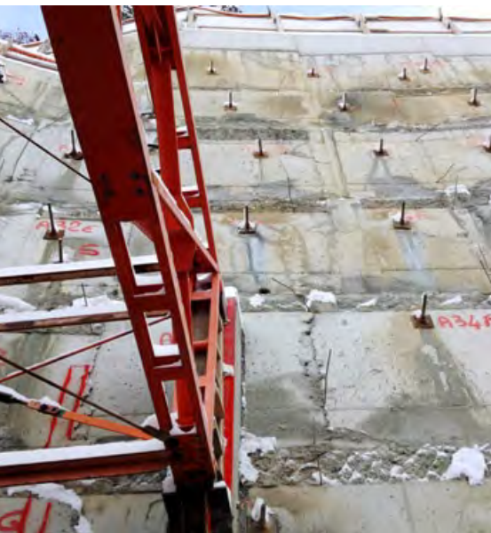
Eindrückliche Höhe der Ankerwand
