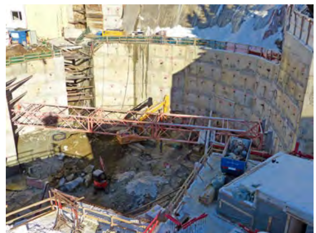
Zur zusätzlichen Sicherheit wurde ein Fachwerkträger eingebaut
