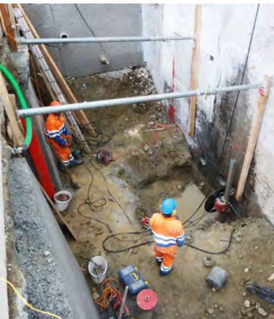
Die Verbindungstüre ins bestehende Haus wird gefräst
