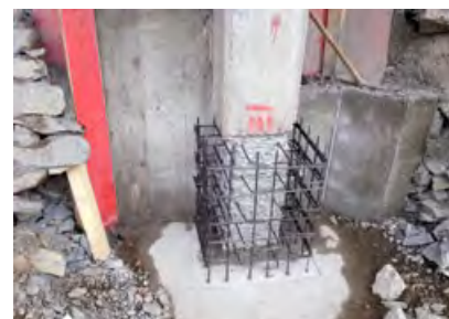
Die bestehenden Pfeilerfundationen wurden verstärkt . . .
