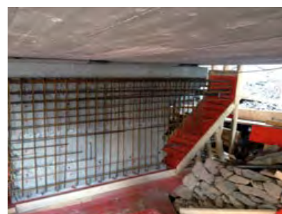
. . . ebenso die Pfeilerköpfe
