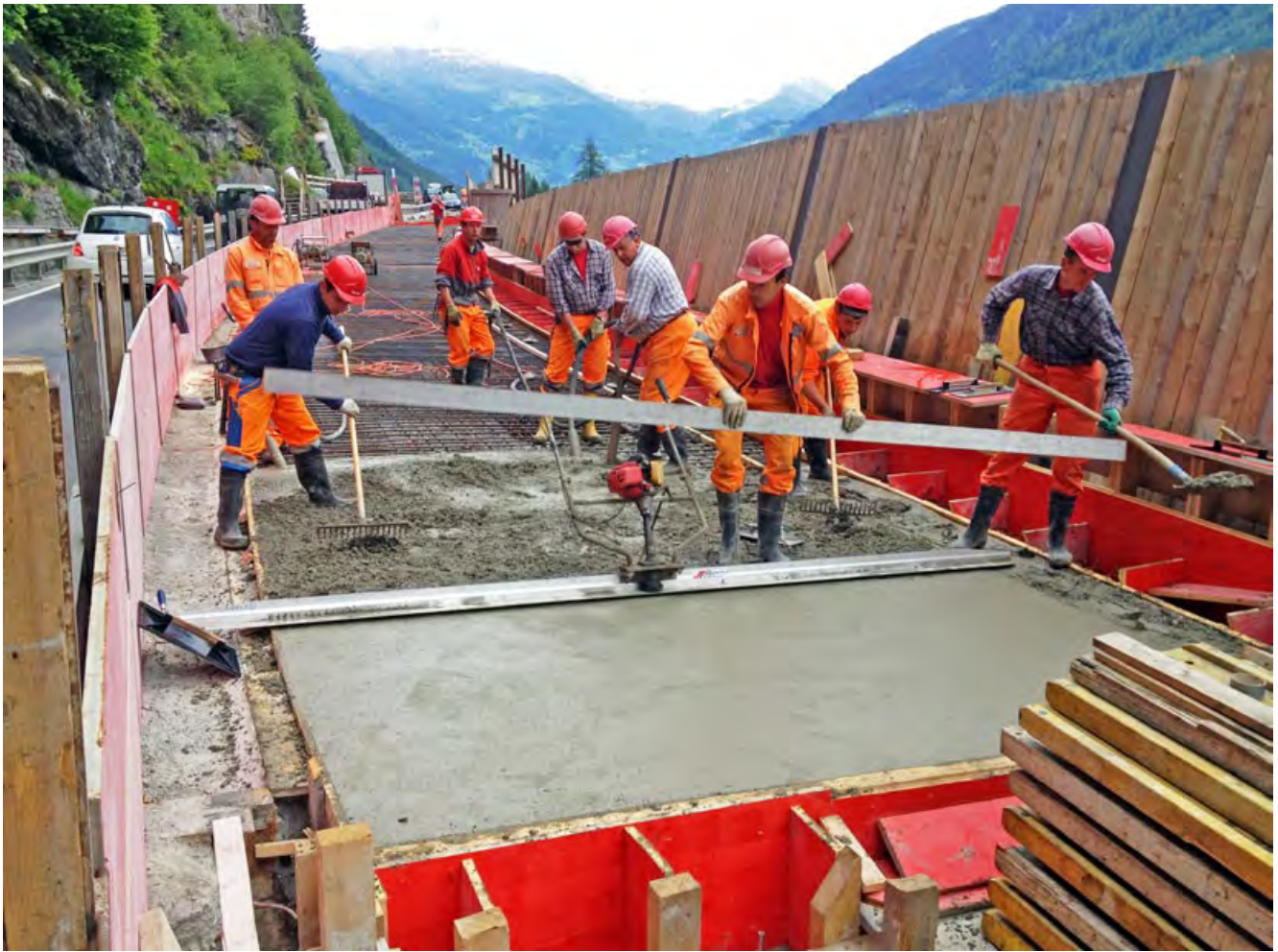
Betonieren der neuen Brückenplatte
