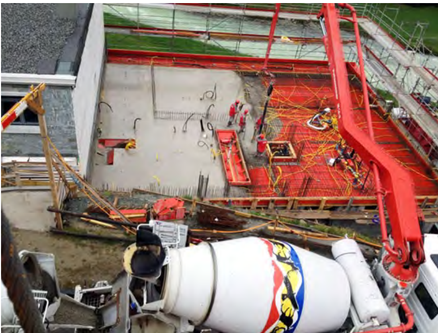
Betonieren der Decke über 1.0G
