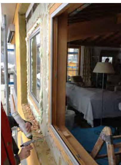
Die alten Fenster werden ausgebaut und die Neuen eingebaut
