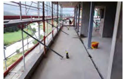
Der Rohbau ist fertig, es fehlen die Backstein Trennwände
