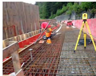
63 m lange Brückenplatte bereit zum Betonieren
