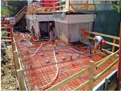
Zum Teil herrschten für die Familie schwierige Zugangsverhältnisse. Die letzte Decke auf welcher Parkplätze, Vorplatz und Eingangsbereich erstellt wurden.
