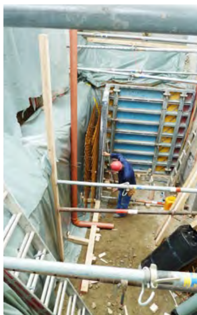
Ein zusätzlicher Raum entsteht
