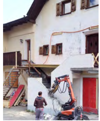
Rückbau Aussentreppe durch Bruno Manzo mittels Abbauroboter
