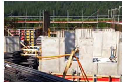
Alle tragenden Wände wurden in Beton ausgeführt, Wandschalungsarbeiten
