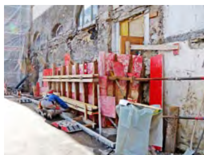
Eine neue Aussentreppe entsteht
