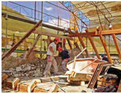
Das Dachgeschoss wird abgebrochen
