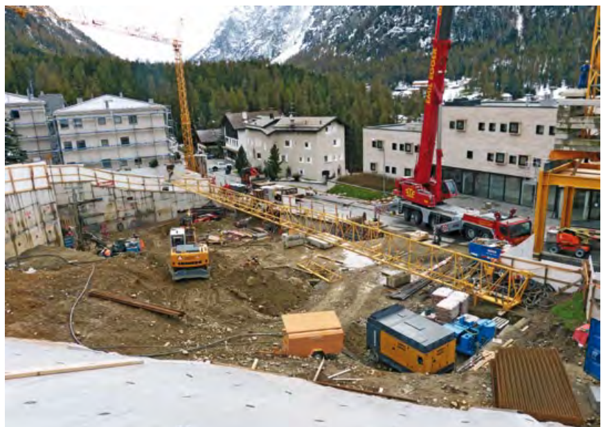
Für die Kranmontage wurde die Via da la Staziun gesperrt
