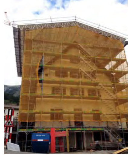
Erstelltes Notdach über der Baustelle
