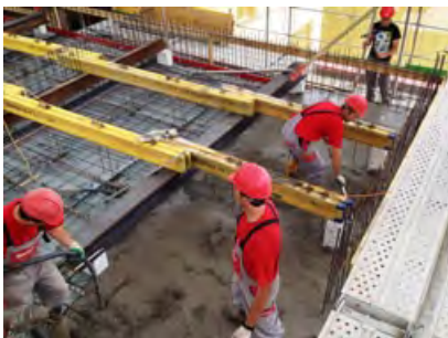
Beton einbringen über Holzbalkenlage
