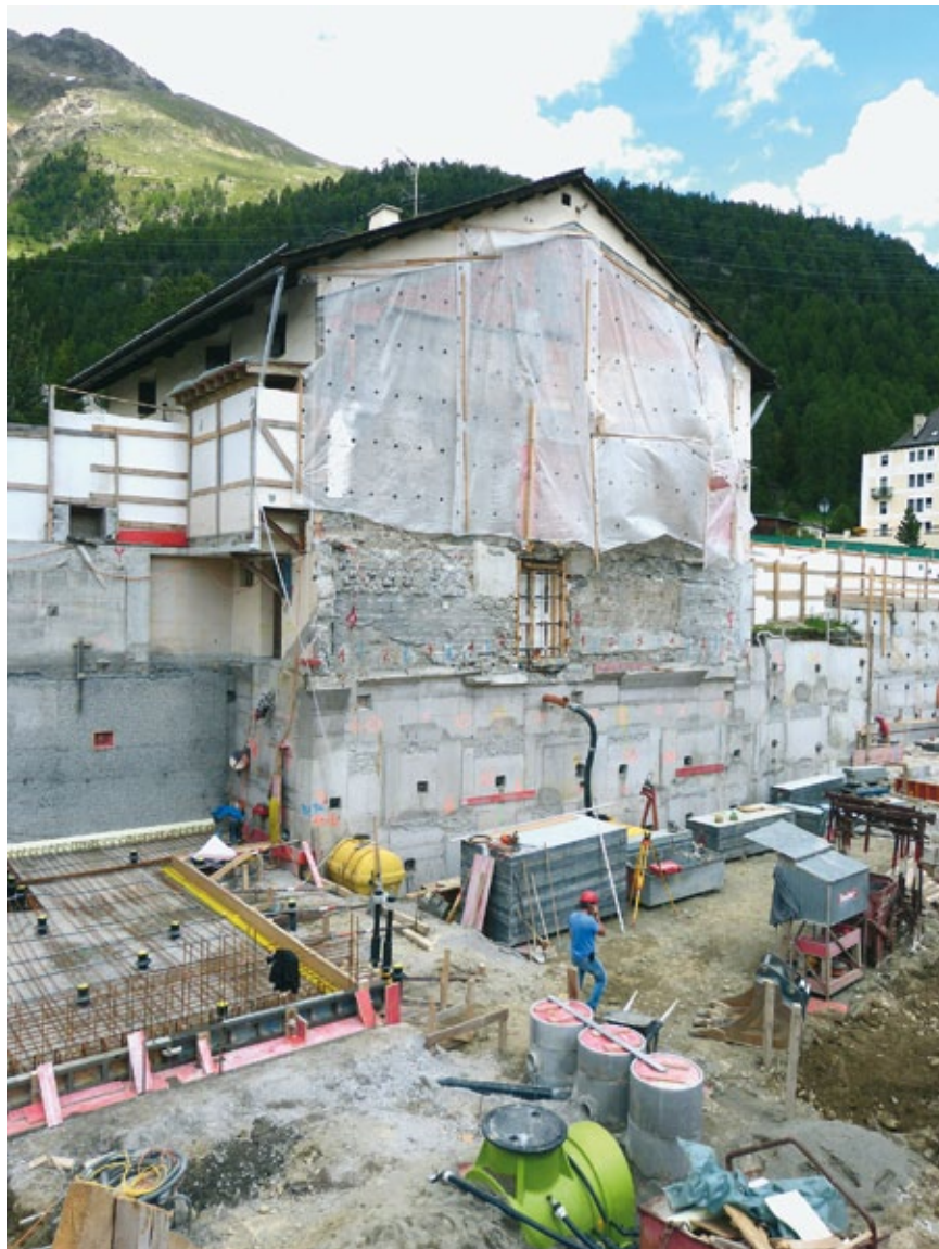
Das bestehende Gebäude wurde fünf Meter hoch unterfangen
