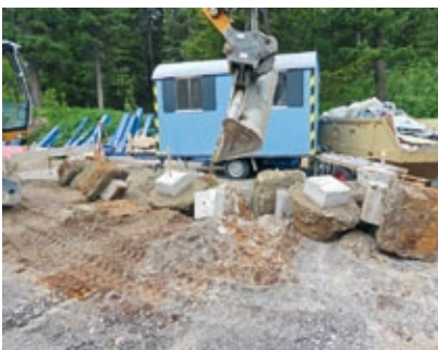
Abbruch der alten Betonfundamente
