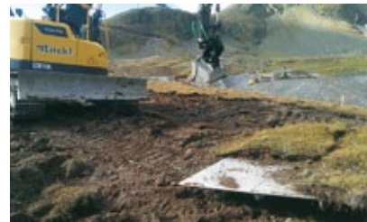
So wurden die Grasziegel an einem Ort abgetragen und am neuen Damm wieder verlegt.
