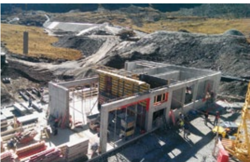
Die Wände Erdgeschoss wiesen ebenfalls viele Öffnungen auf, was die Arbeiten anspruchsvoller machte
