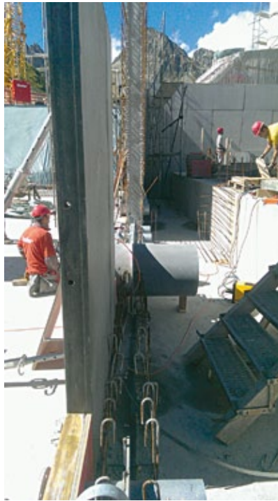
Die verschiedenen Rohreinlagen erschwerten die Schalarbeiten
