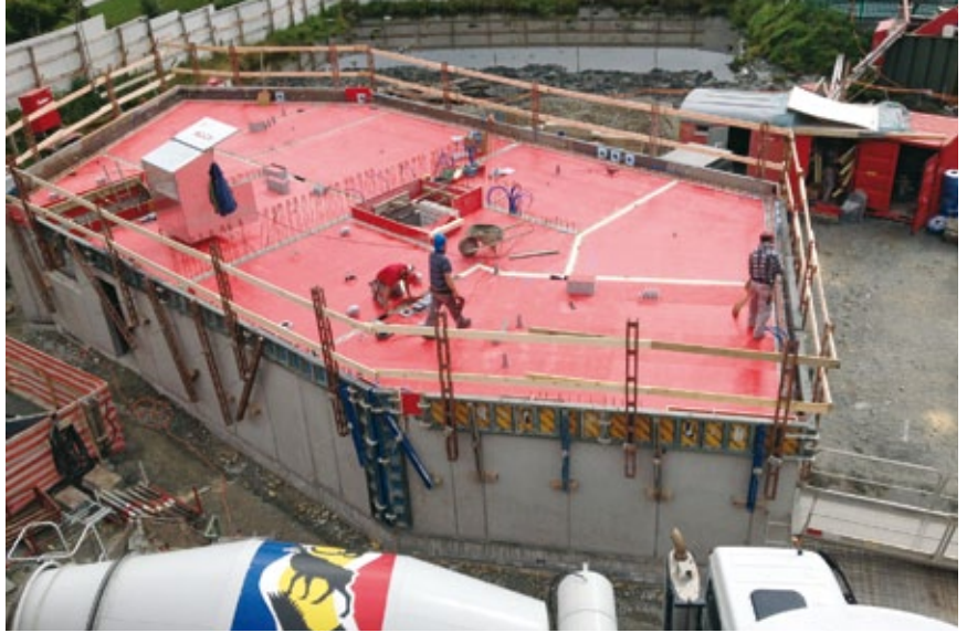
Deckenschalung Untergeschoss
