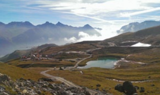
Links die Pumpstation, vorne der bestehende Lej Alv und im Hintergrund ein Teil des neuen Naturspeichersees.
