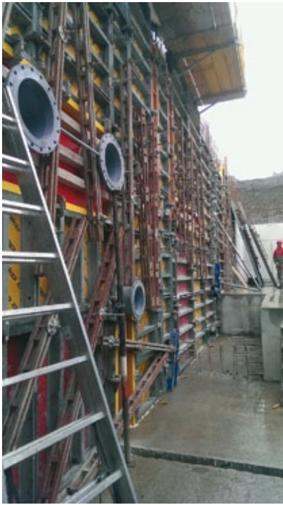
Die verschiedenen Rohreinlagen erschwerten die Schalarbeiten
