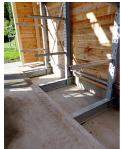
Stahlträger der neuen Lagerhalle
