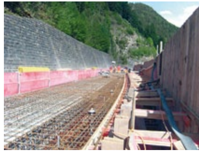
Betoniert wurde aber alles zusammen mit der Fahrbahnplatte. Betonieretappen bedeuteten jeweils Grosskampftage. Die Brückenoberfläche gleicht einem Industrieboden. Die Toleranz beträgt plus minus 1 cm!
