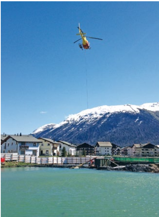
Einrichten Tauchpumpen in Pumpensümpfe mittels Helikopter
