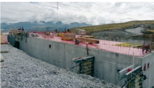
Decke über Untergeschoss
