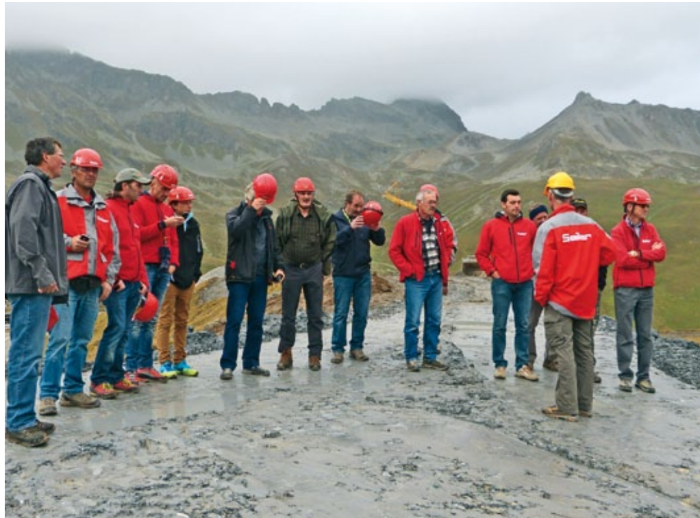
Mit den Polieren führten wir vorgängig eine Besichtigung der Baustelle Lej Alv durch
