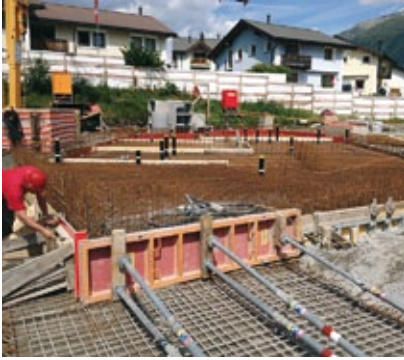
Bodenplatte bereit zum Betonieren
