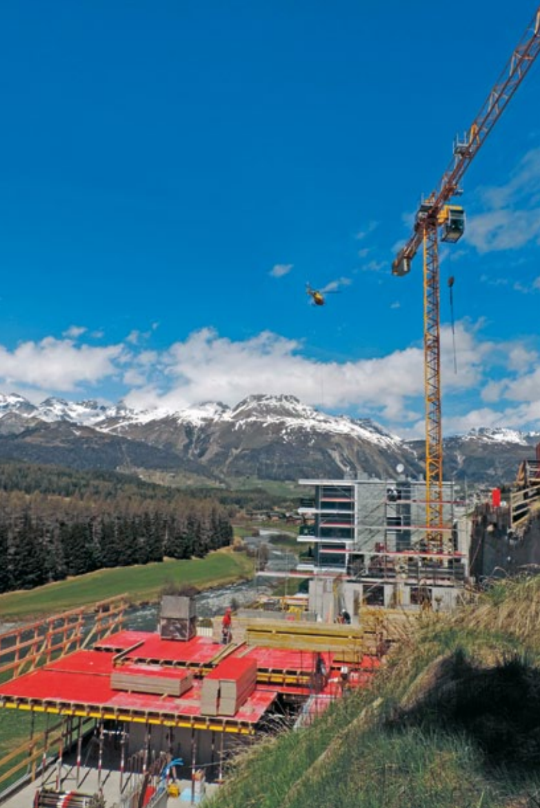
Kranunterstützung durch einen Helikopter bei Schalungsarbeiten
