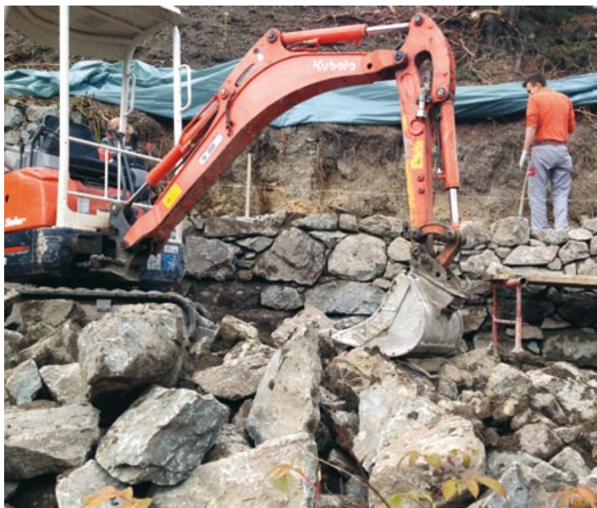
Aufbau des Trockensteinmauerwerks
