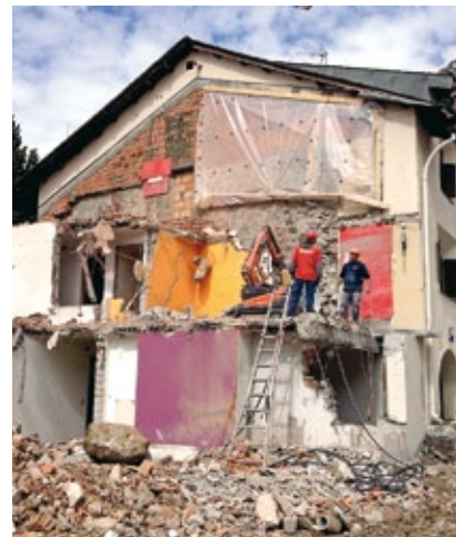
Der Abbruch wurde zum Teil mittels Abbruchroboter vorgenommen ...
