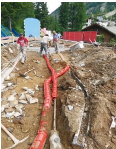
Bestehende Leitungen mussten zum Teil verlegt werden
