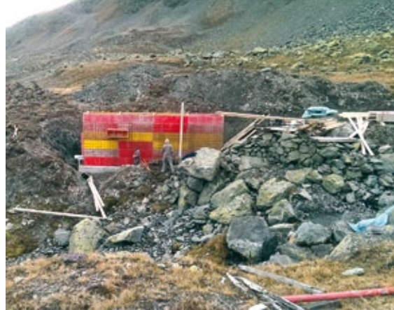
Hier im Gelände entsteht der Sandfang Schlattain
