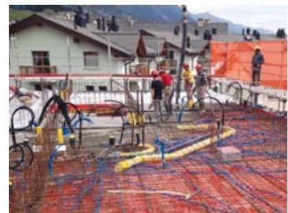
... und schon wird wieder betoniert
