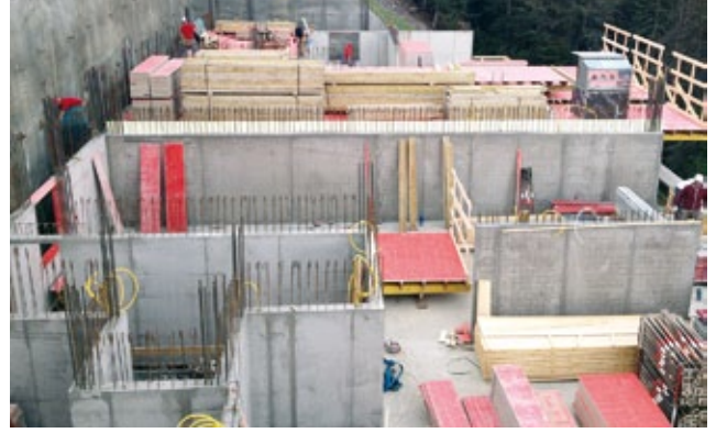
Haus 3B: Deckenschalung EG Haus 3A: Wände EG
