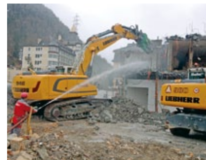
... jedoch die groben Sachen mit Raupenbagger und Abbruchzange
