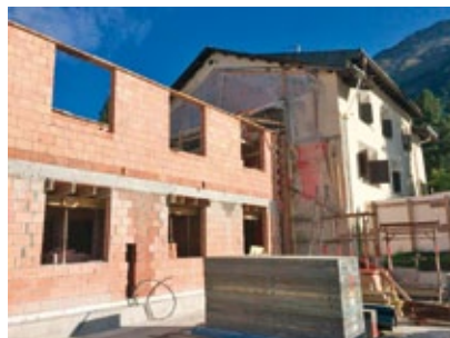
Die beiden Gebäude wurden wieder zusammengebaut
