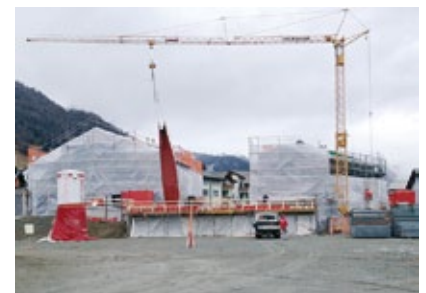
Haus A und B wintersicher eingepackt
