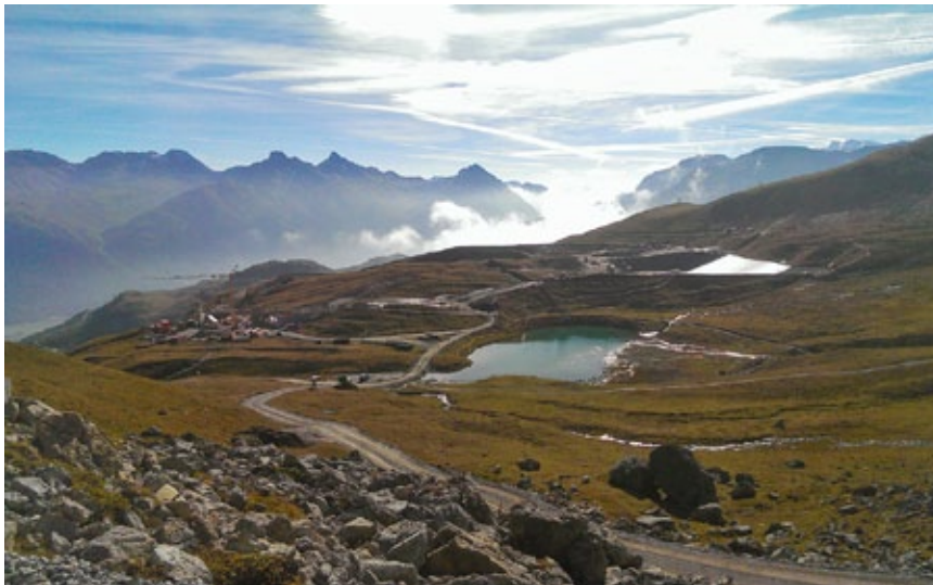
Pumpstation und Naturspeichersee Lej Alv
