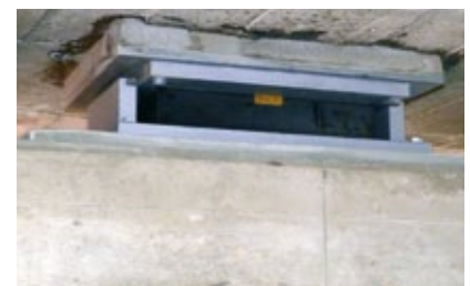
Die neu eingebauten Fahrbahnlager
