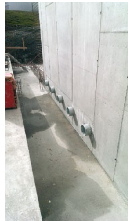
Die Betonqualität könnte nicht besser sein
