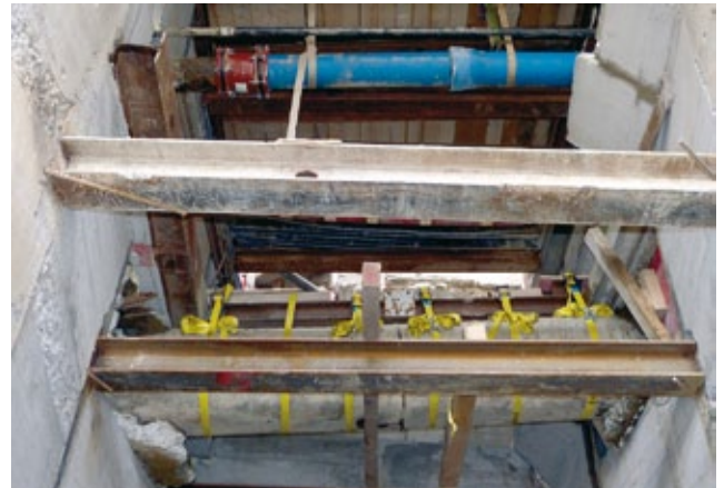
Links: Auf dem Verbindungsgang zum Sporthotel. Die Stahlträger wurden laufend ausgebaut. Rechts: Hier stehen wir zehn Höhenmeter unter der Via Maistra, die blaue Leitung ist die Wasserleitung und die grosse aufgehängte darunter, die Kanalisation.
