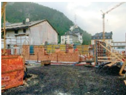
Das Untergeschoss wurde bereits hinterfüllt, nun entsteht das Erdgeschoss
