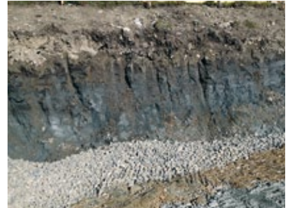
Ansicht des gewachsenen Terrains mit nicht tragfähigen Schwemmlagerungen
