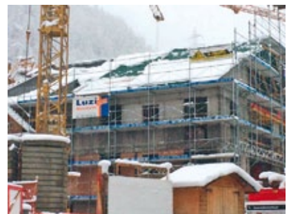
Nach dem Aufrichten und Abdichten
