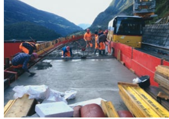
Betoniert wurde aber alles zusammen mit der Fahrbahnplatte. Betonieretappen bedeuteten jeweils Grosskampftage. Die Brückenoberfläche gleicht einem Industrieboden. Die Toleranz beträgt plus minus 1 cm!
