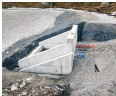
Über dieses Einlaufbauwerk wird der See 2015 gefüllt
