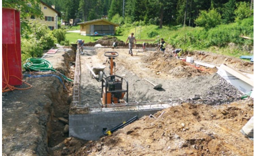
Frostriegel bereits eingefüllt
