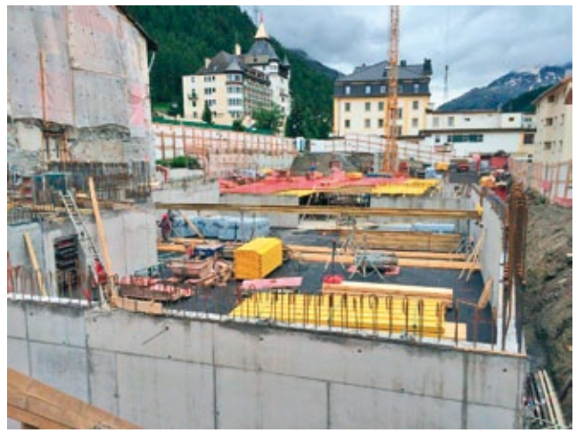
Die geräumige Tiefgarage für beide Gebäude
