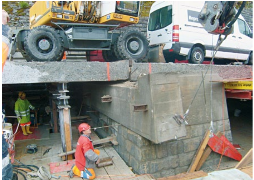
Mittels Seilsägen sägten wir das Betonaufleger unter den Fahrbahnübergängen frei. Mit dem Pneubagger wurde das ganze Stück hervorgezogen.
