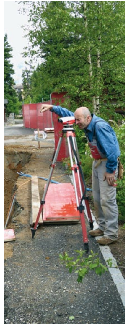
Polier Lino Besseghini beim Nivellieren
