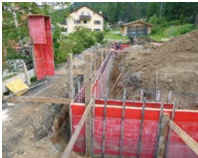
Frostriegel bereit zum Betonieren
