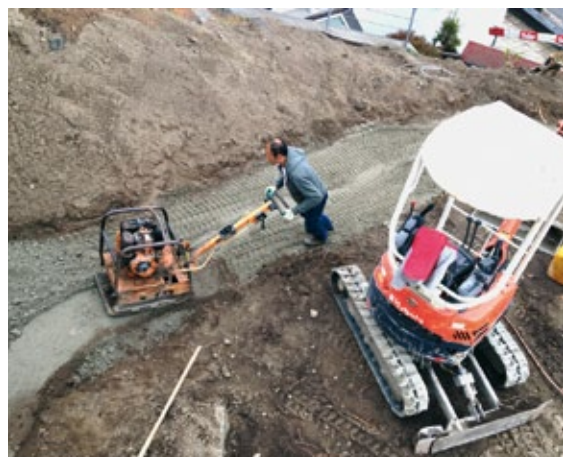
Bruno Manzo ist am verdichten der Fundationschicht
