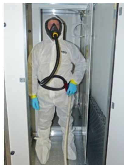
Marcello Della Bella mit voller Schutzausrüstung und Atemmaske in einer der Schleusen unserer Musterbaustelle
