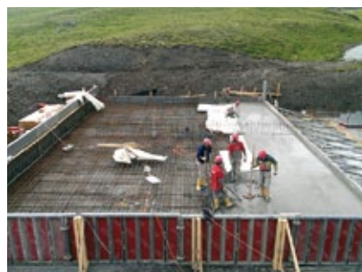
Zweite Betonage der Bodenplatte
