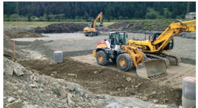
Einbau Koffering 2. Tragschicht
