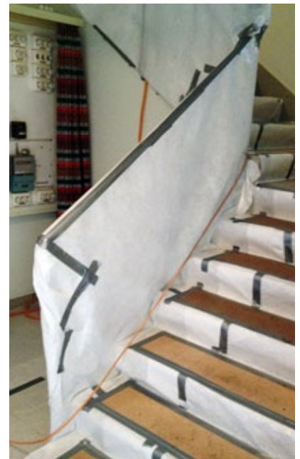
Baustelleneinrichtung und allgemeine Abdeckarbeiten
