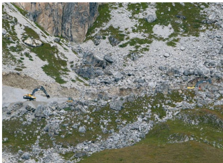
Die Materialaufbereitung vor Ort ist von unten praktisch nicht einsehbar
