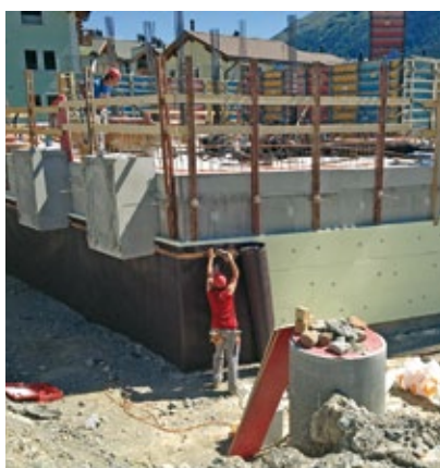
Perimeterdämmung und Trennschicht
