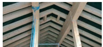
Aufgerichteter Dachstock
