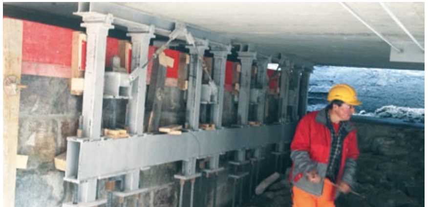
Die Brücke musste angehoben werden um die Pfeilerköpfe zu erneuern
