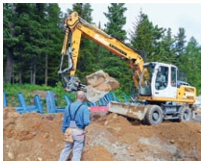
Einer der vielen Findlinge, die entfernt werden mussten
