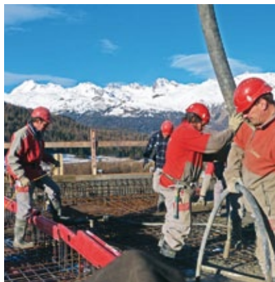
Die letzte Betonage einer Decke im Jahr 2014. Man kann kaum glauben, dass diese Aufnahme am 12.12 entstanden ist.
