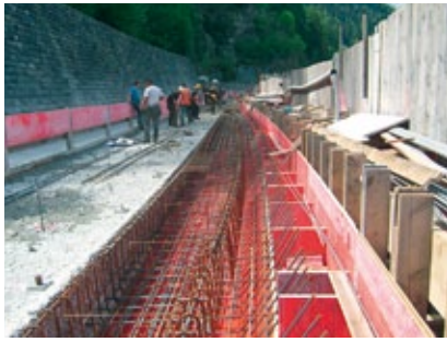
Die Fahrbahnverbreiterung ist armiert
