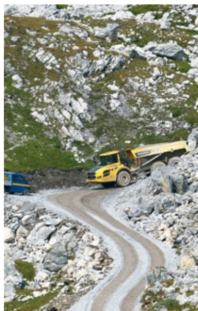
Drei Dumper waren pausenlos im Einsatz
