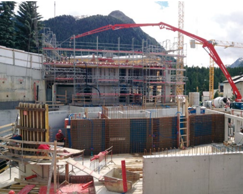
Auf der Baustelle wurde zur Entlastung des Krans fast alles mit der Betonpumpe betoniert. Bild rechts: Zuoberst sieht man die Via Maistra, darunter den Durchgang ins Sporthotel und zuunterst die Verbindungsgänge zum noch zu erstellenden Treppenhaus mit Lift.
