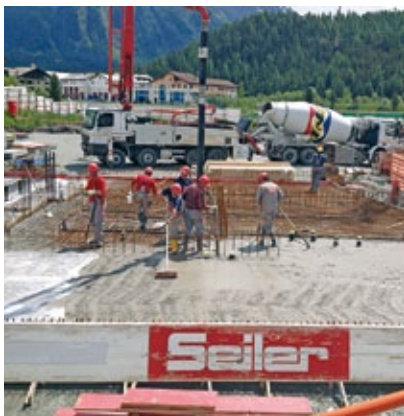
Betonage der Bodenplatte mit Nachbehandlung
