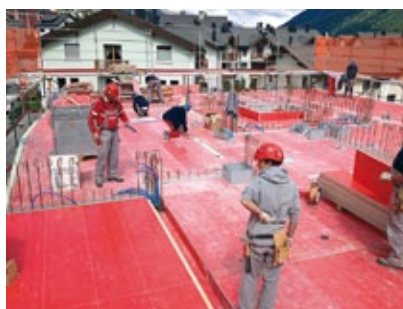
Letzte Einmessarbeiten vor dem Eisenlegen
