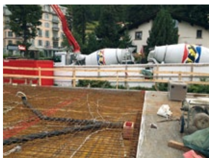
Betonage letzter Decke
