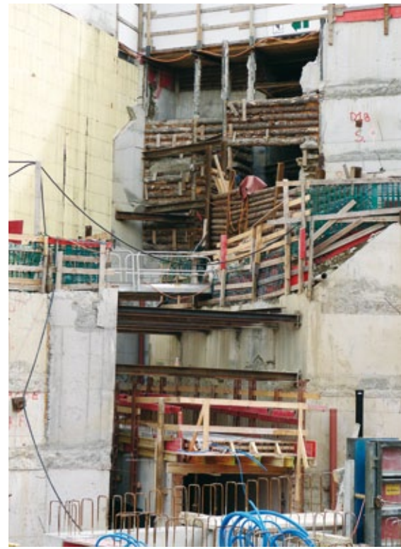
Auf der Baustelle wurde zur Entlastung des Krans fast alles mit der Betonpumpe betoniert. Bild rechts: Zuoberst sieht man die Via Maistra, darunter den Durchgang ins Sporthotel und zuunterst die Verbindungsgänge zum noch zu erstellenden Treppenhaus mit Lift.
