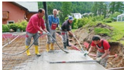
Betonieren der Bodenplatte
