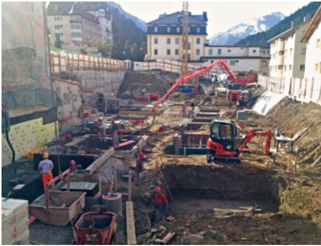
Die Fundationen der Tiefgarage erfolgten via Einzelfundationen
