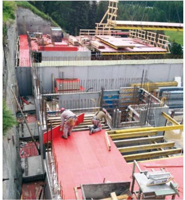
Umsetzen der Schalungstische
