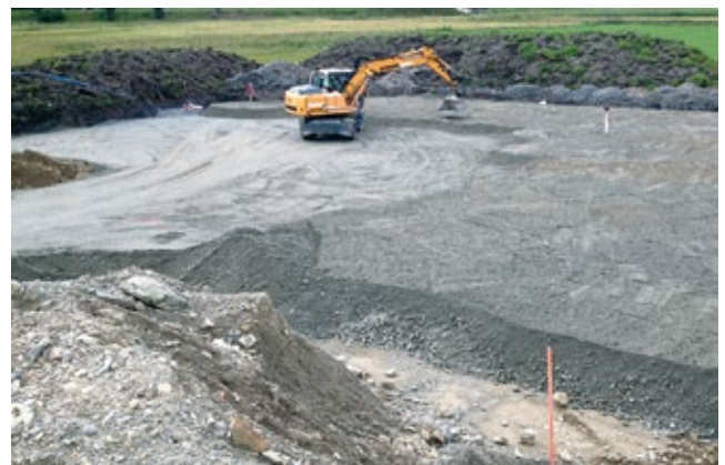
Einbau Koffering 3. und letzte Tragschicht
