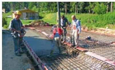
Betonieren der tieferen Bodenplatte
