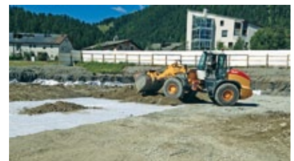
Einbau Foundation 1. Tragschicht
