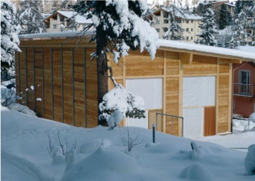
Die Fertige Lagerhalle im Winterkleid
