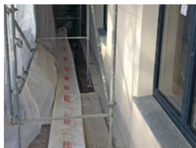
Fassade Fenstergewände und Dämmung mit Netzeinbettung
