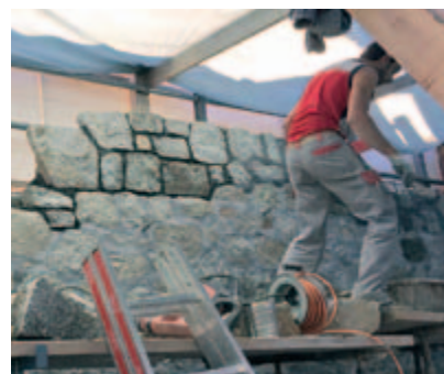
Als letztes erstellten wir noch einige Quadratmeter Bruchsteinmauer.
