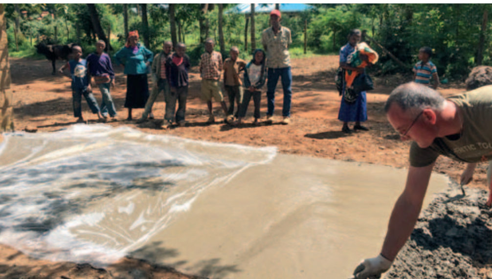
Bei allen Arbeiten waren uns Zuschauer gewiss.
