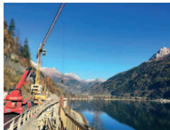
Das Schutzgerüst steht auch schon, so schön kann Bauen sein.
