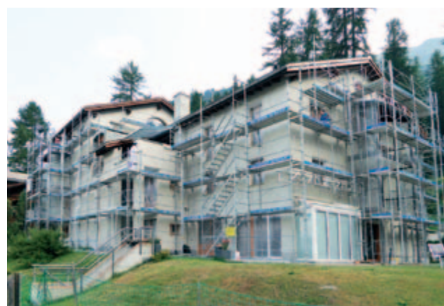
Fertig verputzte Chesa Pizzet, der Maler erledigt noch die letzten Finisharbeiten.
