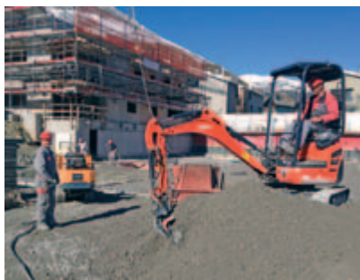
Nach dem Rohbau wurde noch ein Drittel der Einstellhalle erstellt.
