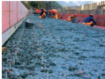
Die Verbindungen von der alten Fahrbahn zum neuen Überbeton wurde mit 3580 Verbundankern sicher gestellt.
