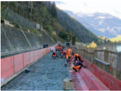
Die Schalung für die Fahrbahnverbreiterung und den Kordon ist erstellt.
