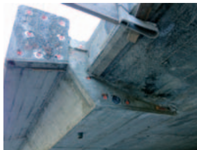
Ende der Etappe 2015. Hier werden wir 2016 wieder ansetzen. Gut ersichtlich ist, was wir genau machen, alte Fahrbahn mit Kordon abschneiden, Fahrbahnverbreiterung erstellen und im 2. Arbeitsgang Kordon anbetonieren.
