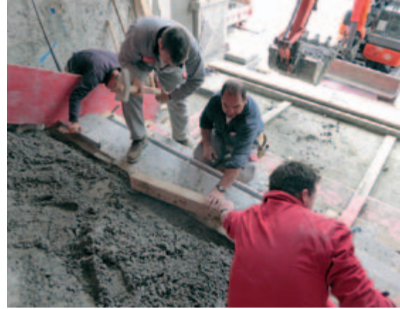
Die alte Treppe wird mit Ergänzungen wieder neu erstellt.
