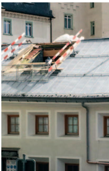
Einbau einer Dachlukarne.
