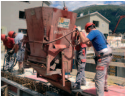
Sogar der Kranführer Cristian Illia hilft mit beim Betonieren (ausser rechts).
