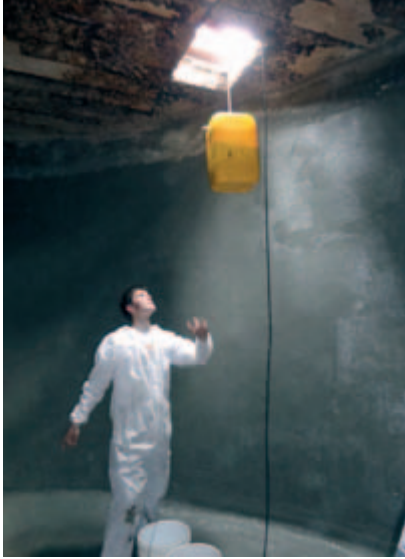
Das Reservoir war 3.5m hoch und der Zustieg erfolgte nur über diese kleine Lucke. Nachher beschichteten wir den ganzen Innenraum mit Sika Top Seal.
