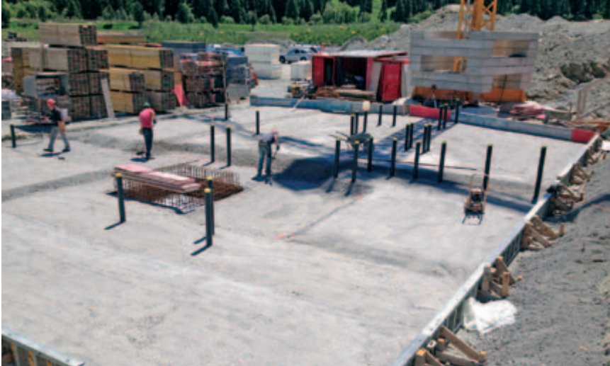
Der Magerbeton wurde eingebracht, alles bereit für die Armierung der Bodenplatte.
