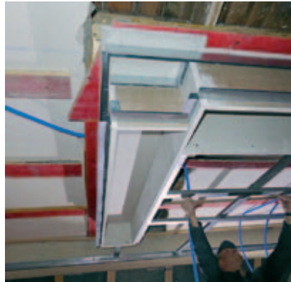
Die Aussparungen für den Feuervorhang.
