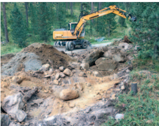
Die Arbeiten für den Installationsplatz haben begonnen.
