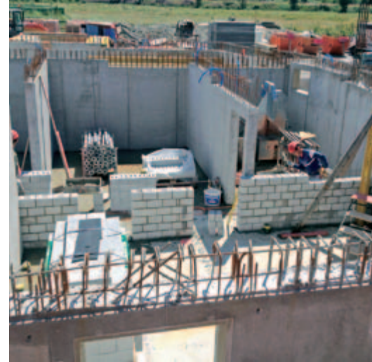
Das Kellergeschoss entsteht.
