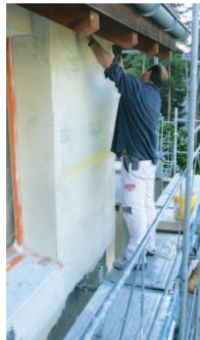
Der Mann der die ganze Sanierungsarbeit leitete, Antonio Martinho.
