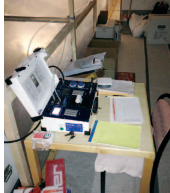
Das Unterdruckmessgerät mit zugeschaltetem Telealarm, nebst der effektiven Arbeit an vorderster Front braucht es noch viel administrative Arbeit, die vom Asbestexperten erledigt werden muss. (Notfallkonzept, Luftbilanzmessungen und Arbeitsplan).
