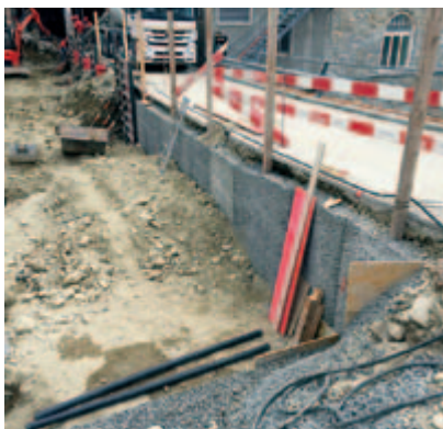
Bevor wir mit dem Aushub beginnen konnten, musste die Zufahrt zum Schlosshotel gesichert werden.
