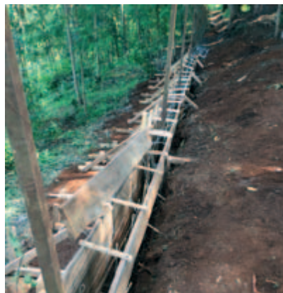
Foundation bereit zum Betonieren. Improvisation war gefragt. Nicht ganz so perfekt, aber Zweck erfüllt.
