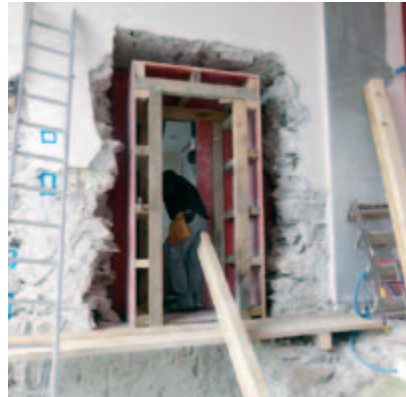
Durchbruch zum Lift.
