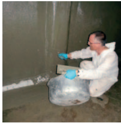
Das Reservoir war 3.5m hoch und der Zustieg erfolgte nur über diese kleine Lucke. Nachher beschichteten wir den ganzen Innenraum mit Sika Top Seal.
