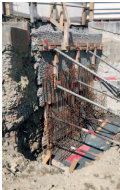
Nach Fertigstellung der Garage mussten wir noch einige Stützmauern bauen, unter anderem eine gegen die Via Maistra.
