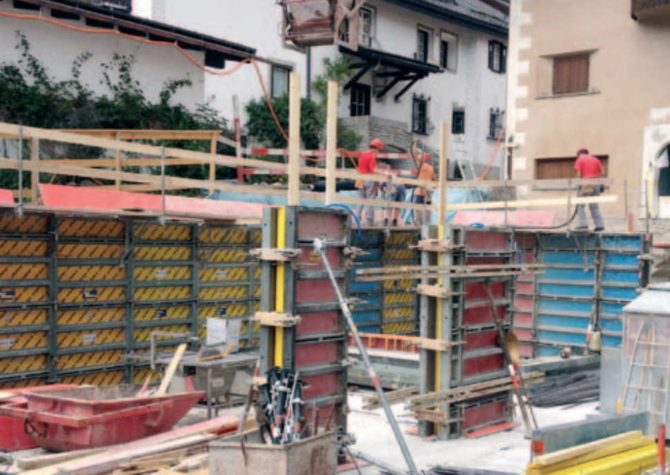
Unser Lehrling Daniel Cramerer aussen links konnte auf dieser „kleinen“ Baustelle viel profitieren.
