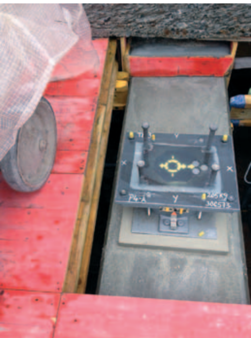
Eines der wenigen Fahrbahnlager, welches von oben eingebaut werden konnte.
