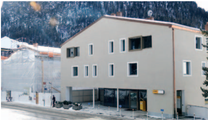
Die beiden neuen Mehrfamilienhäuser. Im Erdgeschoss ist rechts die Post eingemietet, links davon ist ein leerstehendes Ladenlokal.
