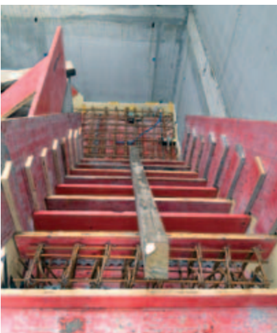
Gleichzeitig mit den Stockwerken wurde auch die Innentreppe hochgezogen.
