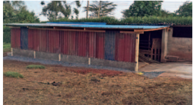
Die fertige Erweiterung des Kuhstalles.
