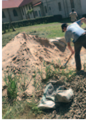
Kuhstallerweiterung: betonieren der Bodenplatte. Der Sand musste zuerst mit dem sehr groben Kies gemischt werden, nach kurzer Zeit gaben wir auf und kauften einen Betonmischer.
