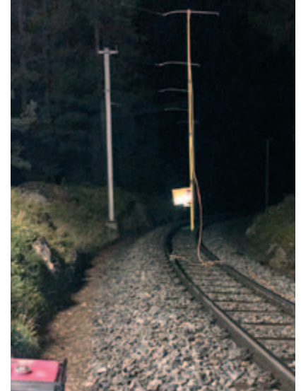
Wenn in der Nacht gearbeitet wurde, musste die Fahrleitung geerdet werden.
