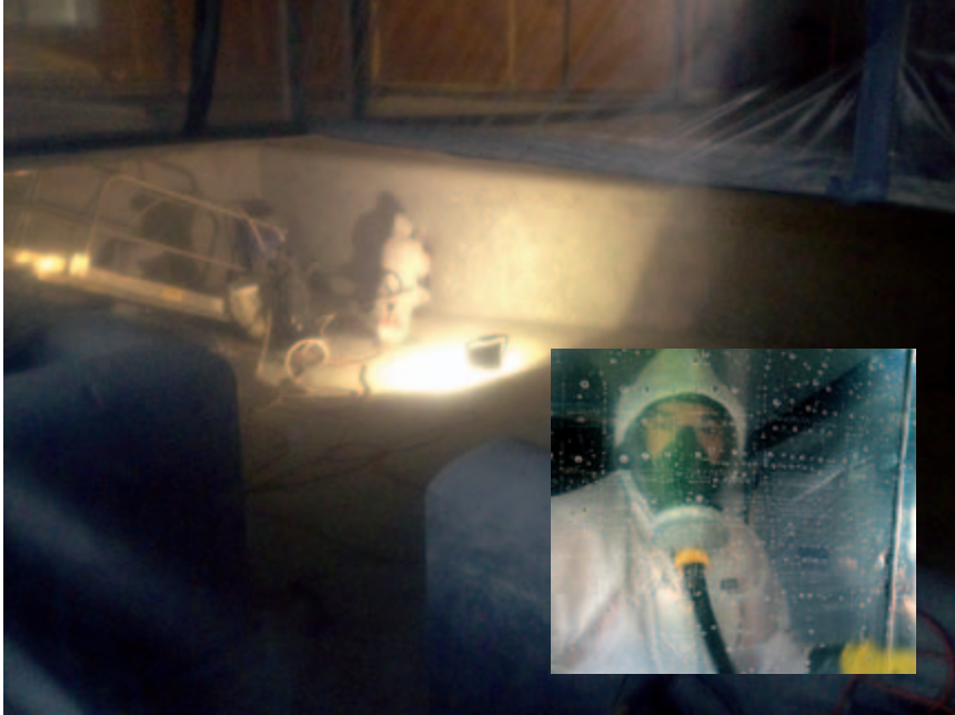
Von aussen durch den Plastik betrachtet, einer unserer Schadstoffsanierer beim Plättli abspitzen.
