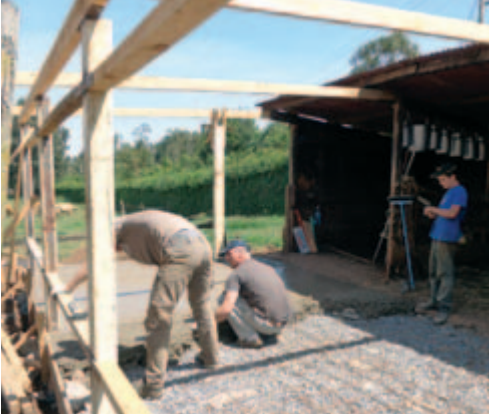
Kuhstallerweiterung: betonieren der Bodenplatte. Der Sand musste zuerst mit dem sehr groben Kies gemischt werden, nach kurzer Zeit gaben wir auf und kauften einen Betonmischer.
