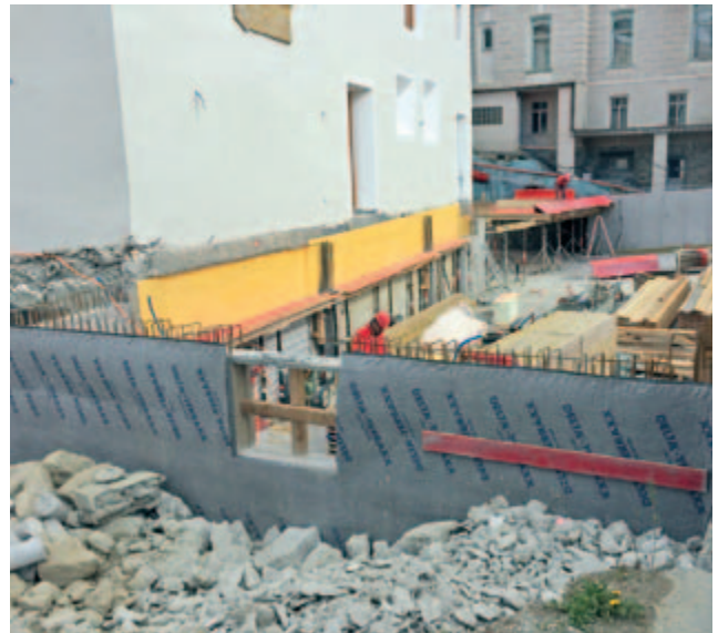
Bereit zum schalen der Decke.
