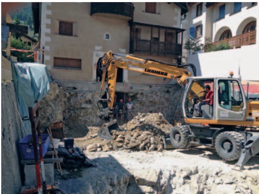
Ein grosser Teil der Aushubarbeiten befand sich im Fels.
