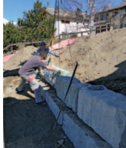
Andrea Vanini und Lino Besseghini versetzen die Steine cm genau.
