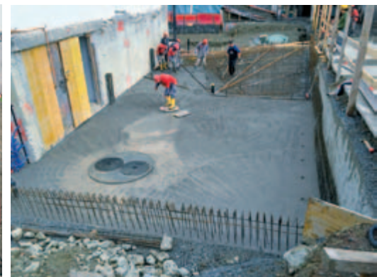
Etappenweises Vorgehen bei der Bodenplatte. Diverse Gefällsänderungen erschwerten das Betonieren, in der Mitte ein Hänny Pumpenschacht.
