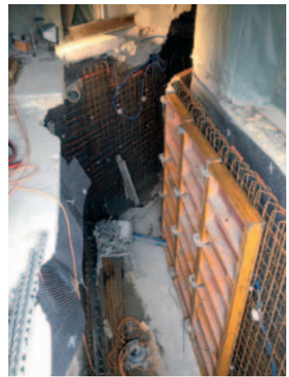
Einhäufiges Schalen der Wände des Verbindungsganges unter engsten Platzverhältnissen.
