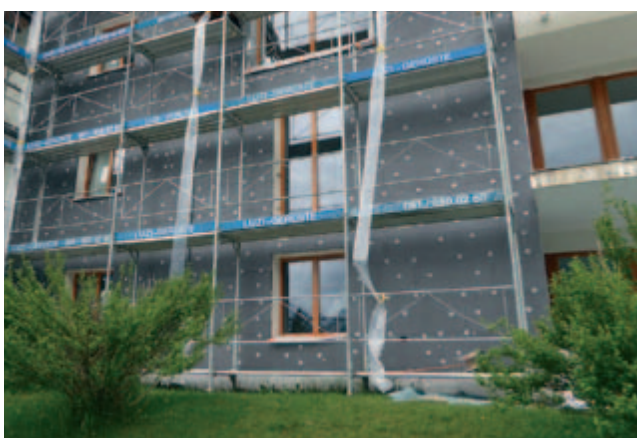
Anbringen der 4 cm Dämmplatten mit Schlagdübel.
