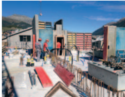
Gut ersichtlich sind die schrägen Giebelwände, diese mussten cm genau stimmen, da die Dachkonstruktion aus fertig isolierten Elementen bestand.
