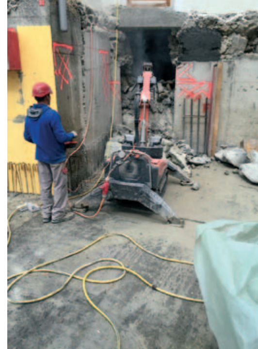
Den neuen Durchgang zum Gebäude spitzten wir mit unserem Abbruchroboter.
