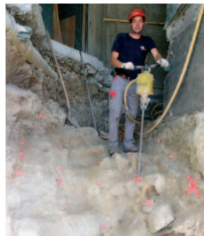
Polier G. Agosti erstellte die Bohrlöcher.
