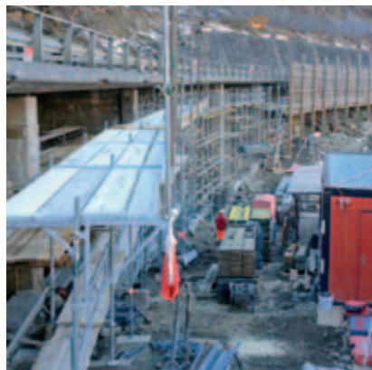
Das Staxo Traggerüst wird montiert, im Hintergrund das Schutzgerüst zur RhB Linie.
