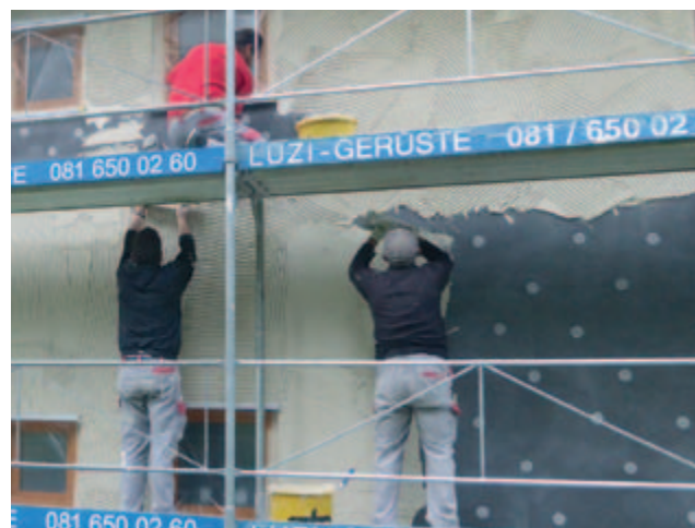
Einbetten des Armierungsgewebes.
