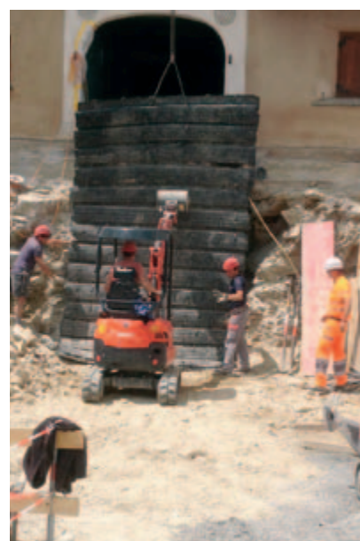
Bei den Sprengungen wurde jeweils alles mit Abdeckmatten geschützt.
