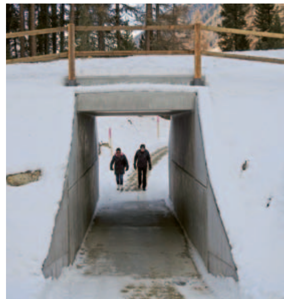
Die fertige Unterführung.
