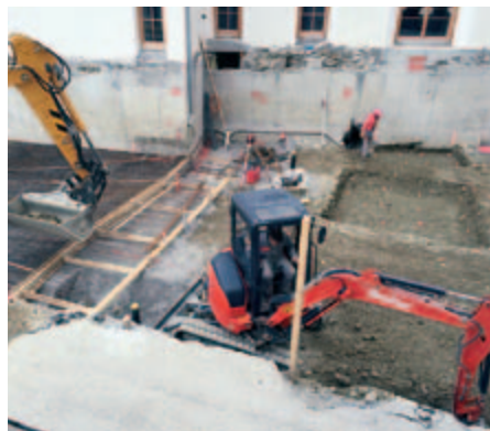
Etappenweises Vorgehen bei der Bodenplatte. Diverse Gefällsänderungen erschwerten das Betonieren, in der Mitte ein Hänny Pumpenschacht.
