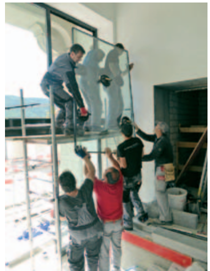
Für das Versetzen der Glasscheiben brauchte es jedermann.
