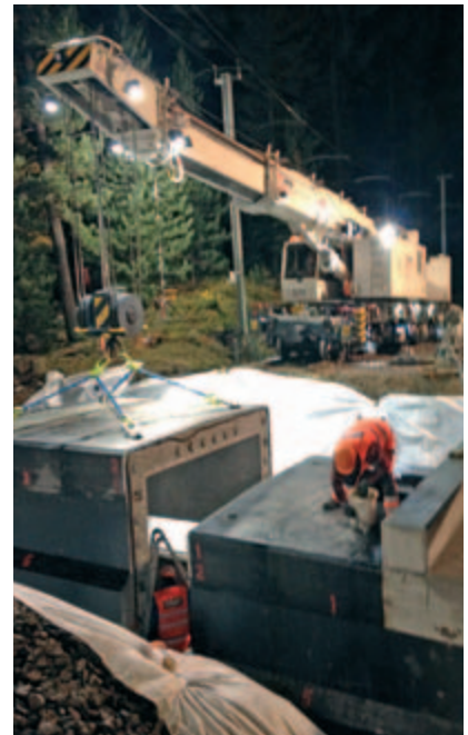
Das Versetzen übernahm der Schienenkran.
