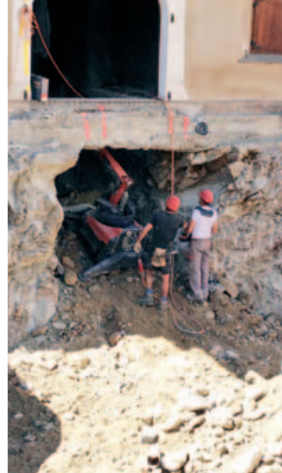
Auch unser Abbruchroboter kam beim Verbindungsgang zum Einsatz.
