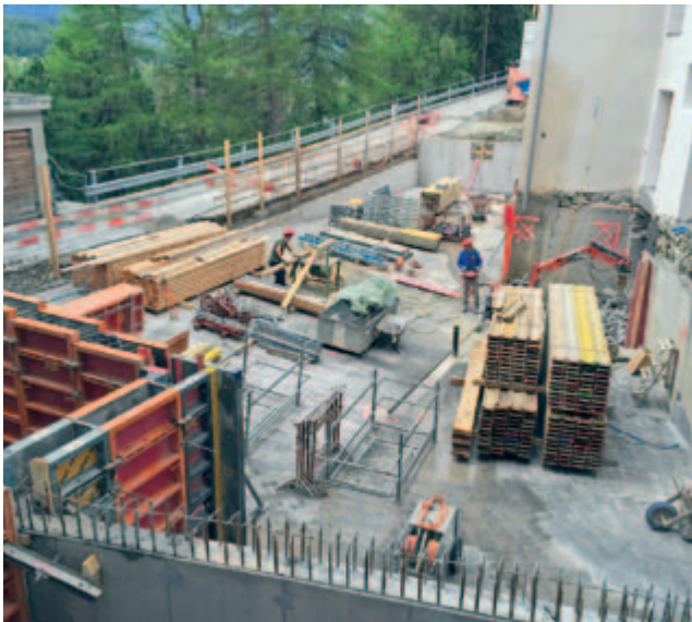
Einige Wände mussten einhäuptig und noch in Sicht ausgeführt werden.
