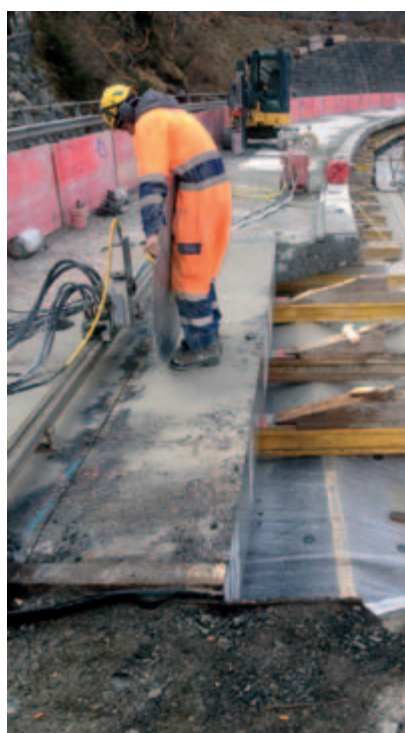
Abtrennen der zu ersetzenden Fahrbahn und Kordon.
