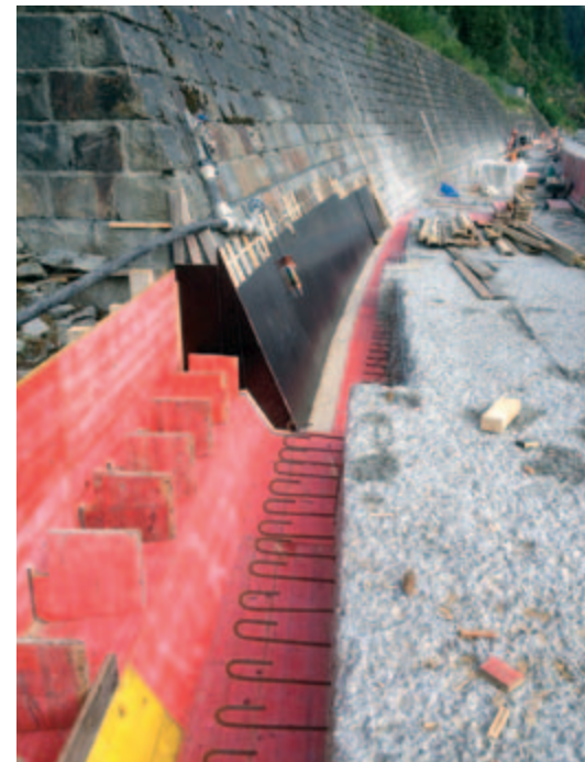
Enge Platzverhältnisse haben unkonventionelle Schalungsmethoden zur Folge.
