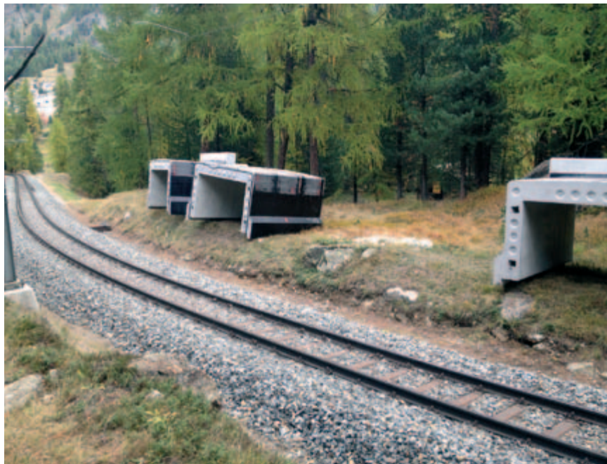
Die Elemente der Unterführung liegen bereit.
