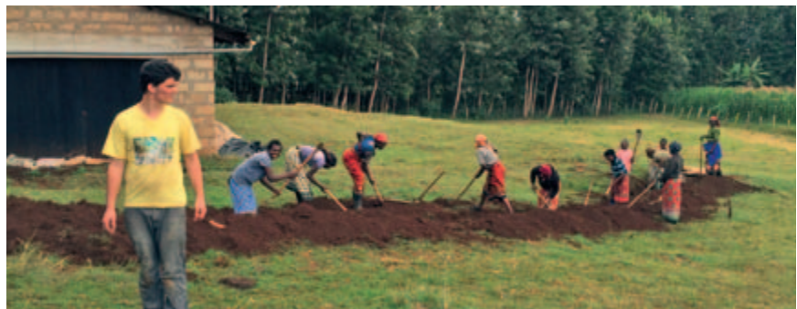
Für den Aushub des 3.5m tiefen Grabens waren 11 Frauen zuständig.
