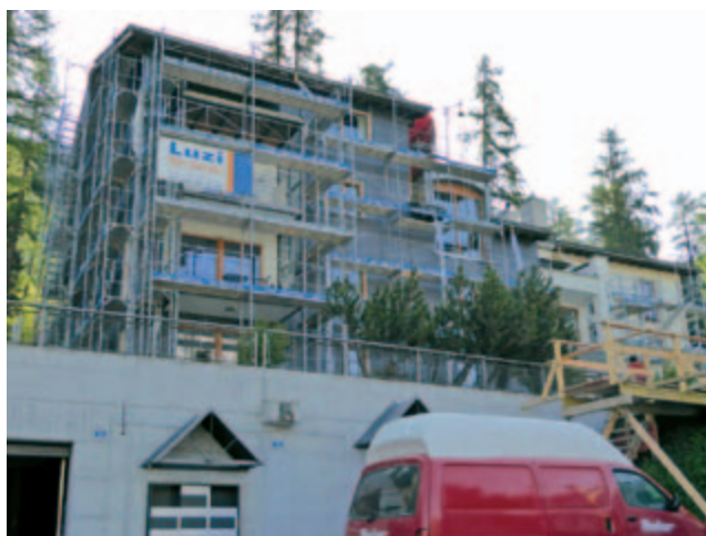
Eingerüstete Chesa Pizzet, Fassade isoliert, es fehlen noch die Schlagdübel.
