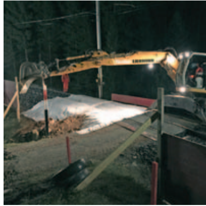
Für das Queren des Geleises mit dem Rau- enbagger wurde eine Rampe geschüttet.
