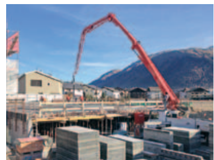
19. November, letzte Betonage im 2015. Decke über die Einstellhalle.
