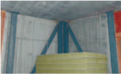
Auf solchen Stahlstützen wurden die Decken abgefangen, da sie nicht direkt mit der Aussenhülle verbunden sein durften.
