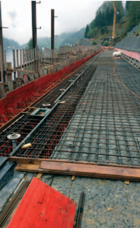
Alles bereit zum Betonieren.
