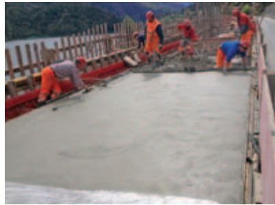
Betonieren heisst Grosskampftag für alle und dies meist ab 05.00 Uhr. Die Oberfläche ist so genau und weist keine 10 mm Abweichung auf.
