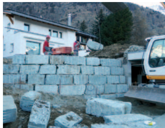
Stein um Stein geht's in die Höhe, wichtig dabei das kontinuierliche Verdichten hinter der Mauer. Die schöne Aussicht von der Chesa Tuja spiegelt sich in den verschiedenen Scheiben.
