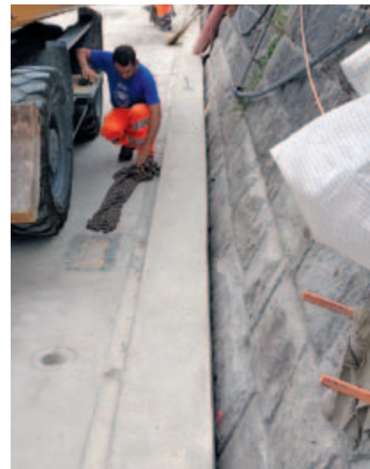
Fahrbahn und Kordon bergseitig fertig betoniert, zur bestehenden Stützmauer sind nur gerade 8 cm Abstand.
