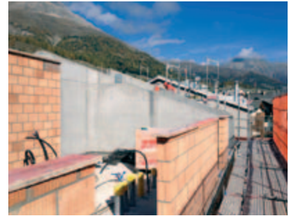
Gut ersichtlich sind die schrägen Giebelwände, diese mussten cm genau stimmen, da die Dachkonstruktion aus fertig isolierten Elementen bestand.
