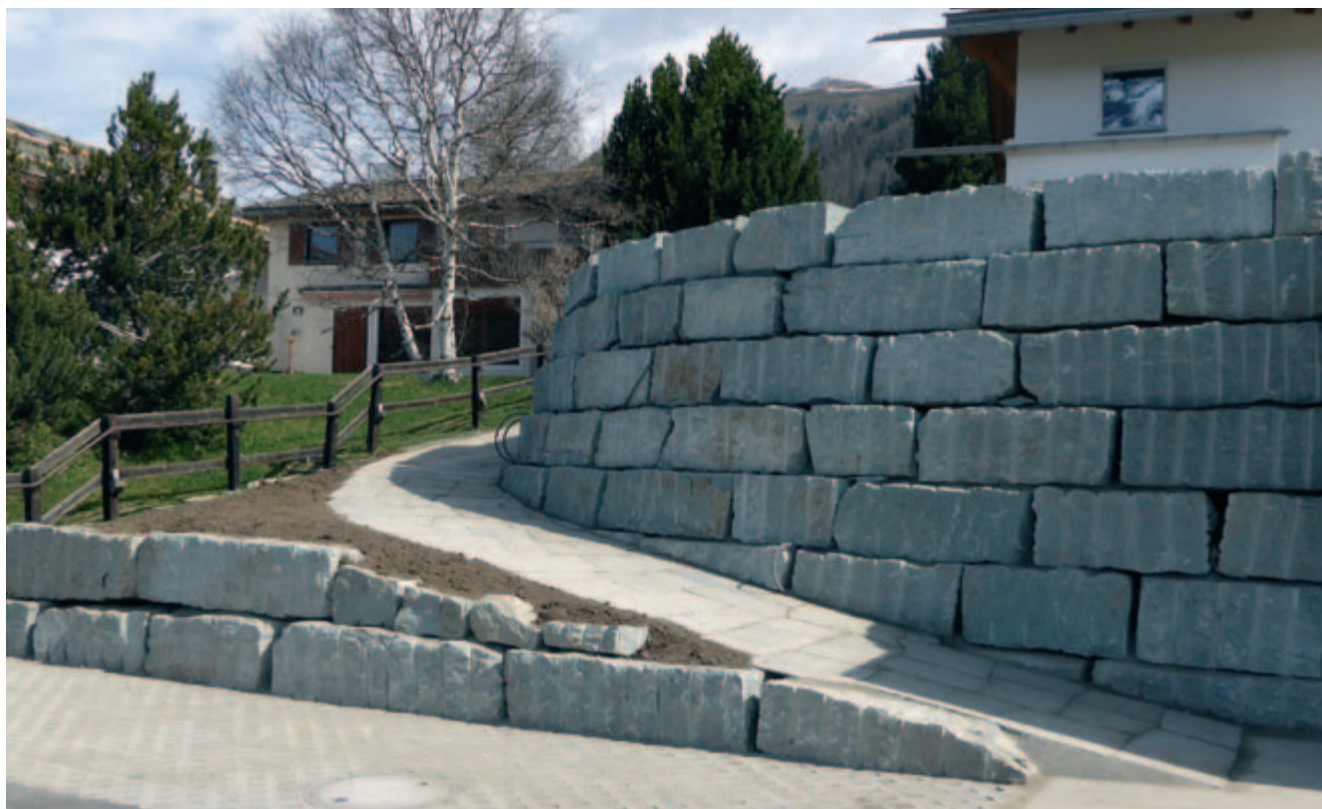
Stein um Stein geht's in die Höhe, wichtig dabei das kontinuierliche Verdichten hinter der Mauer. Die schöne Aussicht von der Chesa Tuja spiegelt sich in den verschiedenen Scheiben.
