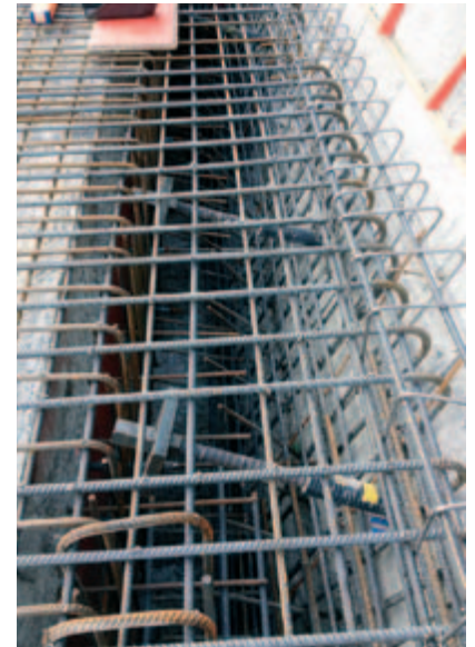
An 12 Stellen wurde die Fahrbahn mit ungespannten Ankern an die Stützmauer, bzw. an den dahinterliegenden Fels gebunden.
