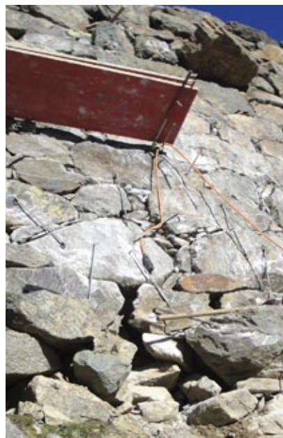
Nicht überall musste die Mauer abgetragen werden. Teils wurden alle Zwischenräume geschlossen und die Steine mit rostfreiem Stahl verbunden.
