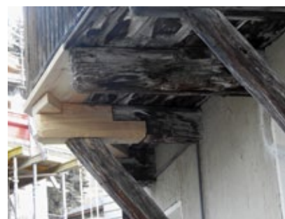
Der Holzbalkon der Chesa Martin wurde einige Male touchiert, aber nicht von der Firma Seiler.
