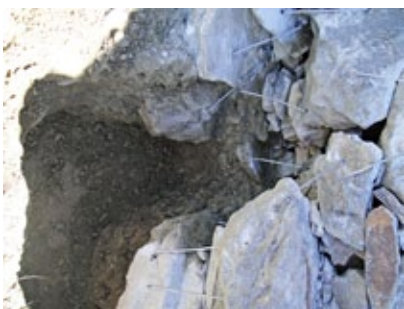
Örtlich eine Fundation unter die Mauer gegraben und stark ausarmiert nun fehlt nur noch der Beton und die örtliche Sanierung ist fertig.
