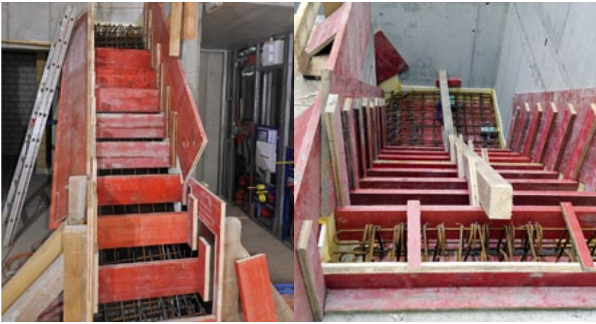
Saubere Schalungsarbeiten im Treppenbau.
