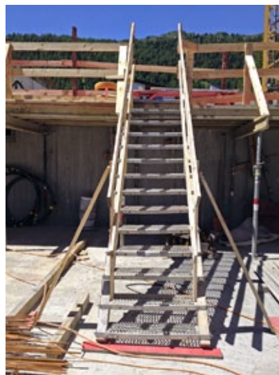
Da schlägt das Herz höher. Perfekter Baustellzugang nach SUVA Norm.
