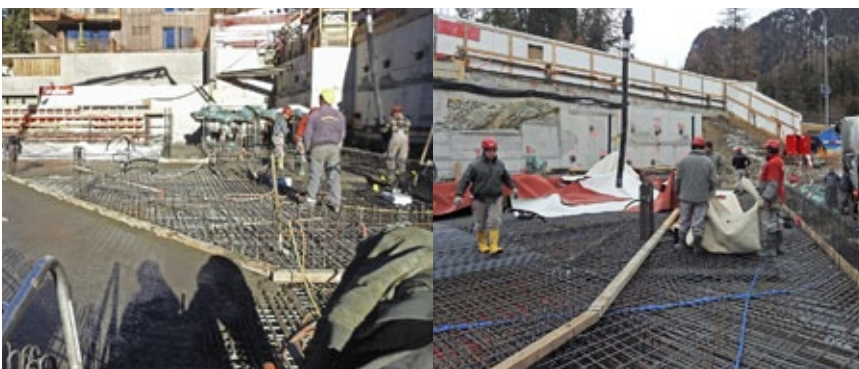
Am 17. Dezember 2015 betonierten wir die Decke über der Garage bei schönstem Wetter ohne Kälte und Schnee.
