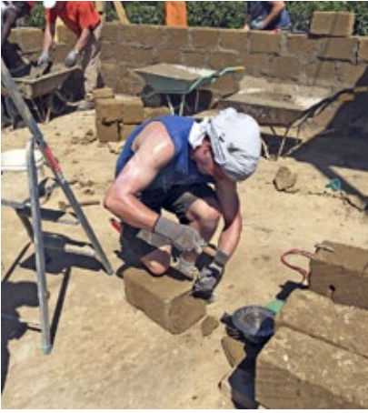
Die Mauersteine wiesen zum Teil Unterschiede von fünf Zentimeter auf. Wir spitzten die Differenzen weg und so ging es Schicht um Schicht aufwärts.
