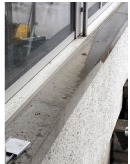
Die Winkel der Fensterbänke und aller Tüorzargen waren mit einer Lackierung behandelt, die Schwermetall und PCB enthält. Sie musste abgelagert werden. Ebenfalls das Fugendichtungsmaterial der Betonfensterbänke war PCB haltig und musste entfernt werden.
