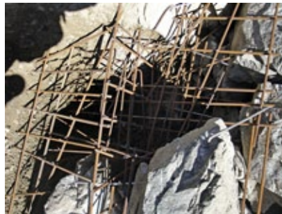
Örtlich eine Fundation unter die Mauer gegraben und stark ausarmiert nun fehlt nur noch der Beton und die örtliche Sanierung ist fertig.
