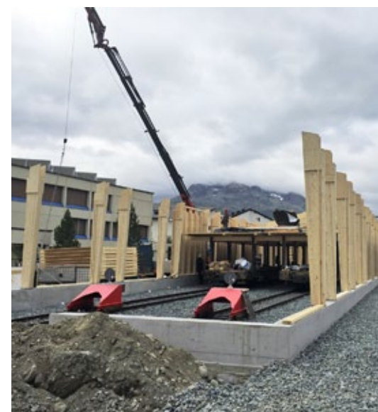
Aufrichten der Holzkonstruktion durch die Firma Freund.
