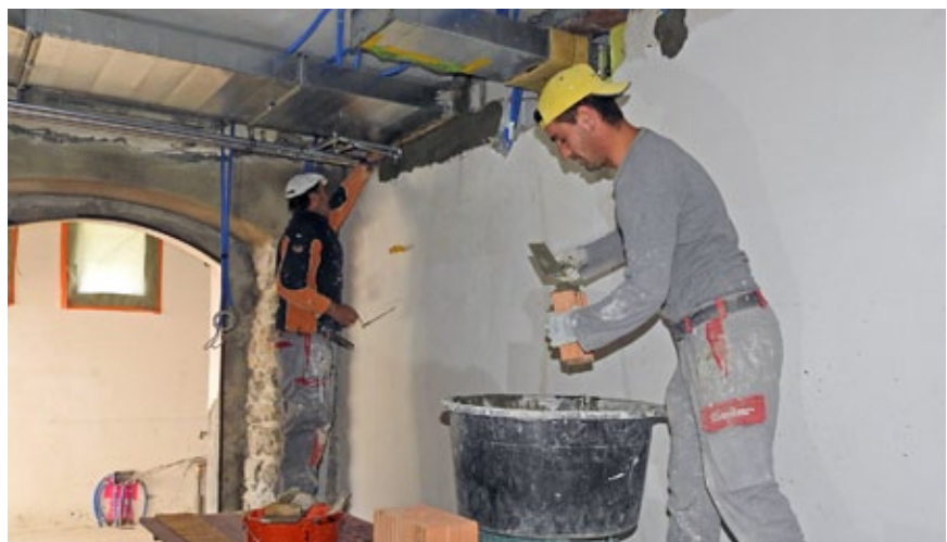
Marco Pozzi und Davide Geronimi schliessen die letzten Durchbrüche.
