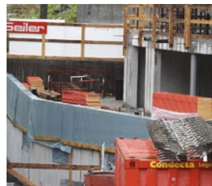
Die Sichtbetonflächen wurden immer mit Plastik abgedeckt.
