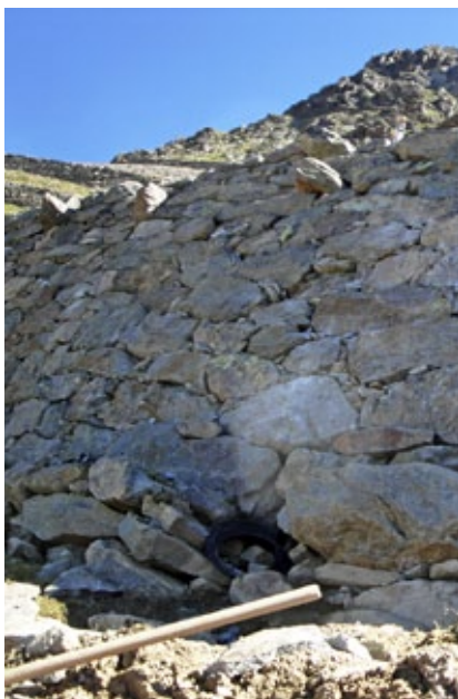
Nicht überall musste die Mauer abgetragen werden. Teils wurden alle Zwischenräume geschlossen und die Steine mit rostfreiem Stahl verbunden.
