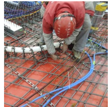
Spezielle Armierung um die Lüftungsrohre.
