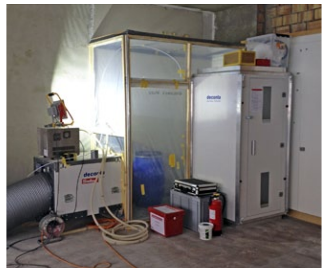
So sieht die komplette Abschottung mit Zutrittsschleuse aus, in welcher nun gearbeitet werden kann.
