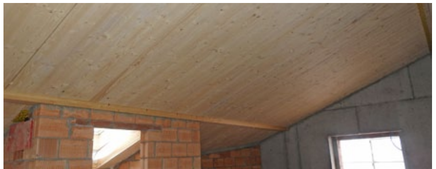
Untersicht des Elementdaches.
