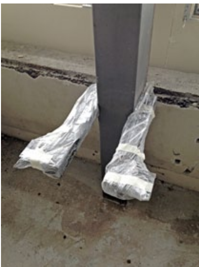
Die Winkel der Fensterbänke und aller Tüorzargen waren mit einer Lackierung behandelt, die Schwermetall und PCB enthält. Sie musste abgelagert werden. Ebenfalls das Fugendichtungsmaterial der Betonfensterbänke war PCB haltig und musste entfernt werden.
