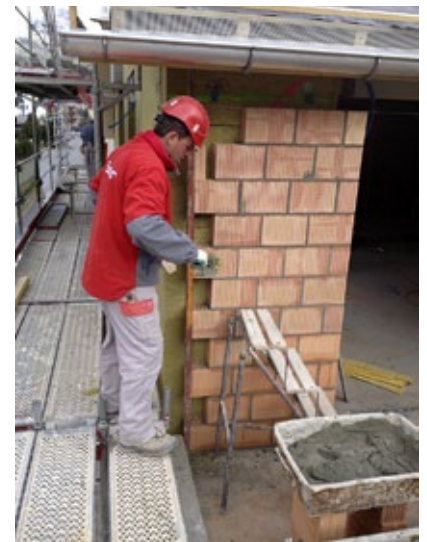
Kranführer Cristian Illia beim Mauern der Fassaden.
