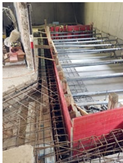
Wanne vor dem Betonieren.
