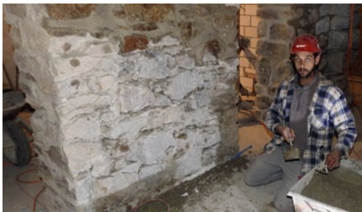
Die „freigespritzten“ Bruchsteinmauern. Alberto Bracchi beim Ausfugen, das Endresultat ist beeindruckend.
