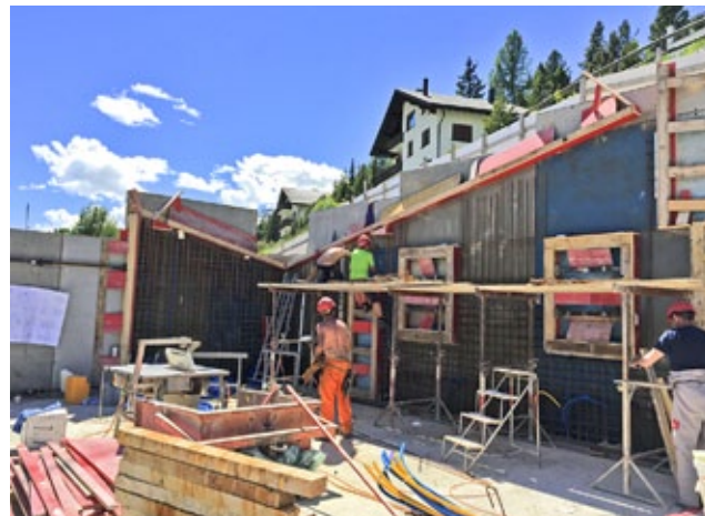
Erstellen der Giebelwände.
