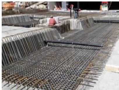
Fundamentvertiefungen unter der Bodenplatte der Garage.
