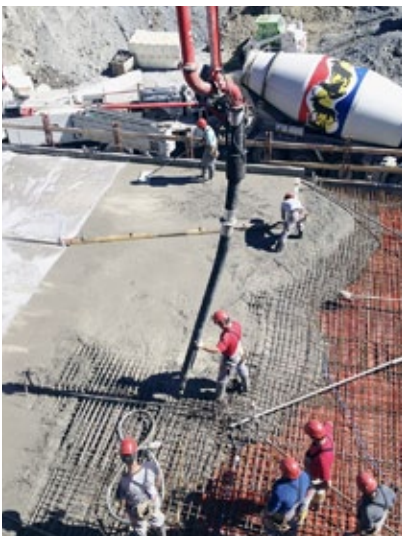
Endlich konnte auch die Garagendecke betoniert werden.
