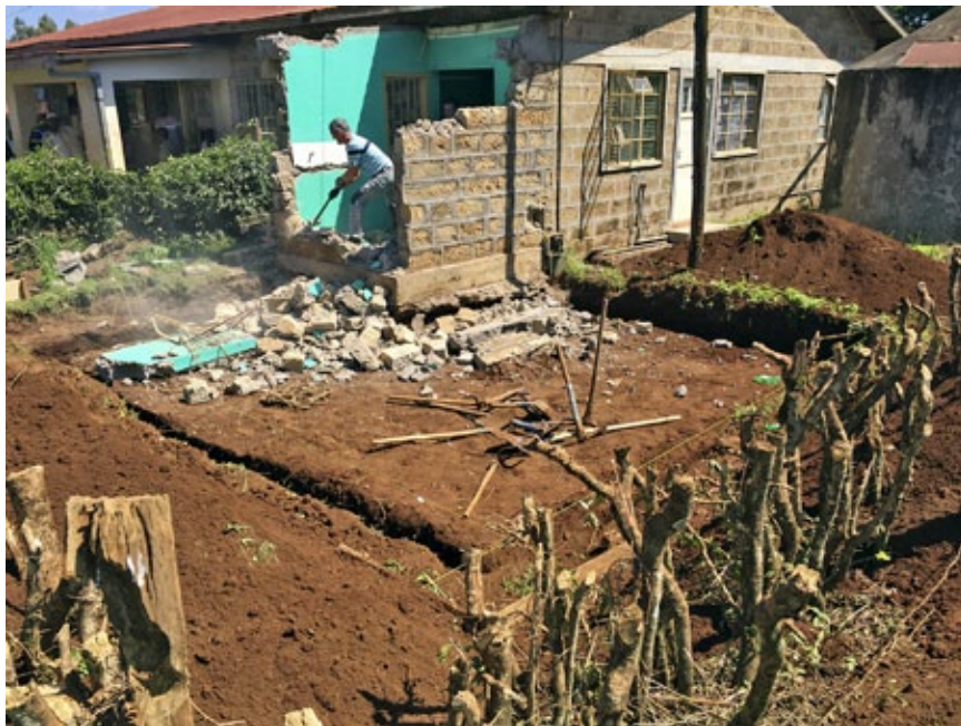
Gleichzeitig mit dem Abbruch wurde auch der Aushub erstellt.
