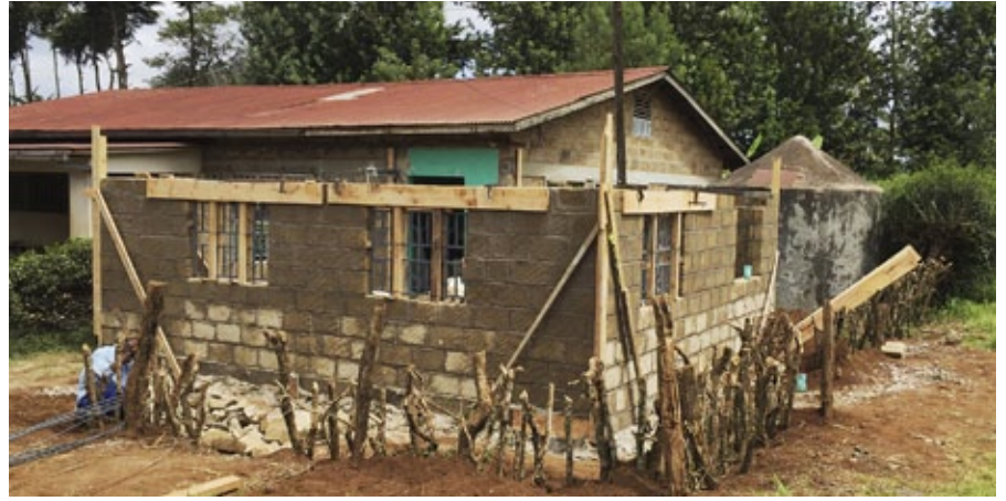
Die Mauersteine wiesen zum Teil Unterschiede von fünf Zentimeter auf. Wir spitzten die Differenzen weg und so ging es Schicht um Schicht aufwärts.
