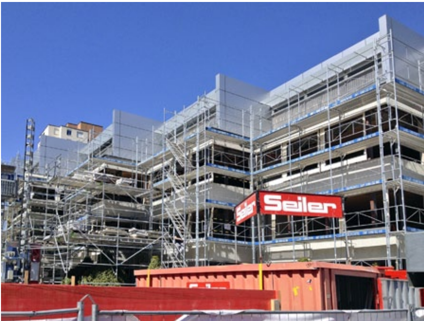
Das eingerüstete Schulhaus Rheinau.
