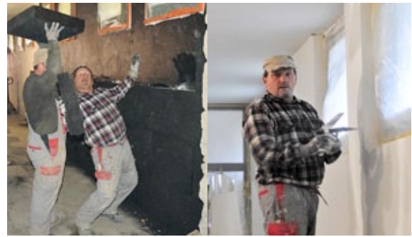
Bei allen Baustellenbesuchen spürte man den Teamgeist. Edi Scaramella beim isolieren mit Foamglas und danach am Verputzen. Edi ist übrigens Kranführer von Beruf.
