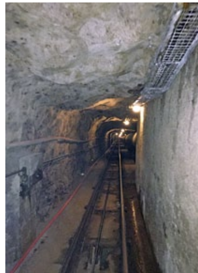
Mit der Stollenbahn ging es zur 215 m tiefer gelegenen Kraftwerkzentrale Cavaglia.
