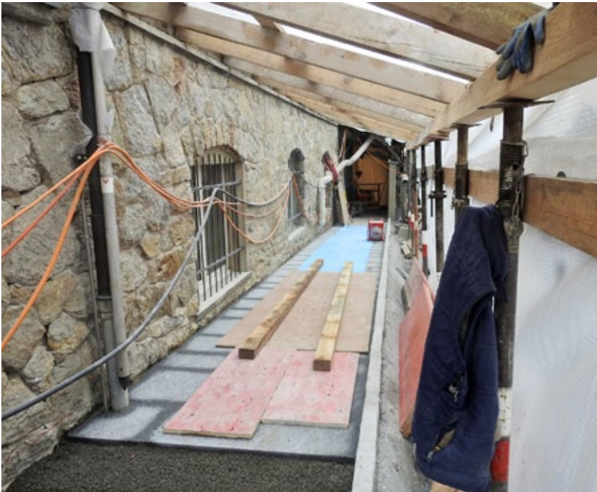
Der neue Zugang entsteht.
