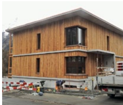
Ansicht von der Via da la Staziun.
