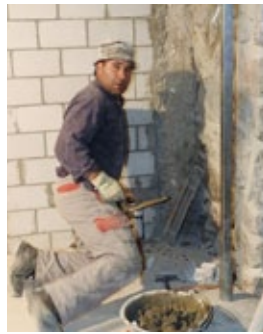
José Silva dos Santos beim Zumauern eines Durchbruches.
