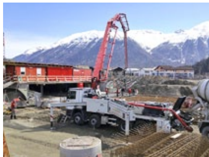
Alle Bodenplatten und Decken werden mit der Betonpumpe betoniert.
