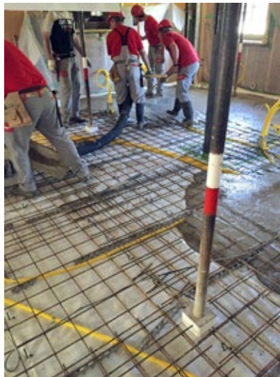
Im Chalet wurde ein Überbeton auf die Holzbalkendecke eingebracht.
