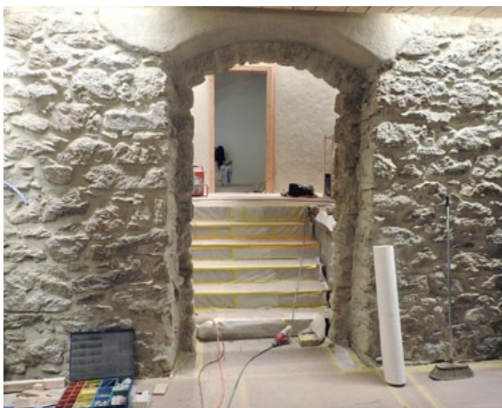
Die „freigespritzten“ Bruchsteinmauern. Alberto Bracchi beim Ausfugen, das Endresultat ist beeindruckend.
