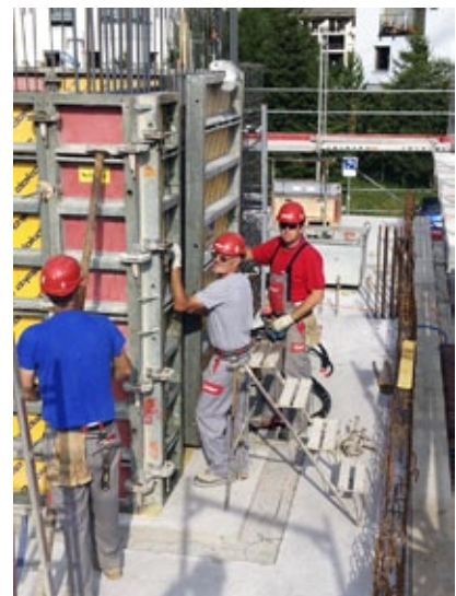
Für die Betonwände werden nur noch Elementschalungen verwendet.
