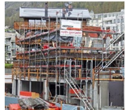
Stockwerk um Stockwerk ging es zügig in die Höhe.
