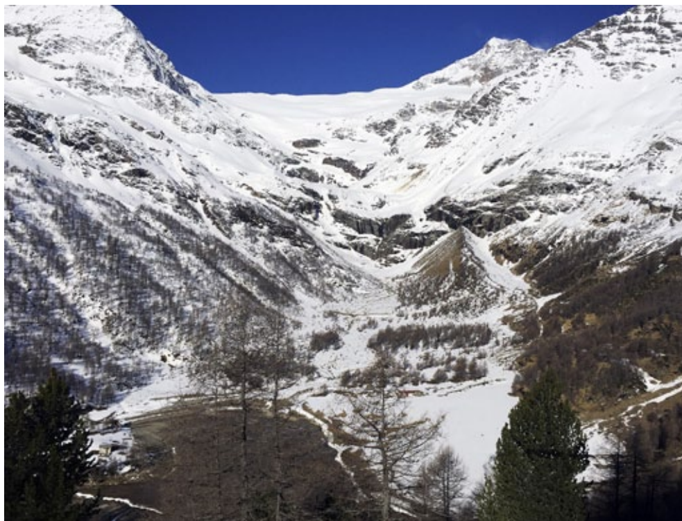
Blick von Alp Grüm zum Palü Stausee. Der See ist wegen den Bauarbeiten entleert.
