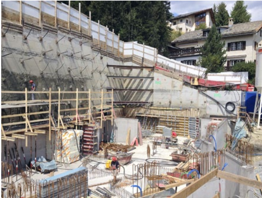
Stand Mitte August 2015 – gut ersichtlich die aufwändige Baugrubensicherung.
