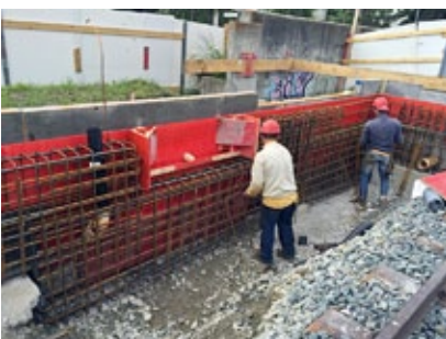
Streifenfundationen. Framax mit Schaltafeln aufgedoppelt um schöne Sichtfläche zu erhalten.
