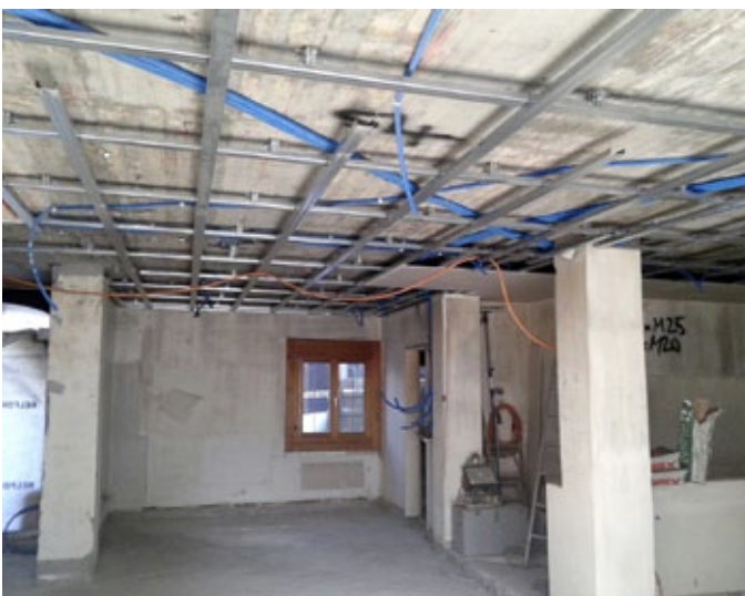
Neu erstellte, heruntergehängte Decke im Korridor und ebenfalls im Eingangsbereich.
