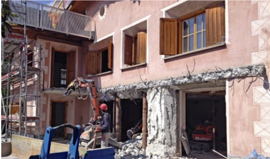
Der Abbruchroboter kam auf dieser Baustelle oft zum Einsatz.
