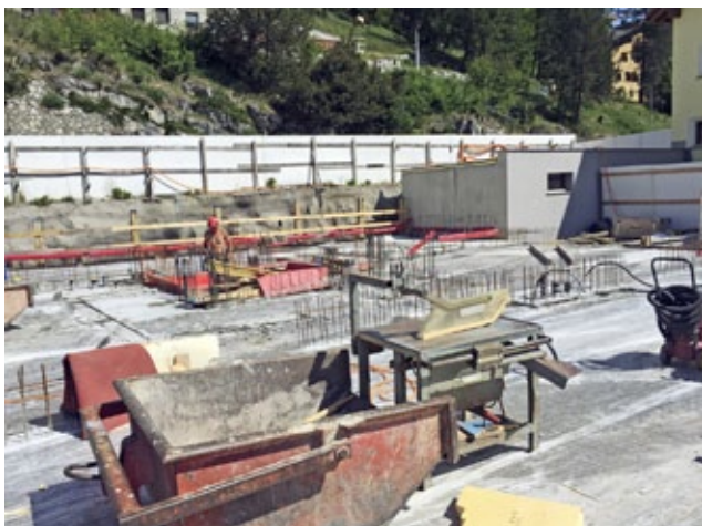
Decke über Ergeschoss.
