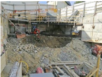
Das gelagerte Material wurde zum Hinterfüllen gebraucht.
