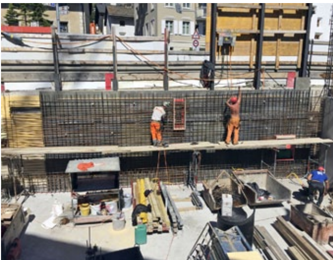
Die Wände gegen die Baugrubensicherung wurden einhäutig betoniert.
