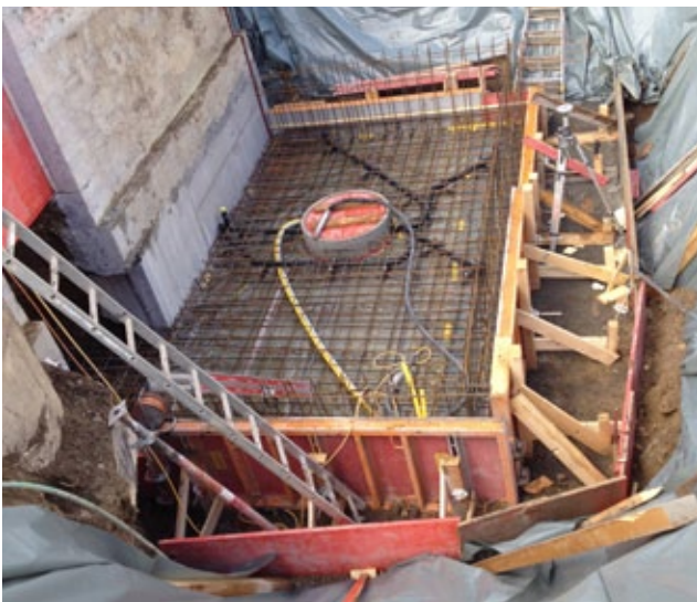
Anbau des Technikraumes.
