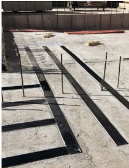
Unterhalb und oberhalb wurde die Decke mit Klebarmierung verstärkt.
