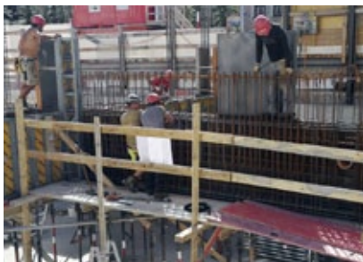
Vor der Decke mussten zuerst die Unterzüge erstellt werden.
