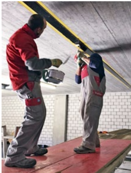
Unterhalb und oberhalb wurde die Decke mit Klebarmierung verstärkt.
