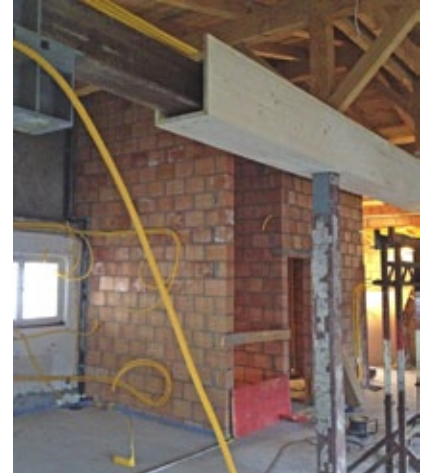
Unkonventionelle Abfangmethoden waren gefragt und nach Erstellen des Schnellstriches kam bereits der Schreiner und verkleidete die Stahlträger.
