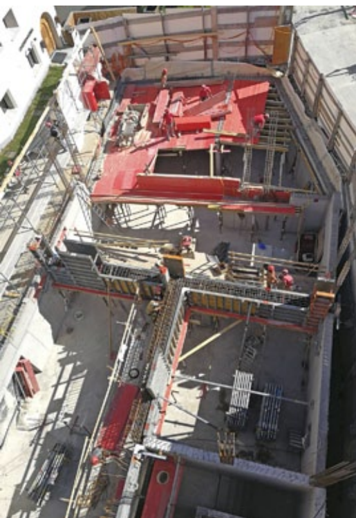
Ansicht auf die Unterzüge vom Kran aus.
