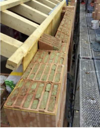
Dachanschluss mit Porotherm Mauerwerk.
