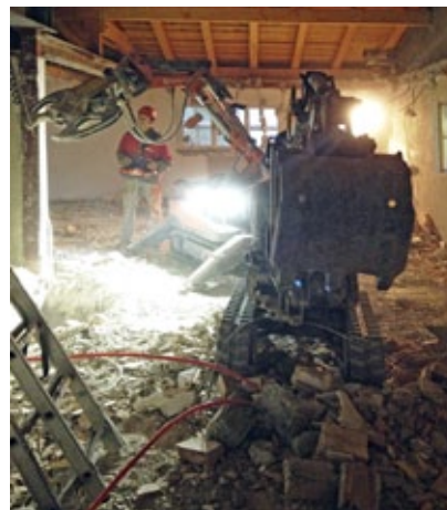
Verschiedenste Kleinmaschinen waren im Einsatz, im Erdgeschoss Kleinbagger Kubota und im Obergeschoss der Abbruchroboter und ein weiterer leichter Kleinbagger.
