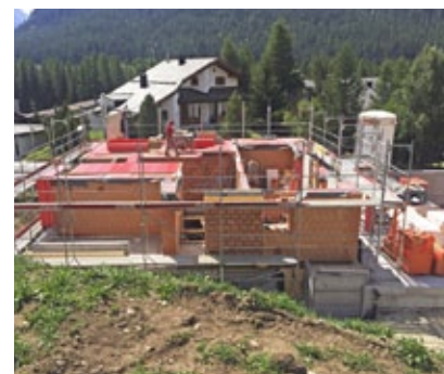
Für das Erdgeschoss benötigten wir mit Decke etwa drei Wochen.
