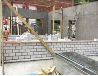
Einige Zwischenwände wurden mit Kalksandsteinen gemauert.
