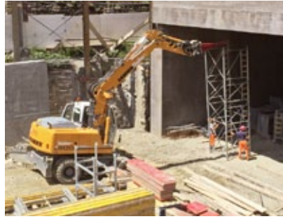
Das Ausschalen der Staxo Türme erfolgte unter anderem mit dem Pneubagger.
