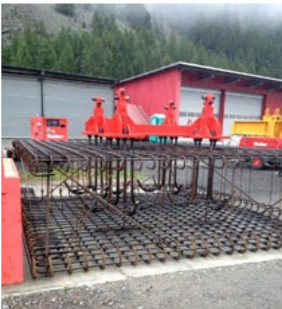
Armierung mit den Anker und dem roten Ankerrahmen. Maschinist Antonio Cometti, Chauffeur Cristian Rossi und unser Bauführer Paolo Crameri mussten für das Betonieren einspringen.
