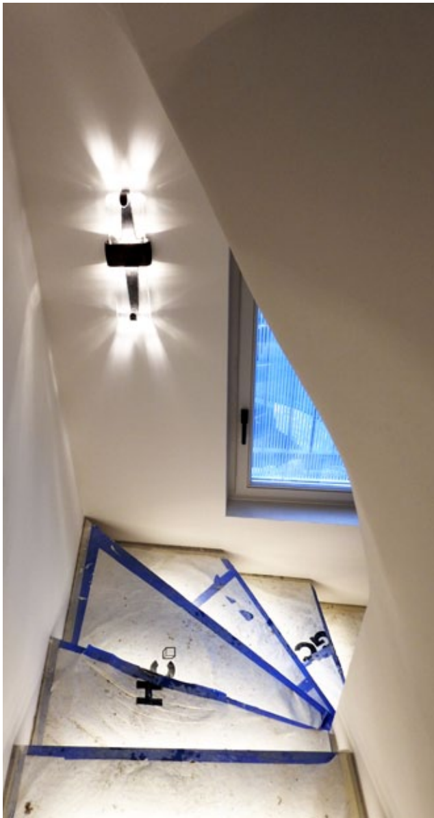
Das Treppenhaus war von seiten der Gipsarbeiten sehr interessant.
