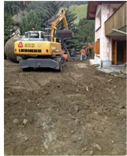
Ausbau des Kugeltankes.
