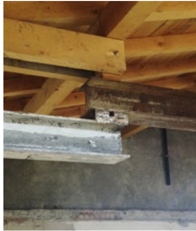
Unkonventionelle Abfangmethoden waren gefragt und nach Erstellen des Schnellstriches kam bereits der Schreiner und verkleidete die Stahlträger.
