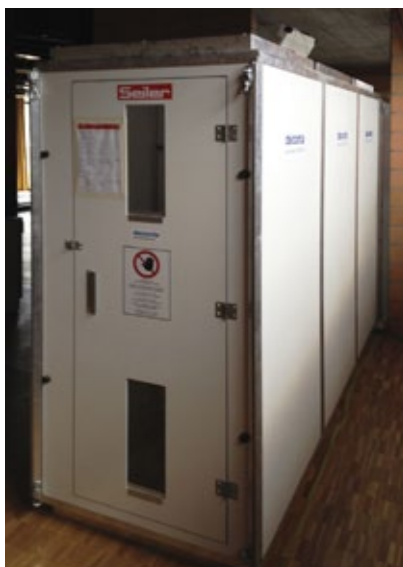
Durch diese drei Schleusen müssen die Mitarbeiter, wenn sie in die Schutzzone wollen. Beim Verlassen wird in der mittleren Schleuse zweimal geduscht.
