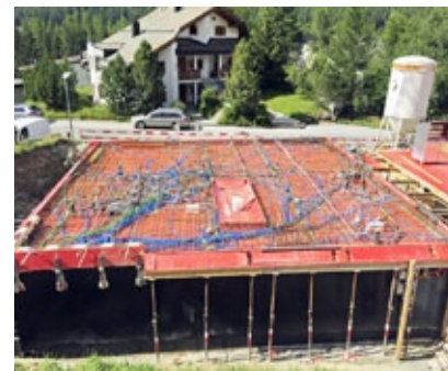
Decke über Untergeschoss bereit zum Betonieren.
