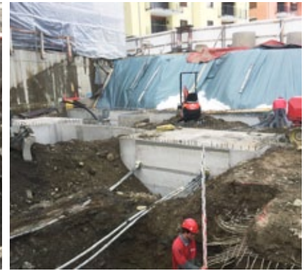
Unter der Bodenplatte Garage entstanden sehr grosse Fundationen unter den Pfeilern.
