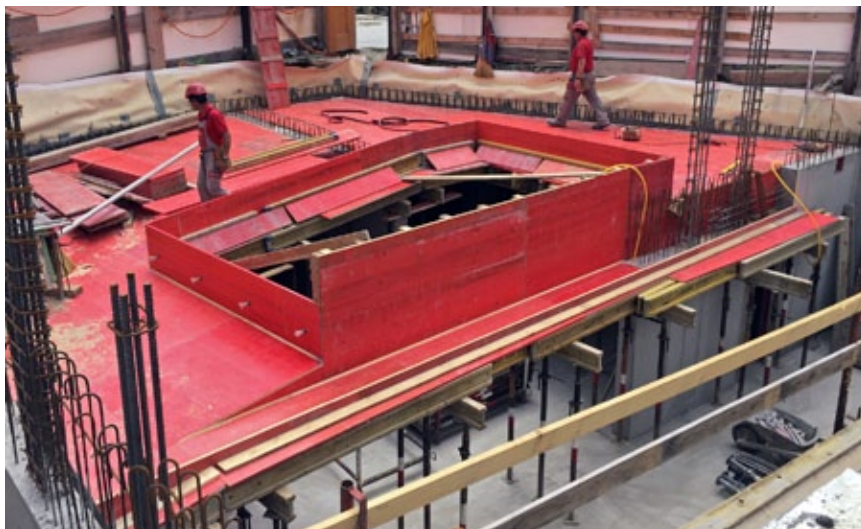
Das geübte Auge erkennt Schalungsdetails, die die Komplexität aufzeigen. Armierungseisen über mehrere Stöcke garantieren die Erdbebensicherheit.
