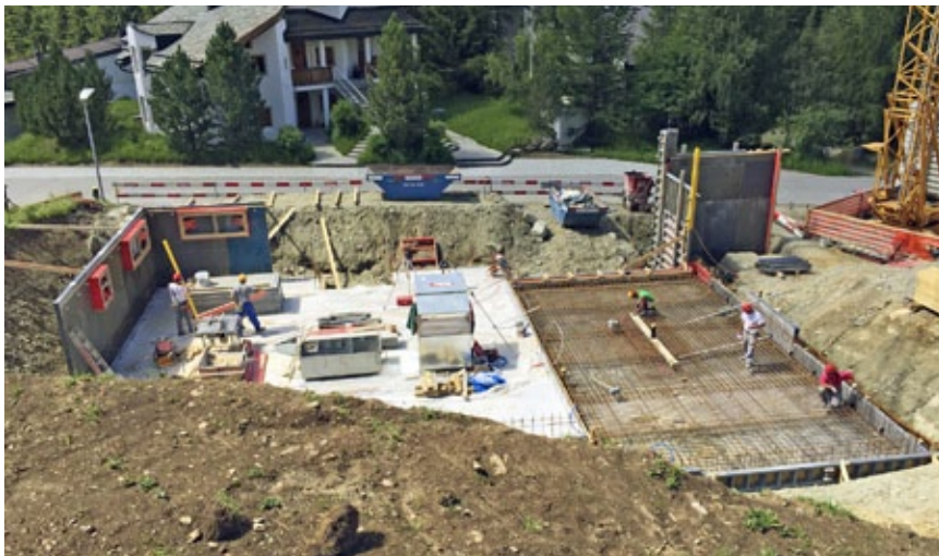
Bodenplatte Untergeschoss betoniert, Garagenboden bereit.
