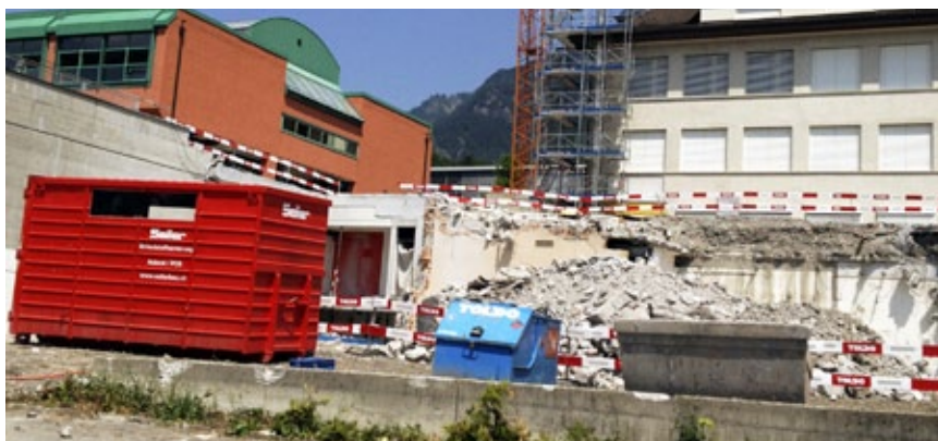
Im Vordergrund wurde die Turnhalle bereits abgebrochen. Im Hintergrund ein Schulhaus, das demnächst ausgehöhlt wird.
