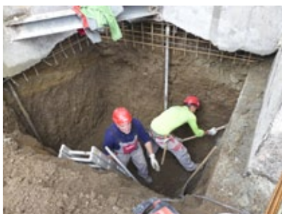
Unterfangung und Baugrubensicherung in einem.
