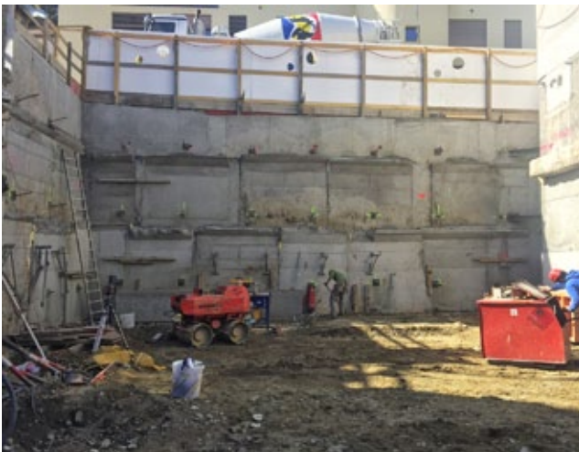
Fertiger Baugrubenaushub. Weiter geht es mit den Leitungen und der Bodenplatte.
