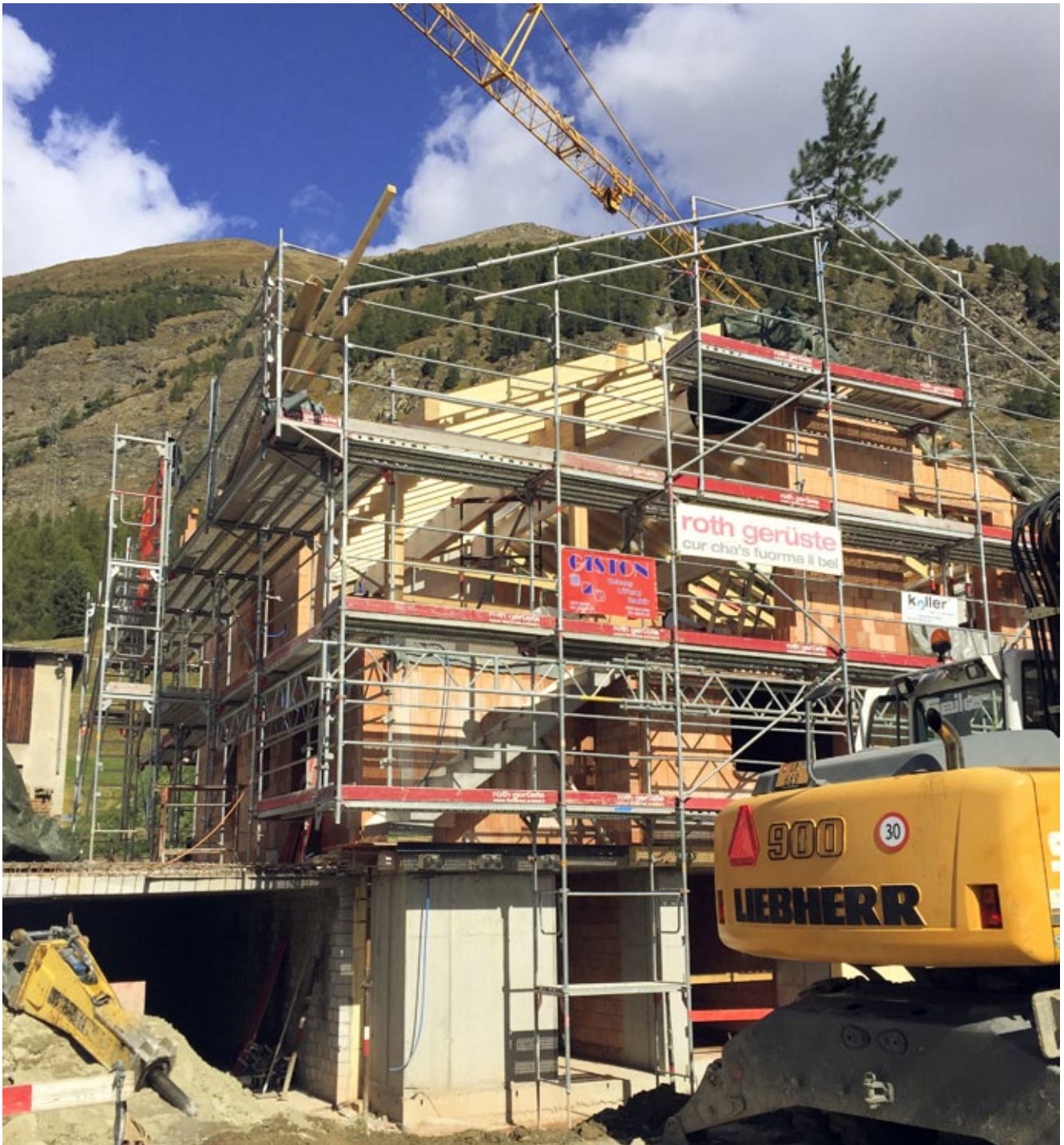
Am 26. September wurde das Aufrichtebäumchen montiert.
