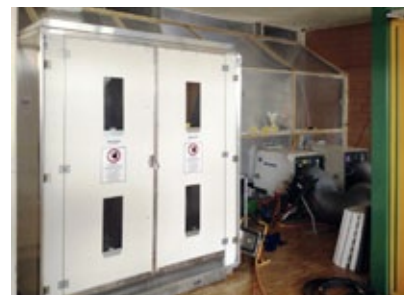
Dies sind die Materialschleusen, über die verseuchtes Material ins Freie gelangt.
