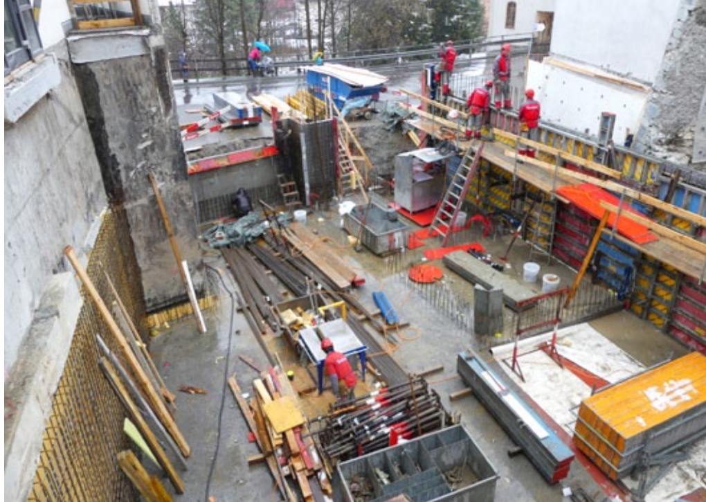
Zuviel Platz hatte es auf dieser Baustelle nicht.
