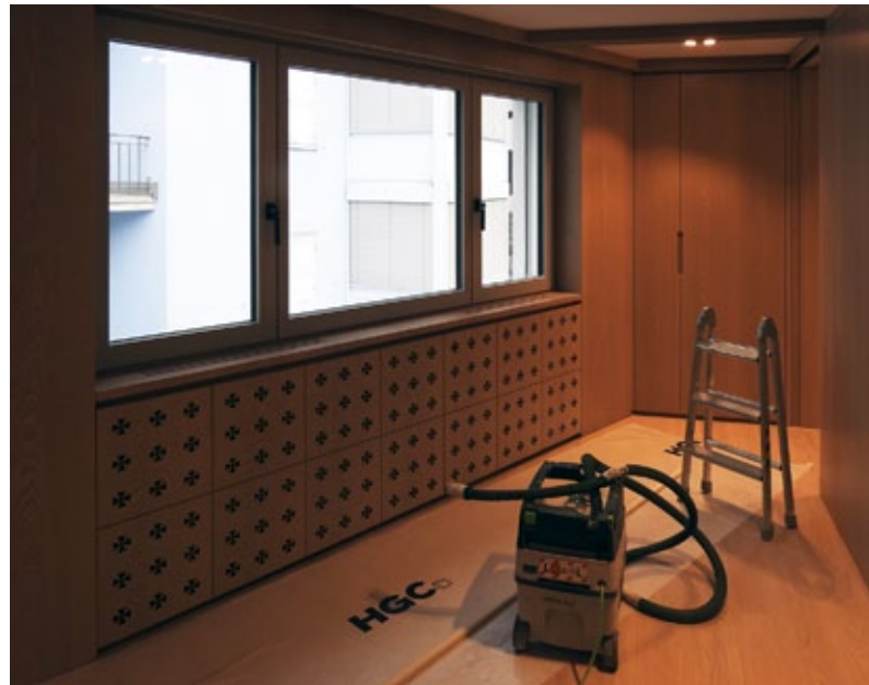
Der Innenausbau wurde viel in Holz erstellt.
