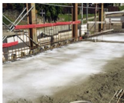
Für einen Teil verwendeten wir eingefärbten Beton, der Rest mit normalem Beton. Weiss, das aufgespritzte Antisol, welches vor Austrocknung schützt. Die Wände im Obergeschoss mit Bretterschalung und ebenfalls eingefärbtem Beton.
