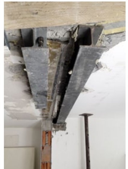
Zum Teil wurden die Stahlträgerkonstruktionen nach oben fixiert.
