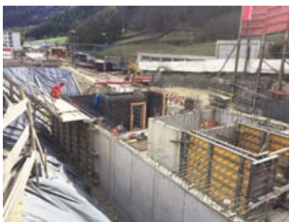
Treppenhaus / Warenlift im Erdgeschoss.
