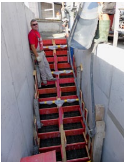
Letztes Mal betonieren auf der Baustelle (Kran ist bereits weg, daher ohne Helm!)
