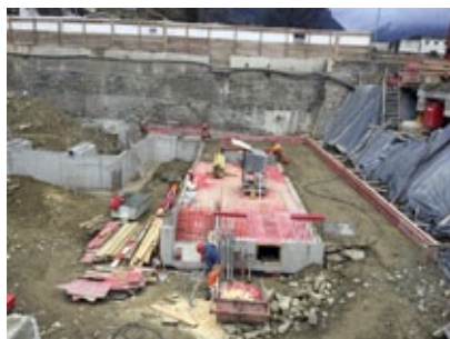
Das Erdgeschoss entsteht.
