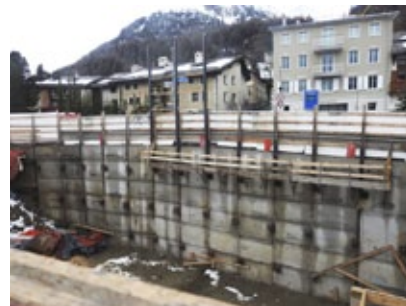
Stand Baustelle Dezember 2016.
