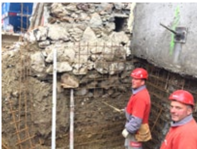
Unterfangung und Baugrubensicherung in einem.
