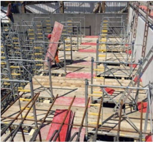
Bei den hohen Schalhöhen mieteten wir das Doka Staxo Traggerüst ein.
