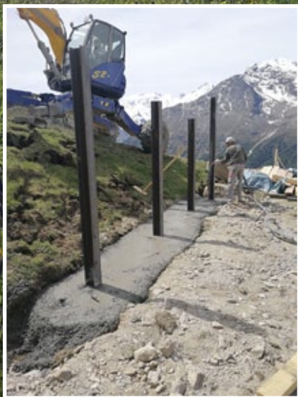
Stahlträger für die Infowand.
