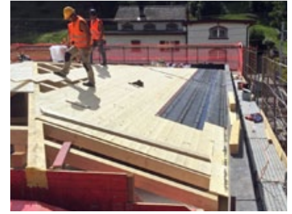
Über der Betondecke des Obergeschosses setzte man ein Holzdach, welches als Gründach aufgebaut wurde.
