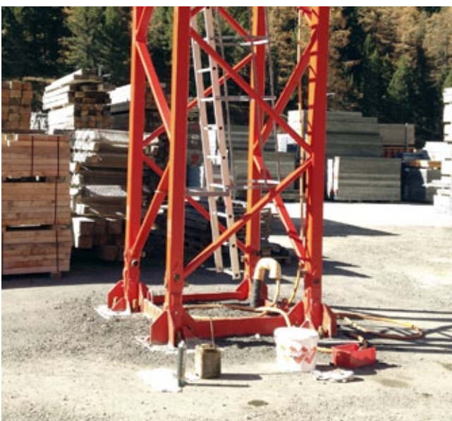
So sieht die fertige Fundation aus mit dem ersten Stück des Turmes auf dem Ankerrahmen. Der Gegenausleger wird mit dem neuen Auto-kran der Firma Lanfranchi montiert.
