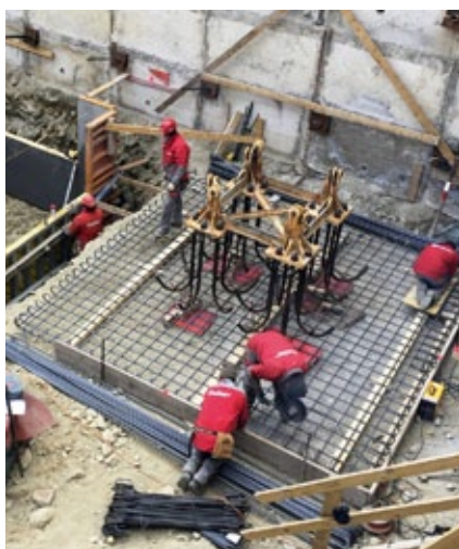
Kranfundation unter der Bodenplatte mit Einlage für den Kranturm. Bei Kranmontagen und Demontagen kann meist von schlechtem Wetter ausgegangen werden.
