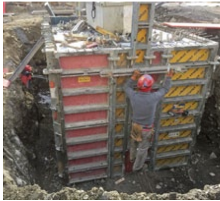
Unter der Bodenplatte Garage entstanden sehr grosse Fundationen unter den Pfeilern.
