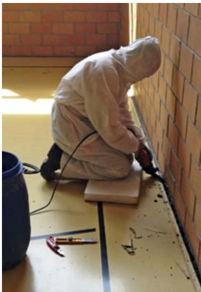
Einer unserer Mitarbeiter beim Entfernen von PCB haltiger Kittfuge.
