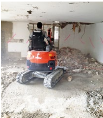
Verschiedenste Kleinmaschinen waren im Einsatz, im Erdgeschoss Kleinbagger Kubota und im Obergeschoss der Abbruchroboter und ein weiterer leichter Kleinbagger.
