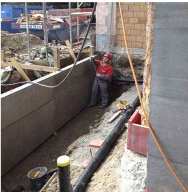
Erstellen von Frostriegeln für den Anbau des Schlafzimmers mit Whirlpool.
