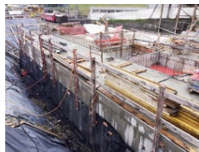
Decke über Erdgeschoss betoniert.
