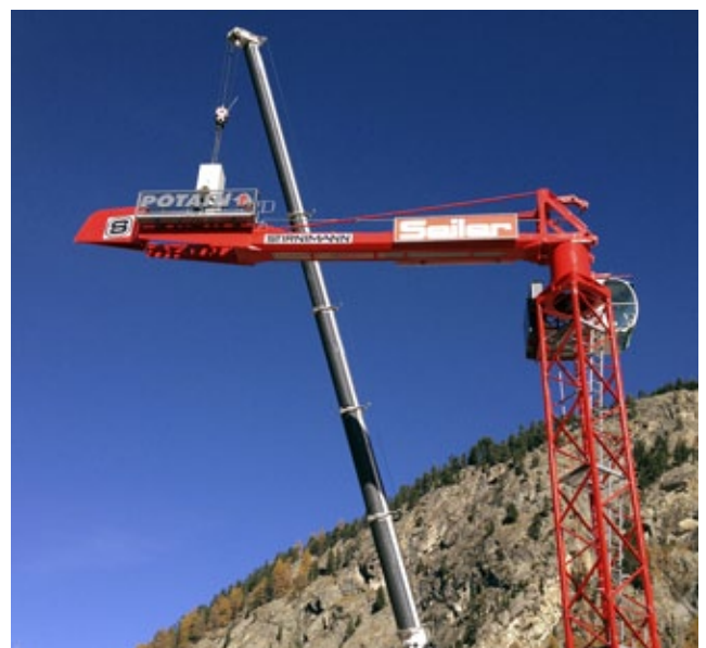
So sieht die fertige Fundation aus mit dem ersten Stück des Turmes auf dem Ankerrahmen. Der Gegenausleger wird mit dem neuen Auto-kran der Firma Lanfranchi montiert.
