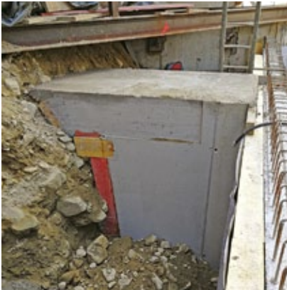
Mit solchen Füllbetonriegeln stellte man das Auflager für die hinauspringende Deckenplatte sicher.
