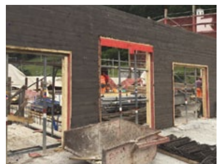
Für einen Teil verwendeten wir eingefärbten Beton, der Rest mit normalem Beton. Weiss, das aufgespritzte Antisol, welches vor Austrocknung schützt. Die Wände im Obergeschoss mit Bretterschalung und ebenfalls eingefärbtem Beton.
