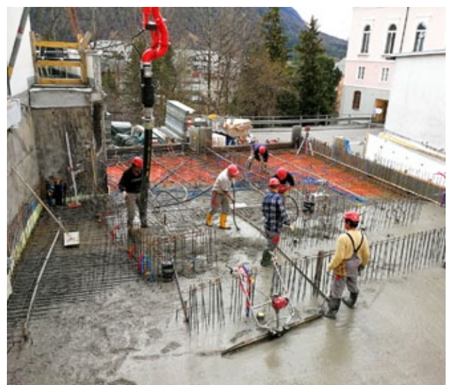
Decke über 2. Untergeschoss.
