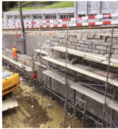
Hinter der langen Stützmauer wird das zweite Gleis der Berninalinie entstehen. Noch während der Bruchsteinarbeit hinterfüllten wir die Stützmauer und die RhB konnte mit dem Gleisbau beginnen.
