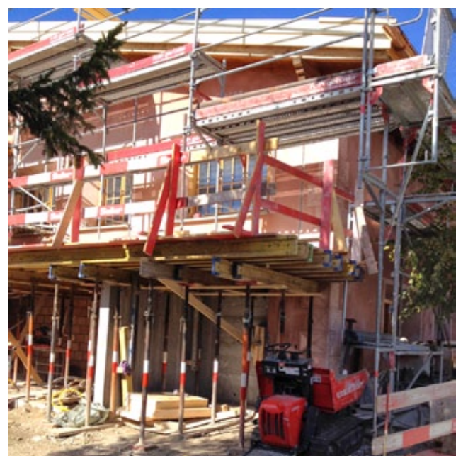
Die neue Terrasse kurz vor dem Betonieren.
