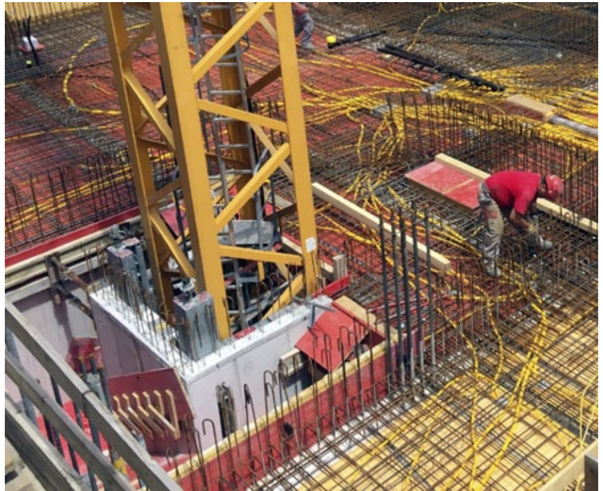
Gut ersichtlich, wie wir um den Kran gebaut haben.
