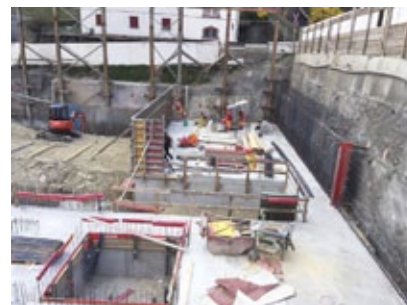
Schalen der Decke über dem Tankraum.
