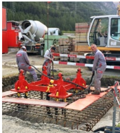
Armierung mit den Anker und dem roten Ankerrahmen. Maschinist Antonio Cometti, Chauffeur Cristian Rossi und unser Bauführer Paolo Crameri mussten für das Betonieren einspringen.
