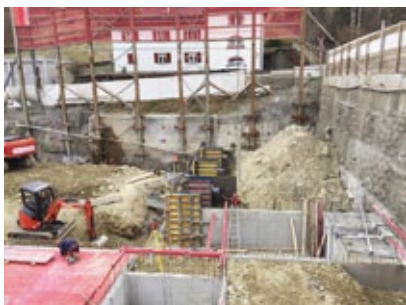
Einbetonieren der Pfuffer.
