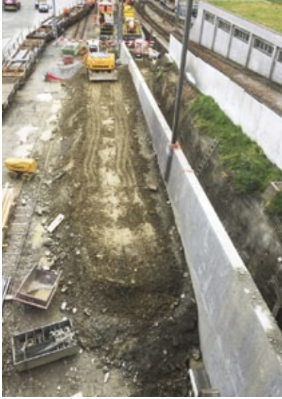
Hinter der langen Stützmauer wird das zweite Gleis der Berninalinie entstehen. Noch während der Bruchsteinarbeit hinterfüllten wir die Stützmauer und die RhB konnte mit dem Gleisbau beginnen.
