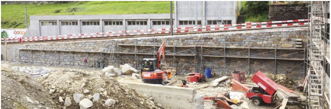
Die verkleidete 68 m lange Stützmauer, mit Natursteinen aus Miralago.
