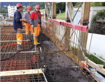
Für einen Teil verwendeten wir eingefärbten Beton, der Rest mit normalem Beton. Weiss, das aufgespritzte Antisol, welches vor Austrocknung schützt. Die Wände im Obergeschoss mit Bretterschalung und ebenfalls eingefärbtem Beton.
