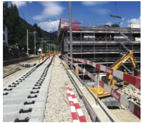
Hinter der langen Stützmauer wird das zweite Gleis der Berninalinie entstehen. Noch während der Bruchsteinarbeit hinterfüllten wir die Stützmauer und die RhB konnte mit dem Gleisbau beginnen.
