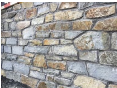
Die imposante Masse der sehr gut gelungenen Stützmauer.
