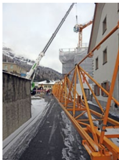
Natürlich schneite es bei der Kran- demontage wieder mal ...
