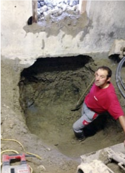
Bereit für die erste Unterfangung.
