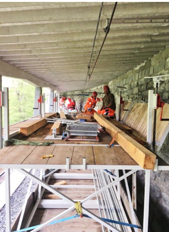
Mit ausgeklügeltem System wurde die Schalung umgesetzt.
