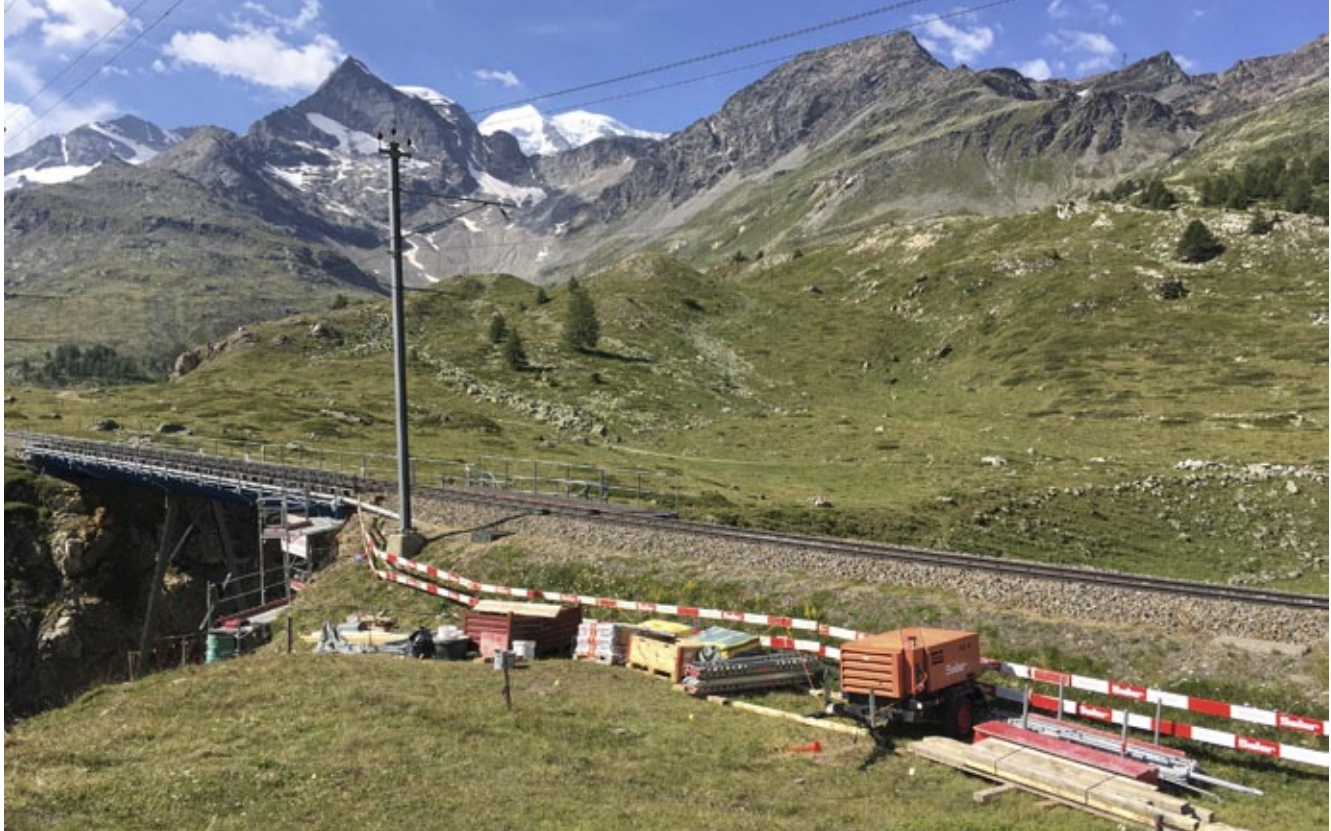
Was für ein schöner Bauplatz.
