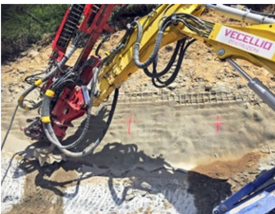
Die talseitige Stützmauer wurde mit Mikropfählen gehalten. Sämtliche Mikropfähle wurden durch unseren ARGE Partner Vecellio Construzioni AG mit Bohrlafette gebohrt.
