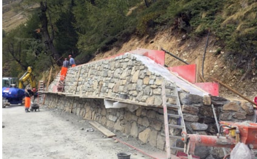
Am Schluss wurden verschiedene Stützmauern noch mit Natursteinen verkleidet.
