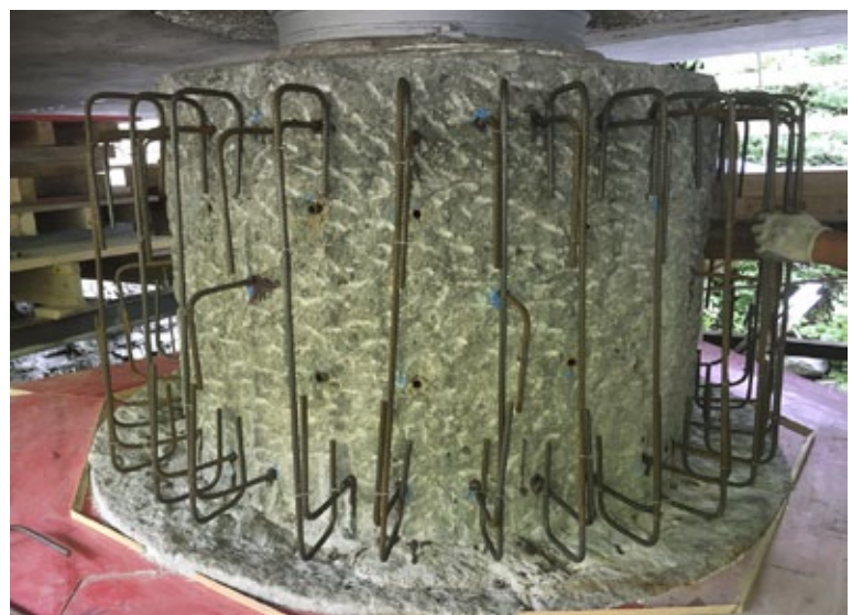
Die bestehenden Pfeiler unter der Brücke wurden ebenfalls verstärkt.
