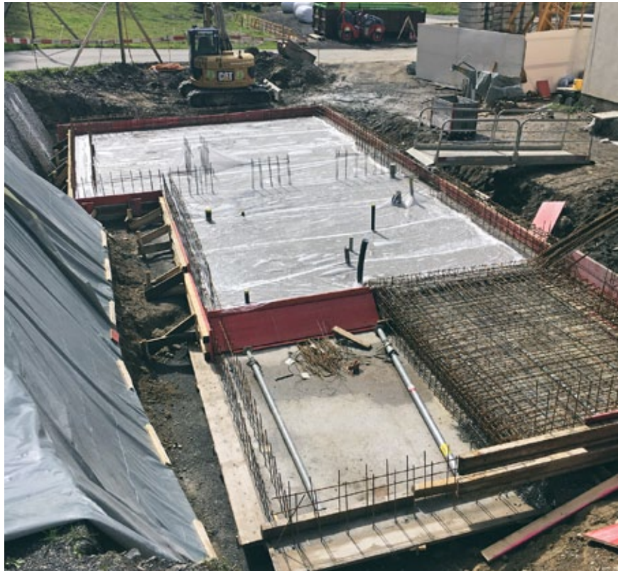
Schluss mit schmutzigen Schuhen, Bodenplatte betoniert.
