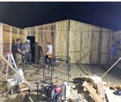
Fassadenelemente wurden vorfabriziert und am Bau beplankt.
