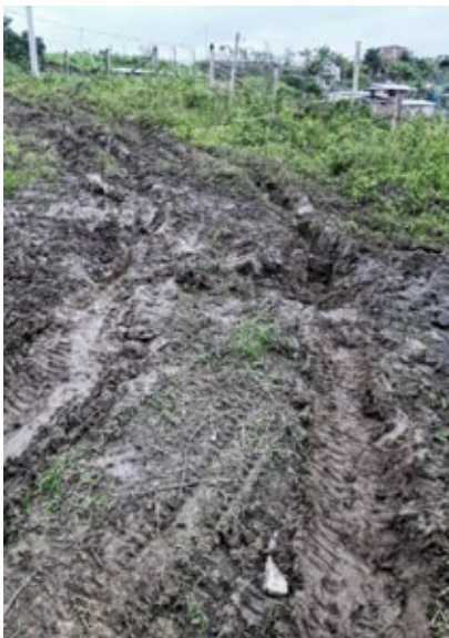
Nach fünf Minuten Regen waren die Zufahrtsstrassen unpassierbar.
