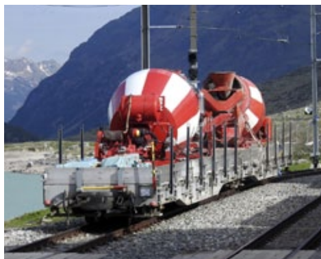
Die talseitige Stützmauer. Entweder betonierten wir mit der Heli Bernina oder ab dem Bahnwagen mit unseren Fahrmschern. Betonieren war immer nur nachts möglich.
