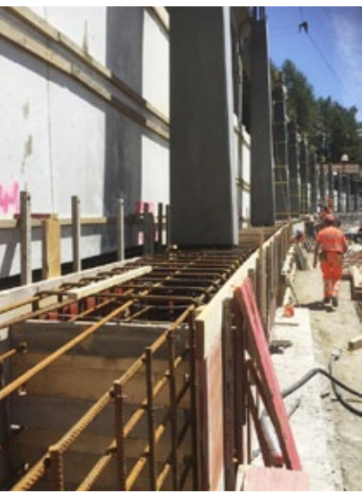
Fundation mit den Betonstützen. Betonieren mit dem Heli verlangte grosses Können seitens der Piloten, waren doch überall Abspannkabel vorhanden.
