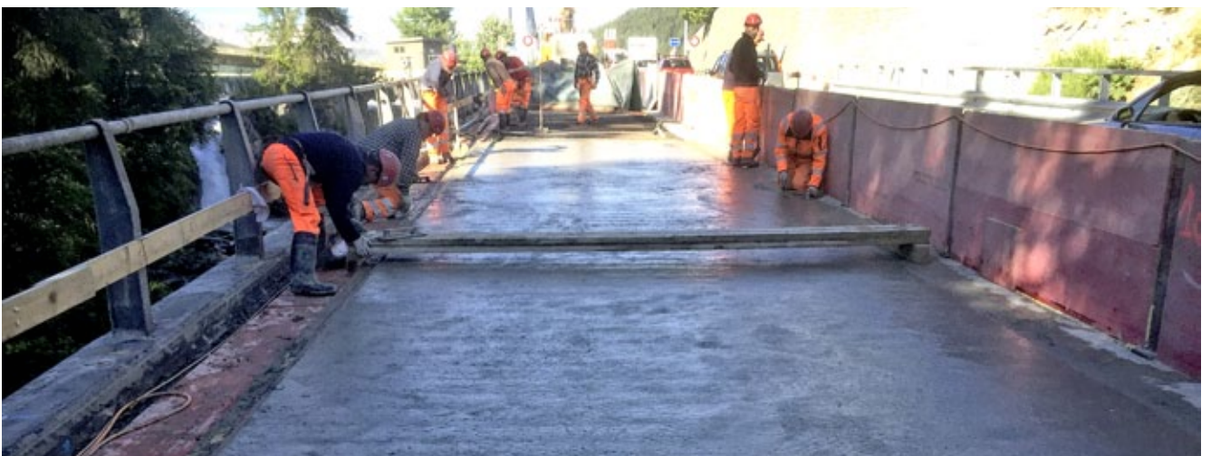
Toleranz beim Betonieren beträgt 10mm.
