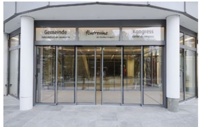
Fertiger neuer Eingang.
