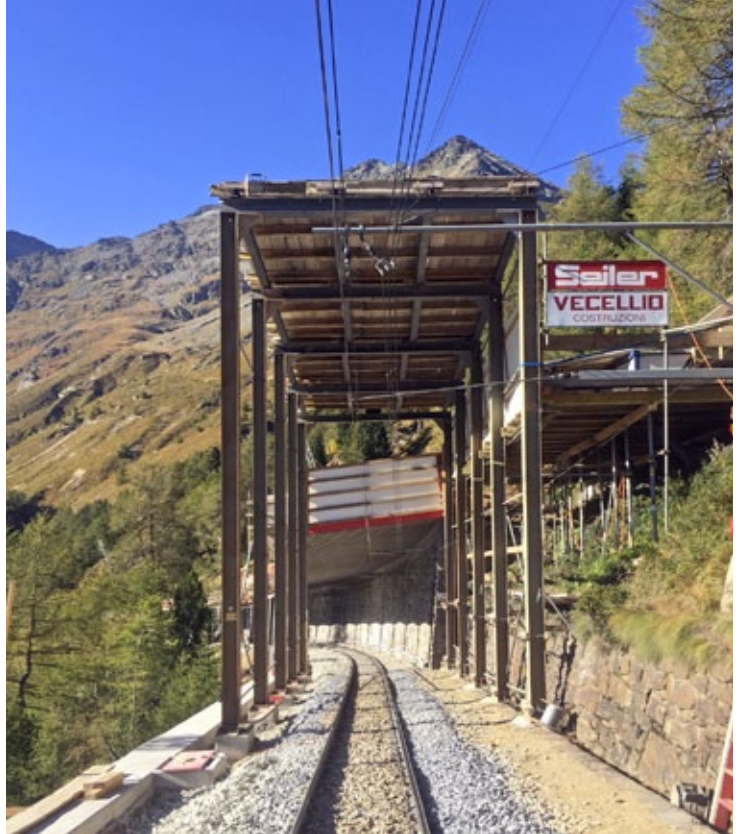
Vor der Galerie, im Bereich der Materialseilbahn, erstellen wir ein Schutzgerüst über dem Bahntrasse.
