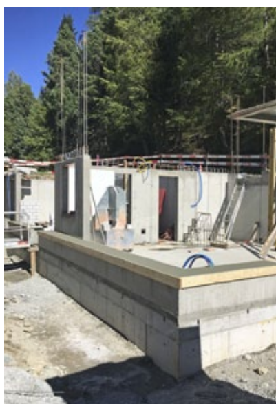
Alles bereit für das Porotherm Mauerwerk.
