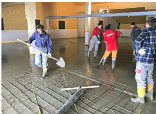
Betonieren des Überbetons auf der Holzkonstruktion im 2. OG.
