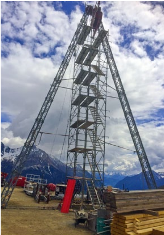
Abspannmast der Materialseilbahn. Das Gerüst war notwendig um die Laufkatze zu betanken.
