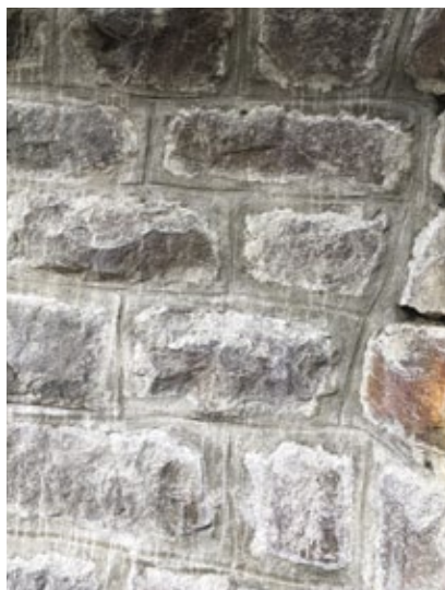
Fertiges Bruchsteinmauerwerk vor der Reinigung.
