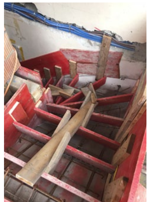
Neue Treppe im Hausinnern.
