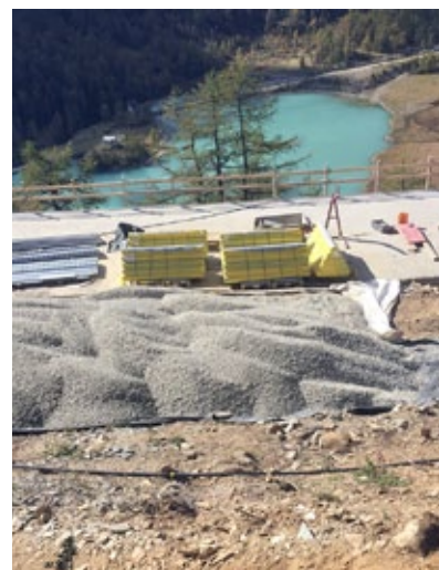
Die Abdichtungen und das Betonkies liegen für die Arbeiten 2019 bereit.
