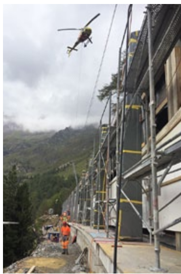
Fundation mit den Betonstützen. Betonieren mit dem Heli verlangte grosses Können seitens der Piloten, waren doch überall Abspannkabel vorhanden.
