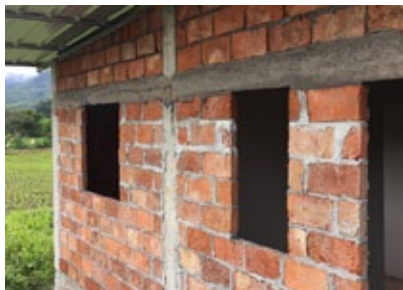
Mit 5 cm dicken Tonsteinen fachten wir die Betonpfeiler aus.
