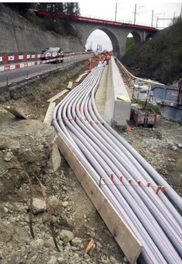
16 Leerrohre mussten eingelegt werden.
