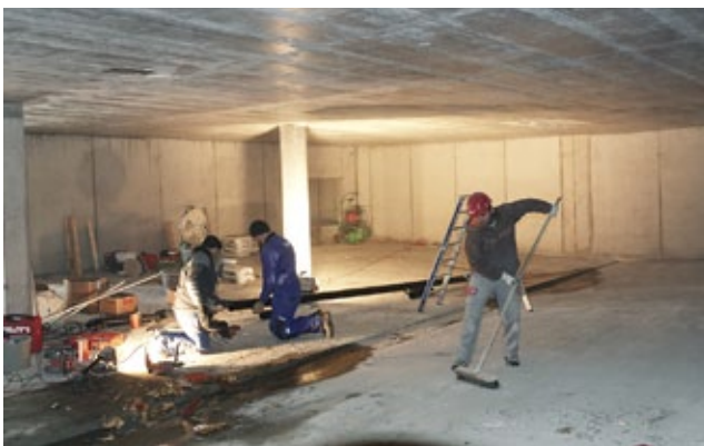
Reinigung bevor der Gussasphalt gegossen wird.
