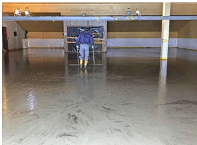
Auch hier brauchte es nach dem Betonieren keinen Aufbau mehr.
