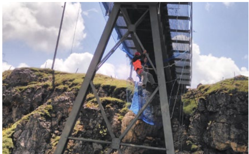
Giancarlo Salis befestigte das Auffangnetz als Absturzsicherung.
