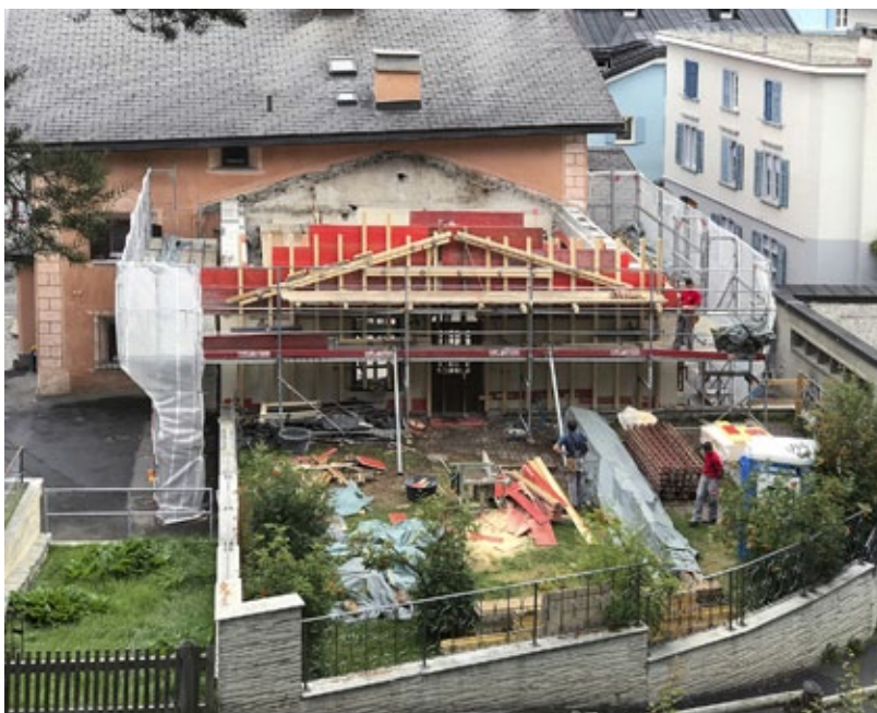
Die vordere Giebelwand wurde neu erstellt.
