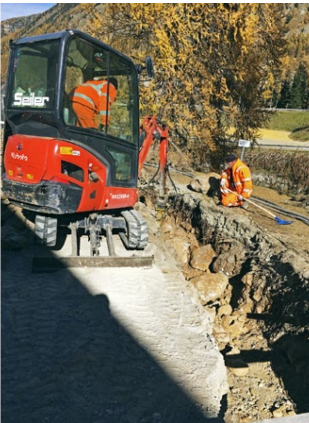
Es gäbe schöneren Baugrund.
