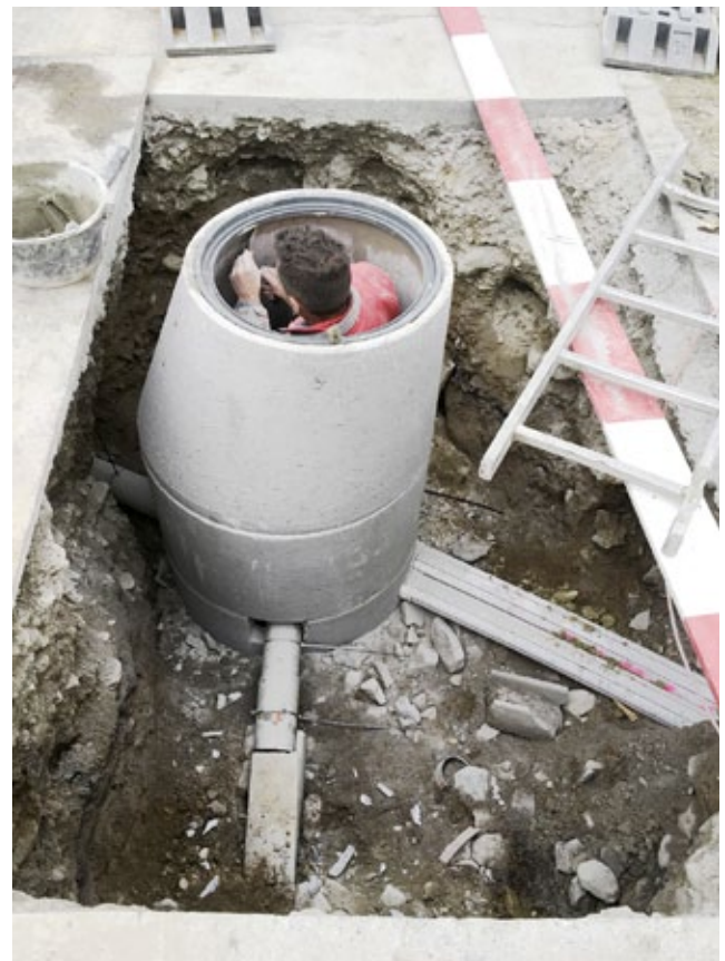
Nicht immer brauchte es einen Ortsbetonschacht.
