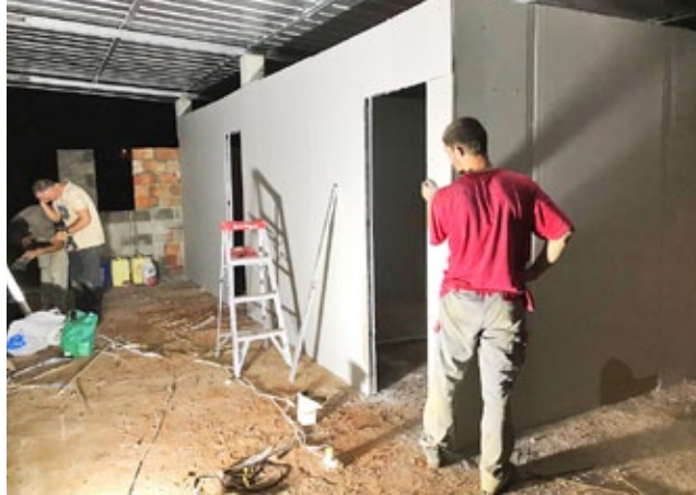
Die Zwischenwände erstellten wir in Gipskarton.
