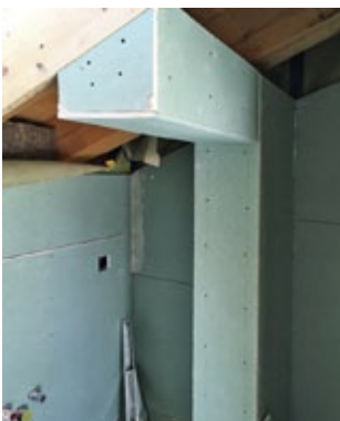
Die ganze Dachuntersicht wurde isoliert und mit Gipsplatten verkleidet.
