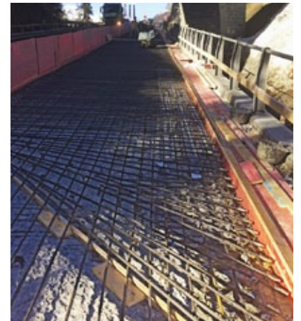
Fahrbahn bereit zum Betonieren.
