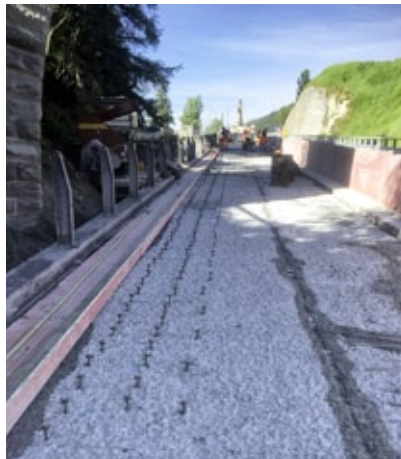
Die Brückenplatte wurde mit Wasserhochdruck abgetragen. Gut sichtbar die eingesetzten Verbundanker.
