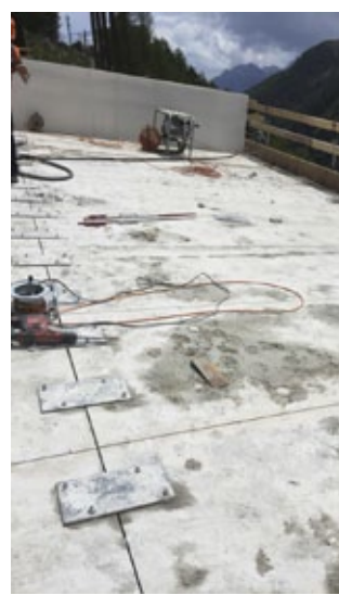
Die alte Galerie wurde tagsüber in Stücke geschnitten, welche nachts ausgebaut wurde.
