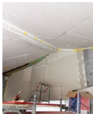
Die ganze Dachuntersicht wurde isoliert und mit Gipsplatten verkleidet.
