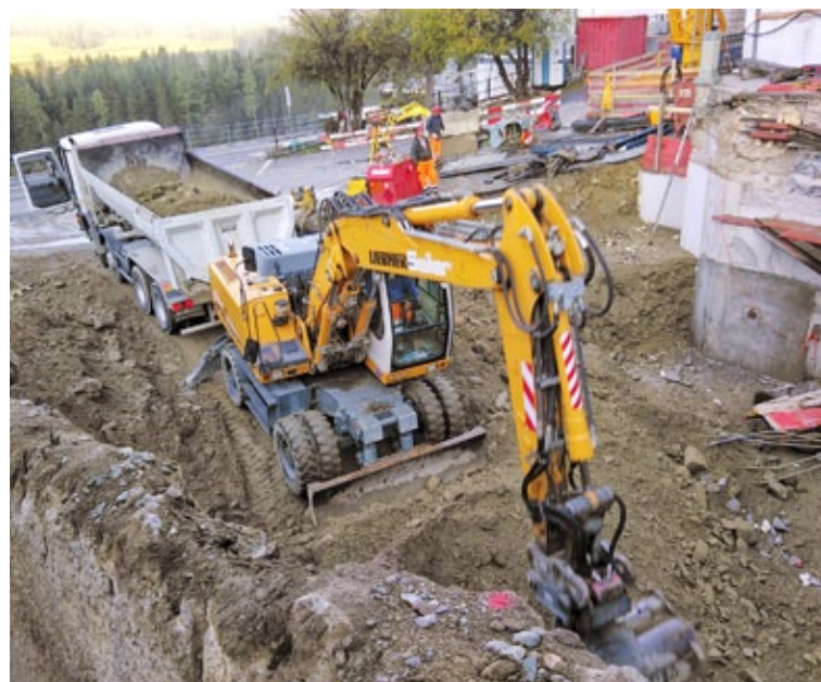
Gutes Material kam zum Vorschein, im Vordergrund die alte Baugrubensicherung.
