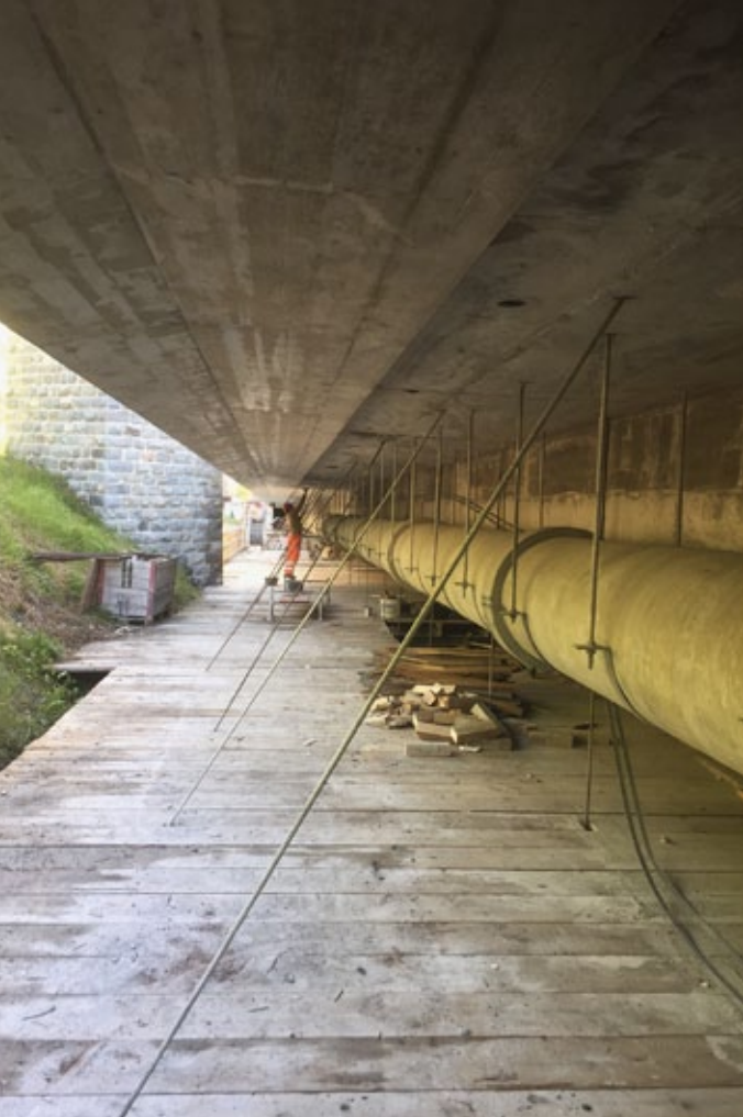
Auf die bestehende Kanalisation unter der Brücke musste Rücksicht genommen werden.
