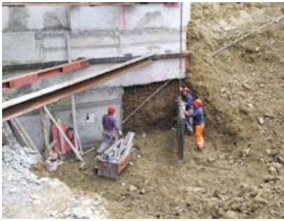
Die Chesa Belmunt wurde in Etappen unterfangen.
