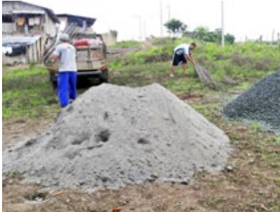
Anlieferung der Komponenten zur Betonherstellung.
