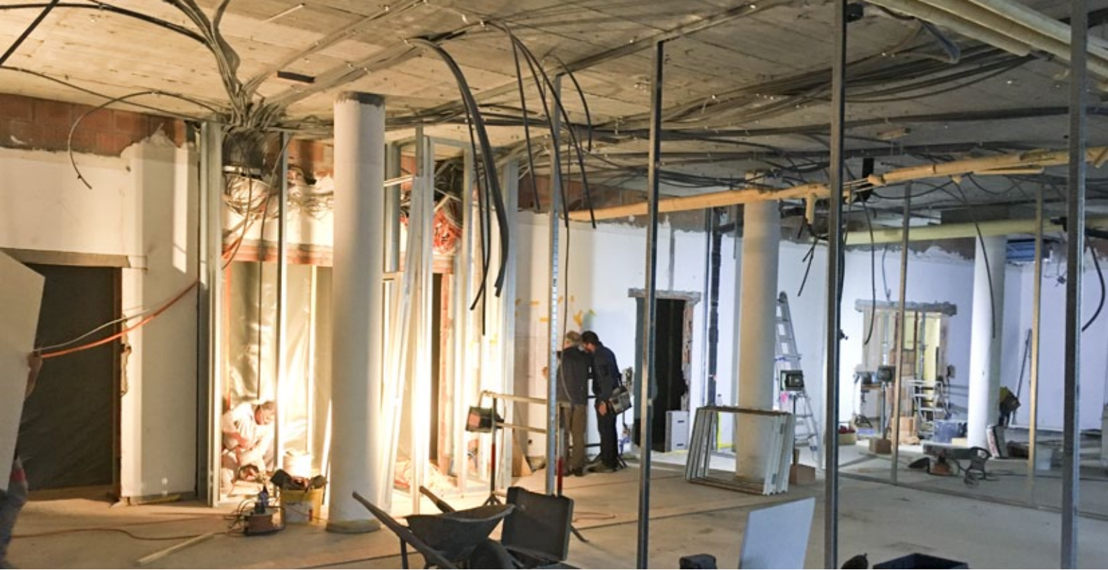
Wiederaufbau im Leichtbau.
