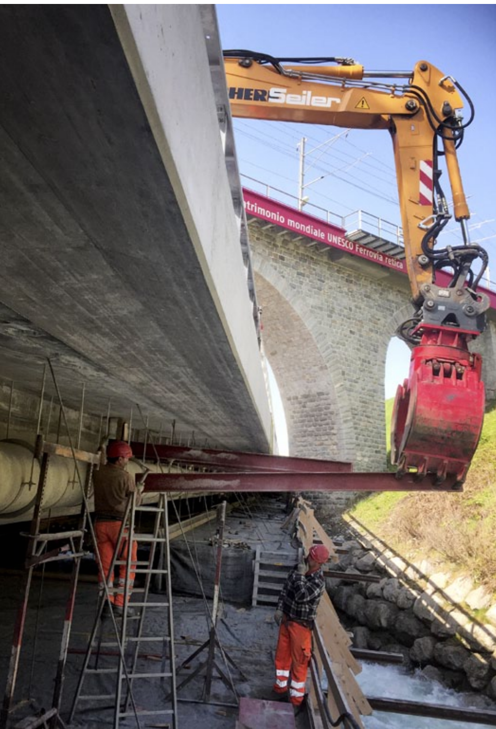
Zum Erstellen des Arbeitsgerüsts unter der Brücke hatten wir unser eigenes System.
