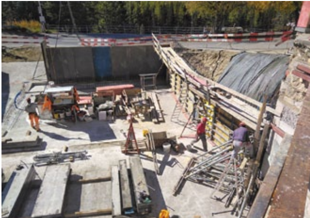
Ist die Bodenplatte einmal betoniert, geht es schnell vorwärts.
