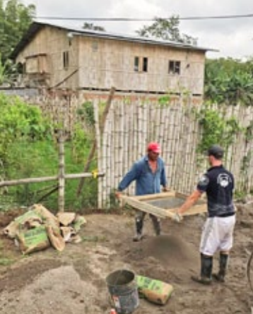
Damit Daniel Crameri überhaupt mauern konnte, musste der Sand zuerst gesiebt werden.
