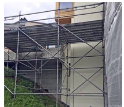
Durch Roth Gerüste erstellte Plattform für Lagerung von Material.
