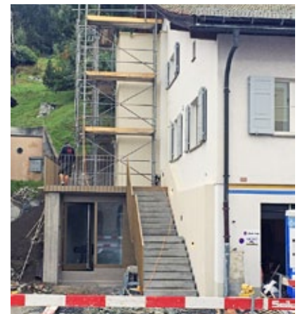
Fertiger Eingang mit darüberliegendem Liftaufbau.
