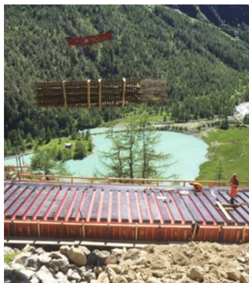
Auf der Schalung kamen dann die vorgefertigten Rippen zum Einsatz, die vorgeschweisste Armierung ist bereits im Anflug.
