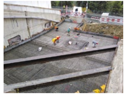
Ein Tag vor dem Betonieren der Bodenplatte.
