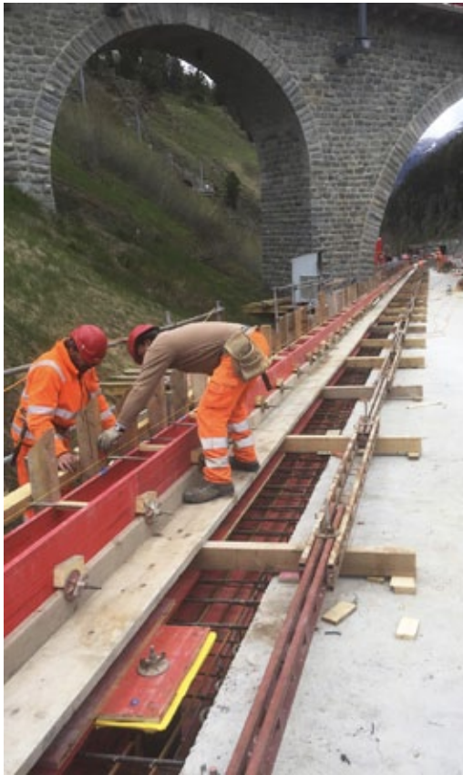
Als nächster Schritt wird der Kordon anbetoniert.
