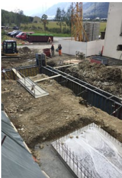
Unter der Bodenplatte erstellen wir Frostriegel.
