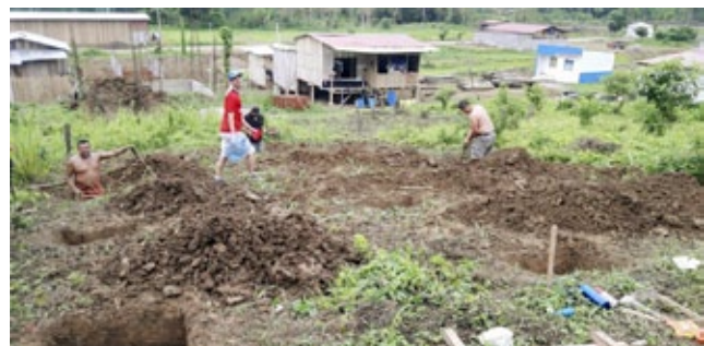
Auch diese Familie musste die Foundation selber erstellen, diesmal jedoch aus Holzpfählen.
