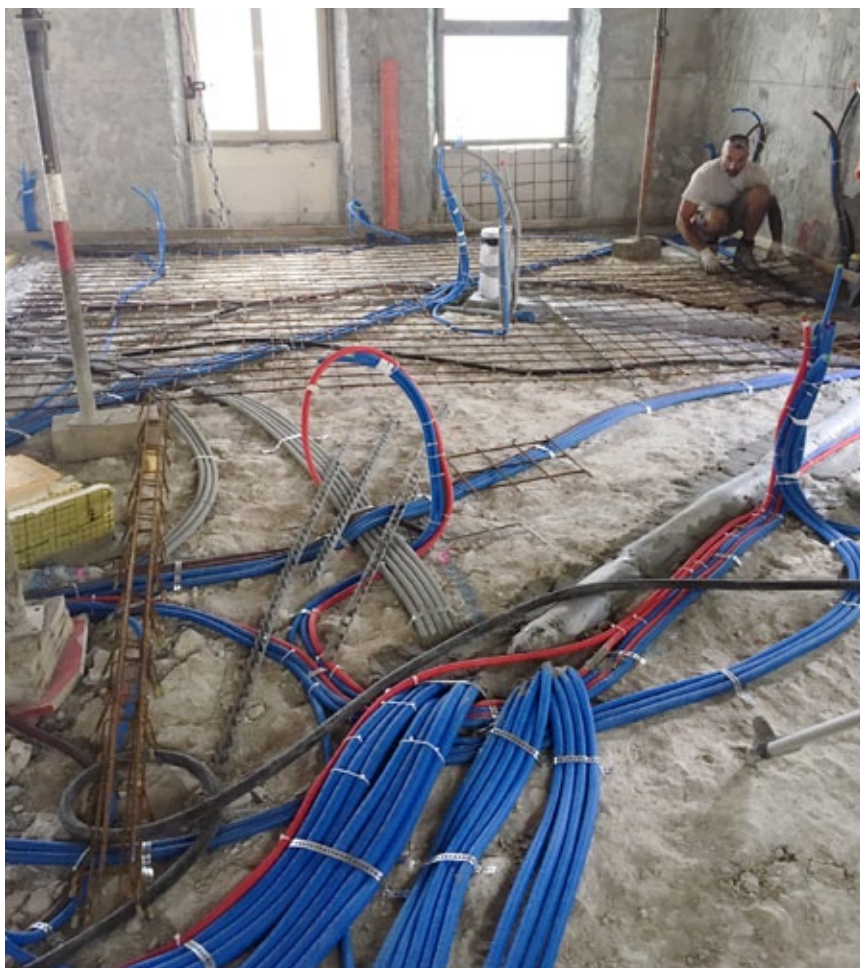
Alle neuen Leitungen wurden in den Überbeton verlegt.
