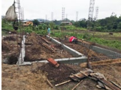
Einen grossen Teil der Fundation musste durch die Familien hergestellt werden.
