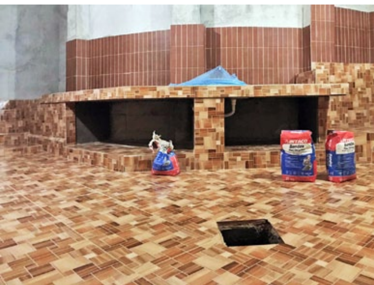
Im Gemeinschaftsraum der Mission bauten wir eine neue Küche ein und verlegten nachher alles mit Fliesen.
