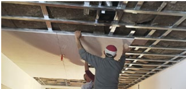
Akustikplatten wurden an der Decke angebracht.
