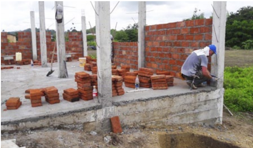
Mit 5 cm dicken Tonsteinen fachten wir die Betonpfeiler aus.
