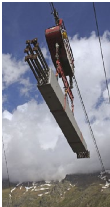
Anlieferung der vofabrizierten Betonstützen mittels Seilkran. Luis F. Wieser ist froh über eine Abwechslung, wenn er den ganzen Tag Seilkran fahren muss.
