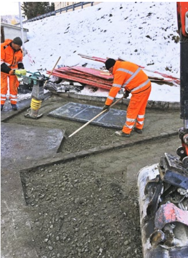
Fertiger Schacht vor dem Belageinbau.
