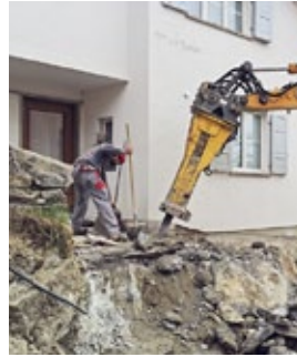
Grobes Geschütz, um den Fels entlang der Telefonleitung abzubauen.
