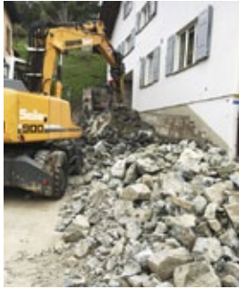
Viel mehr Fels als gedacht erschwerte den Aushub.
