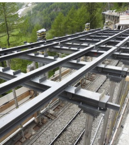
Die Nachtequipe erstellte vier Stahlträgerfelder für die Aufnahme der Schalung.
