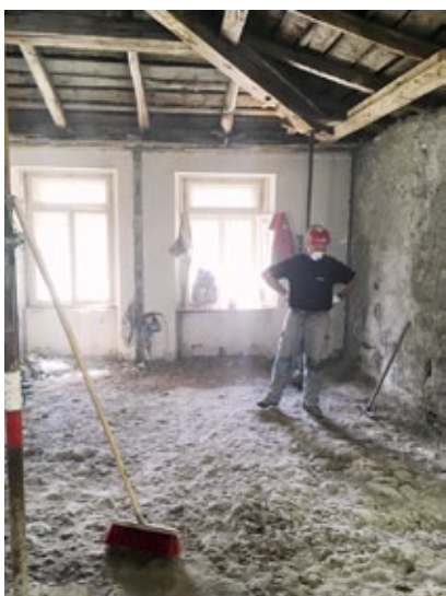
Decke über Untergeschoss bestand aus Natursteinen.
