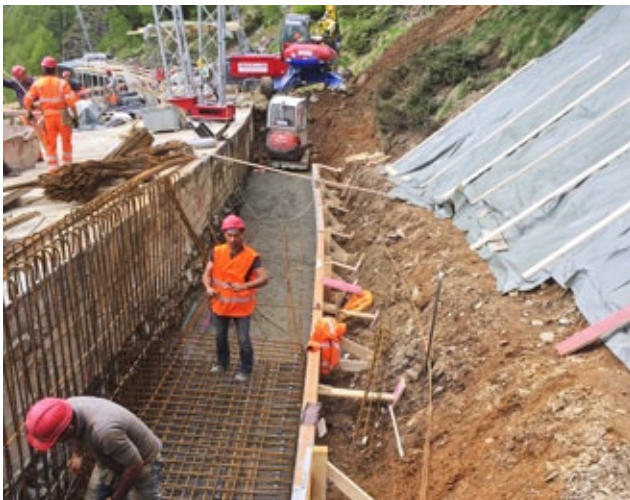
Parallel zur Talseite wurde bergseitig die Winkelmauer vorangetrieben.
