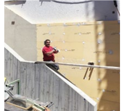
Rocco Raffa beim Erstellen der Aussenisolation.
