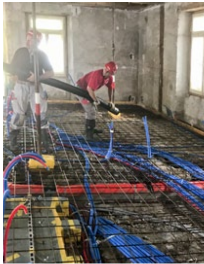
Betonieren mit der Pumpe durch das Dach.
