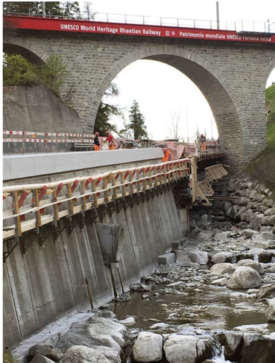
Vor der Brücke wurde der Kordon verlängert.
