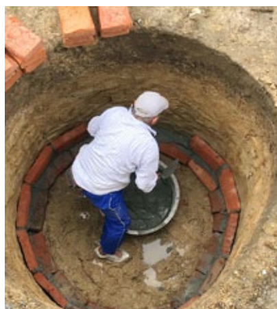
Parallel zu unseren Arbeiten erstellten die Einheimischen die Sickergrube.
