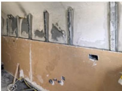
Aus krummen alten Bruchsteinwänden im Untergeschoss werden neu gerade Wände erstellt.
