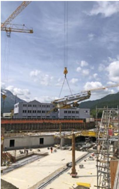
Um die Grosskräne zu entlasten, arbeiteten wir zusätzlich mit einem kleinen Kran, welcher mit den grossen umgestellt werden konnte.
