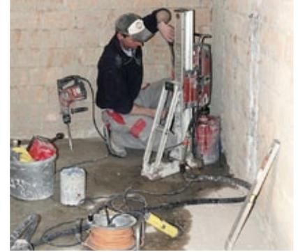
Zum Betonieren erstellte Valter Sala Kernbohrungen durch die Decken.
