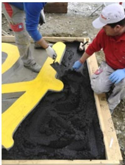
Die fertigen Buchstaben wurden auf den Beton geklebt. Mit einer speziellen eingefärbten Masse wurden die Zwischenräume gefüllt.
