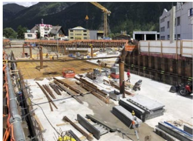
Hier steht man schon auf der Decke über dem 2. Untergeschoss, während zuhinterst noch am Aushub für die letzten Bodenplatte gearbeitet wird.
