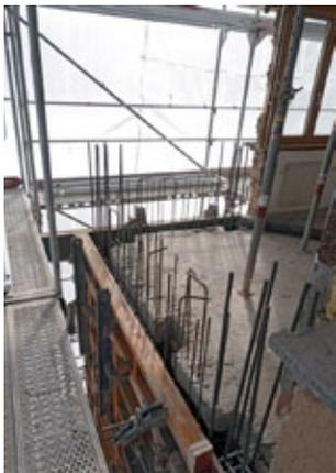
Hier wurde ein Stück Fassade abgebrochen und mit einer Betonwand ersetzt.
