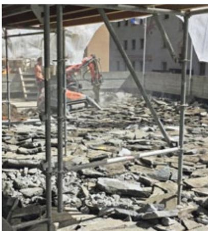
Der Überbeton auf dem Dach wurde mit dem Abbruchroboter gespitzt.
