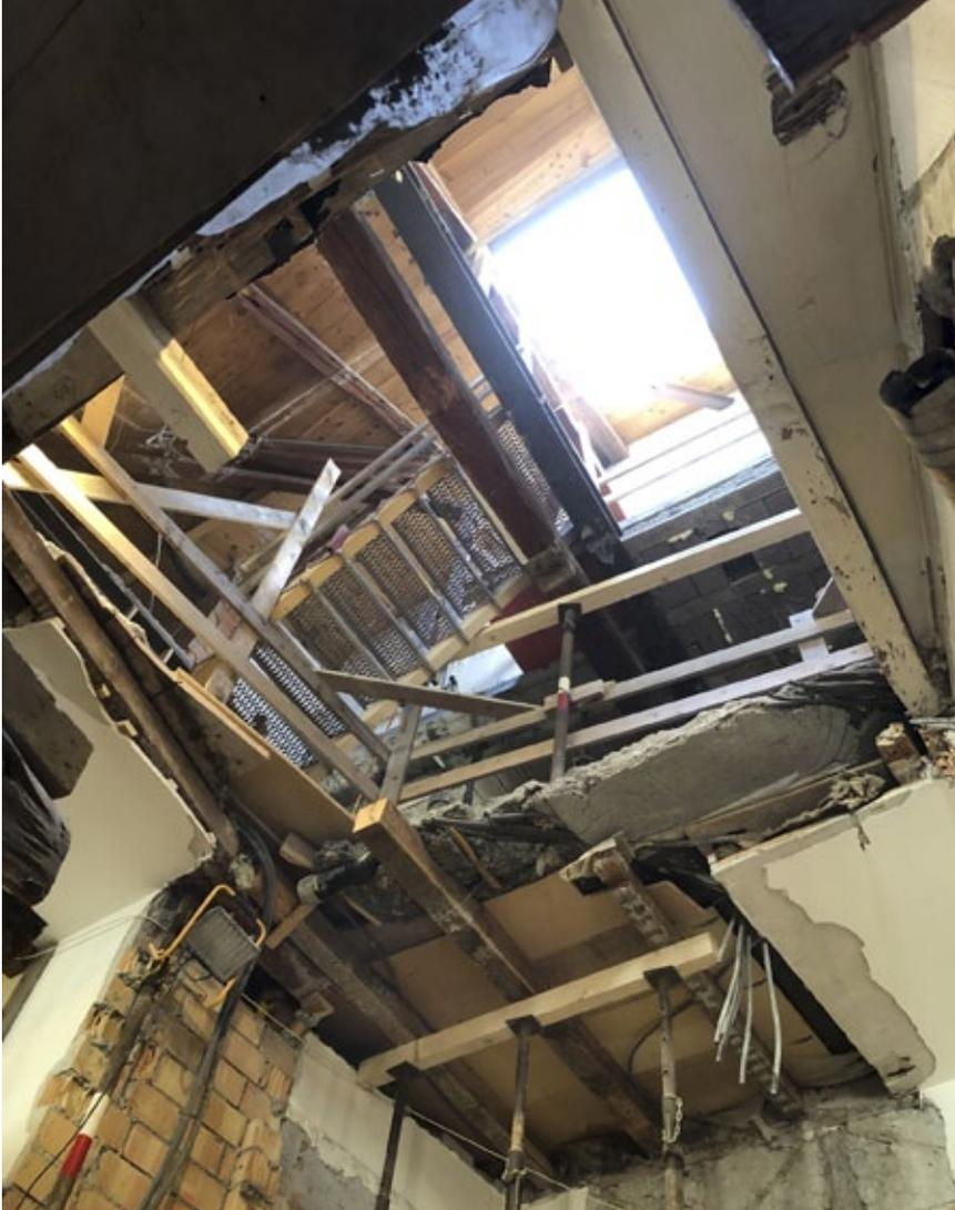
Blick zur Dachöffnung über die verschiedenen Stockwerke. In dieser Öffnung kommt später der Lift zu stehen.
