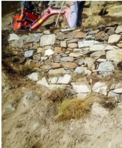
Schicht für Schicht wurden die Trockensteinmauern aufgebaut und alles wieder neu aufgeschichtet.
