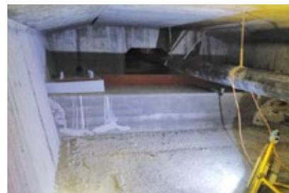
Betonfundament mit untergossener Ankerplatte als Verstärkung im Brückenhohlraum.
