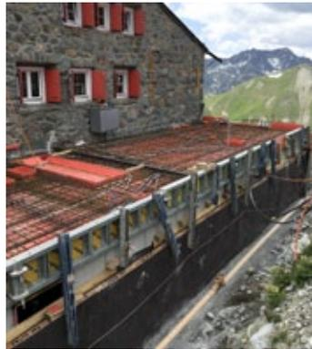
Bereit für die letzte Betonage, Decke über Kellergeschoss.
