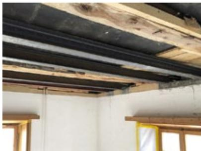
Im 1. Obergeschoss musste die bestehende Holzdecke mit Stahlträgern verstärkt werden.
