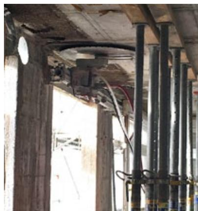
Ganze Wände wurden mittels Fräse entfernt.
