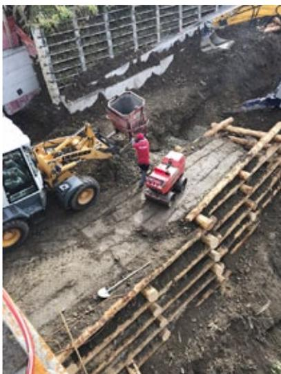
Bergseitig wurde eine Filterschicht aus Kies eingebaut.
