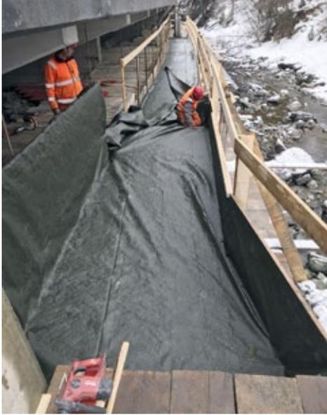
Installation für die Ableitung des Abwassers zur Neutralisationsanlage.
