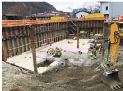
Gut ersichtlich die Spundwand um die Baustelle mit der Ankerreihe, stehend sieht man die Filterbrunnen in welchen Pumpen in den Stahlrohren sind.
