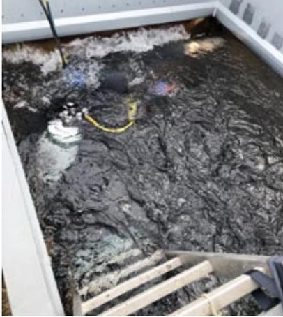
Schnell einmal war das Absetzbecken für das gepumpte Grundwasser zu klein. Ein Spezialtaucher schnitt unter Wasser einen zusätzlichen Ausgang. Das gepumpte Grundwasser war stets glasklar.
