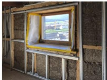
Detail eines Fensters bevor die Profile mit Gipsplatten beplankt werden.
