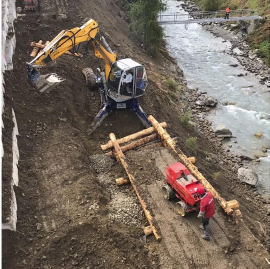
Erstellen der Holzkasten mit gleichzeitigem auffüllen und verdichten.
