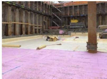
Teils wurde Isolation unter der Bodenplatte verlegt (pink) und um das ganze Gebäude wurde eine wasserdichte Folie durch die Firma Sika AG verlegt (gelb).
