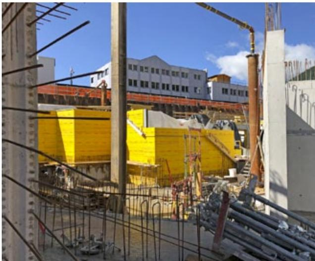
Bei verschiedenen Wänden wurde eine Schaltafelschaltung verlangt.
