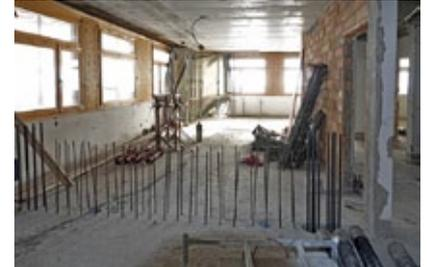
Gut ersichtlich die neue Betonwand die eingezogen werden muss. Die durchgehende Armierung dient der Erdbebensicherheit.
