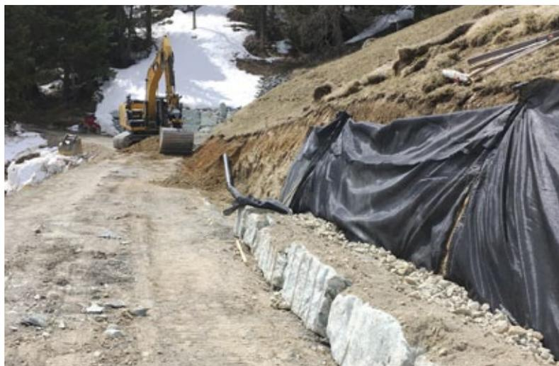
Hinter der Stützmauer wurde ein Sickerrohr in einer Geröllpackung verlegt. Das Geotextil verhindert eine Verschmutzung mit Feinmaterial.
