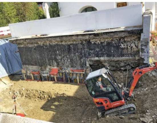
Unterfangung der Garagenbodenplatte.
