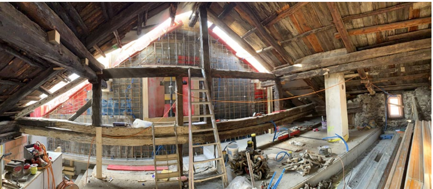
Über der neuen Decke im EG entstand eine neue bis 7 m hohe Giebelwand.
