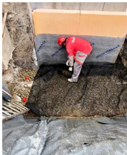
Das Untergeschoss bereit zum betonieren und zugleich abgedichtet, isoliert und hinterfüllt, somit war die Abstellbasis für das Gerüst bereit.
