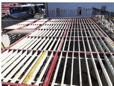
Ausfachen der Rahmen mittels Aluelementen und belegen mit Schaltafeln.
