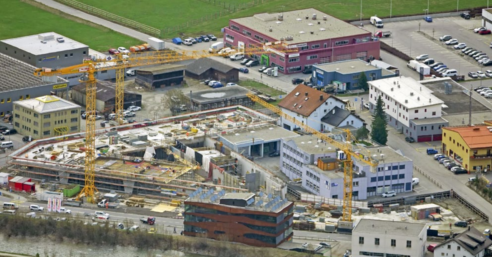
Ein Riesengebäude. Lläuft man einmal der Fassade nach, um den Komplex, so legt man 300 Meter zurück.
