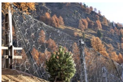
Das Haus wurde durch drei Meter hohe Steinschlagnetze geschützt.
