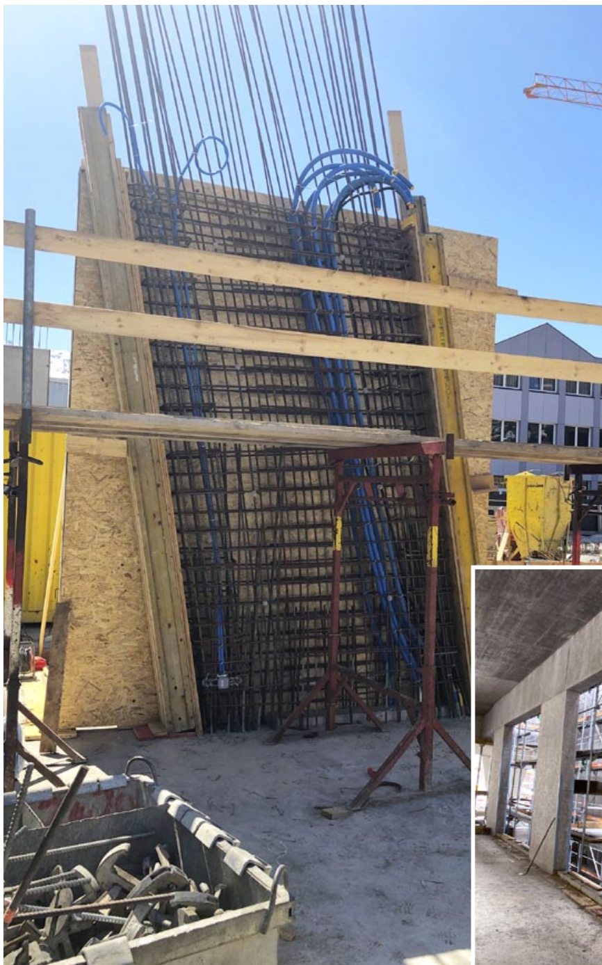
Die Schalungen der Pfeiler wurden mit OSB-Platten belegt um dem Beton eine besondere Struktur zu geben.
