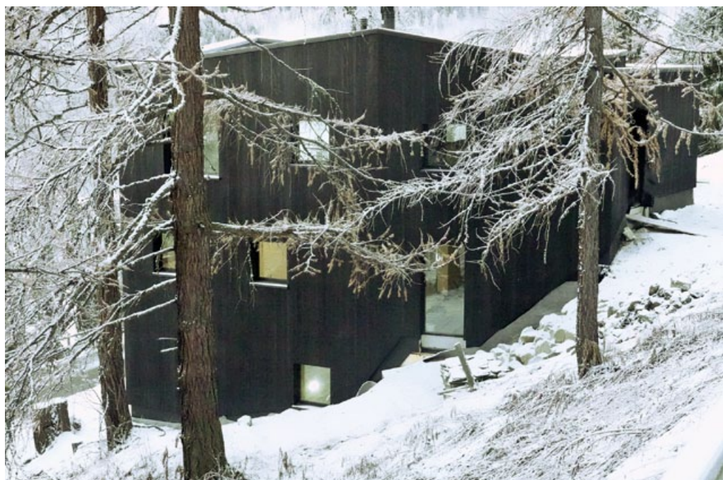
Der fertige Holzbau.
