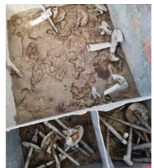
Was von den Fussgängerbrücken noch übrig blieb und was nicht weggeschwemmt wurde steckte in einer Schlammschicht.
