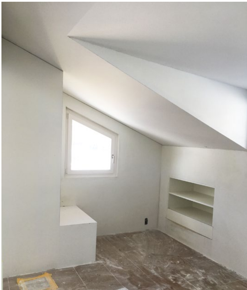
Nicht ganz leichte Verputzarbeit mit diesen vielen Kanten und Ecken.
