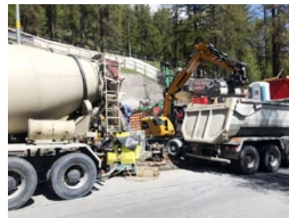
Auf engstem Raum: Aushub abführen, Betonieren ab Fahrmischer und im Hintergrund die Erdsondenbohrungen.
