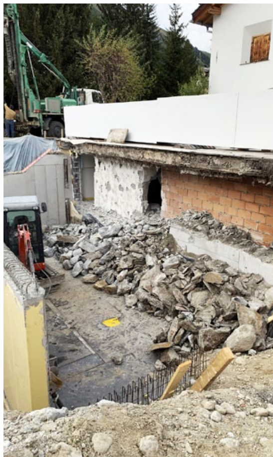
Anschließend wurde die Garagenwand bestehend aus Bruchsteinen, Beton und Backsteinen abgebrochen.
