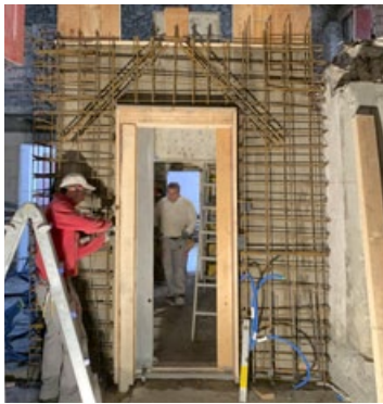
Zusätzlich eingezogene Betonwände wurden zum Teil in Sichtbeton mit Schalbretterschalung ausgeführt.
