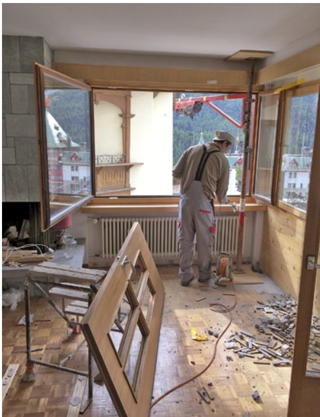
Erste Abbrucharbeiten. Im Hintergrund unser Aussenaufzug.
