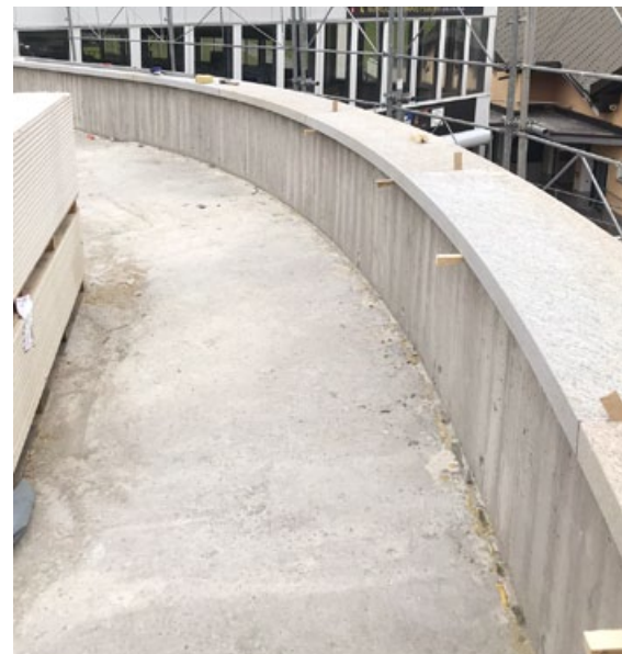
An dieser Brüstung mit Natursteinabdeckung sitzen nun die Skifahrer auf Barhockern ganz unter dem Motto: „sehen und gesehen werden“.
