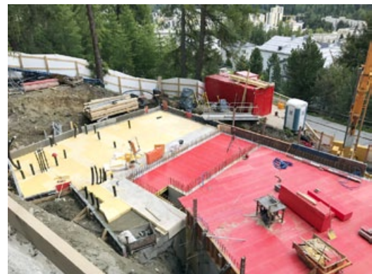
Bereit zum Verlegen der Armierung. Decke über Garage und Bodenplatte Einfamilienhaus.
