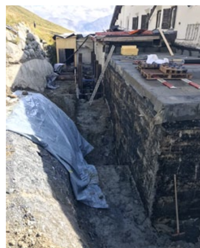
Hinter dem Restaurant wurde eine Perimeter Isolation und eine neue Sickerleitung eingebaut.
