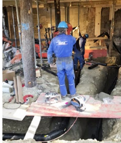
Vor der Bodenplatte mussten noch die Kanalisation und die Erdwärmeleitungen unter Boden gebracht werden. All die vielen Abstützungen erleichterten das Arbeiten nicht gerade.
