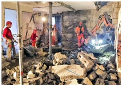
Abbrucharbeiten im Innern mittels Abbruchroboter für die neue Bodenplatte.
