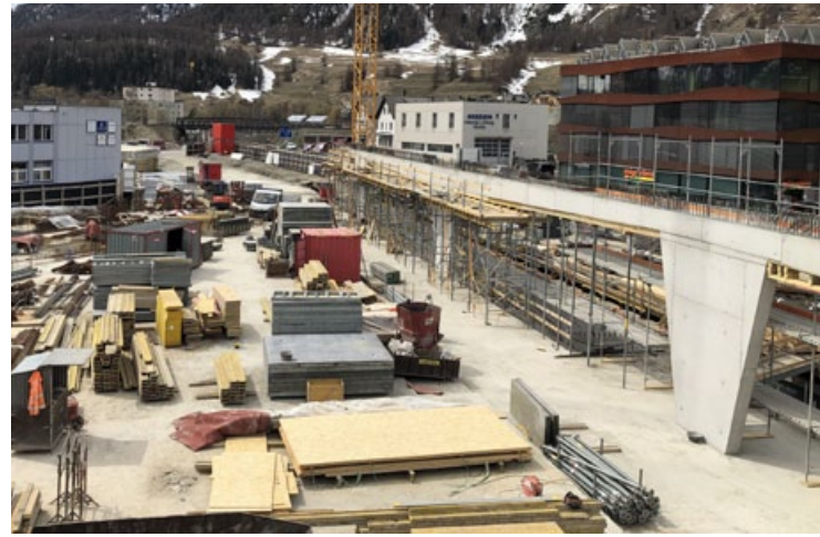
Erste Etappe bereit um mit der Decke nachzuziehen.
