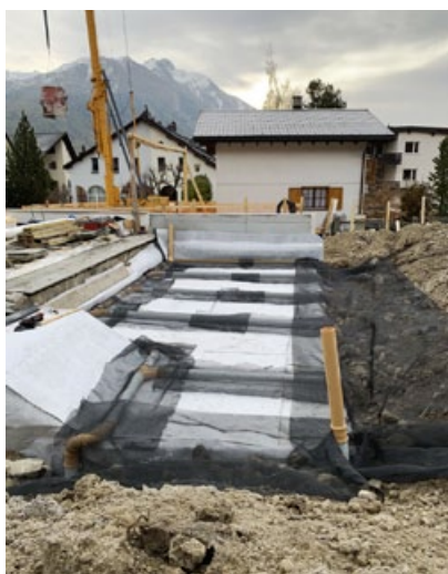
Bereit zur definitiven Eindeckung.
