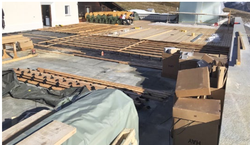
Die obere Terrasse wurde mit Holz beplankt während die Untere mit Belag belegt wurde.
