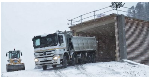
Anlieferung des Koffers für die beidseitigen Rampen.
