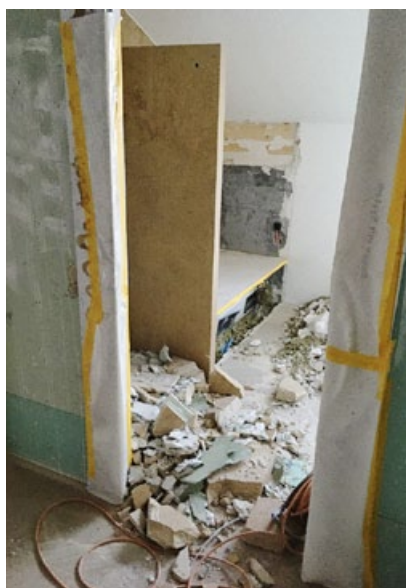
Die Wohnung im Rückbau.
