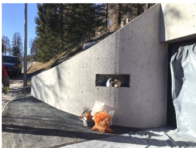
Die fertigen Flügelmauern wurden gestockt. Eine Visitenkarte für die Firma Seiler.
