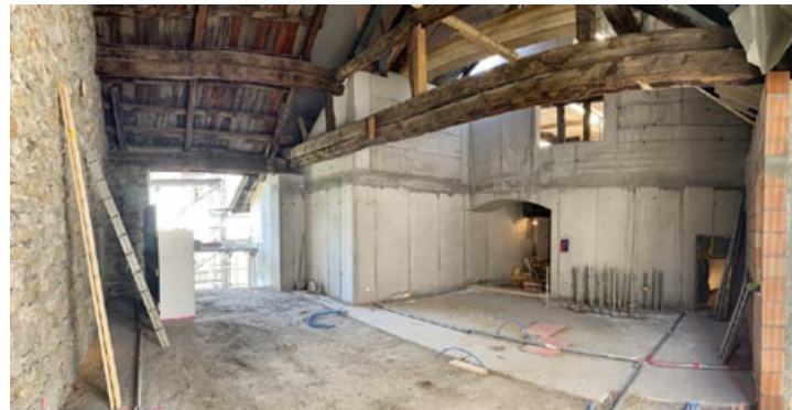
Einige Betonwände im Erdgeschoss sowie im Obergeschoss um das Dach abzufangen.
