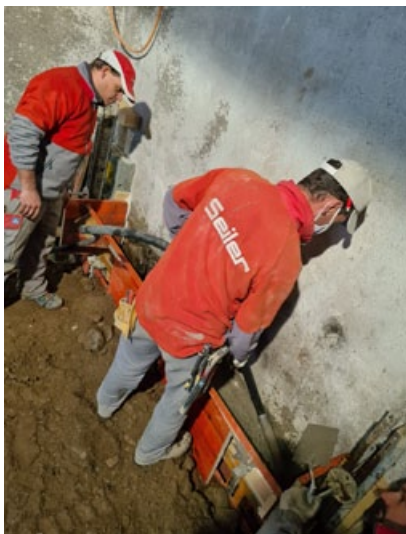
Zuallerst wurden alle Innen- und Aussenwände unterfangen. Vorarbeiter Paulo Jorge Chança Melo (links) überwacht die Arbeiten.
