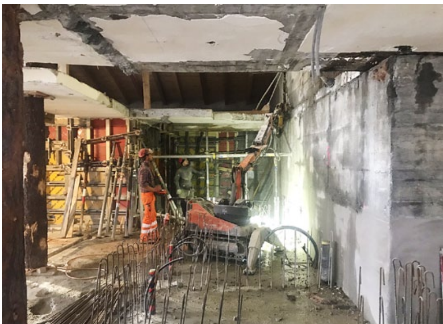
Auf diesem Foto sieht man die Komplexität: Abstützen der alten Decke mittels Baumstämmen, im Hintergrund die Schalung der neuen Betonwände, Abbruch mittels Roboter von unnötiger Decke und die Anschlussseisen verraten was alles noch betoniert werden muss.
