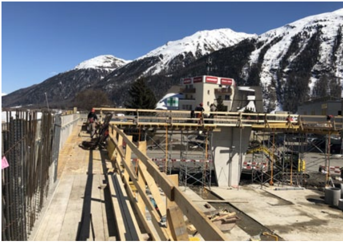
Aufwendige Arbeit bis die Pfeiler mittels Unterzügen verbunden waren.
