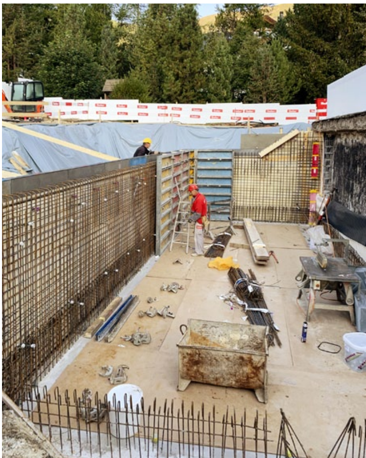
Zuschalen der Wände des Technikraumes.
