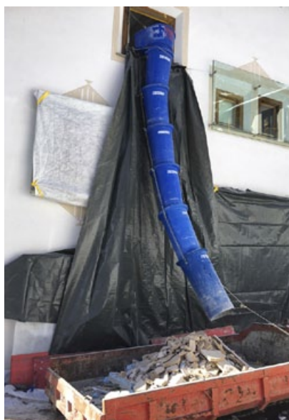
Über Fallrohre wurde der Schutt nach draussen in die Mulden befördert.
