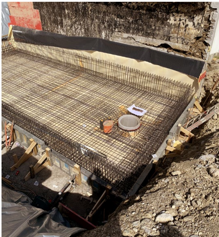
Bodenplatte bereit zum betonieren. Die gelbe Folie garantiert die Wasserdichtigkeit.
