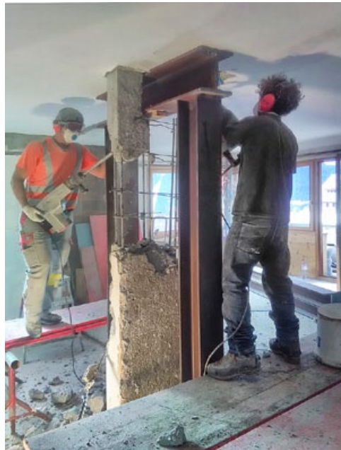
In der Küche der Betonpfeiler welcher entfernt werden musste. Nun neu eine schlanke Stahlstütze anstelle des Pfeilers.
