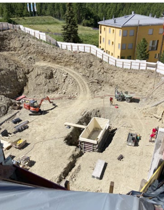
Unsere allererste Betonarbeit betraf den Pumpenschacht, hoffentlich alles richtig eingemessen? Es folgt die erste Bodenplatte 5. Untergeschoss.
