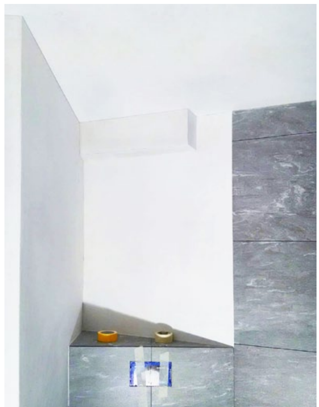
Detailaufnahme Badezimmer, wenn alles wieder frisch verputzt ist.
