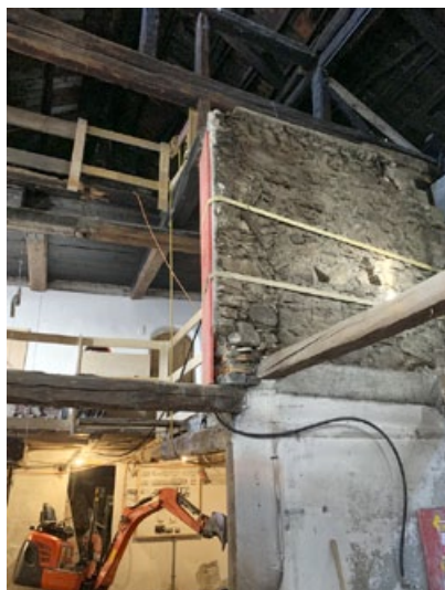
Bestehende Bruchsteinmauern, die erhalten bleiben, mussten geschützt werden.
