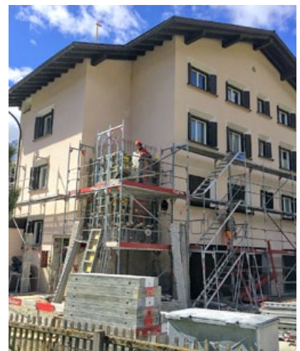
Das Untergeschoss bereit zum betonieren und zugleich abgedichtet, isoliert und hinterfüllt, somit war die Abstellbasis für das Gerüst bereit.
