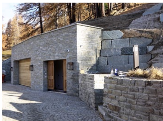
Garage und Zugang wurden mit Natursteinen verkleidet.
