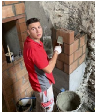
Lehrling Patric Martinho mauert eine Bruchsteinmauercke neu auf.
