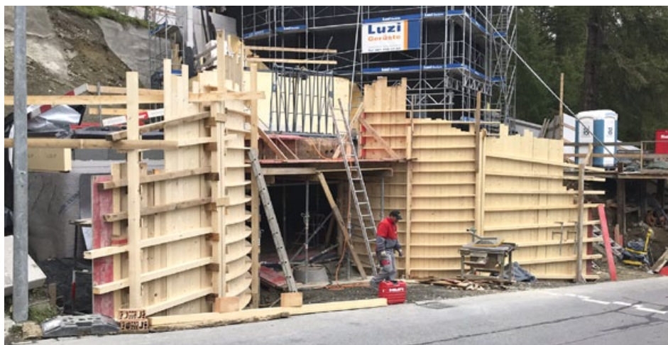
Die gebogenen Betonwände der Garageneinfahrt sind geschalt. Schaler Paolo Pilatti und Polier Massimo Redolatti übernahmen die anspruchsvolle Arbeit.
