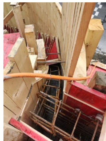
Die gebogenen Betonwände der Garageneinfahrt sind geschalt. Schaler Paolo Pilatti und Polier Massimo Redolatti übernahmen die anspruchsvolle Arbeit.
