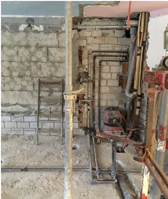
Eine Wohnung in den Rohbauzustand zu versetzen sieht so aus.
