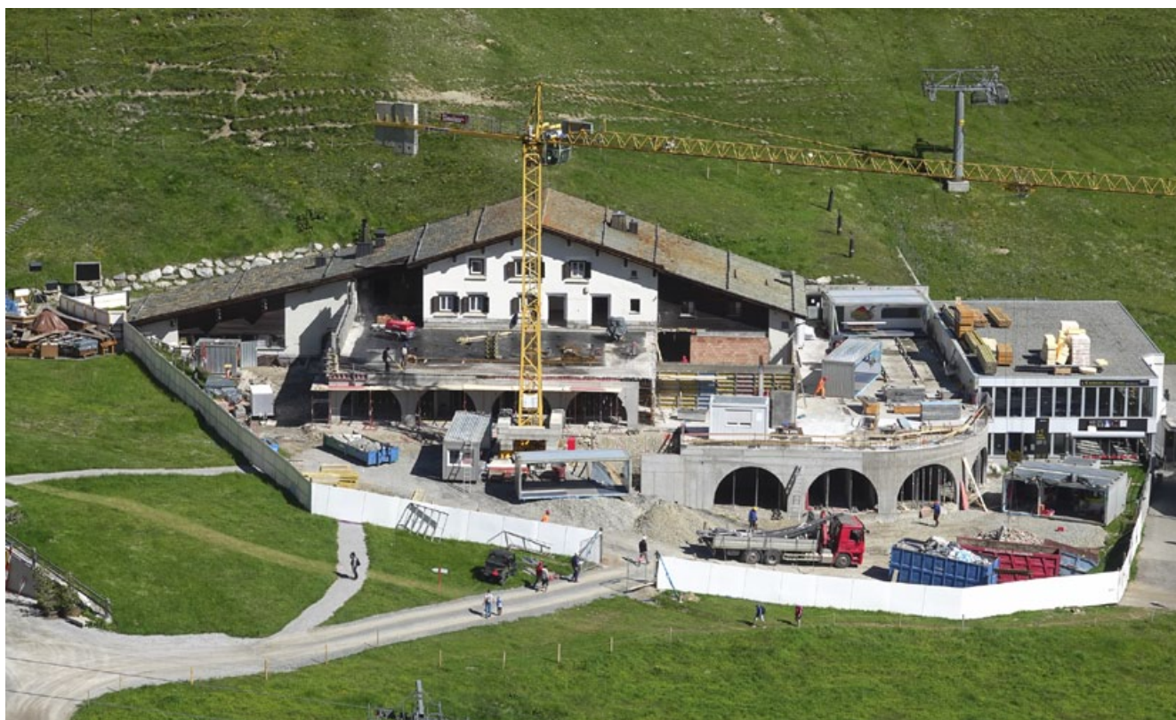
Gut ersichtlich wie an allen Ecken gleichzeitig gebaut wurde.
