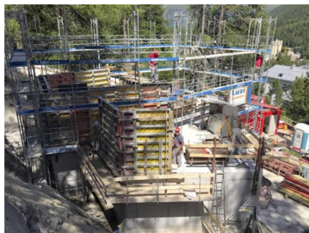
Gerüst bereit für die Lieferung der Holzelemente.
