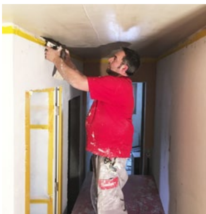
An den Decken erstellen wir einen Glattputz, im Bild Cosimo Raffa.
