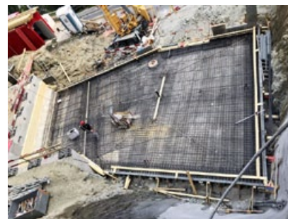
Bodenplatte der Garage bereit zum Betonieren.
