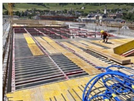
Ausfachen der Rahmen mittels Aluelementen und belegen mit Schaltafeln.
