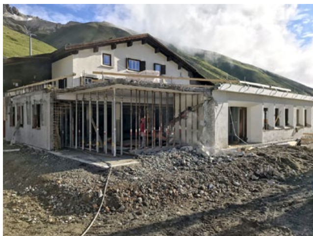
Abbruch der alten Fassade und Abspriessung der Betondecke.
