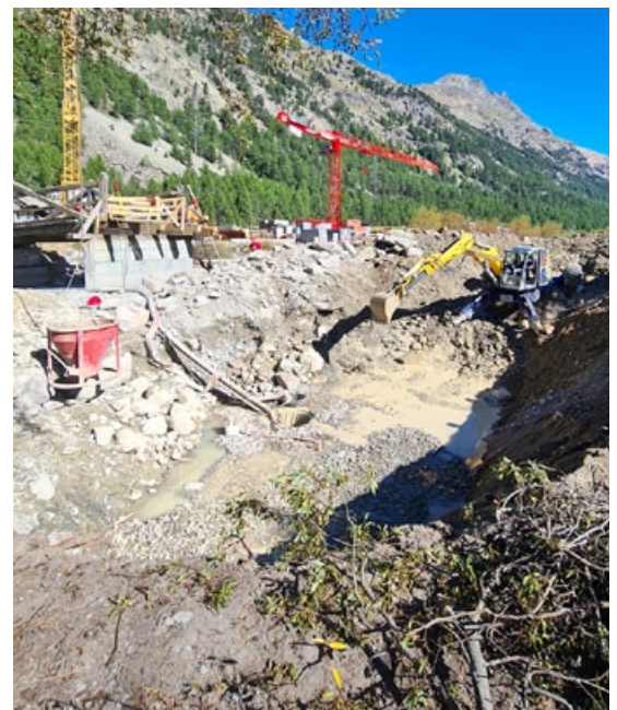
Ganz ohne Wasser ging dann der Aushub doch nicht.
