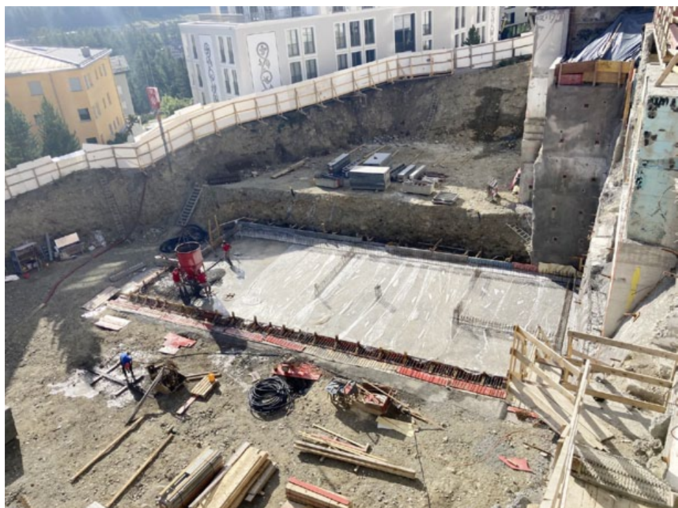
Unsere allererste Betonarbeit betraf den Pumpenschacht, hoffentlich alles richtig eingemessen? Es folgt die erste Bodenplatte 5. Untergeschoss.
