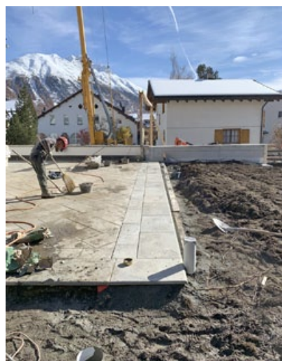
Die Randplatten der Terrasse mussten ersetzt werden.
