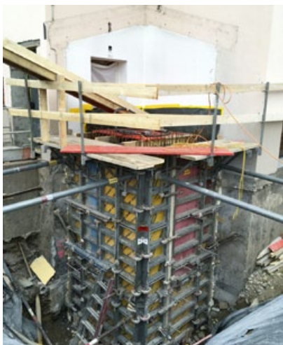
Das Untergeschoss bereit zum betonieren und zugleich abgedichtet, isoliert und hinterfüllt, somit war die Abstellbasis für das Gerüst bereit.
