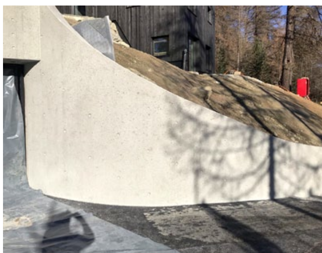
Die gebogenen Betonwände der Garageneinfahrt sind geschalt. Schaler Paolo Pilatti und Polier Massimo Redolatti übernahmen die anspruchsvolle Arbeit.
