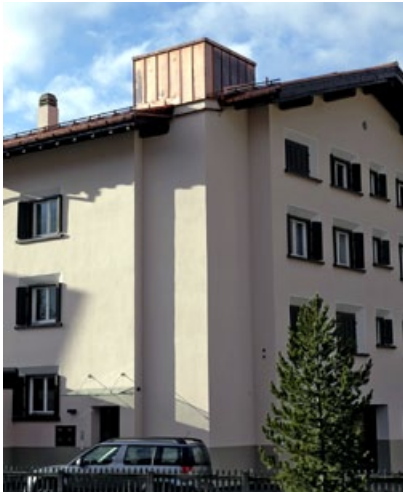
Der neue Liftanbau ist fast nicht zu erkennen.
