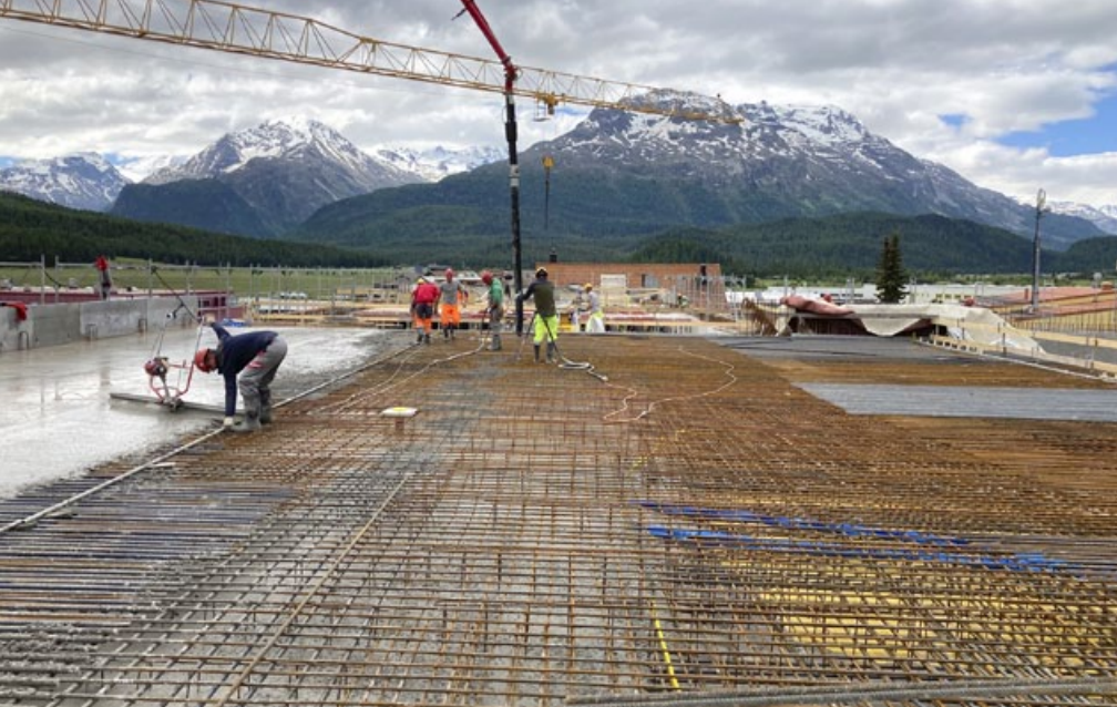
Was für ein schöner Arbeitsplatz! Insgesamt haben wir 16'000 m 3 Beton verbaut.
