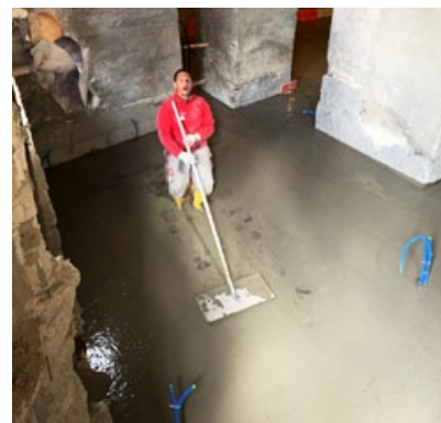
Eigentlich sollte man beim Abtalschieren am Schluss nicht in der Mitte stehen :)
