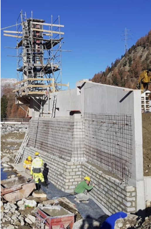
Nachdem die imposanten Widerlager mit Natursteinen verkleidet wurden, war alles bereit für den Holzbau.
