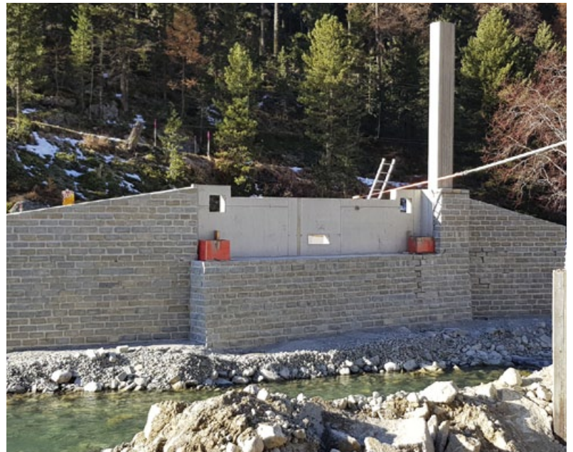
Nachdem die imposanten Widerlager mit Natursteinen verkleidet wurden, war alles bereit für den Holzbau.
