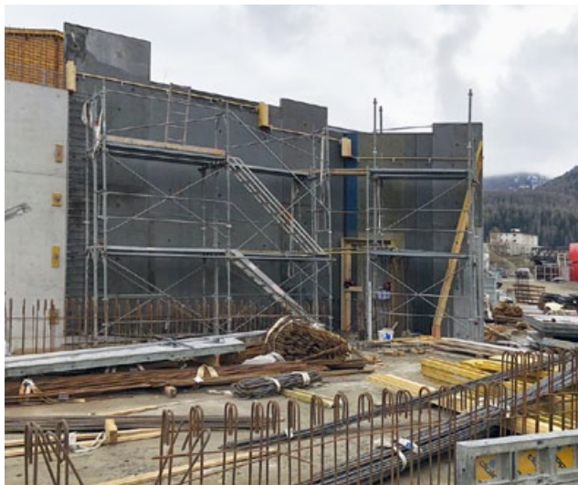
Wandhöhen über fünf Meter verlangten jedes Mal ein Kerngerüst zum Schalen, Armieren und Betonieren.
