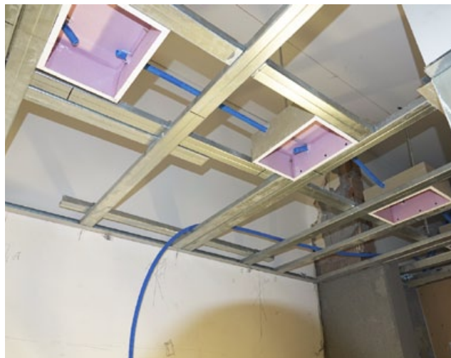
Der Raster für die abgehängte Decke ist erstellt.
