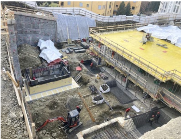
Das Ziel wäre gewesen möglichst viel von den letzten Etappen des 4.+ 5. Untergeschosses vor dem Winter zu erstellen.
