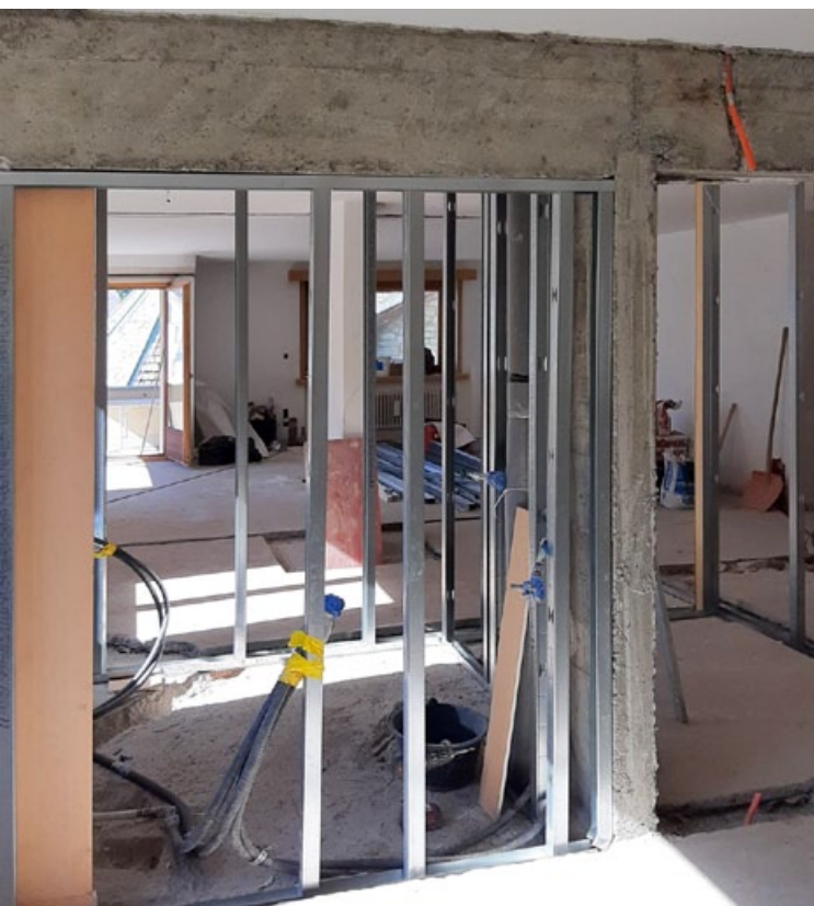
Innenwände wurden teilweise mit Gipskarton erstellt.
