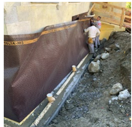
Aussen am Gebäude wurde die Bruchsteinmauer unterfangen, saniert und isoliert. Zusätzlich erstellten wir noch eine Sickerleitung.
