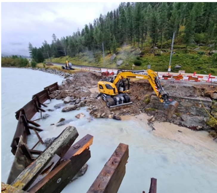
Die allerersten Arbeiten galten dem Wasser. Der Fluss wurde in ein engeres Korsett gedrängt.
