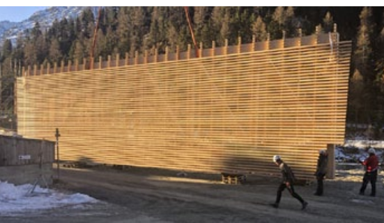
Ein erstes Holzelement wird gesetzt.
