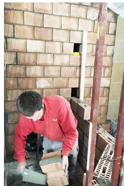
Daniel Crameri beim Aufmauern der Dusche.
