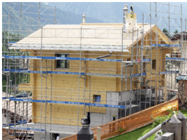
Die Firma Ruwa Holzbau aus Küblis ist für den Strickbau und den Innenausbau verantwortlich.
