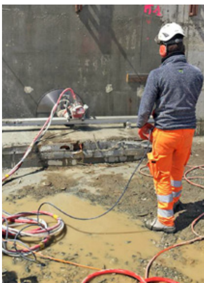
Die Verbindungstüre zur Garage wurde ausgefräst.
