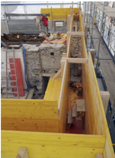
Nicht ganz einfach zum Schalen, Armieren und Betonieren.
