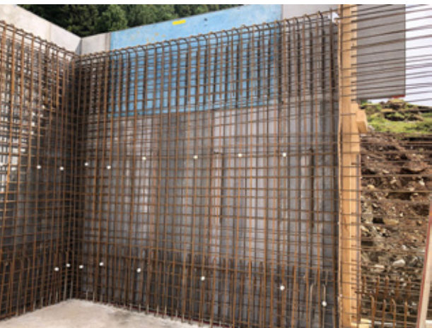
Wände in Etappen perfekt armiert und geschalt.
