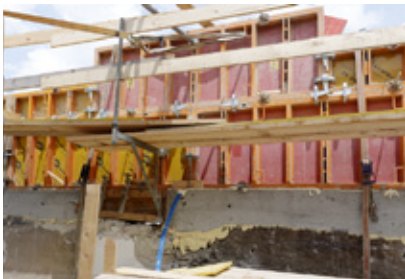
nach Entfernen des Daches brauchte es neue Giebelwände.
