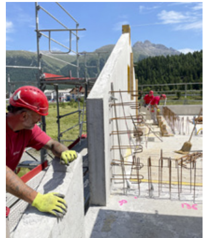
Vorarbeiter Nino Lorenzoni überwacht die Arbeiten.
