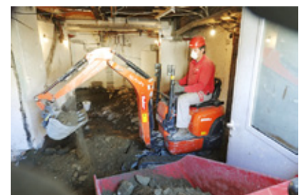
Im Innern und Aussen, sowie im hinteren Teil wurde alles unterfangen.
