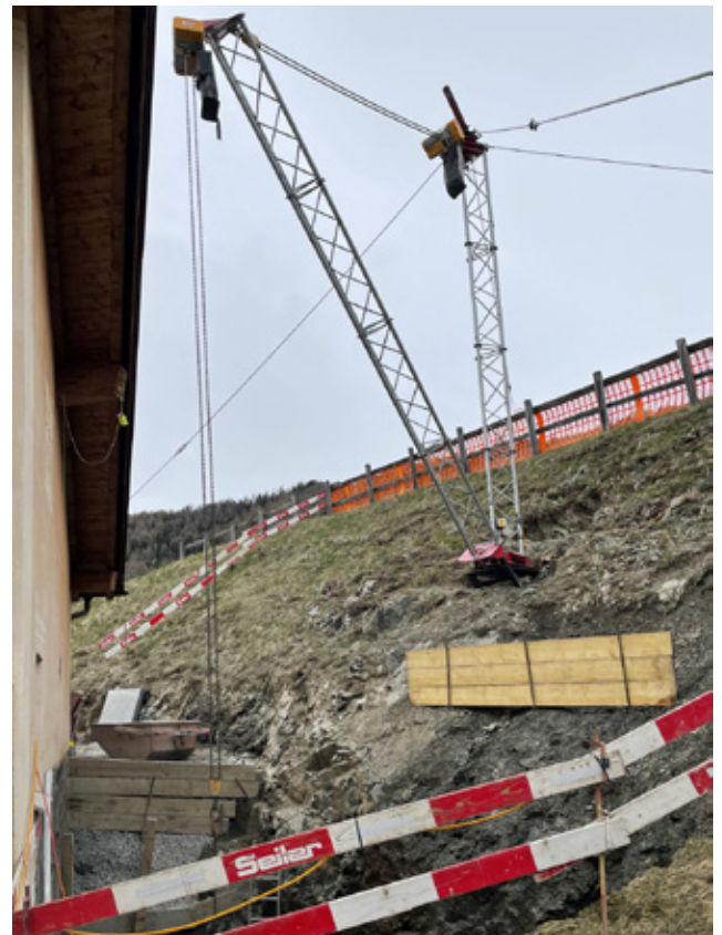
Der Schafbergkran konnte schon mehrmals in schwierigem Gelände eingesetzt werden.
