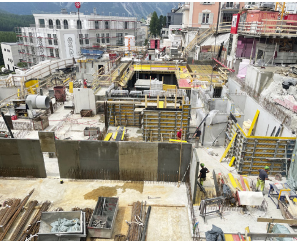
Die Komplexität und die Grösse der Baustelle ist hier gut ersichtlich.
