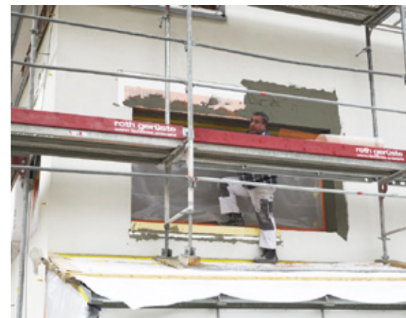
Rocco Raffa verantwortlich für das Verputzen der Fassade.
