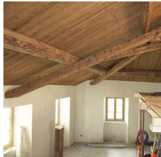
Teile der alten Dachkonstruktion wurden nachträglich von unten an das neue Dach befestigt. Es entstand eine wunderschöne Dachwohnung.
