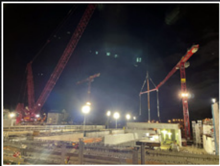
Während 22 Nächten wurden unter Flutlicht die Träger versetzt.
