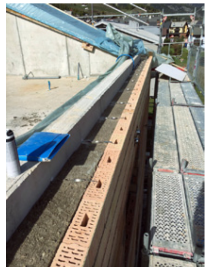
Das Zweischalenmauerwerk ist erstellt, es fehlt aber noch das Dach.
