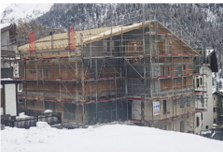
Die Baustelle geht bald in den verdienten Ruhestand.
