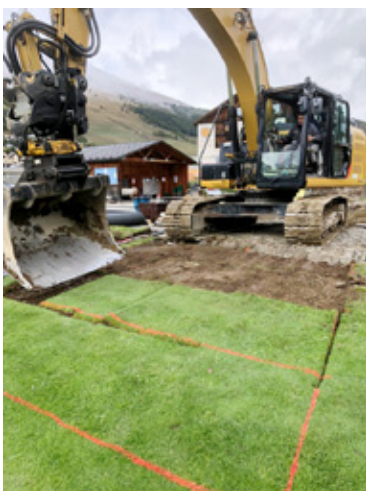
Die Grasziegel auf dem Golfplatz Zuoz wurden durch Antonio Gossi Stück um Stück entfernt und seitlich deponiert.
