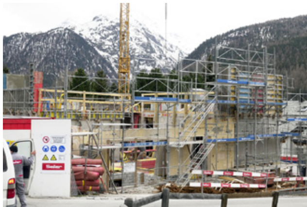
Schritt für Schritt wurde alte Substanz mit der Neuen verbunden.
