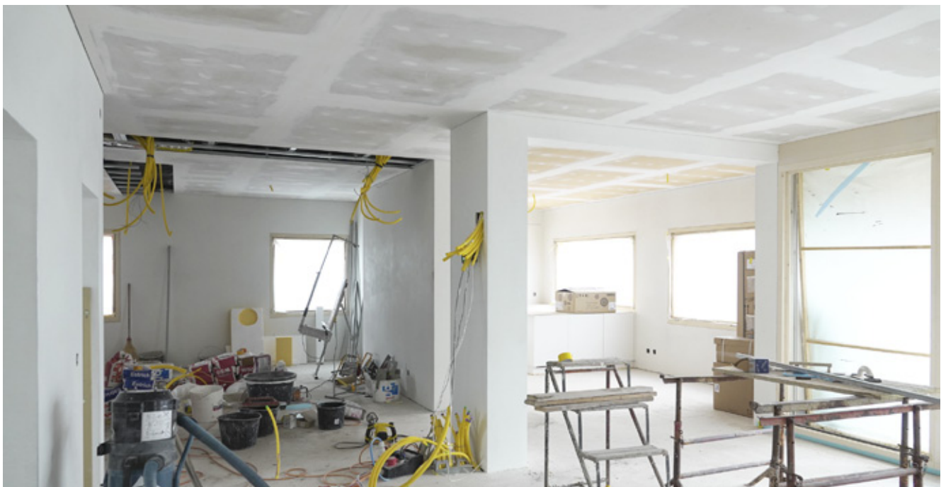
Im Erdgeschoss sind die Gipserarbeiten in vollem Gange. Nun fehlt nur noch der Glattputz an der Decke.
