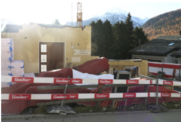
Die Fassade die gegen die Strasse steht musste bleiben. Hoffentlich wurde nicht noch Post geliefert.
