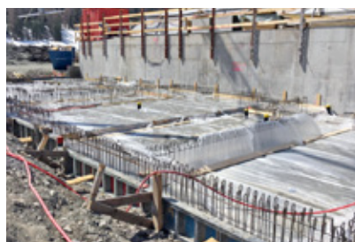
Bodenplatte frisch betoniert.
