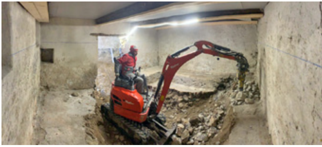
Mit einem Kleinbagger spitzten wir die alten Fundationen und erstellten den Aushub für die Unterfangungen.
