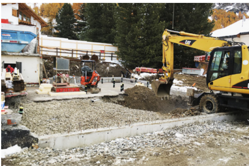
Als wir die Bodenplatte betonieren wollten, kam es auf Wunsch des Bauherrn zu einer Änderung. Ein Technikraum und ein kleines Bad wurden neu unter das Untergeschoss gebaut. Das hiess nochmals mit Aushub beginnen.
