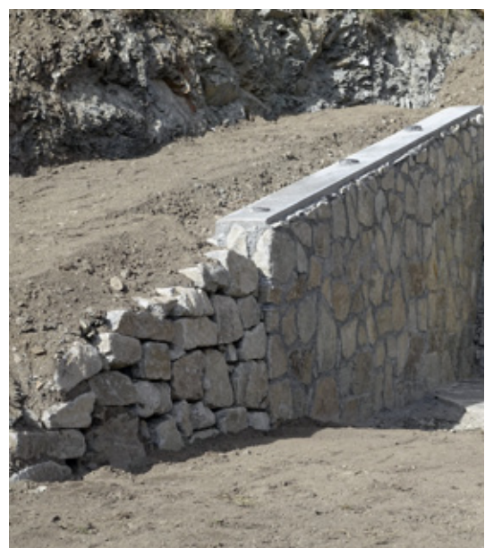
Aussensitzplatz mit ergänzter Stützmauer.
