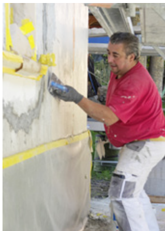
Rocco Raffa am Verputzen der Fassade und frisch verputzt mit dem alten Sgraffito.
