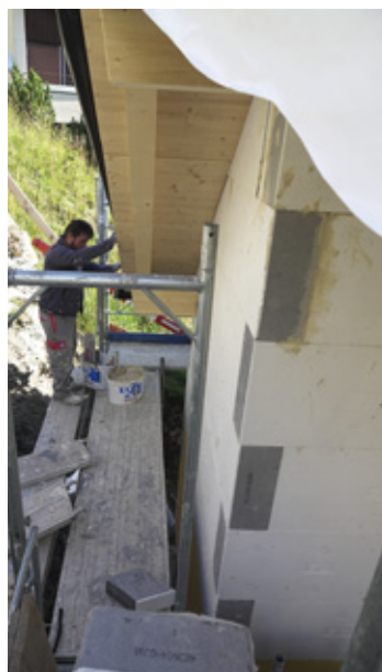
Unsere Gipser erstellen die Aussenisolation und die Verputzarbeiten.
