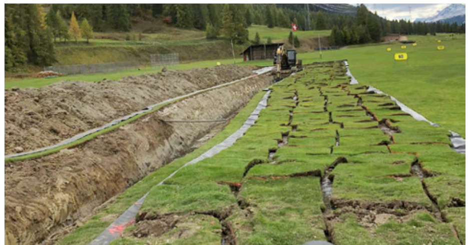
Die Grasziegel auf dem Golfplatz Zuoz wurden durch Antonio Gossi Stück um Stück entfernt und seitlich deponiert.
