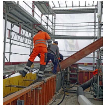
Als letzte Arbeit im Jahr 2021 wurden die Brüstungen im Erdgeschoss (auf gleicher Höhe wie die Via Maistra) unter dem beheizten, eingepacktem Gerüst betoniert.
