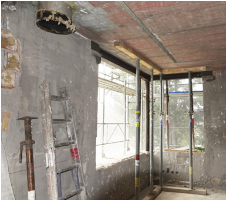
Das verstehen wir unter Rückbau, alle Verputze, Fenster und Unterlagsboden entfernt.
