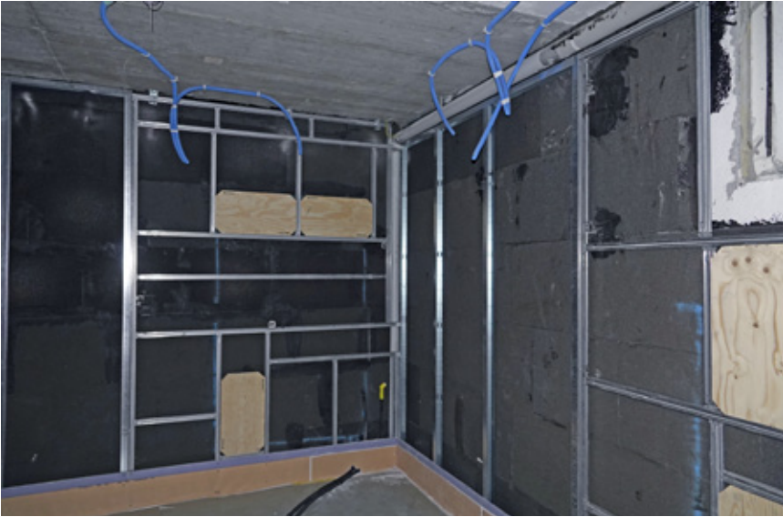
Ständerwände auf Foamglasisolierung.
