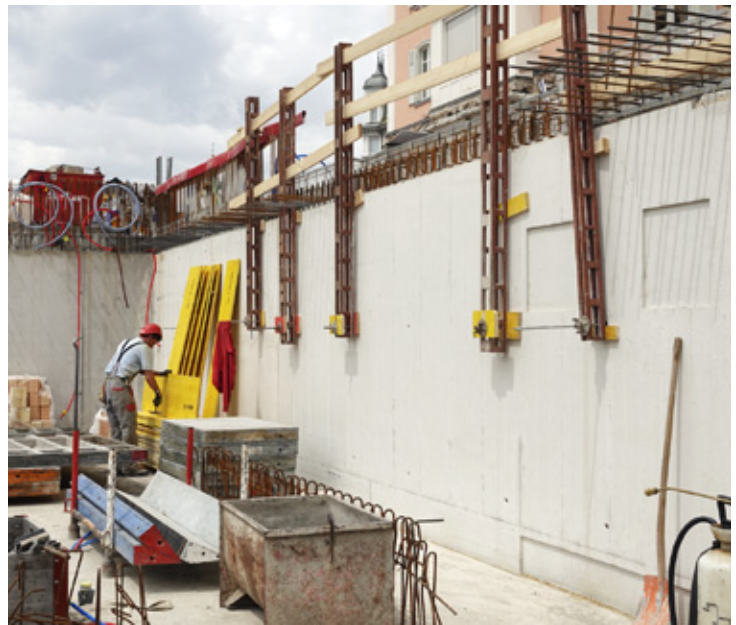
Fertige Sichtbetonwand mit Einlagen.
