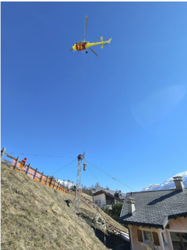
Das Setzen des „Schafbergkrans“ mittels Heli Bernina.
