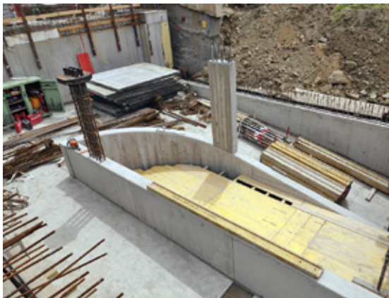
Noch weist der Sichtbeton der Garageneinfahrt keine Stossstangenspuren auf.
