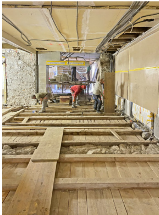
Die freigelegte Holzbalkendecke des Erdgeschosses.
