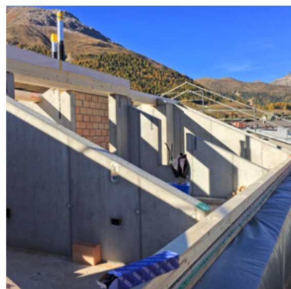
Perfekte Betonarbeit im Dachgeschoss.
