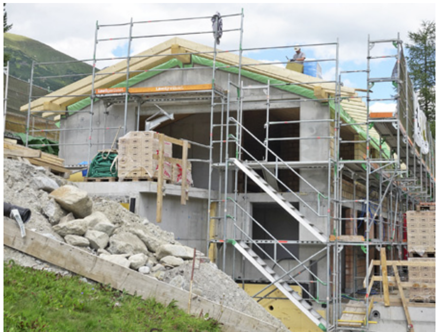
Fertig aufgerichtet. Grosses Panoramafenster im Dachgeschoss.
