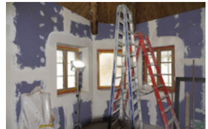
Viel Arbeit für die Gipser, welche alle Wände dämmten, beplankten und verputzten.
