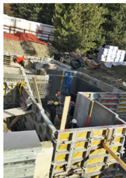
Bad und Technikraum sind nun erkennbar.
