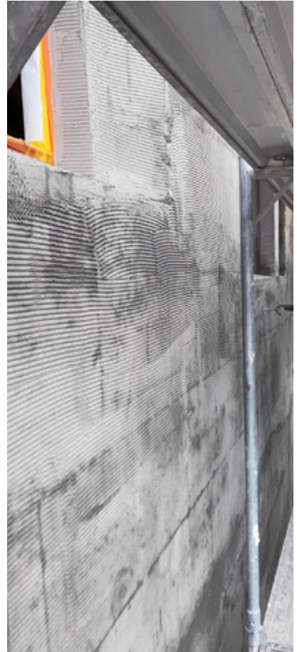
Das Haus wurde komplett neu verputzt, ebenfalls mit eingebettetem Kupfernetz.
