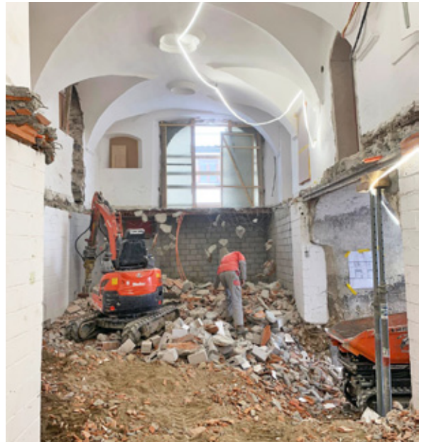
Abbruch der Innenwände und der Decke über Untergeschoss.
