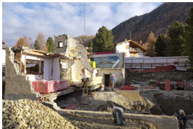
Das neue Einfamilienhaus musste später mit dem stehen gelassenen Teil verbunden werden.
