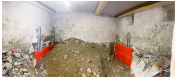
Mit einem Kleinbagger spitzten wir die alten Fundationen und erstellten den Aushub für die Unterfangungen.
