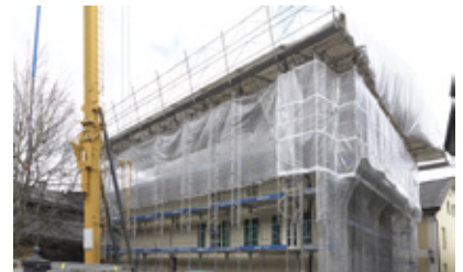
Die Chesa San Bastiaun wurde komplett eingepackt und über dem Haus erstellte man ein Notdach.
