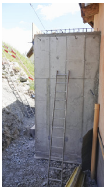
Der Lift ist erstellt und hinterfüllt.
