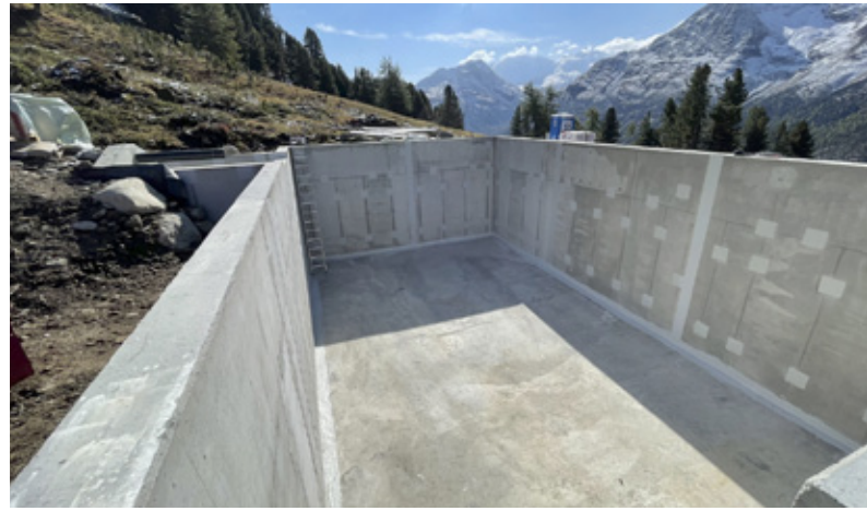
Fertiges Becken mit abgedichteten Fugen und Bindstellen.
