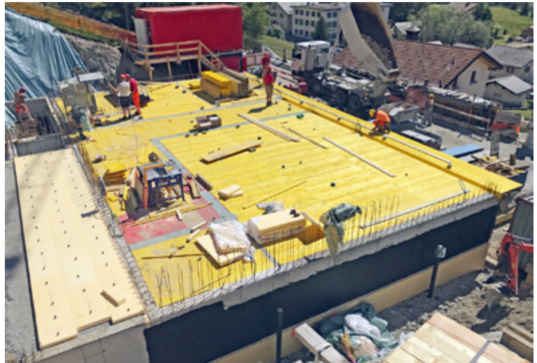
Decke über Kellergeschoss.
