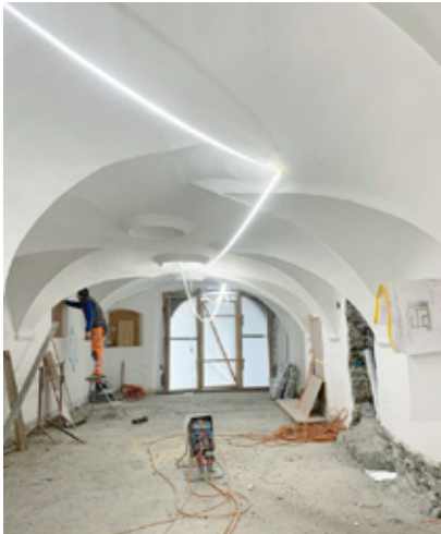
Der Sulèr bleibt nach Einzug der Decke über Untergeschoss so erhalten.
