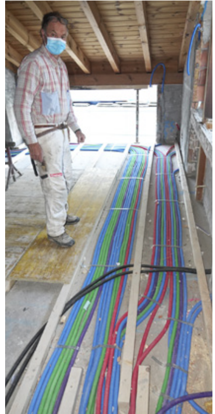
Perfekt verlegte Elektrikerrohre.
