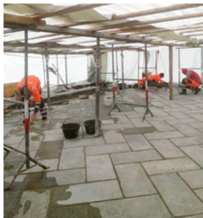
Am 9. Dezember sind unsere Mitarbeiter noch am erstellen des Terrassenbodens.
