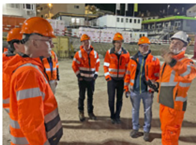
Chefbauleiter Oskar Seger (Seger Ingenieur GmbH) führte kompetent über die Baustelle.
