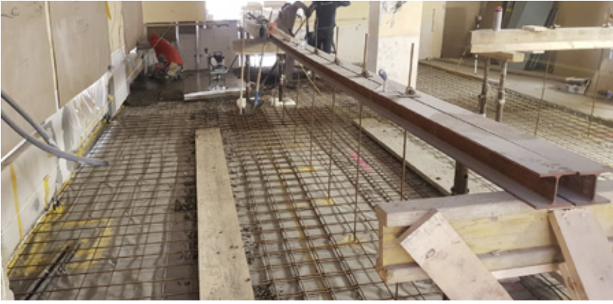
Decke nach oben aufgehängt an Stahlträgern.
