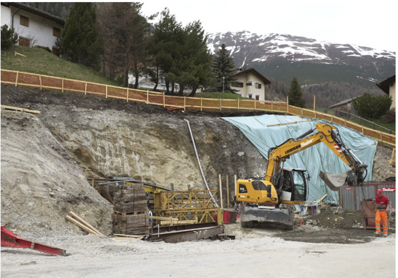
Der Aushub ist vollbracht. Bis der Kran steht, arbeiten wir mit dem Pneubagger als Hebegerät.
