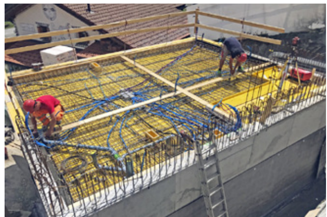
Decke über Geschoss minus 2 kurz vor dem Betonieren.
