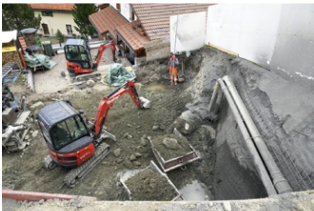
Die umgelegten Kanalisations- und Meteorleitung führen knapp am Haus vorbei. Der letzte Teil des Aushubes musste mit Aushubkübeln auf die obige Zufahrtsstrasse gebracht werden.
