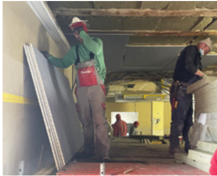
Das Isolieren und Anbringen der LaPlura Platten war mit all den Rohren alles andere als einfach.
