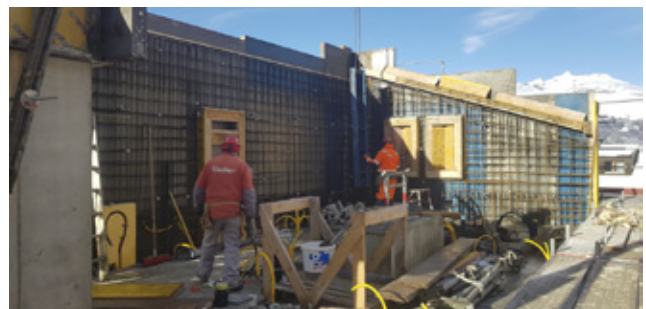
Die letzten Giebelwände kurz vor dem Betonieren.
