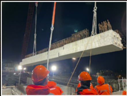
186 solche vorfabrizierte Träger wurden total versetzt.
