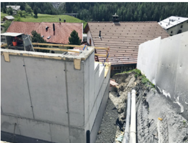
Unser Teil des Vertrages ist praktisch beendet, das Gerüst und der Holzbau können aufgerichtet werden.
