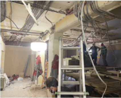
Das Isolieren und Anbringen der LaPlura Platten war mit all den Rohren alles andere als einfach.
