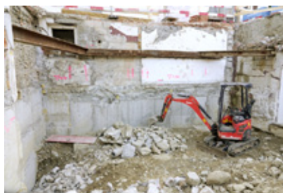
Im Innern und Aussen, sowie im hinteren Teil wurde alles unterfangen.
