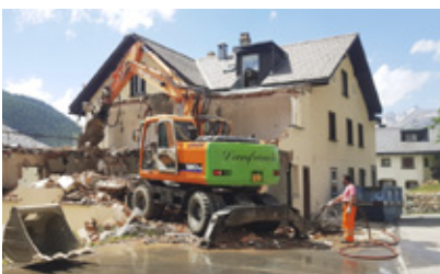
Für den Abbruch arbeiteten wir mit der Firma Lanfranchi zusammen.
