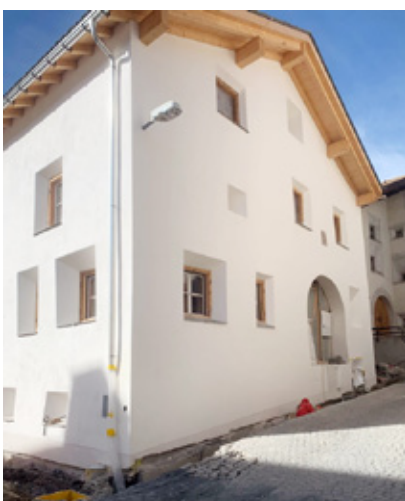
Chesa Lendi, es fehlt die Eingangstreppe und die Schroppenpflästerung. Die Strassenlaterne passt wohl nicht so recht.
