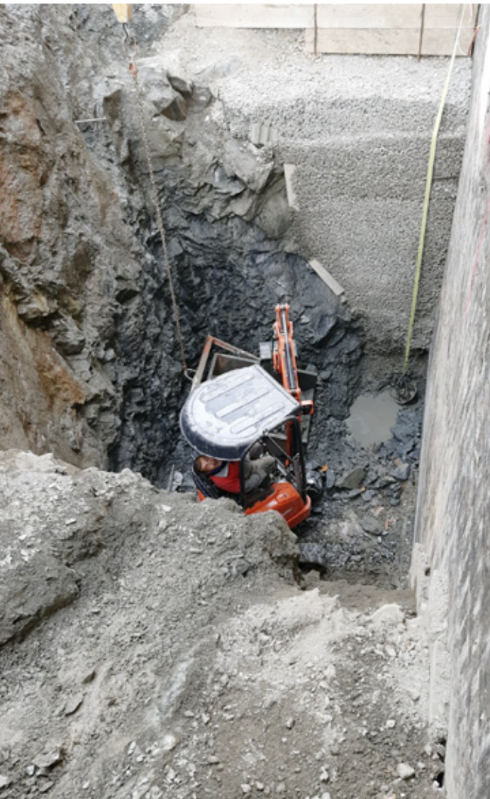
Zum Glück befand sich der Aushub im Fels.
