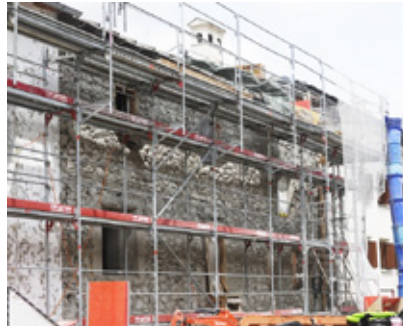
Die alten Engadiner Häuser sind alle mit Natursteinen gemauert, meist war der Steinbruch nicht weit weg vom Dorf.
