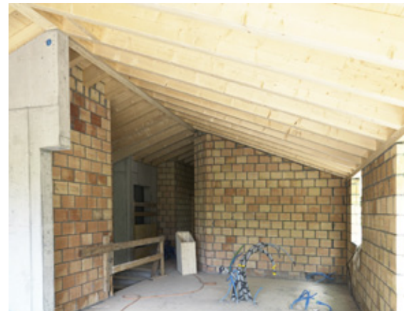
Hier wird später die Küche stehen.
