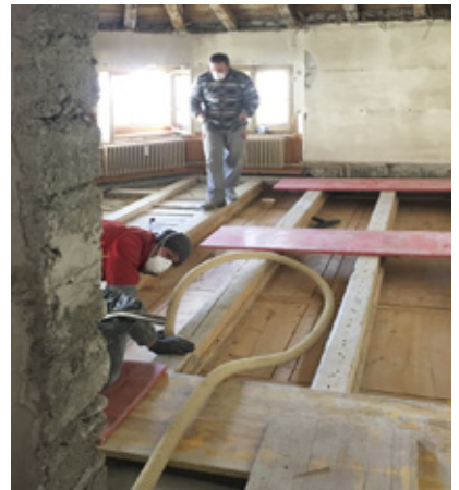
Freigelegte Holzbalkendecke vor dem Dämmen und Erstellen des Überbetons. Gut ersichtlich die Kassettendecke vom unteren Stock.
