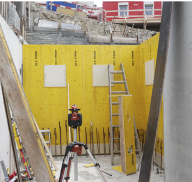
An vielen Orten werden Einlagen im Sichtbeton verlangt.
