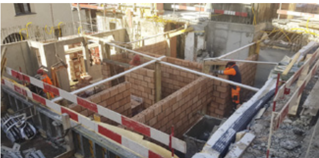
Je länger je weniger wird mit Backsteinen gemauert, hier im Verbindungstrakt zur Garage.
