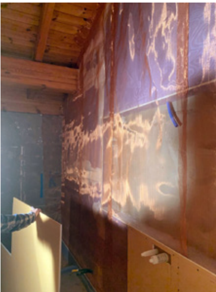
Alle Wände und Decken wurden mit einem Kupfernetz versehen, um Strahlungen von aussen zu eliminieren.
