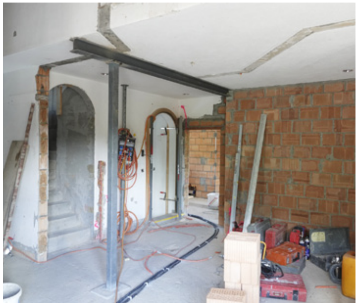
An der Decke ist ersichtlich, welche Wände wir abgebrochen haben und wie wir die Lasten mittels Stahlträger und Stütze abfangen.
