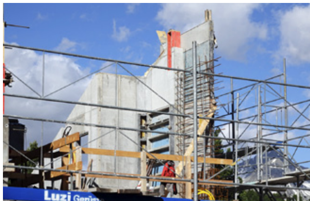
Die Giebelwände entstehen.
