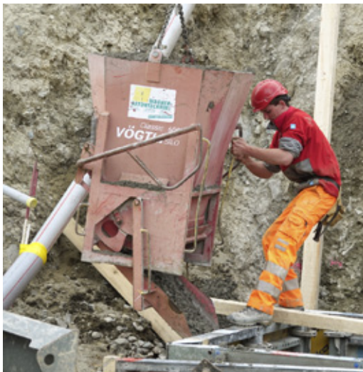
Unser Lehrling Patrick Crameri betoniert die Liftunterfahrt.
