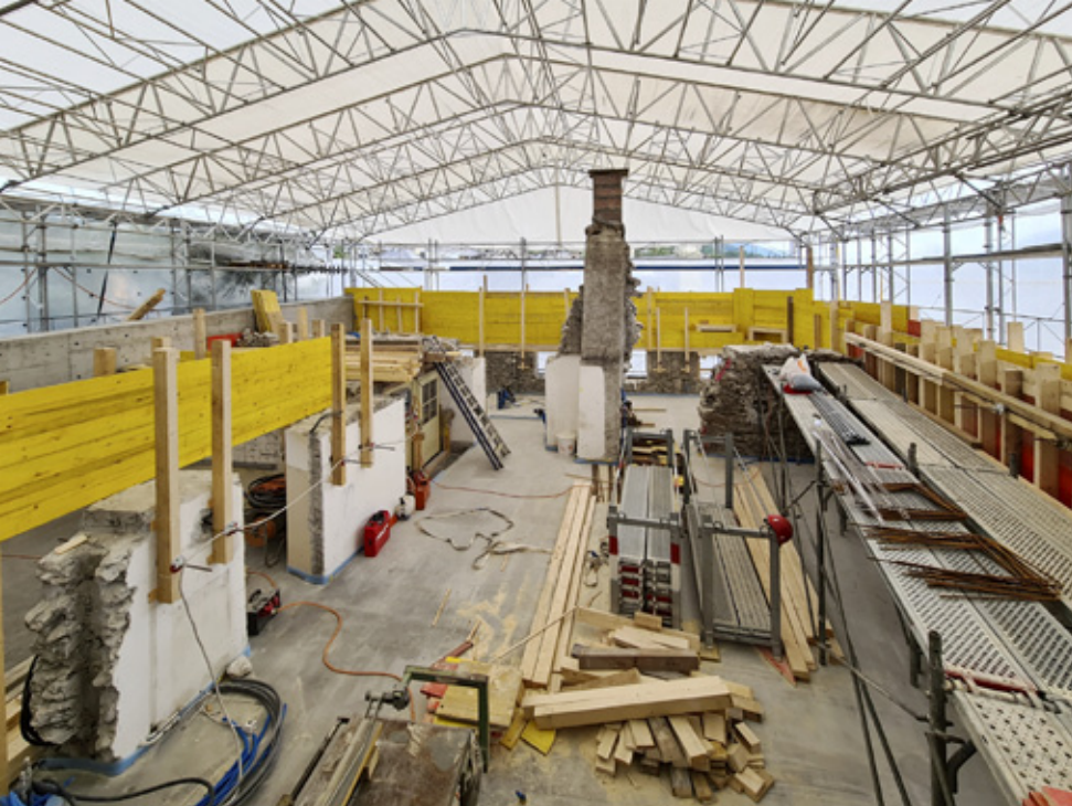
Das Dach wurde nun entfernt und wir begannen mit der Schalung der Aufstockung der Bruchsteinwände.
