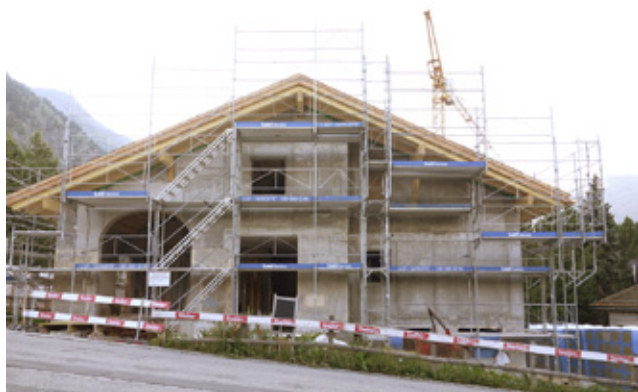
Fertige Chesa Dimvih vor und nach dem Anbringen der Aussenisolation.
