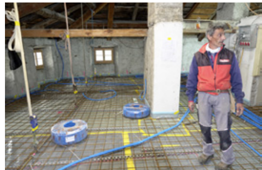
Polier Dario Giudici kurz vor dem Betonieren, die bestehenden Holzbalken wurden mit Spannssets an das Dach hochgebunden.
