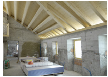
Aufbetonierten Wände und das neue Dach.
