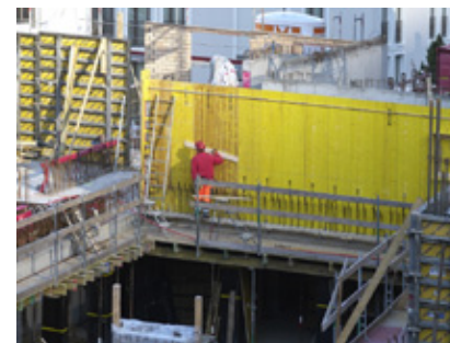
Für die Sichtschalungen werden neue Schaltafeln eingesetzt.
