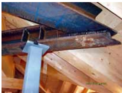
Im Oktober 2008 erfolgte die definitive Abstützung des Daches
