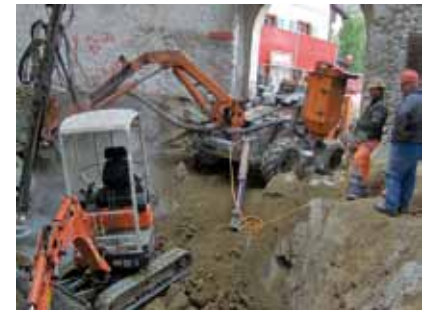
Felsbohrung zum Aussprengen
