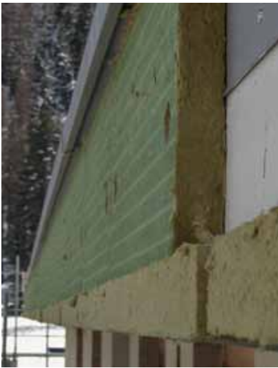
Dämmung am Vordach und an der Dachuntersicht
