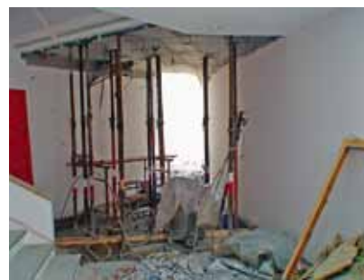
Absperrungen nach genauen Angaben des Ingenieurs
