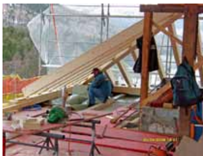
Aufrichten des Daches durch die Firma Gemmet
