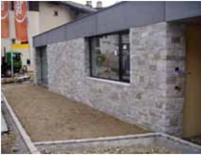
Kleiner Teil der Bruchstein Mauerwerkfassade.
