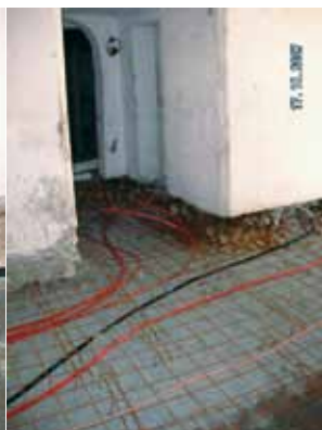
Neue Bodenplatte Entree
