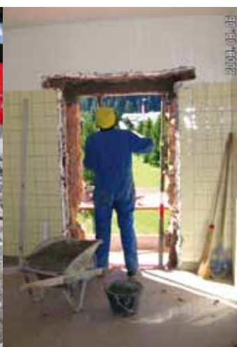
Wanddurchbruch für neue Türe
