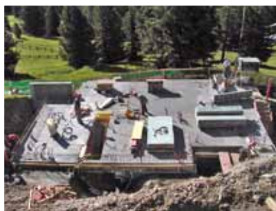
Das Gästehaus entsteht
