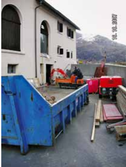
Aushubarbeiten mit Kleinbagger
