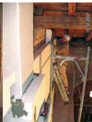
Trennwand Wohnung/Heustall isolieren
