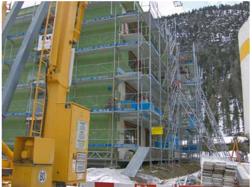
Fassaden, Versetzen der Dämmplatten
