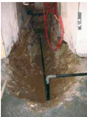
Neue Wasserleitung unter neuer Bodenplatte
