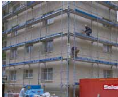
Fassaden, Armierungsgewebe am Einbetten
