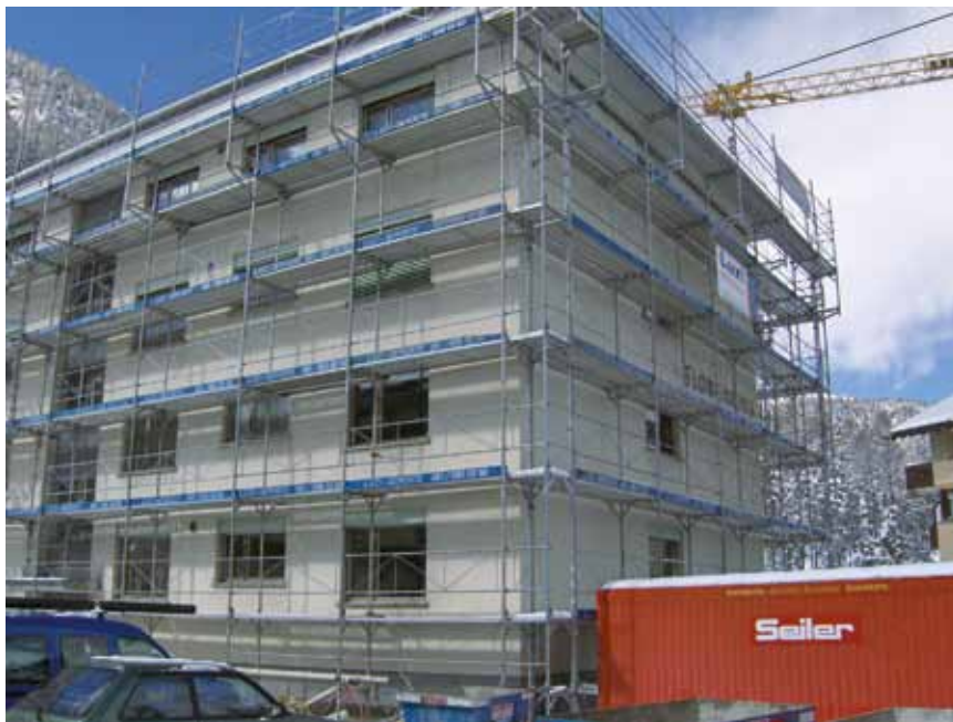
Fassade eingerüstet, Vorbereitungsarbeiten
