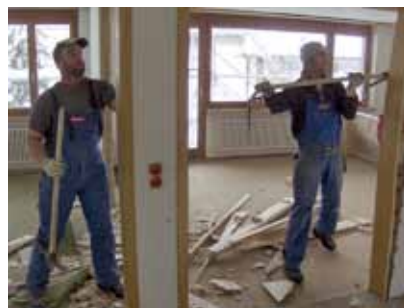
Umbau der Wohnungen, Ausbrucharbeiten
