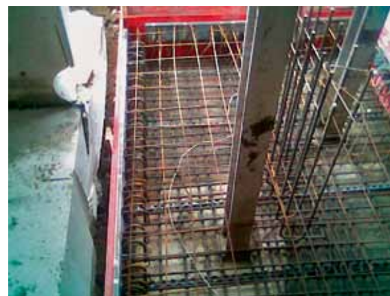
Erstellen von neuen Fundationen. Bis die neuen Betonpfeiler standen, konnten die provisorischen Stahlstützen nicht entfernt werden.
