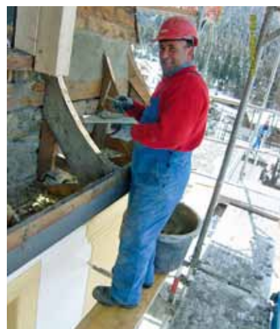
Nach der Demontage mussten diverse Flickarbeiten durchgeführt werden. Im Bild Santos da Silva José
