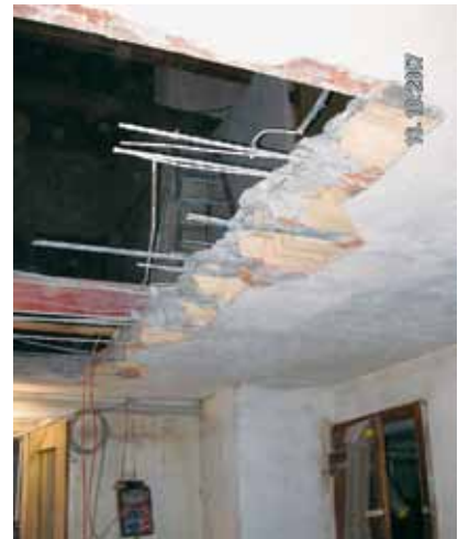
Abbruch Decke im Bereich des neuen Treppenhauses
