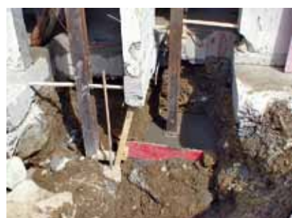
Abfangen des Gebäudes mit provisorischen Stahlträgern
