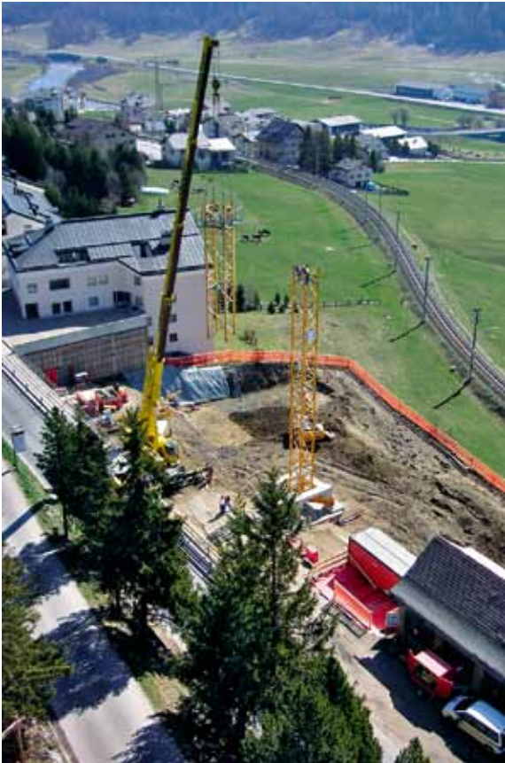
Kranmontage. Ein wunderschön gelegener Bauplatz
