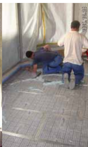
Verlegen der Bodenisolierung
