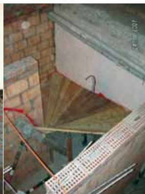
Schalen der Treppe
