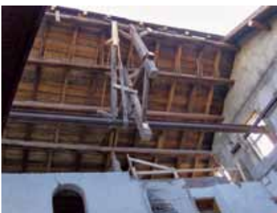
Sicherung des Dachstuhl
