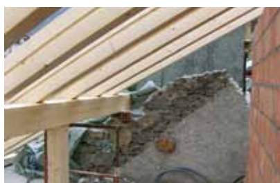
Dachgeschoss, alte und neue Wände
