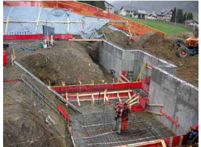
Mit Riegeln und Pfeilern wurde auf den gewachsenen Baugrund fundiert
