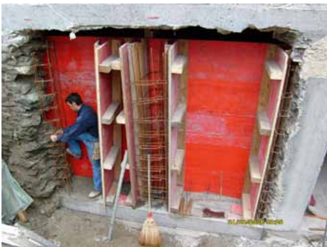
Neue Fassadenöffnungen. Im Bild Polier Gianni Agosti
