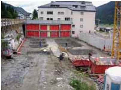
Gut ersichtlich die Vertiefungen der Fundamentverstärkungen der Tiefgarage
