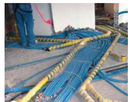
Neue Abläufe und Elektroleitungen in der Küche
