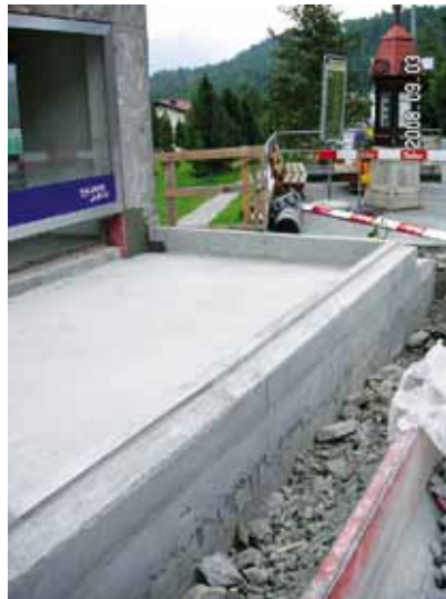
Bodenplatte und Brüstung Anbau Café
