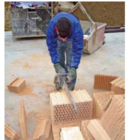
Das Zuschneiden der Steine macht Michael Büchi sichtlich Spass
