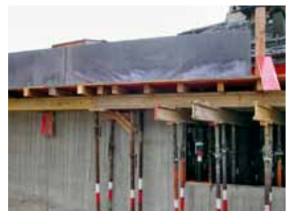
Vorfabrizierte Decken-Randelemente. Die Ausblühungen gaben noch einiges zu reden
