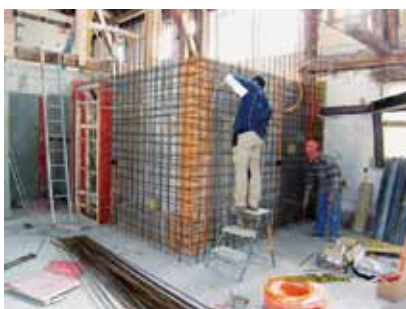
Sämtliches Material, wie Schalung, Armierung musste von Hand ins Gebäude getragen werden
