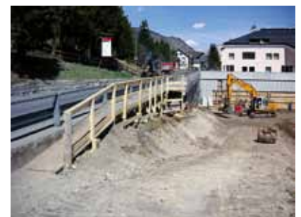
Fussgängerpassarelle. Der Raupenbagger erstellt den Aushub für die Tiefgarage.
