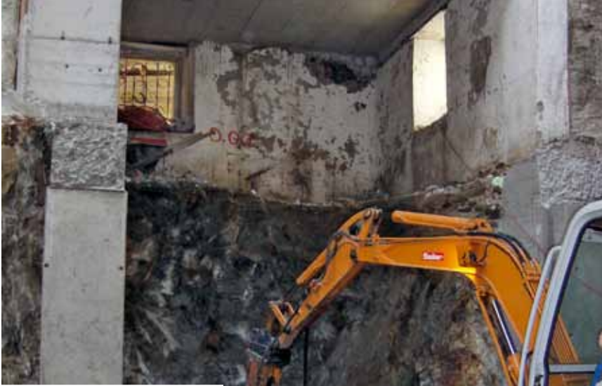
Felsbohrung zum Aussprengen
