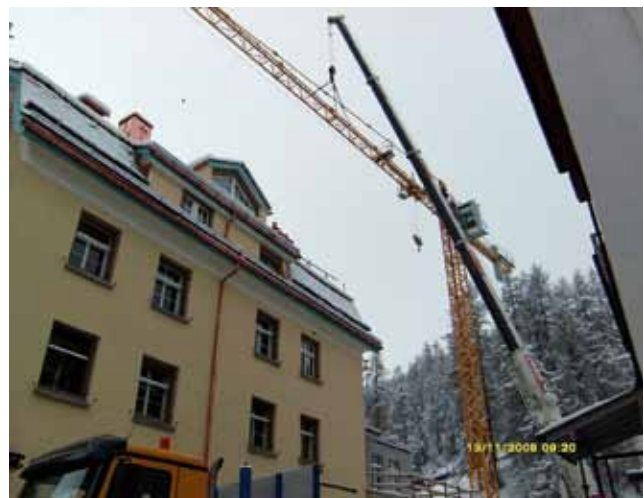
Krandemontage gerade noch rechtzeitig vor Wintereinbruch
