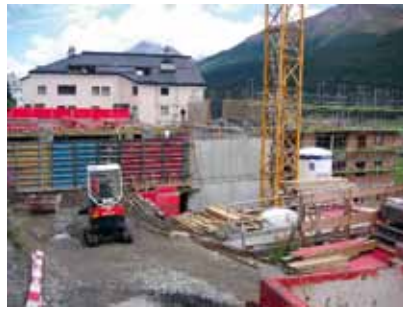
Rohbau Wohnhaus und Tiefgarage wurden gleichzeitig hochgezogen
