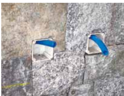
Fugenloses Bruchsteinmauerwerk mit Juliersteinen
