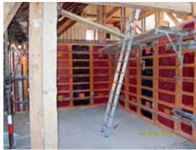
Auch im Dachgeschoss musste noch betoniert werden
