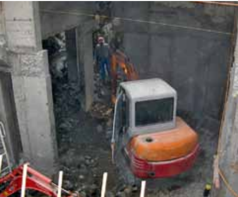
Maschinen am Felsausbruch
