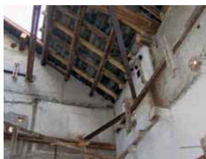
Sicherung des alten Gebäudes
