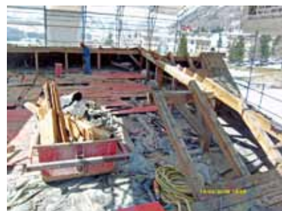
Beihilfe beim Dachabbruch
