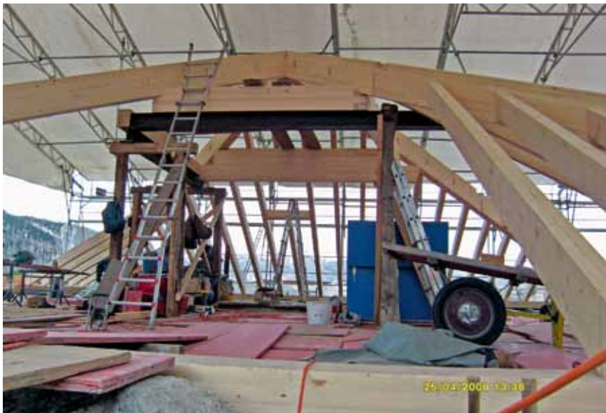
Provisorische Dachabstützung bis Herbst 2008
