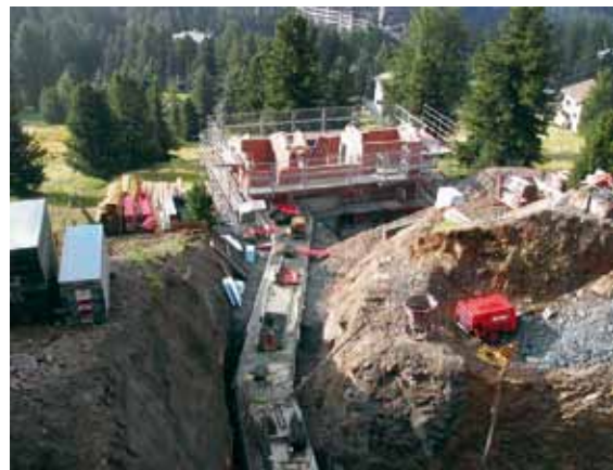
Verbindungsgang vom Gästehaus zum Wohnhaus
