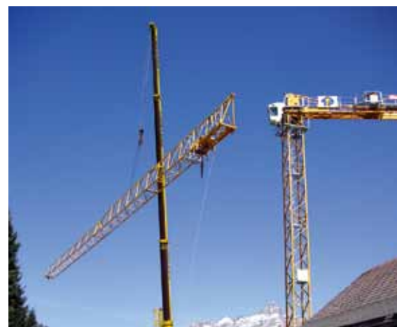
An einem wunderschönen Herbsttag erfolgte die Krandemontage
