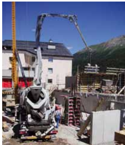
So viel als möglich wurde mit der Pumpe betoniert, um den Kran zu entlasten
