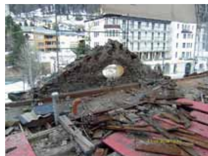
Dachdemontage, inkl. Abbruch Mauerwerk bis auf Decke Dachgeschoss
