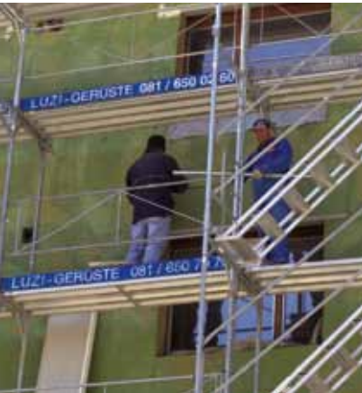
Versetzen der Rollladen-Sturzelemente
