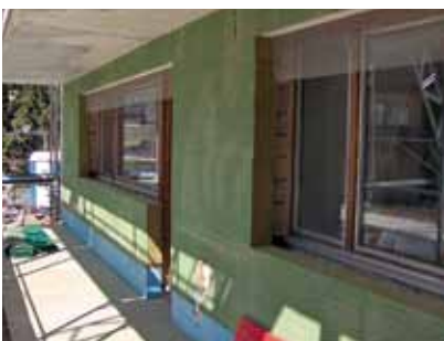
Fassaden sind gedämmt. Unterbruch bis die neuen Fenster montiert sind
