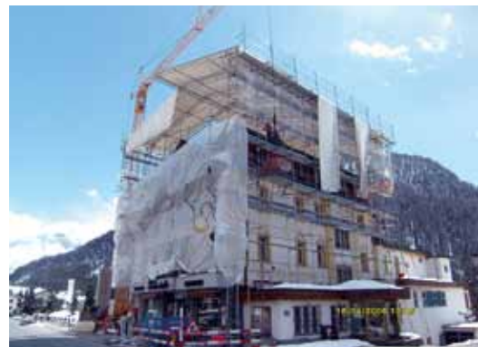
Hotel Albris mit Notdach, vor der Demontage des alten Daches
