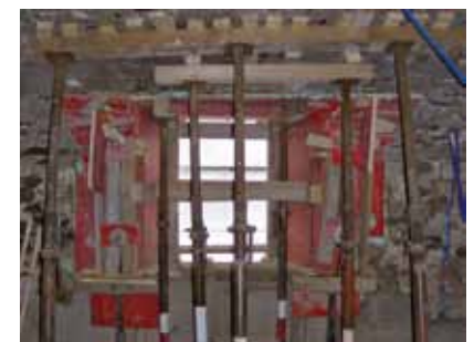
Abspriessung der Gewölbedecke und Änderungen am Fenster
