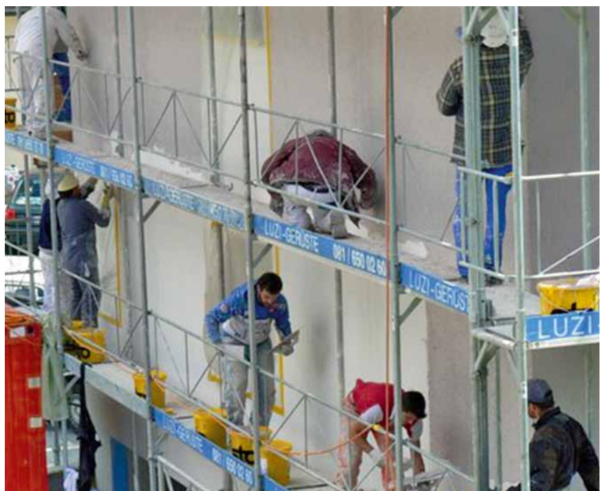
Auftragen der Deckschicht (Abrieb)
