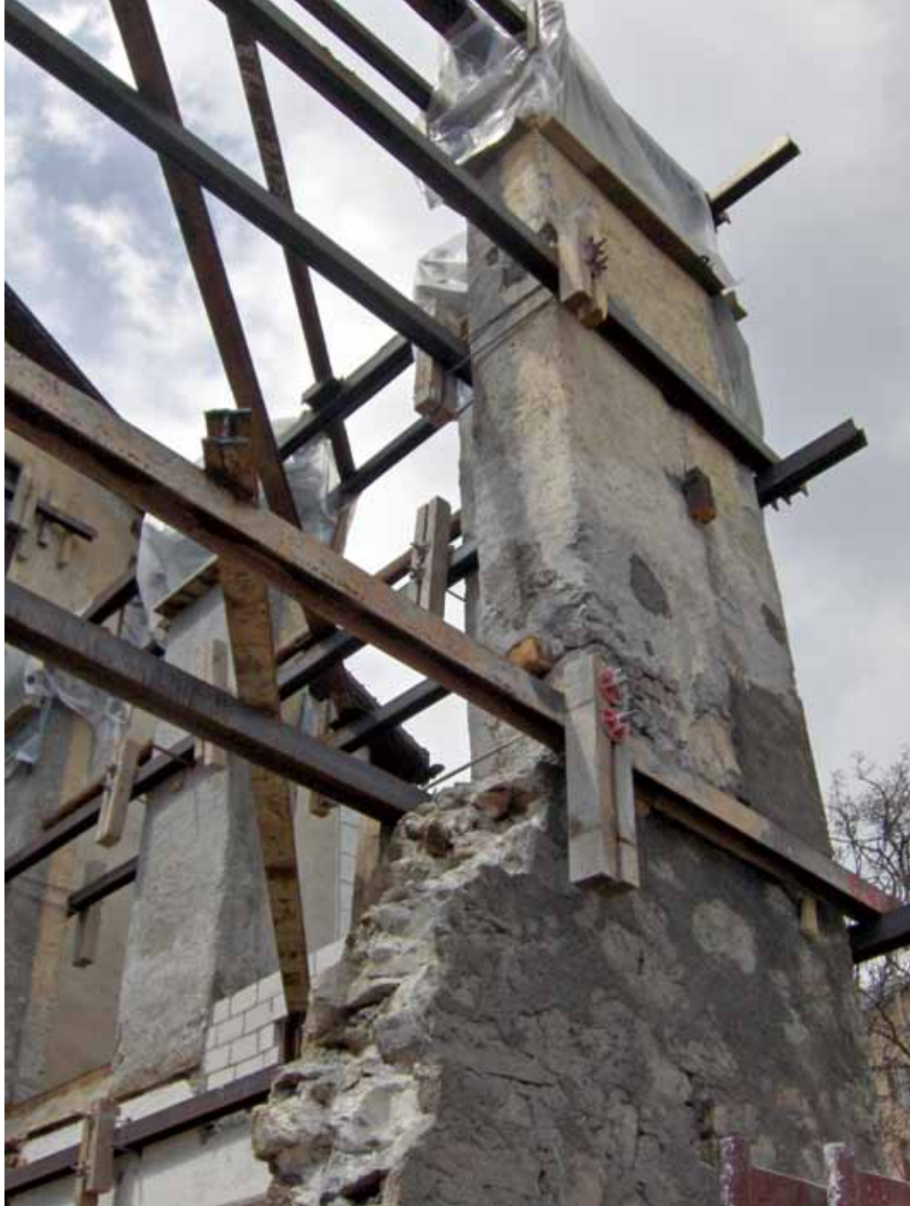
Fassadensicherung mit Stahlträgern
