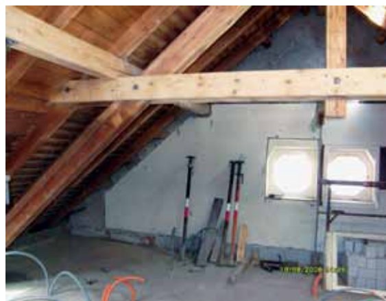
Die alte Dachkonstruktion wurde sandgestrahlt
