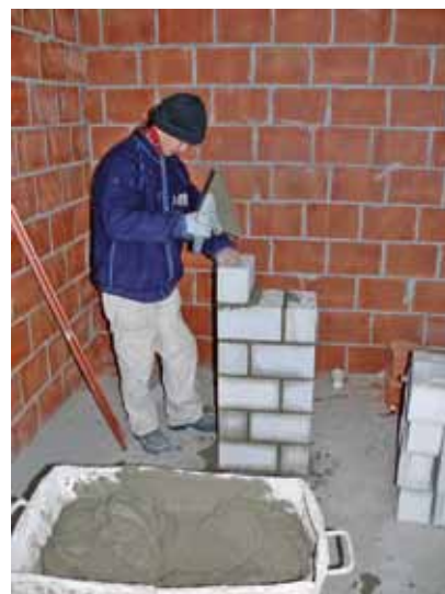
Auch dieses Pfeilermauerwerk des Lehrlings Mario Mammoliti lässt keine Wünsche offen
