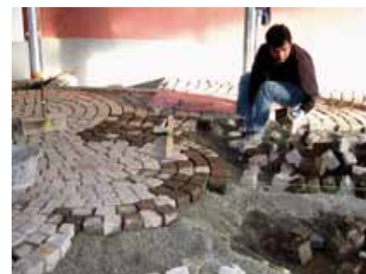
Man würde nicht denken, dass diese Aufnahme am 17. Dezember 2008 gemacht wurde. Die Firma Walo bei der anspruchsvollen Vorplatz Pflasterung
