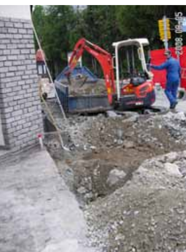
Beginn Aushub für den Anbau Café
