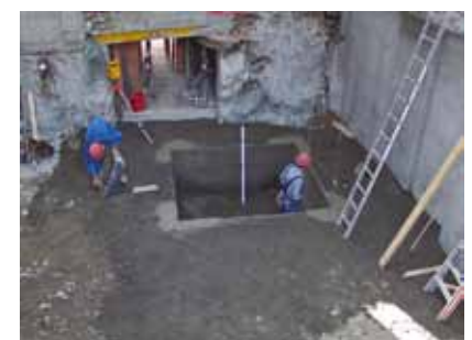
Magerbeton – Sohle mit Liftunterfahrt
