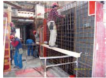
Erstellen der Wände im UG mittels Aluminium Framax.
