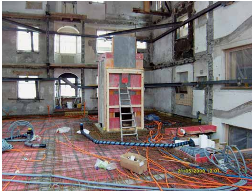
Decke kurz vor dem Betonieren. In der Mitte die Liftschalung.
