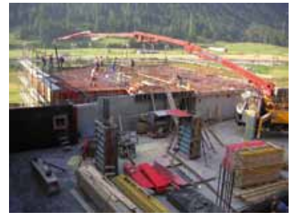
Vorbildlich, wie jeweils das Gerüst ein Stockwerk im Voraus hoch gezogen wurde
