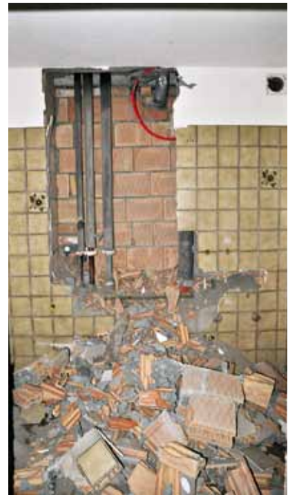
Spitzarbeiten um alte Leitungsstränge freizulegen
