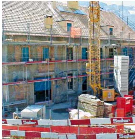
Resgia Veglia, eine wunderschöne Wohnanlage mit grosszügigen Wohnungen
