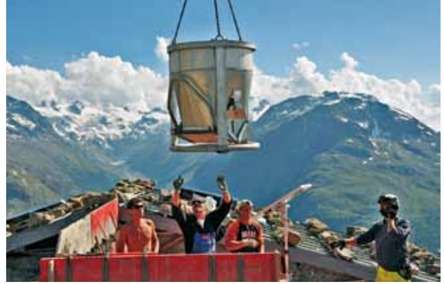
Zwischen den Rotationen musste der Beton eingebracht werden weil 6 Min. später bereits der nächste Kübel Beton eingeflogen wurde
