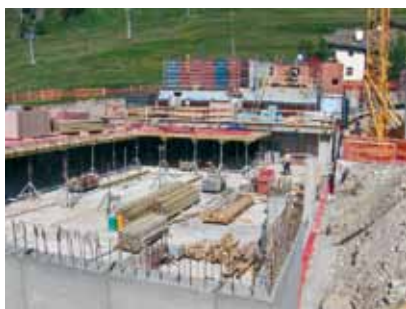
Einstellhalle 2. Etappe Decke/ Haus 1, Wände EG
