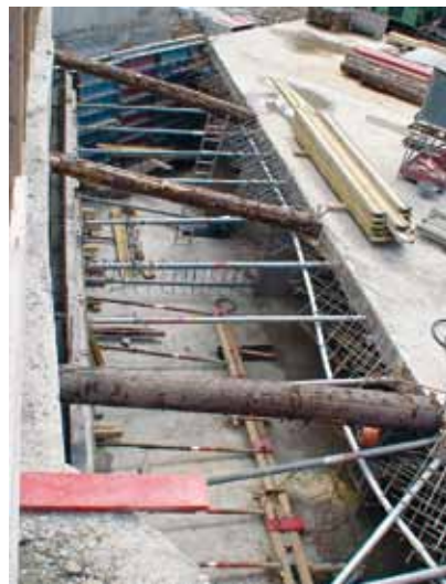
Abstützung der Baugrubensicherung mit Rundholz auf die Garagendecke
