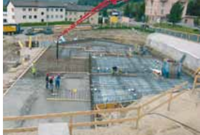
Betonage der Bodenplatte. Total 177m 3 .
