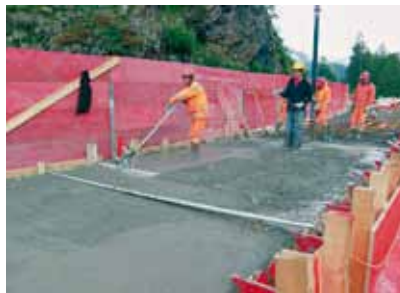
Oberflächenbearbeitung mit Abziehbalken
