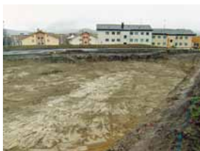
Der Baugrubenaushub wäre fertig, doch der Untergrund nicht tragfähig
