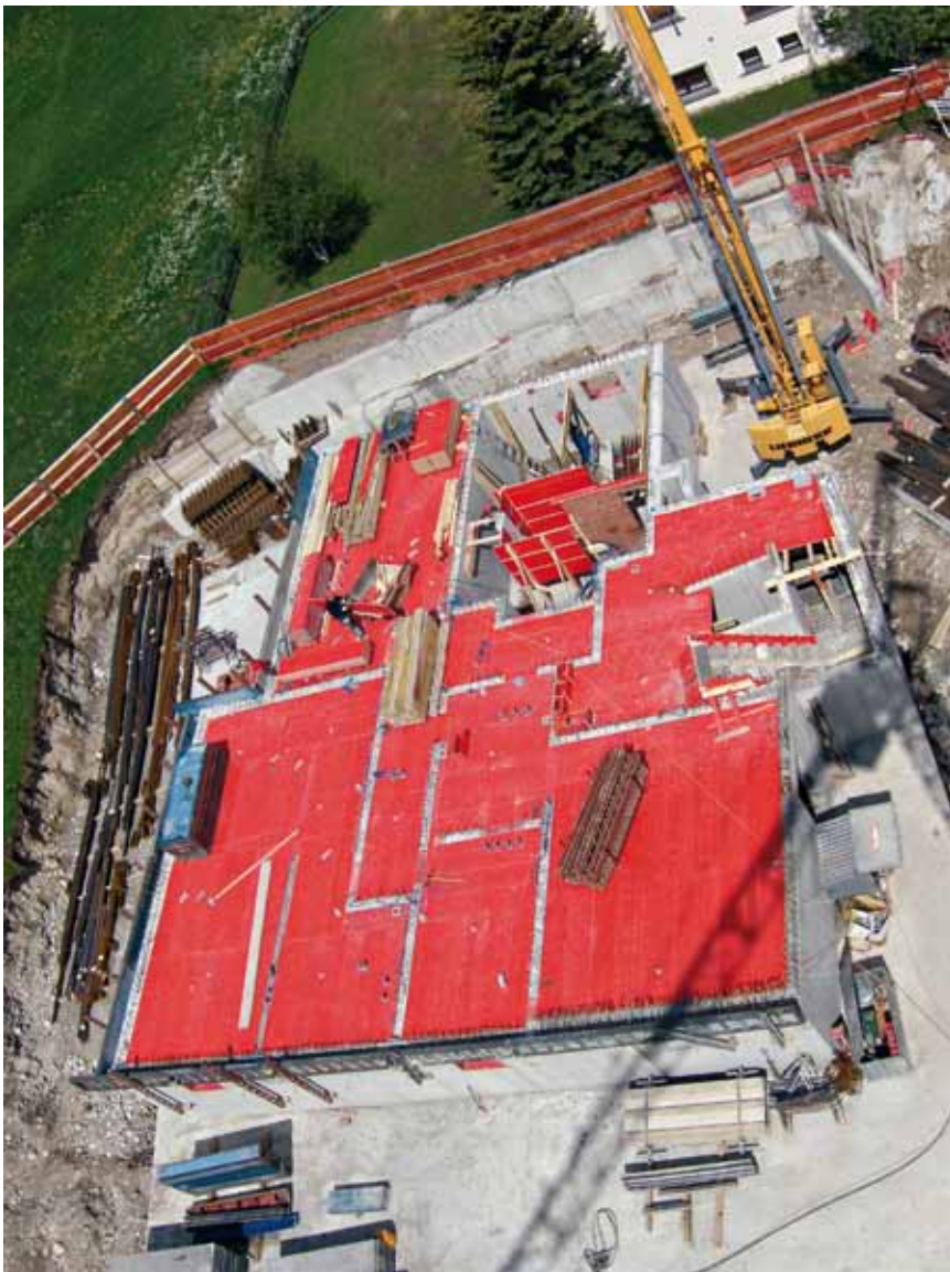
Haus 1, Decke über 1. UG
