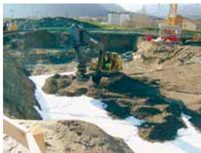
Schichten von 1 bis 2 Meter wurden ausgetauscht
