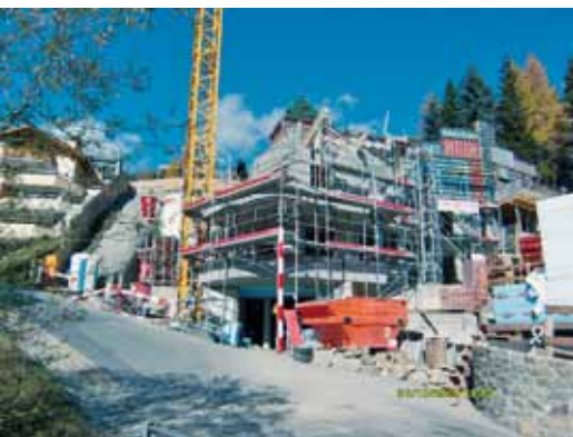
Aufrichten des Daches
