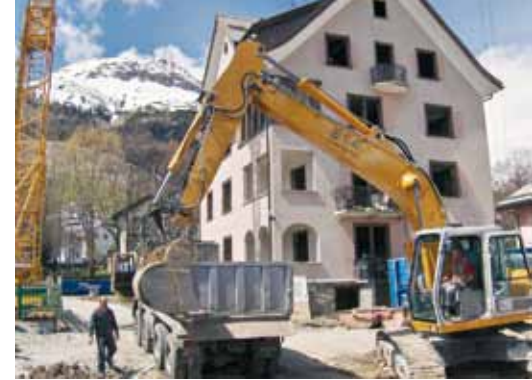
Aushub Autoeinstellhalle
