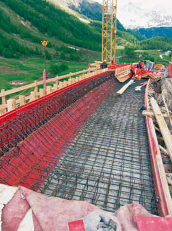
Die erste Betonetappe
