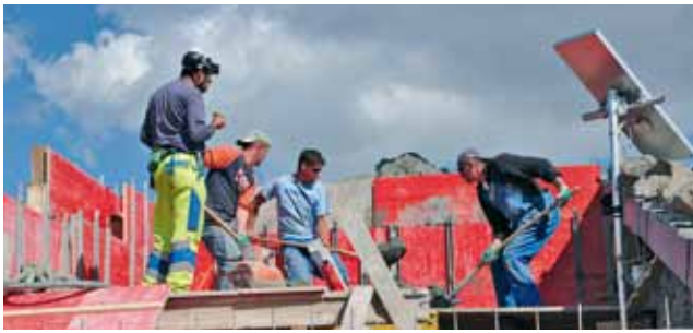
Zwischen den Rotationen musste der Beton eingebracht werden weil 6 Min. später bereits der nächste Kübel Beton eingeflogen wurde
