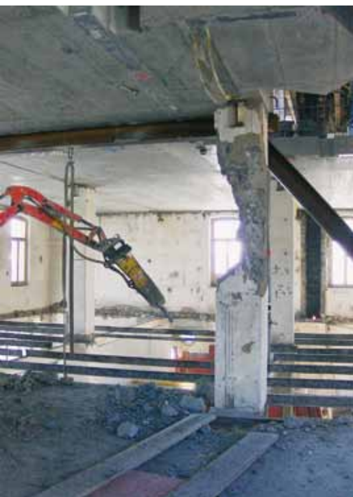
Der Rückbau erfolgte nach dem Einbau der Decke von oben nach unten, die tragenden Hauptstützen konnten anschliessend abgespitzt werden
