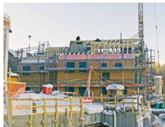
H 2, Dach am Aufrichten
