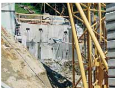
Baugrubensicherung Ankerwand
