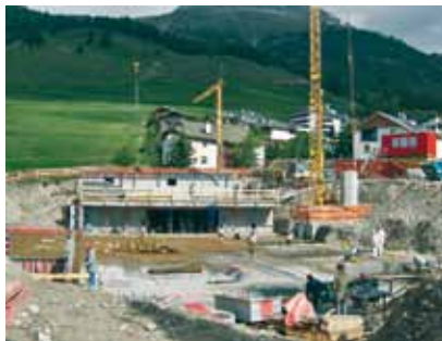
Einstellhalle 2. Etappe Bodenplatte
