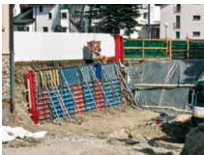
Baugrube Böschungssicherung
