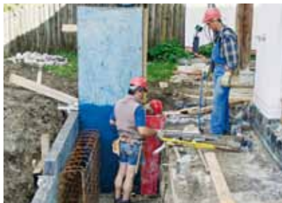
Maschinist Antonio Gossi und Rocco Balatti beim Schalen der Fundamente
