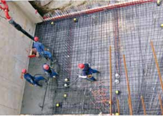
H 2, 2. UG Bodenplatte am Betonieren
