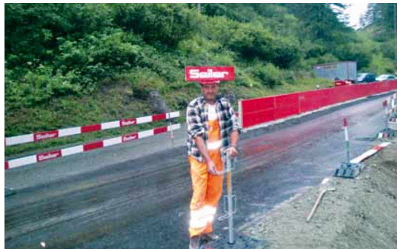
Carnini Ermanno begrüsst die ersten Automobilisten nach Freigabe der ersten Strassenhälfte auf unmissverständliche Art. Schliesslich soll man sehen, welche Firma hier so sauber gebaut hat...
