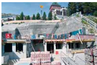
Bereits im 2. OG
