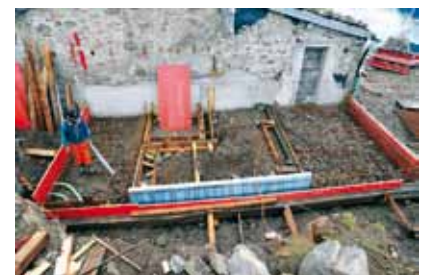
Die Bodenplatte ist bereit zum Betonieren
