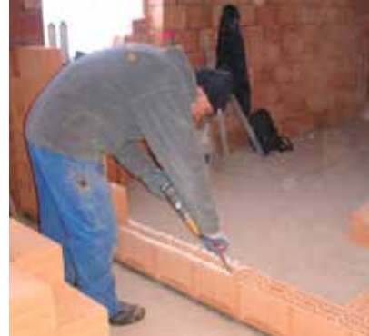
Die erste Schicht wird im Mörtel gesetzt und erst nachher geklebt
