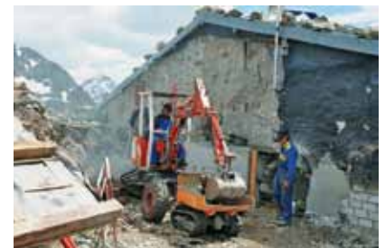
Mittels Kleinmuck und Motorkarrette wurde der Aushub getätigt
