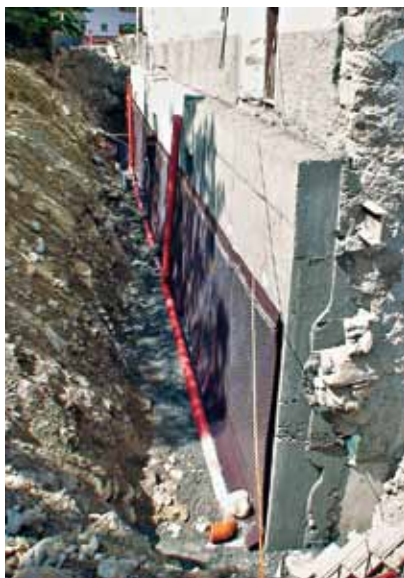
Die Aussenmauern wurden am Schluss vorbetoniert
