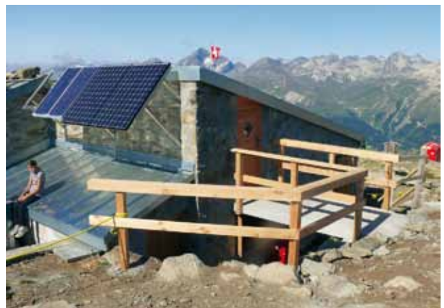
Eine gelungene Baustelle auf 2731m.ü.M.
