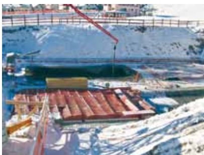
Betonieren der Einzelfundamente
