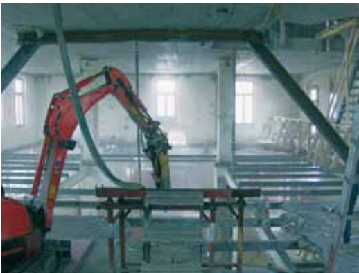
Die Decke wurde mit Stahlträgern auf die Aussenmauern abgefangen die durch alte und neue Träger zusammengehalten wurden
