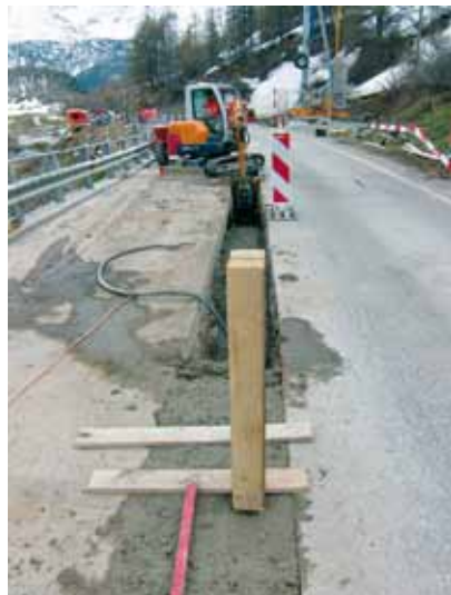
In der Mitte brauchte es eine Trennwand
