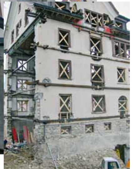
Ganz ohne neue Risse in der alten Fassade ging es trotzdem nicht
