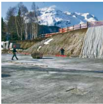
Einstellhalle 1. Etappe Bodenplatte
