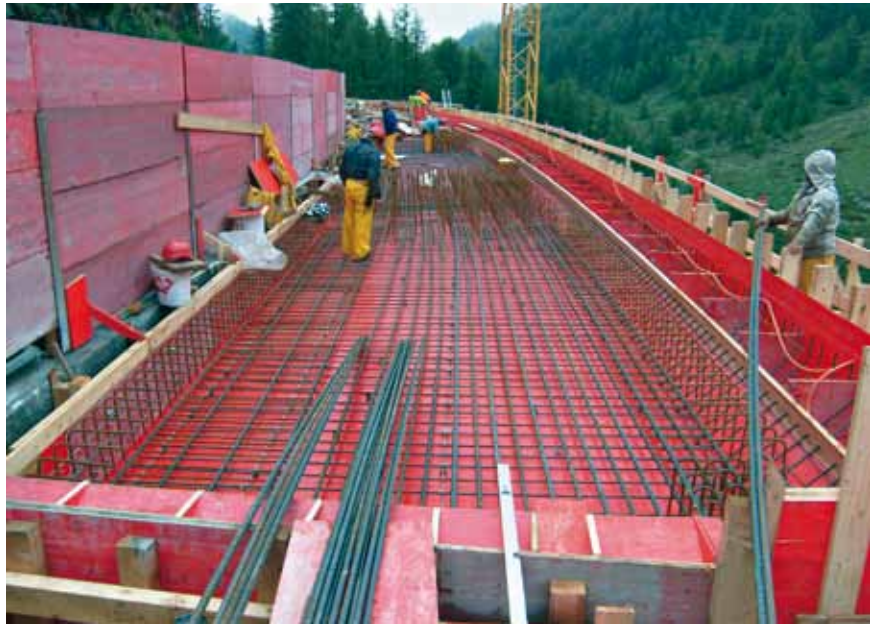
Die neue Brückenplatte entsteht
