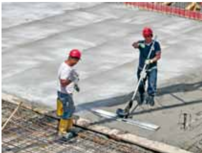
Bodenplatten am Betonieren
