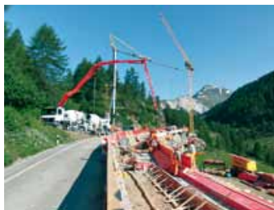
Organisation der Betonierarbeiten
