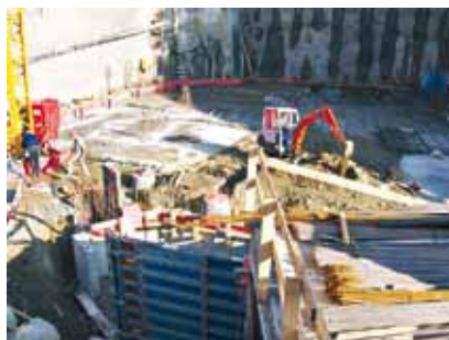
Bodenplatte Garage
