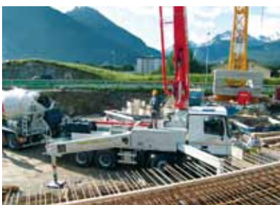
Pedro mit seiner neuen Betonpumpe
