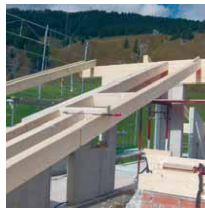
Haus 1, Dach am aufrichten
