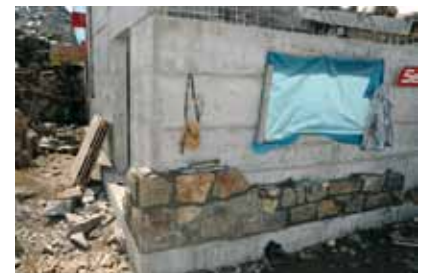
die Aussenmauern wurden nachträglich mit Natursteinen verkleidet
