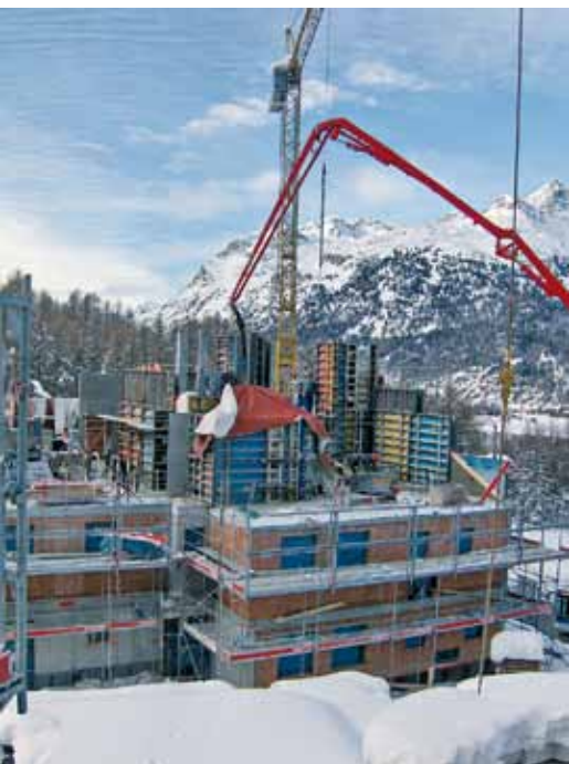
H 2, DG Betonieren der Giebelwände
