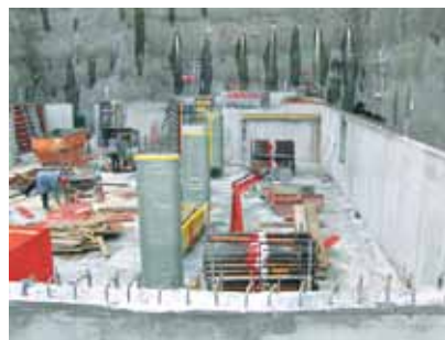
Bereit zum Schalen, Decke über Garage
