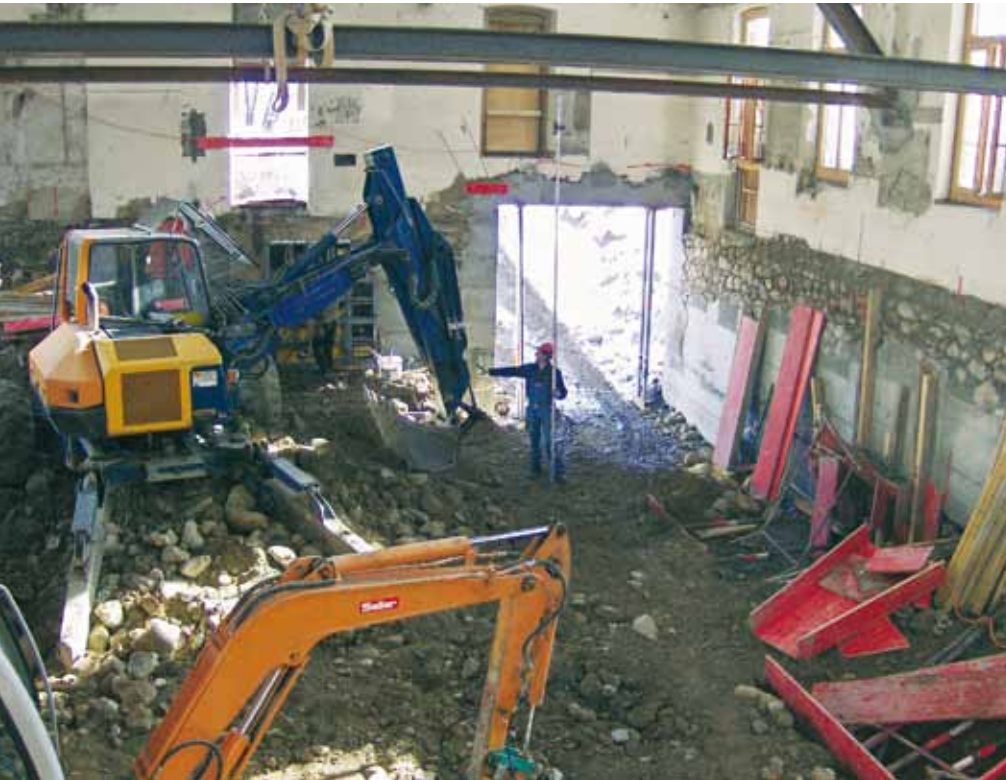
Mit grösseren Maschinen wurden der Aushub und die Unterfangungen voran getrieben
