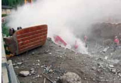
Samedan im Ausnahmezustand! Kanalisationsbohrung durch die Firma Cavegn
