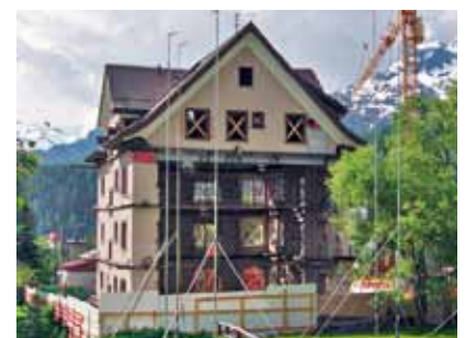
Nur noch Fassade
