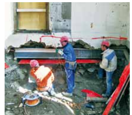
Die Bruchsteinmauern wurden je zur Hälfte von Aussen und von Innen unterfangen
