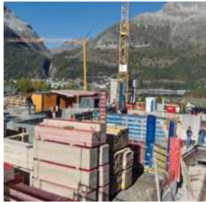
H 1, 1. UG Treppenhaus am Zuschalen
