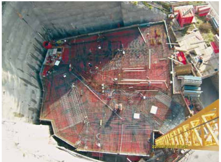
Decke über Garage, bereit zum Betonieren
