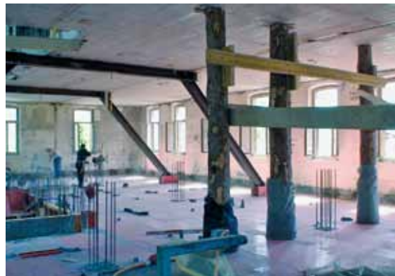
Um die Holz und Stahlabstützungen herum wurde wieder aufgebaut
