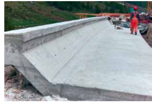
Kordon und Widerlagerbank im ausgeschalteten Zustand
