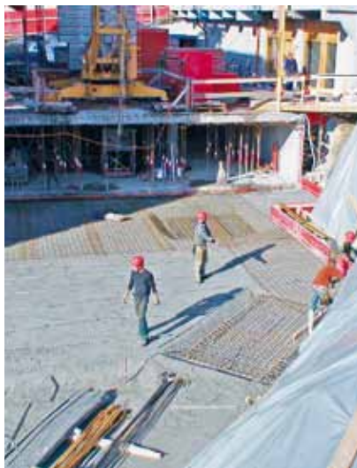
Zugleich wurde auch der Garagenbau vorangetrieben
