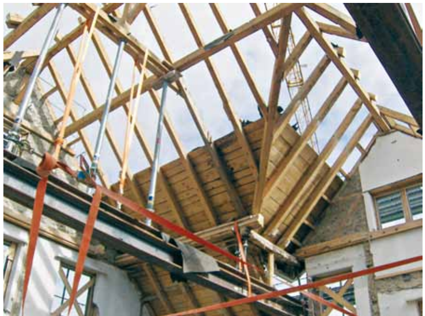
Am Schluss wurde das Dach trotzdem entfernt
