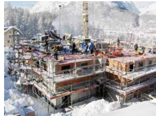
H 2, OG Betondecke 2. Teil
