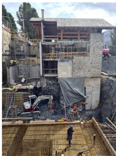
Aushubarbeiten für die Liftunterfahrt während im Vordergrund die Bodenplatte des Anbaues bereit zum betonieren ist.
