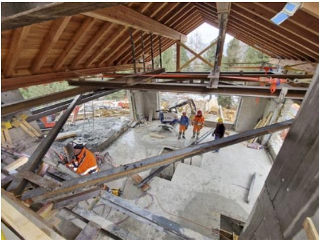
**Die ganze Villa wurde mit Stahlträgern rundum gesichert und das Dach abgefangen.**
