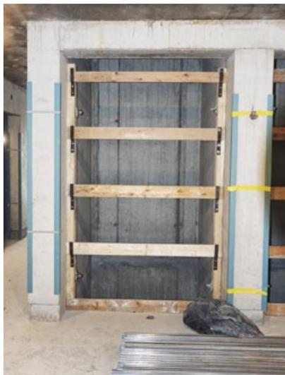
**Perfekt abgesperrter Lifteingang. Im Winter werden wir die Übergänge von Sichtdecke und Sichtwänden reinigen und wo nötig kosmetisch behandeln. Während der Rohbauphase waren alle scharfkantigen Ecken so geschützt.**
