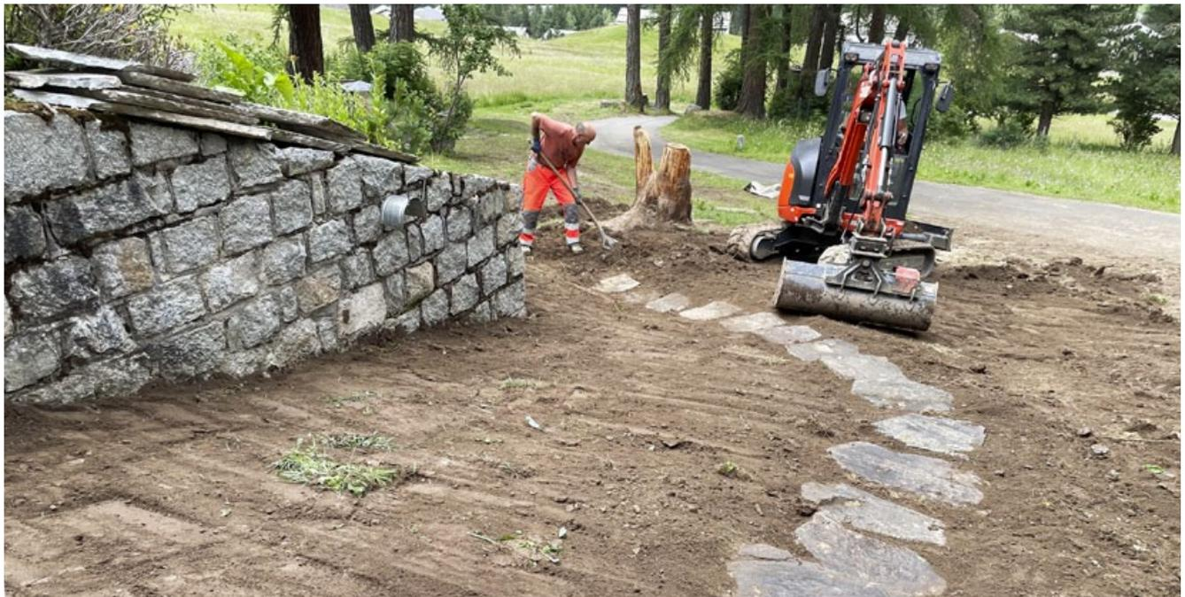
Nach dem hinterfüllen und verdichten wird der Humus wieder angelegt.
