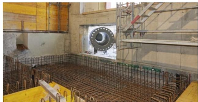
**Bis Weihnachten 2022 wurde bis Oberkant Armierung betoniert. Im 2023 betonieren wir bis auf die Höhe über der Druckleitung.**
