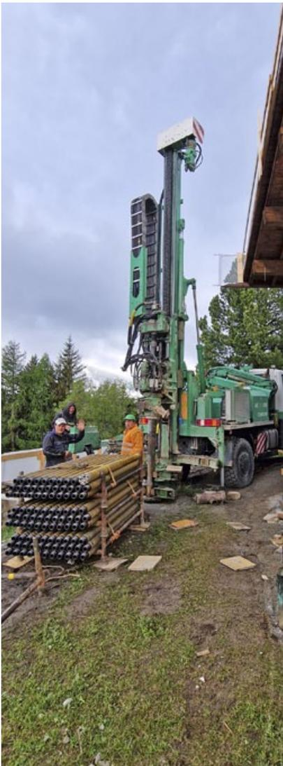
Als erste Arbeiten werden die Tiefenbohrungen erstellt.
