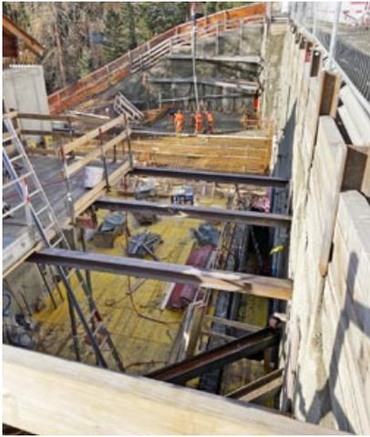
Die Bodenplatte des Autoliftes ist betoniert. Die Stahlträger verbinden die Villa als Sicherung mit der Baugrubensicherung.
