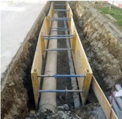
Links die Kanalisations- und rechts die neue Wasserleitung.
