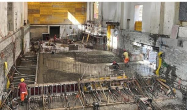
**Betonieren der Bodenplatte der Maschinen-
