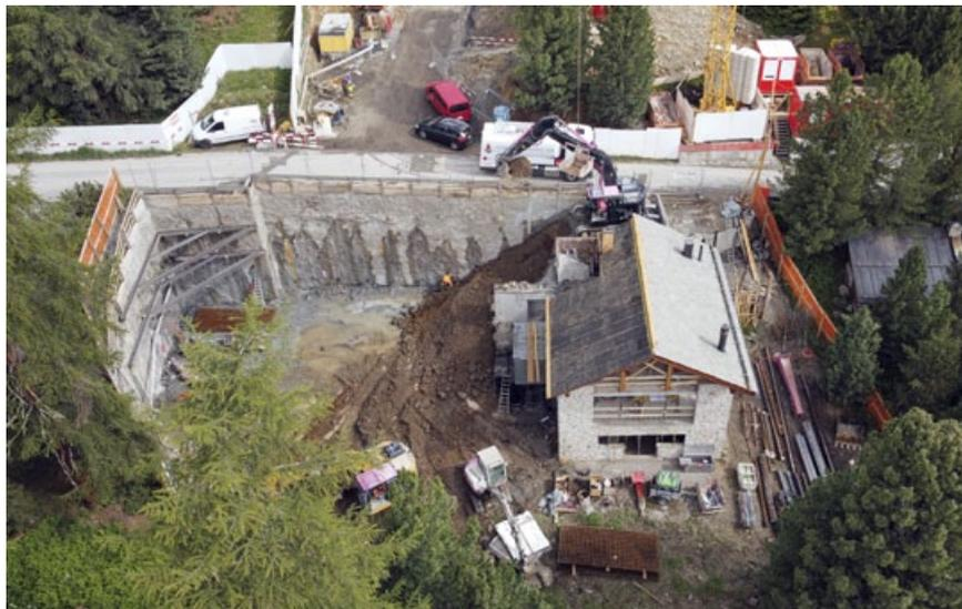
Luftaufnahme der Villa Caschina mit der Baugrubensicherung und dem laufenden Aushub.
