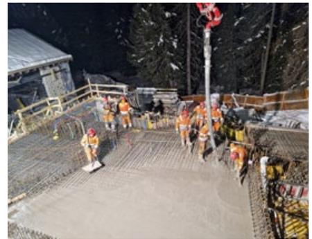
Am 14. Dezember musste der Kran demontiert werden und gleichzeitig betonierten wir einen Teil der Decke über EG. Die Zufahrtsstrasse war zeitweise blockiert. Um 20.00 Uhr waren wir fertig mit betonieren.
