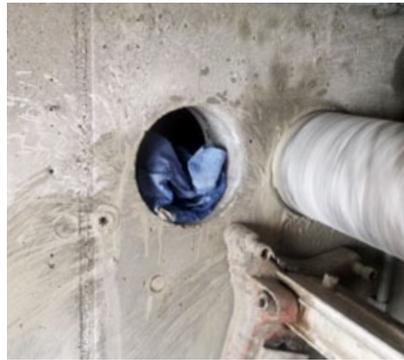
Die Aussenwand zur Heizung wird durchbohrt.
