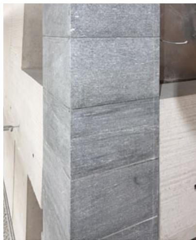
**Zwischen den Pfeiler versetzte eine Spezialfirma die vorfabrizierten Beton-elemente.**
