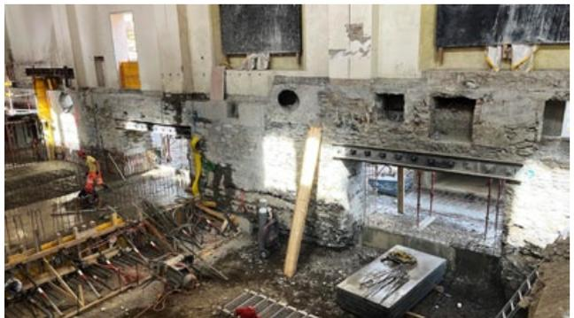
**Verschiedenste Durchbrüche mussten in das Bruchsteinmauerwerk geschnitten werden. Gut ersichtlich die Abwasserkanäle. Andere alte Durchbrüche mussten hingegen wiederum geschlossen werden.**
