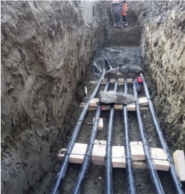
Von den Sonden führen je zwei Leitungen zum Schacht.
