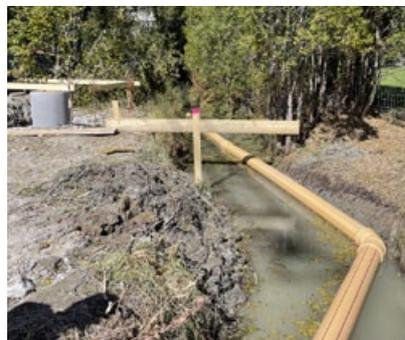
**Für die Arbeiten an den Frostriegeln musste zuerst das Grundwasser abgesenkt und eine Sickerpackung eingebracht werden. Mittels Pumpen bekamen wir das Grundwasser etappenweise in den Griff.**
