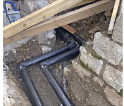
In dem Fall eine starre, isolierte Zuleitung vom Schacht ins Haus.
