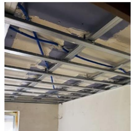
In allen 47 Zimmern erstellten wir neue heruntergehängte Decken.
