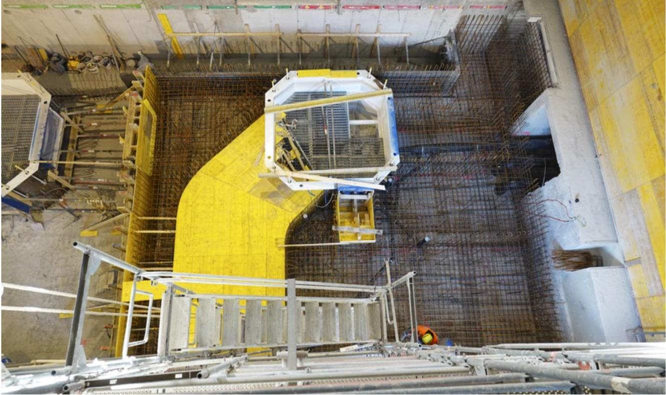
**Der Abwasserkanal ist mit Schaltfeldern geschalt. Auf die weisse Turbinenpanzerung kommt am Ende die Turbine zu stehen. An den Wänden sieht man die Armierungseinlagen. Schrittweise wird auf diese Höhe alles einbetoniert.**
