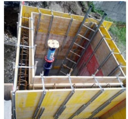
Hydrantenschacht vor Ort betoniert.
