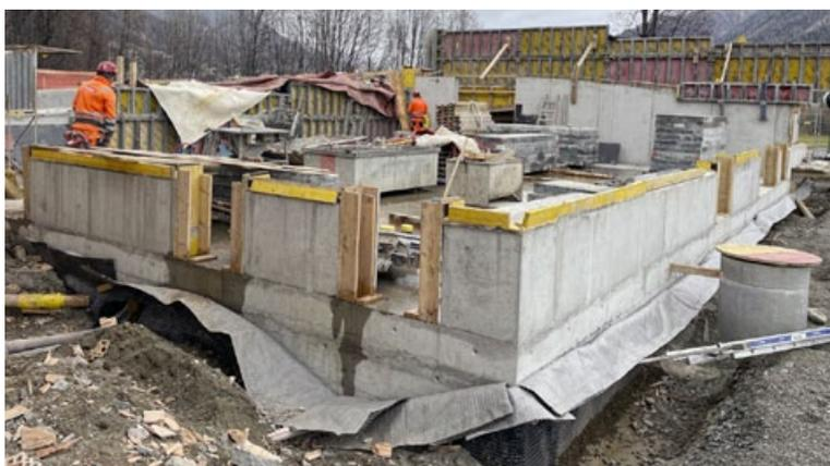
**Eine Rampe führt in den Anbau. Dieser besteht aus Sichtbetonbrüstungen, auf welchen später der Holzbau zu stehen kommt.**
