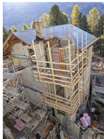
Liftenbau an der Villa an dem später die ganze Sicherung der Stahlkonstruktion verankert wurde.
