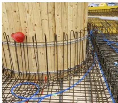
Runde Schächte bringen Licht ins Untergeschoss.
