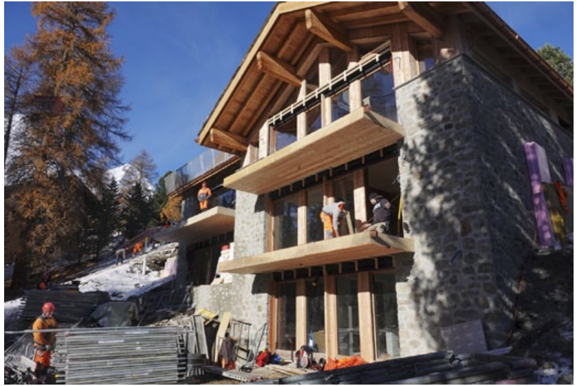
Für einen Moment lang nicht «Suva like», nach der Demontage des Gerüstes montieren die Schreiner als nächstes das Geländer.
