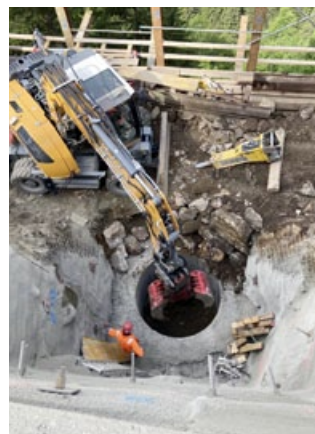
Unsere selbstentworfene Schalung für die Ringbetonfundationen. Jede der 16 Fundationen hatte eine Tiefe von 5.10 m. Die Tiefe erreichten wir mittels Pneubagger, ausgerüstet mit einem Greifer.
