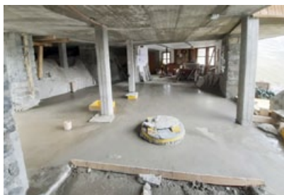
Neue Leitungen im Untergeschoss und die darüber frisch betonierte Bodenplatte.
