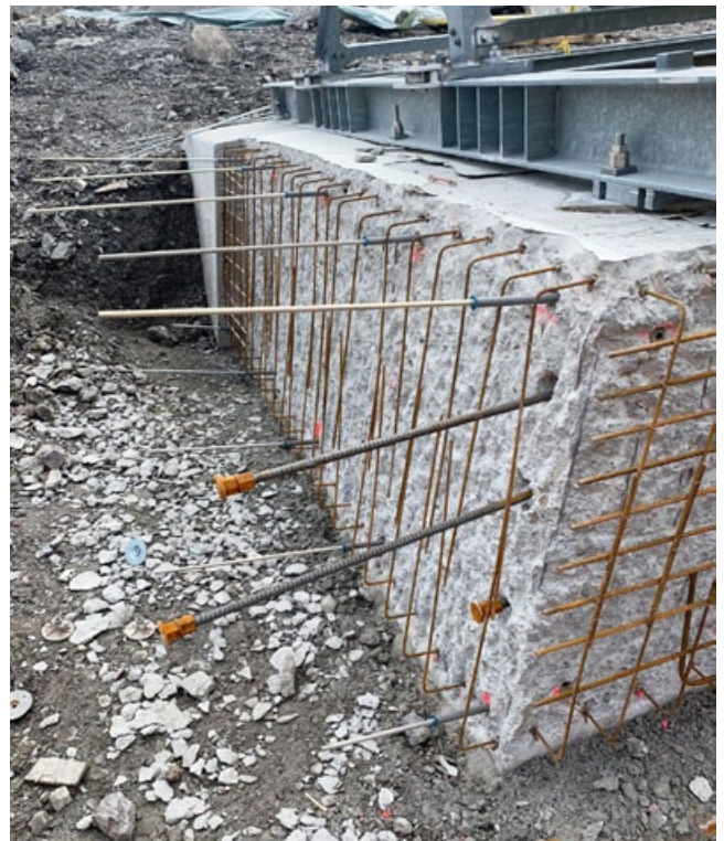
Die bestehenden Foundationen wurden vorbetoniert, im Bild die Swiss Gewi Gewindestangen.
