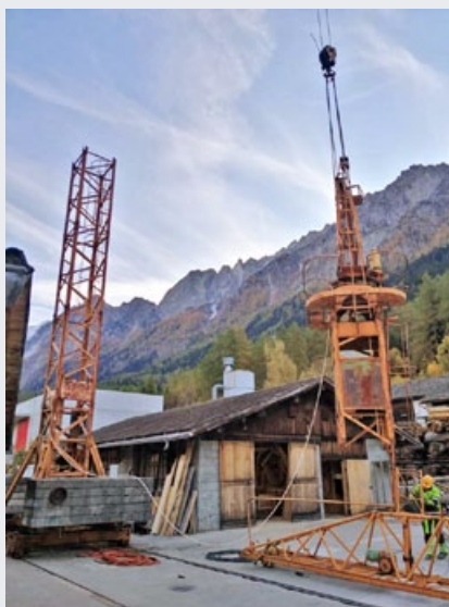
Ende Jahr 2022 wurde der 52 jährige Kran in Stampa durch Linus Berther demontiert. 1990 war der Kran noch im Besitz der Firma Seiler.
