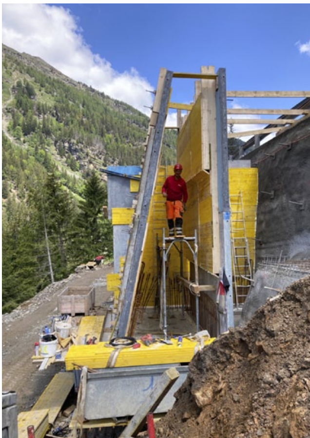
Im untersten Bereich der Baustelle erstellten wir eine Schwerewichtsstützmauer.
