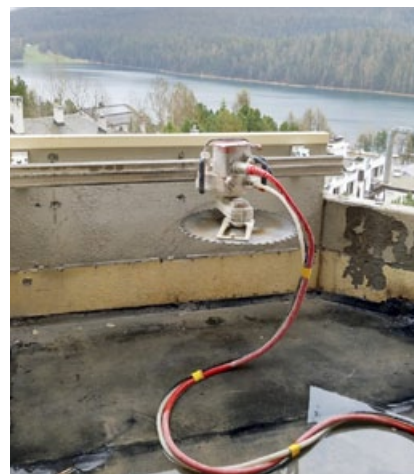
Die Brüstungen auf den Balkonen wurde um ca. 50cm abgefräst.
