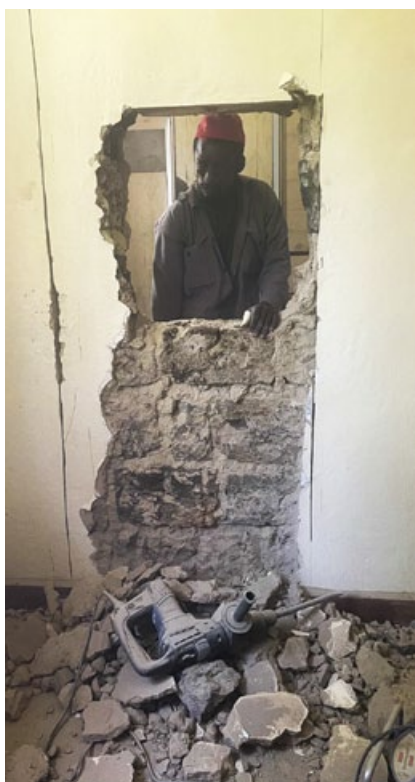
Einheimische Helfer beim Erstellen eines neuen Durchbruches.
