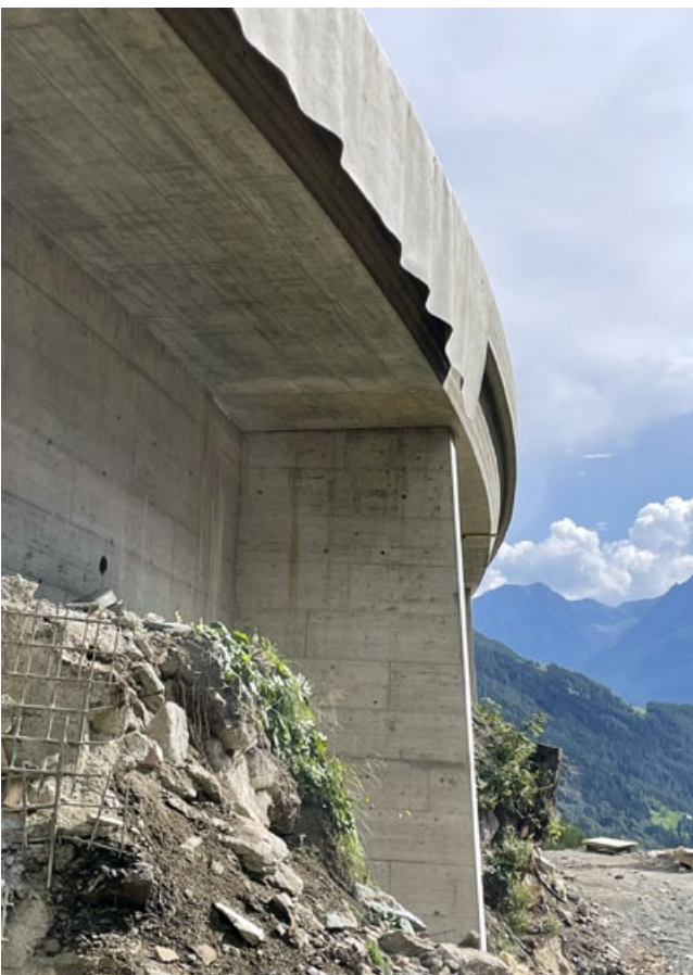
Fertige Lehenbrücke mit den beschriebenen Pfeilern, der Schürze und der Fahrbahnplatte.
