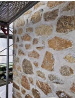
Bruchsteinmauerwerk, nach den Vorgaben der stehen gelassenen Pfeiler.
