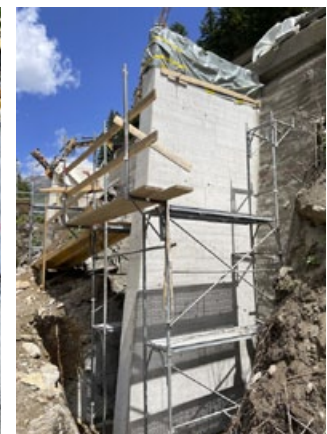
Auf die Ringfundation kam eine Bodenplatte zu liegen auf welcher die Pfeiler der Lehnbrücke zu stehen kamen.
