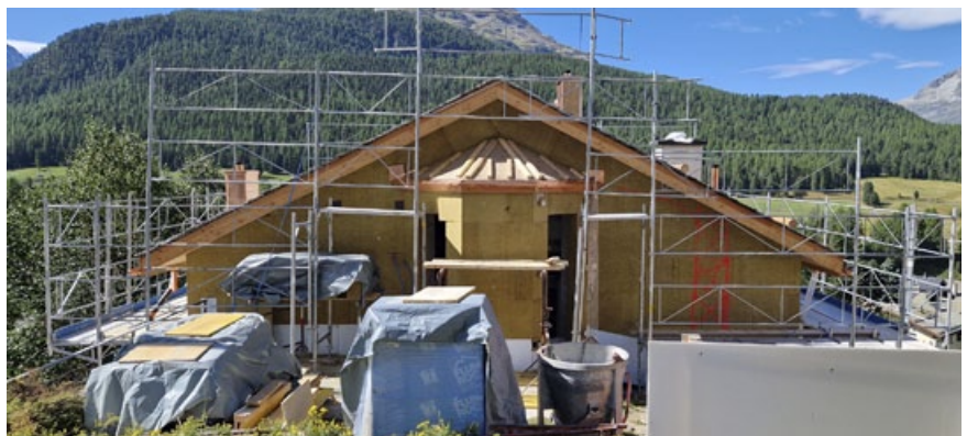
Anbau Dachgeschoss mit fertig gestellter Aussenisolation.
