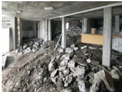
Dem Fels im Untergeschoss wurde mit Betonfräse und Spitzhammer auf Kubota zu Leibe gerückt.
