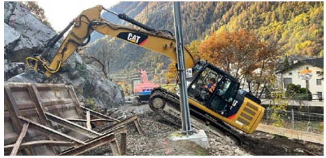
Nach der Sprengung wurde das Material mit Baggern weggebracht.
