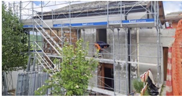
Die alte Aussenwärmedämmung wurde entfernt und neu mit 20 cm wieder aufgebaut.
