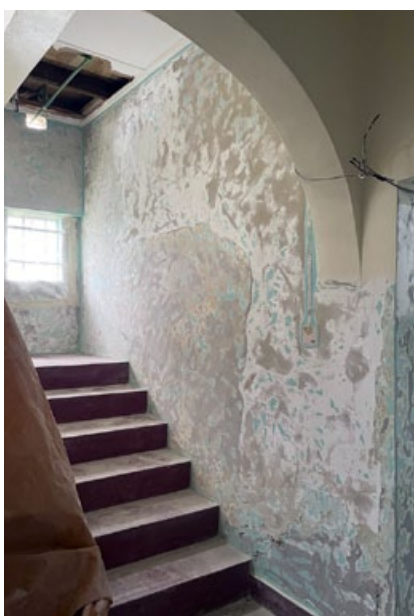
Alle Wände und Treppen wurden geschliffen, bevor wir neue Plättli verlegten oder Wände neu verputzten.
