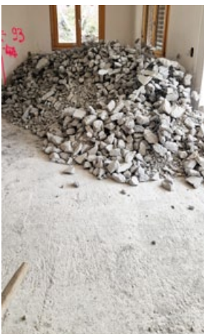
Im ganzen Einfamilienhaus wurden die Unterlagsböden entfernt und im Dachgeschoss entstand neu eine grosse Fensteröffnung.
