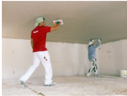
Unser Gipserteam am Glattputz erstellen.
