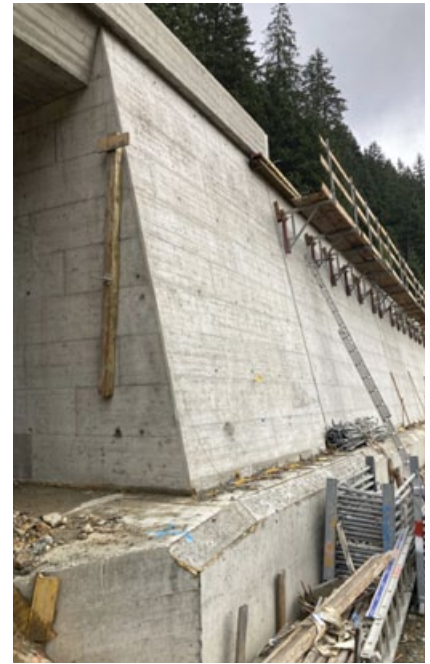
Unterster Bereich mit der Schweregewichtsstützmauer.
