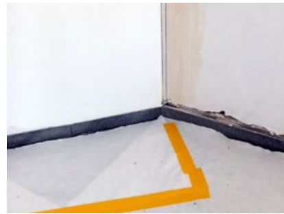
Nachträglich wurde entschieden, Sockelleisten aus Holz oder Stein in die Wände einzulassen.
