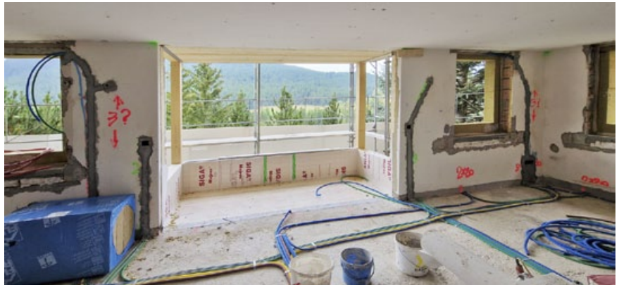
Ein bestehender Balkon wurde neu in die Wohnfläche integriert.
