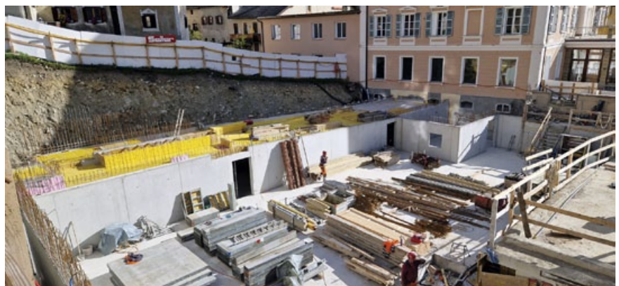
Untergeschoss der Tiefgarage mit Verbindungsgang.
