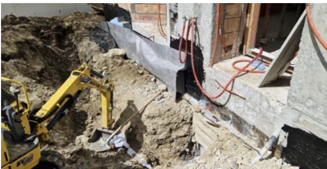
Bis zu einer Tiefe von 1.0m wurde die Perimeter Isolation von 10 cm auf 20cm erhöht.
