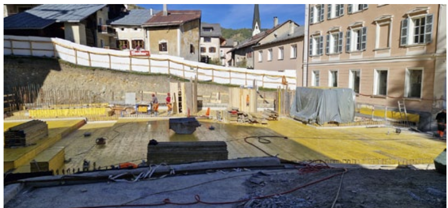
Decke über Untergeschoss bereit zum armieren.
