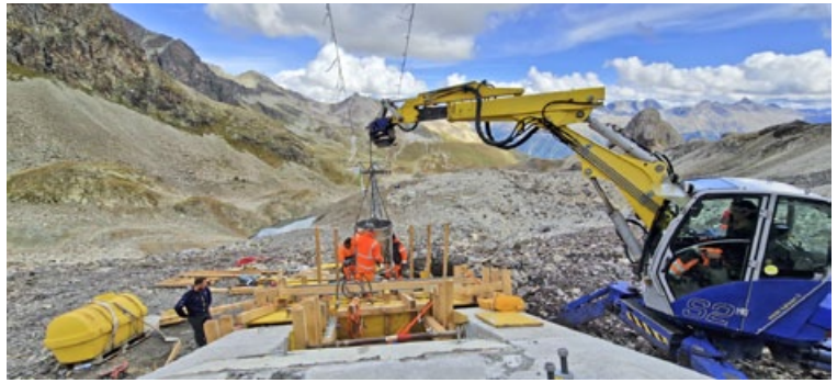
Wegen den Tragseilen wurde der Beton knapp nebenan hingeflogen und dann mit dem Schreitbagger an den Bestimmungsort gebracht.
