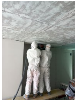
Aufwendige Arbeit, um die Decke zu schleifen und später Schlitz für Elektrorohre hinein zu fräsen.
