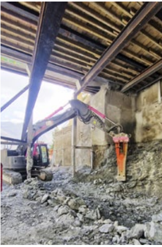
Felsabtrag unter der Chesa Maurin ohne die filigranen Stützen zu berühren.
