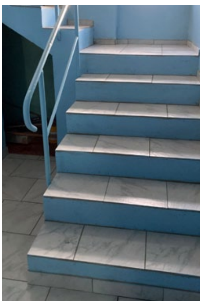
Alle Wände und Treppen wurden geschliffen, bevor wir neue Plättli verlegten oder Wände neu verputzten.
