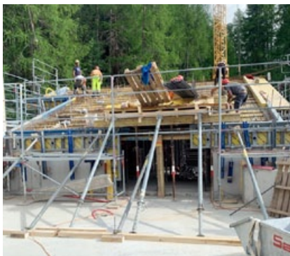
Die Dächer wurden betoniert.
