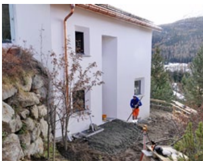
Umgebungsarbeiten im November 2023.
