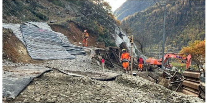
Für das Bohrgerät wurde laufend die Fahrrampe verlängert.
