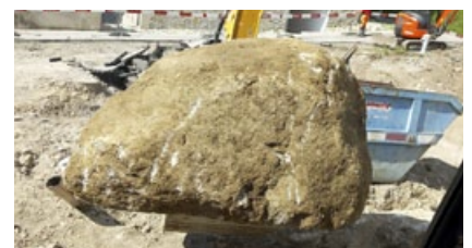
Im Aushub kam ein Findling aus der Eiszeit zum Vorschein.
