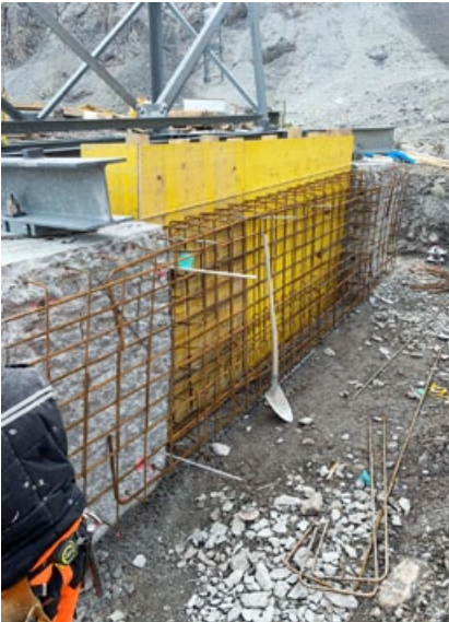
Die alte U förmige Fundation wurde nun komplett zu einem einzigen Betonfundament zusammengehängt.
