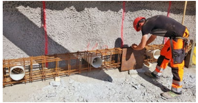
Vorbereitungsarbeiten für die Longarine mit den Ankereinlagen und den Stahlplatten für die Stahlträger.
