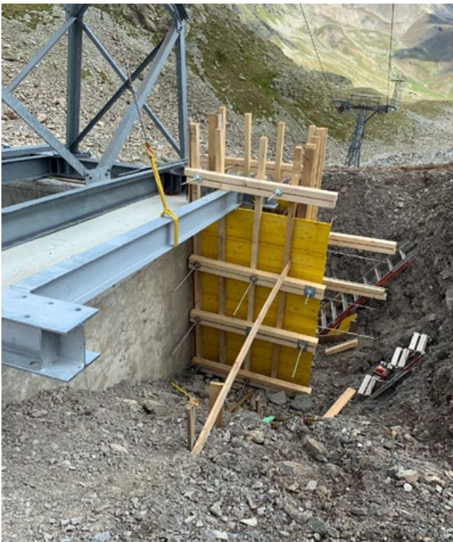
Bei der Stütze 8 wurden zuerst seitlich Betonpfeiler anbetoniert.
