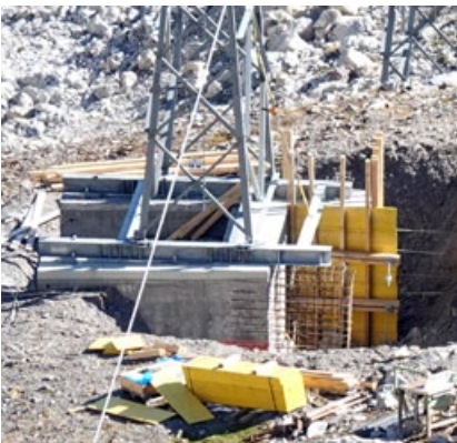
Im Bild ersichtlich wie der Mast auf dem horizontalen Träger geschoben werden kann.
