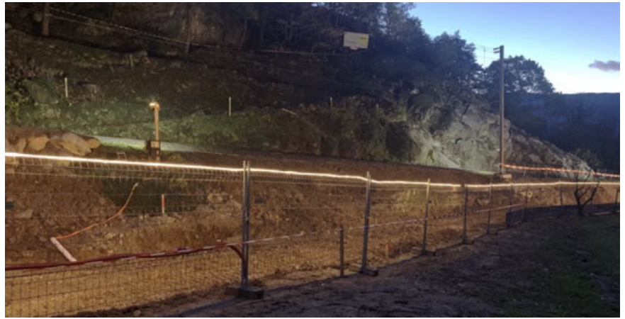
Mittels LED Lichtband wurde die ganze Baustelle ausgeleuchtet.
