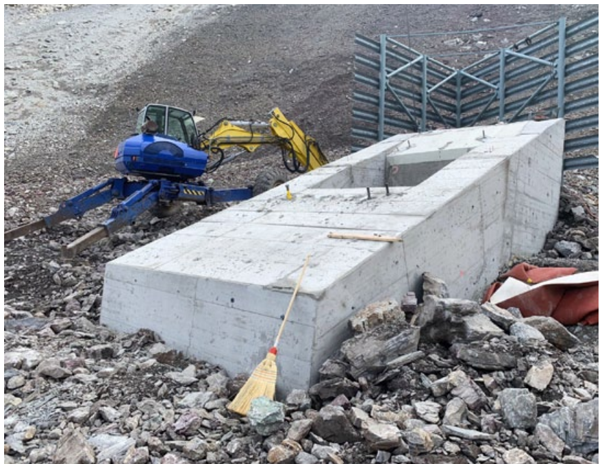
Die beiden alten Einzelfundamente wurde zu einem einzigen, massiven Betonklotz zusammen gehängt.
