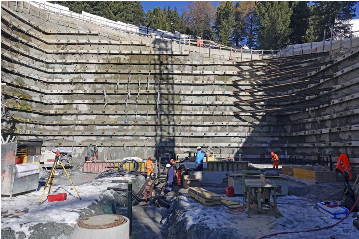
Imposante Baugrube für ein Gebäude über sechs Stockwerke.
