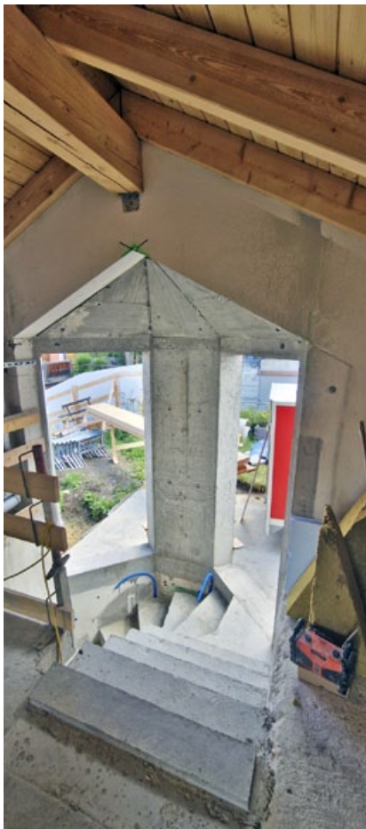
Das Dachgeschoss wurde neu mit einer Treppe und einem zusätzlichen Anbau erschlossen.
