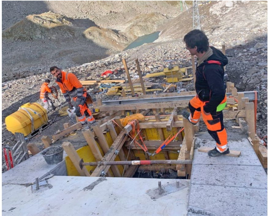
Links Marco Martinelli und Schreitbaggerfahrer Aldo Zanoli bei der letzten Betonage.
