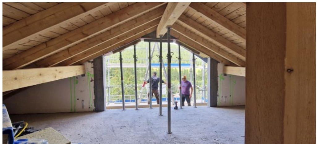
Im ganzen Einfamilienhaus wurden die Unterlagsböden entfernt und im Dachgeschoss entstand neu eine grosse Fensteröffnung.
