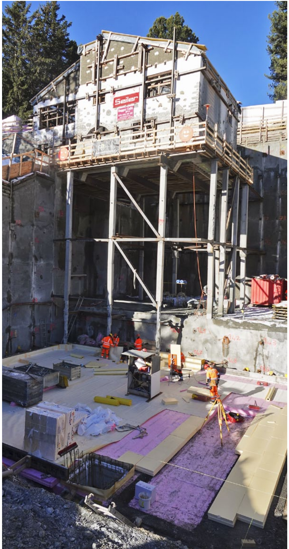
Vorbereitungsarbeiten für die Bodenplatte 3. Untergeschoss. Klar, dass die unterirdischen Bauten um einiges grösser sein werden als das Einfamilienhaus. Noch wissen wir nicht, was genau für Räumlichkeiten unter die Chesa Maurin gebaut werden.
