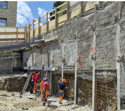
Die Baugrubensicherung wird in Zusammenarbeit mit der Firma Gasser erstellt.
