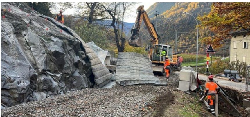
Abdekarbeiten mit Gummimatten vor der Sprengung.
