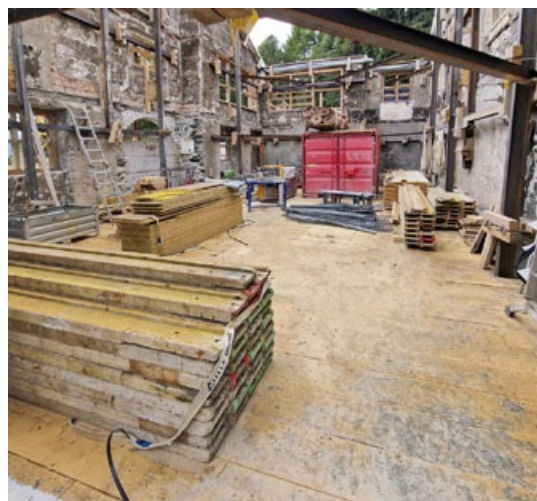
Eine Schalung verhindert, dass man 12.5m in die Tiefe stürzen könnte.
