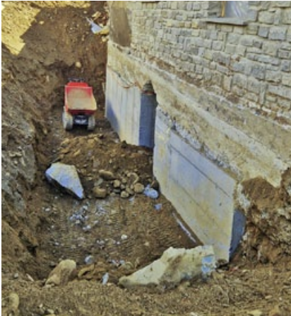
Etappe für Etappe wurde das 1. Untergeschoss unter-, bzw. abgefangen.
