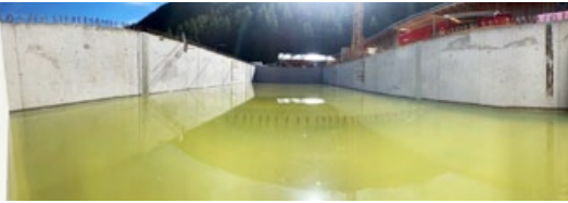
Dichtigkeitsprüfung Fermenter.
