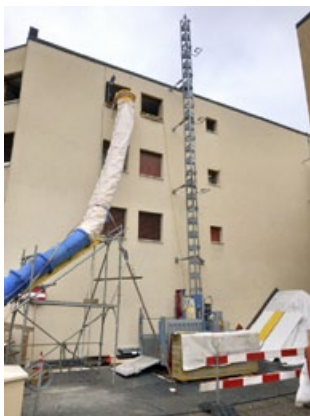
Unser Aussenlift mit dem Fallrohr, welches direkt in die Mulde führte.
