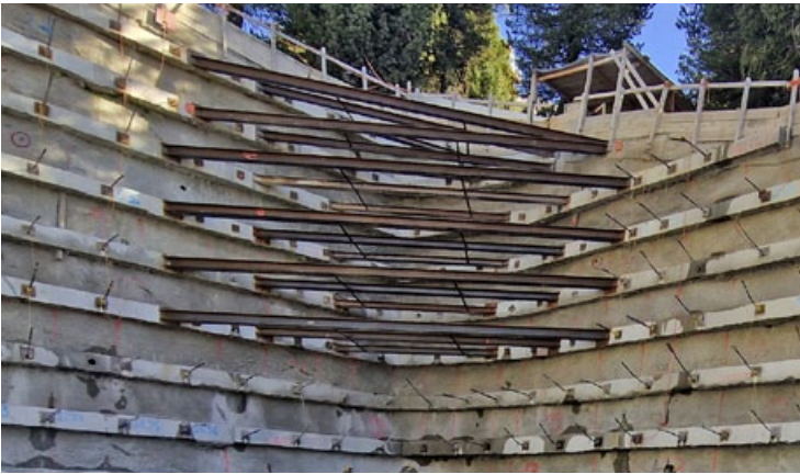
Über die Ecke wurden Stahlträger eingeschweisst.
