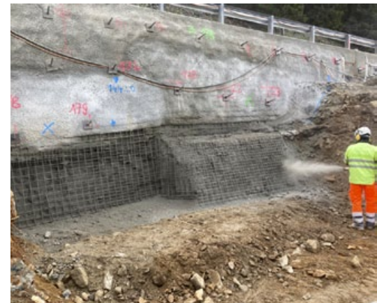
Bis zu der Tiefe der Fundationen wurde der Kordon der Berninastrasse unterfangen.
