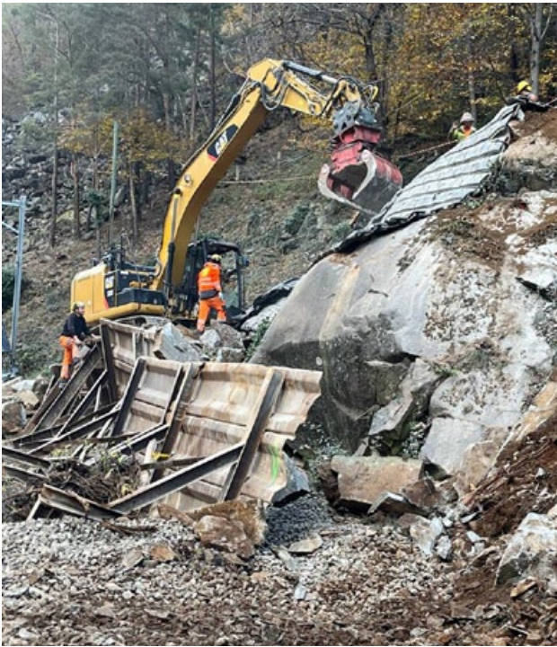
Bis zu 12 Mal pro Tag wurde gesprengt.
