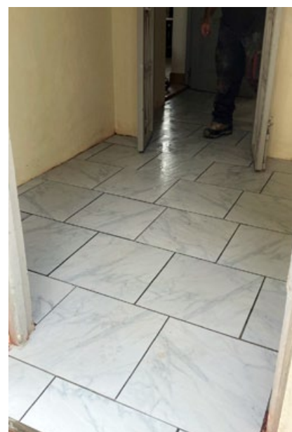
Praktisch alle Böden ausser in den Zimmern wurden mit Plättli belegt.
