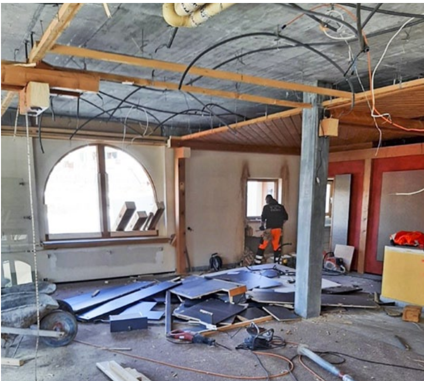
Abbrucharbeiten im Innern.
