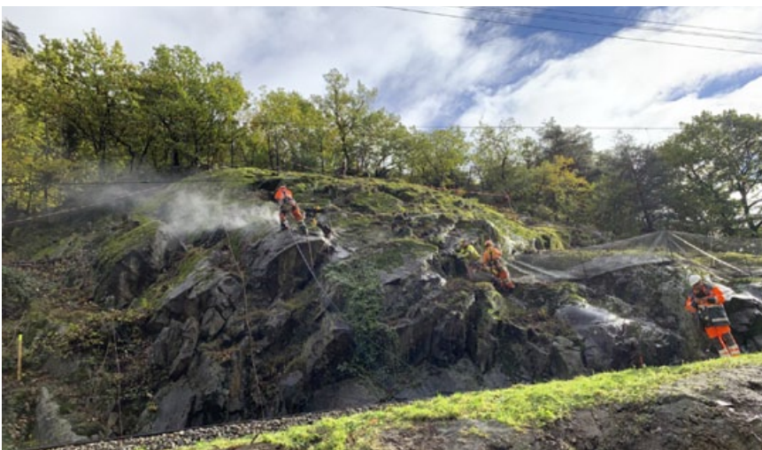
Noch unter Bahnbetrieb wurden die ersten Sprenglöcher gebohrt. Gut überwacht durch einen Sicherheitswärter.
