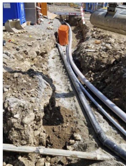
Jede mögliche Leitung musste umgelegt werden.
