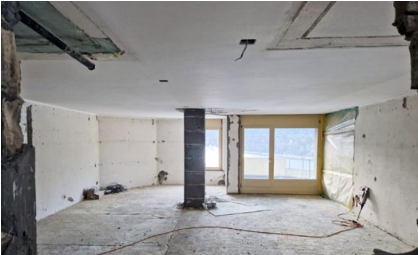
Die Wohnung wurde noch im Jahr 2022 in den Rohbauzustand zurückversetzt.
