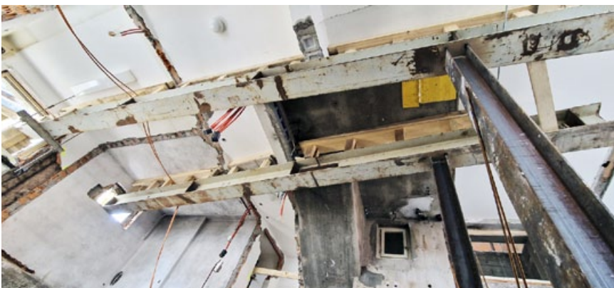
Alte Stahlträger aus dem Magazin wurden für das Abfangen der Obergeschosse verwendet.
