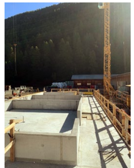
Brüstungen Auflager für Elementbau Holz.
