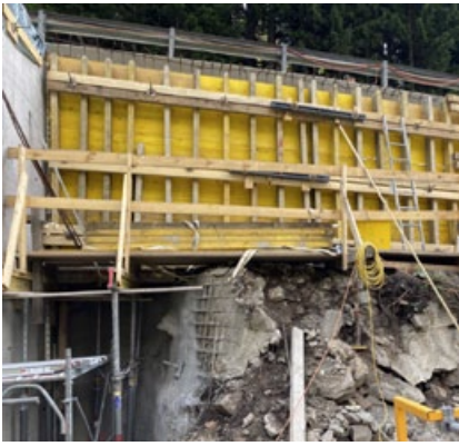
Zwischen den Pfeilern betonierten wir Schürzen.
