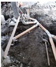
Neue Leitungen im Untergeschoss und die darüber frisch betonierte Bodenplatte.
