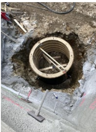
Unsere selbstentworfene Schalung für die Ringbetonfundationen. Jede der 16 Fundationen hatte eine Tiefe von 5.10 m. Die Tiefe erreichten wir mittels Pneubagger, ausgerüstet mit einem Greifer.
