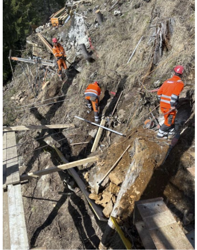
Für das Gerüst der Baupiste mussten unter erschwerten Bedingungen Fundationen erstellt werden.
