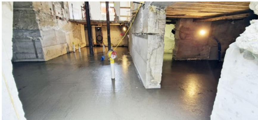
Frisch betonierte Bodenplatte im zweiten Untergeschoss.
