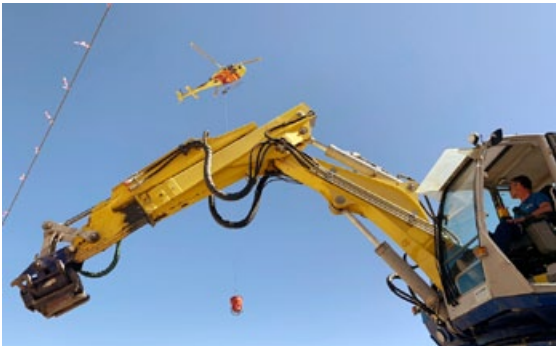
Wegen den Tragseilen wurde der Beton knapp nebenan hingeflogen und dann mit dem Schreitbagger an den Bestimmungsort gebracht.
