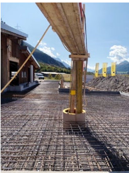
Bodenplatte Hof mit Pumpensämpf.
