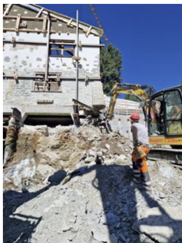
Die Chesa Maurin wurde mittels Betonriegel unterfangen und die Lasten auf HEB 550 übertragen und diese wiederum leiteten das Gewicht über HEB 140 Träger bis zur Baugrubensohle.
