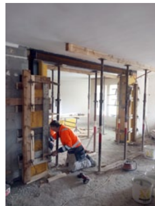
Neuer Durchgang von Küche/ Essen in den Wohnraum mittels Stahlträgern abgefangen.
