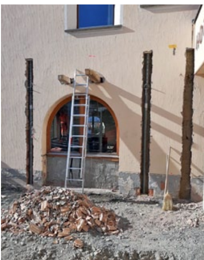
Provisorische Sprossung vor dem Abbruch der Fassade.
