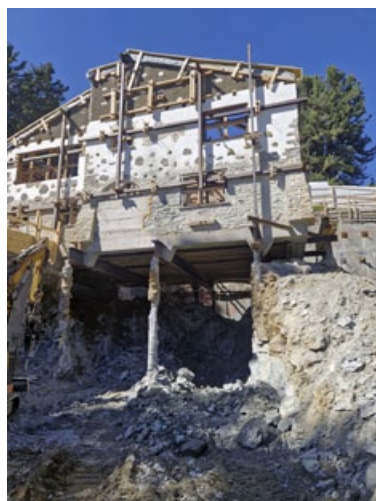
Die Chesa Maurin wurde mittels Betonriegel unterfangen und die Lasten auf HEB 550 übertragen und diese wiederum leiteten das Gewicht über HEB 140 Träger bis zur Baugrubensohle.
