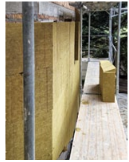
Die alte Aussenwärmedämmung wurde entfernt und neu mit 20 cm wieder aufgebaut.
