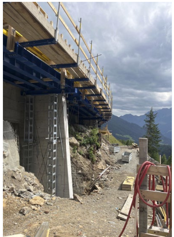
Für das Schalen der Lehenbrücke mieteten wir extra eine Stahlschalung.
