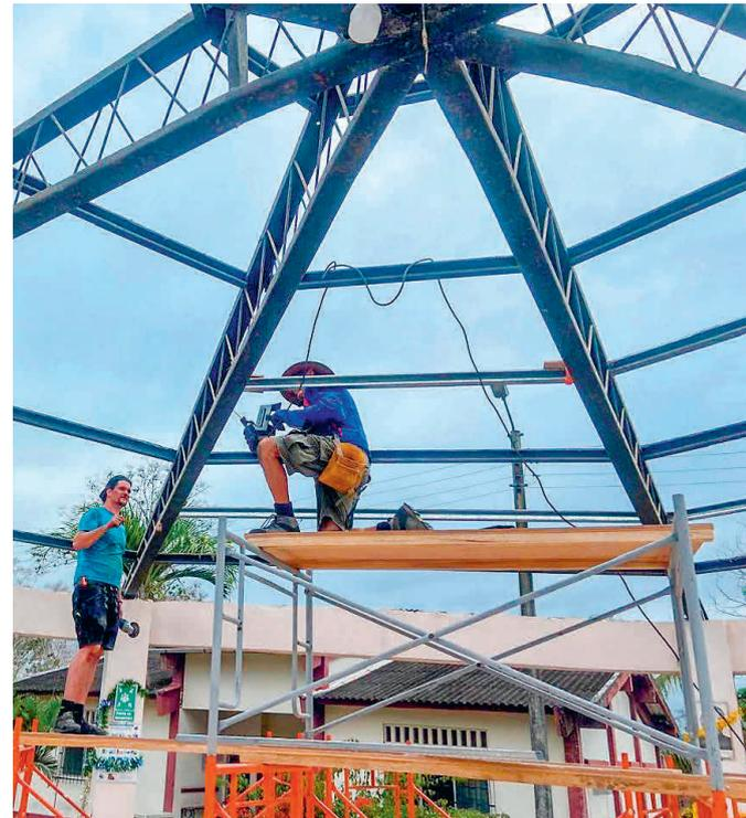
Die Stahlkonstruktion des Pavillons musste verstärkt werden
