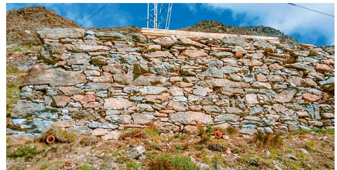
*Diese Trockensteinmauer wurde über 8.0m rück- und wieder neu aufgebaut*
