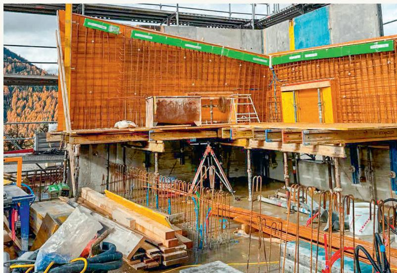
*Giebelwand: gut ersichtlich die erste Betonieretappe bis zum Gerüstboden (wo der Knick ist) und die nächste Etappe bereit zum Zuschalen*
