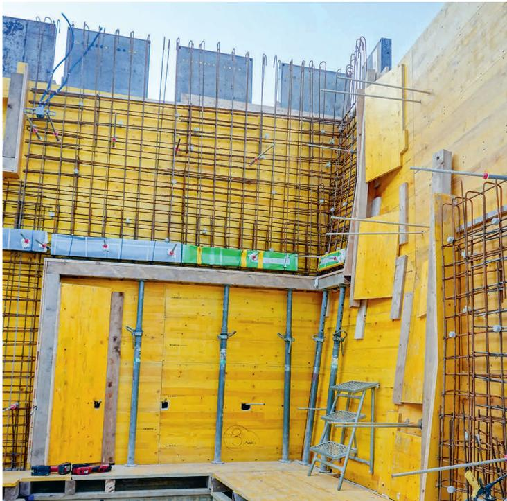
Die schrägen Etappen liefern meist von Mitte Stockwerk zu Mitte Stockwerk des folgenden Stockes, die spätere Decke kommt auf der Höhe der Ebene Einlagen
