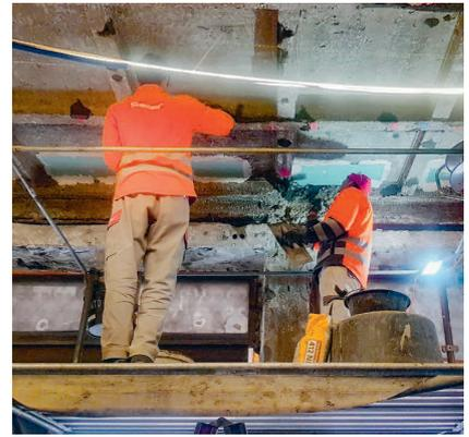
*Teils sichtbarer Armierungsstahl der Decke musste saniert werden*
