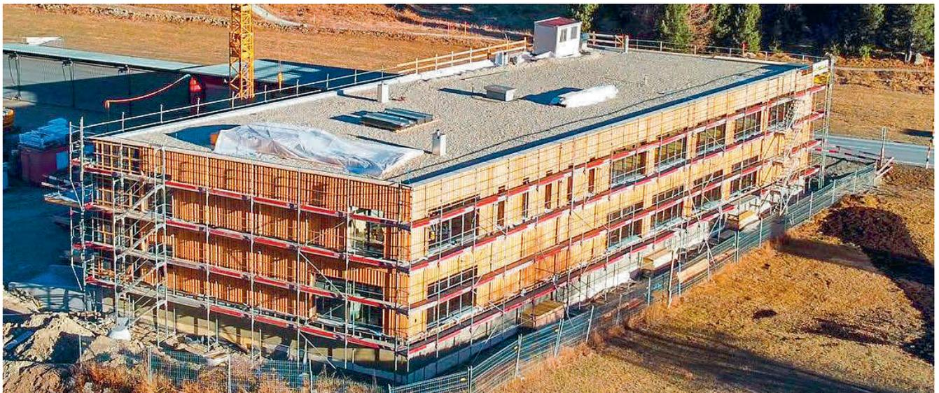
*Die Fassade besteht aus verkleideten Holzelementen*
