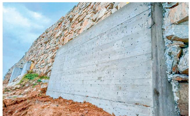
*Die vorbetonierten Mauern sind im Fels verankert und werden später noch farblich angepasst*
